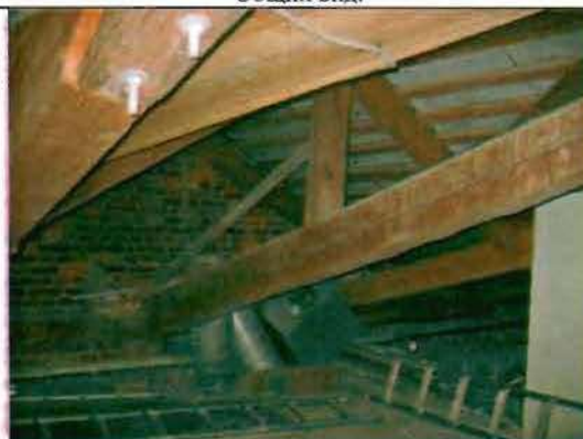
Фото 77. Конструкции крыши. Общий вид.
