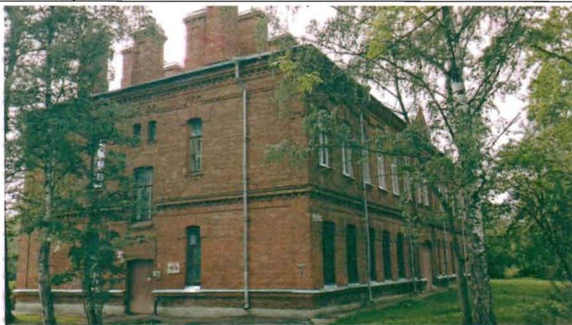
Фото 170. Северный, западный фасады. Общий вид.
