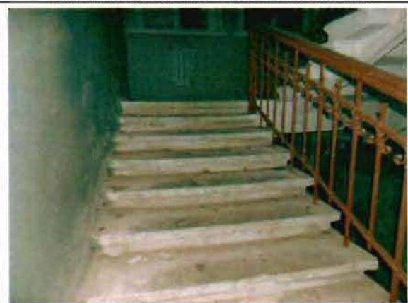
Фото 122. Парадная лестница в центральной части здания. Фрагмент.
