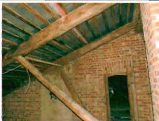
Фото 127. Конструкции крыши. Общий вид.
