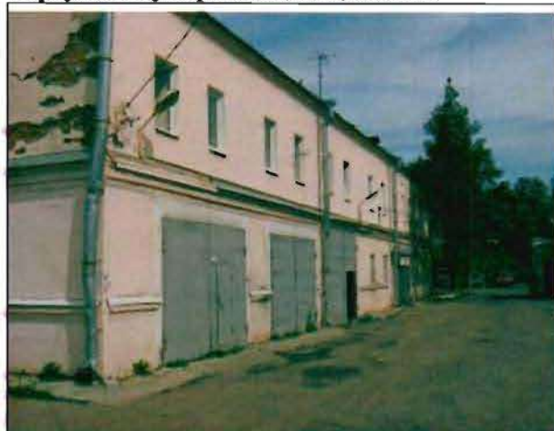
Фото 110. Восточный фасад. Общий вид.
