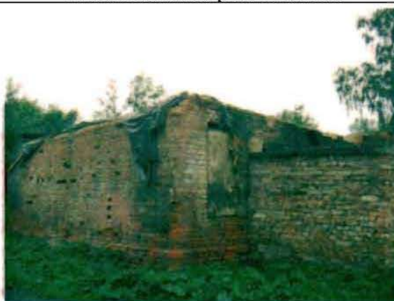
Фото 187. Северный фасад. Общий вид.
