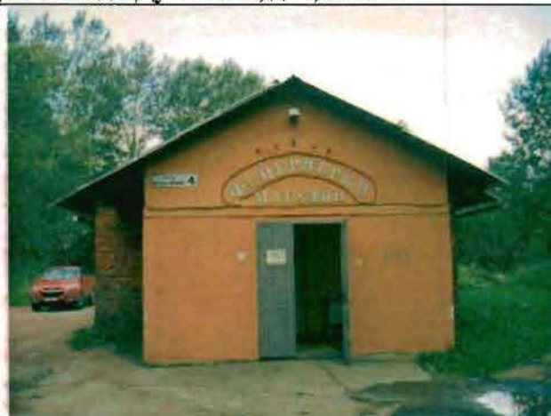
Фото 153. Восточный фасад. Общий вид.
