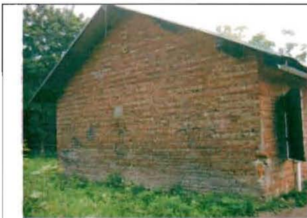
Фото 155. Северный фасад. Общий вид.
