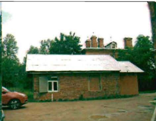
Фото 154. Южный фасад. Общий вид.
