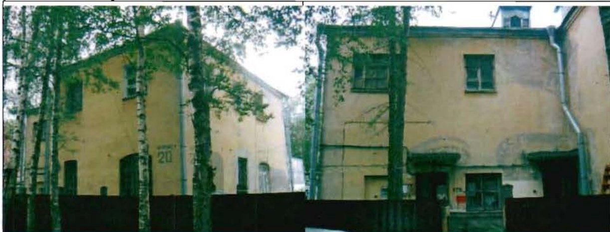
Фото 43. Северный, восточный фасады. Общий вид.
