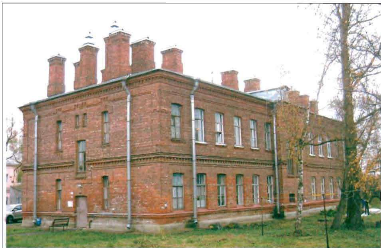
Фото 129. Западный, северный фасады. Общий вид.
