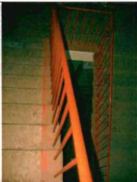
Фото 149. Лестница № 1 в северной части здания. Общий вид.
