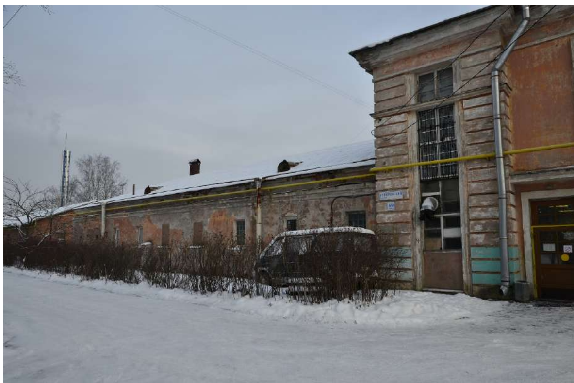
25. Западный фасад, вид с юго-запада, фото декабрь 2018 г. Фотоальбомы сообщества вконтакте «Петергоф. Суворовский городок».
