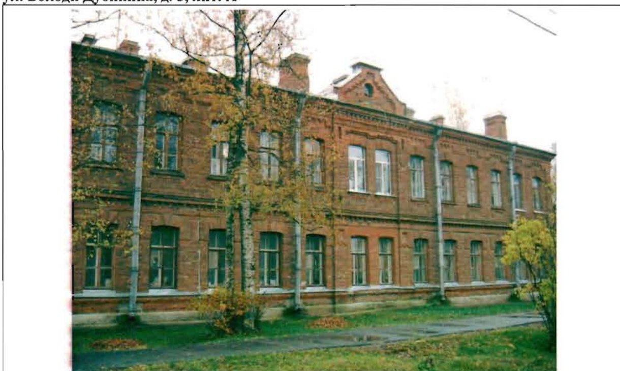
Фото 157. Западный фасад. Общий вид.
