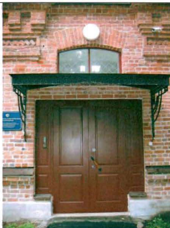
Фото 41. Дверной проем восточного фасада. Общий вид.
