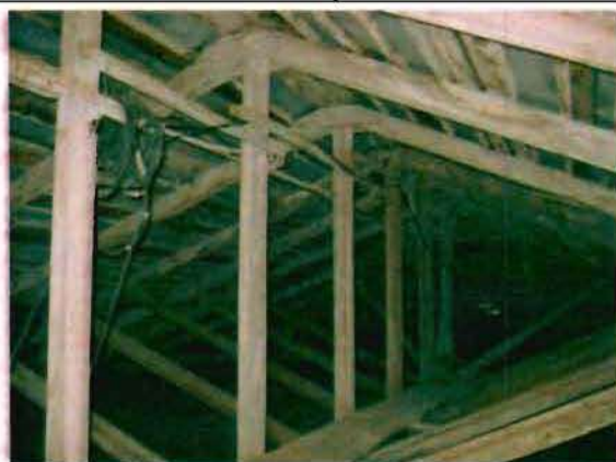
Фото 81 Конструкции крыши. Общий вид.
