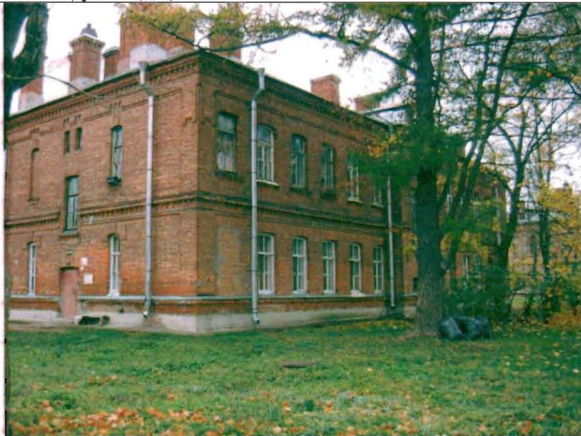
Фото 145. Восточный фасад. Общий вид.
