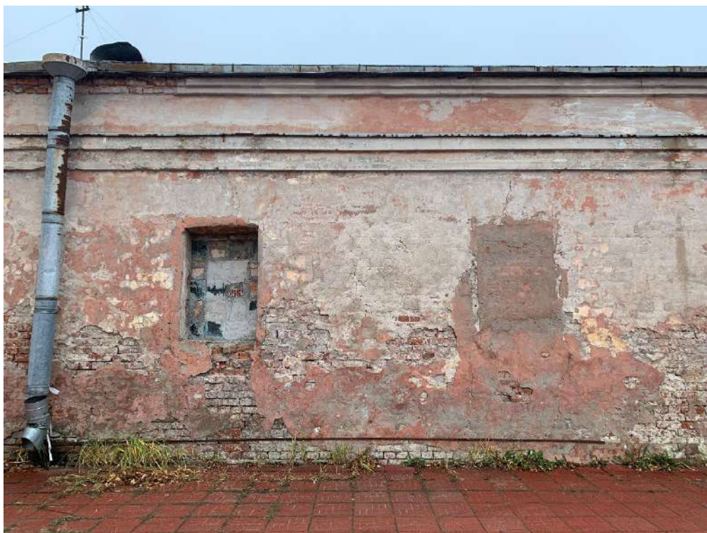
Фото 16. Вид на фрагмент фасада по оси 8.
