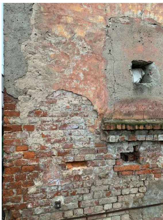
Фото 8. Вид на фрагмент фасада по оси А.
