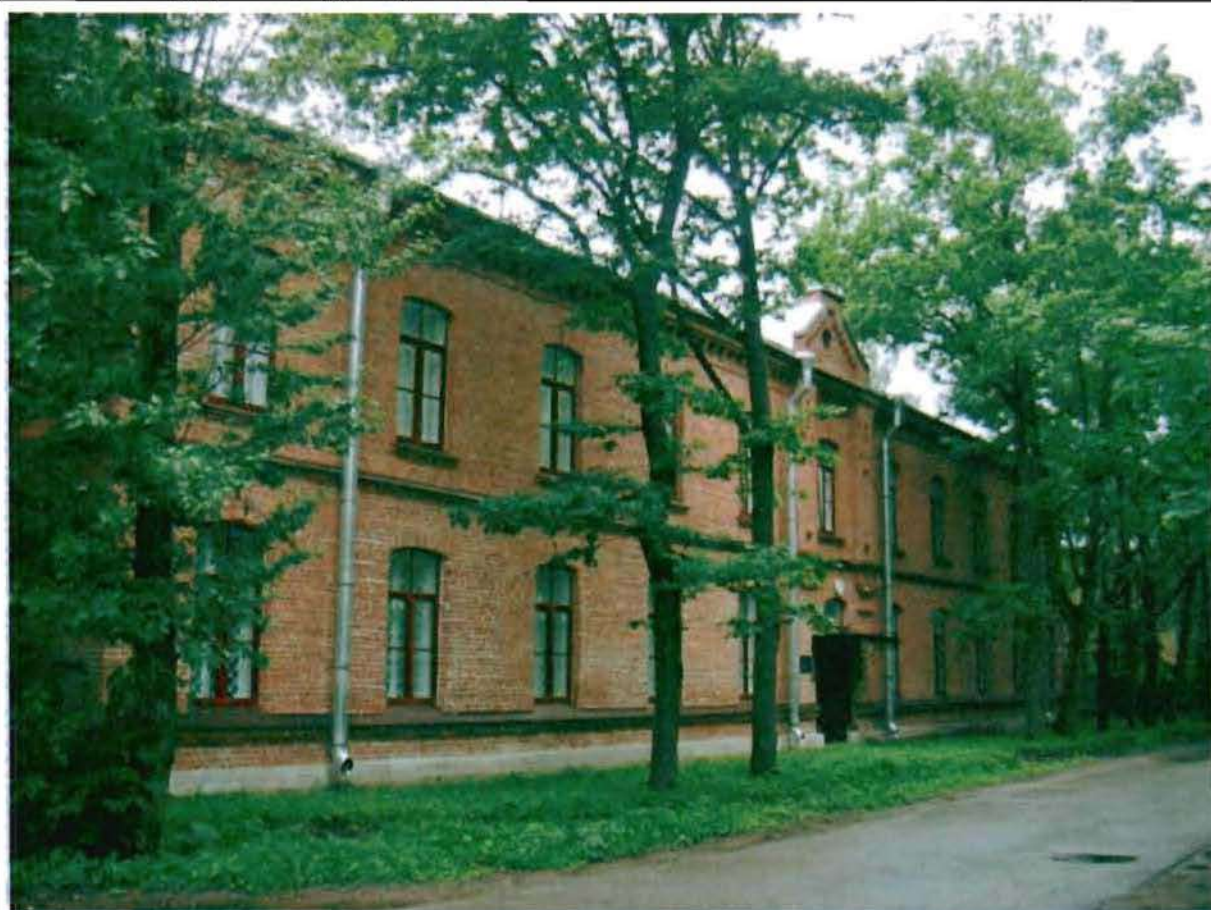
Фото 39. Восточный фасад. Общий вид.
