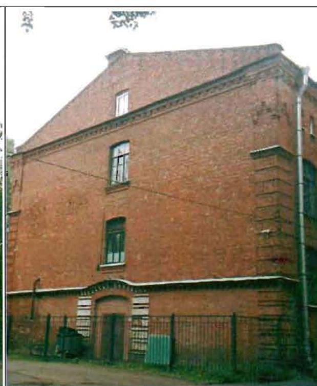
Фото 50. Южный фасад. Общий вид.
