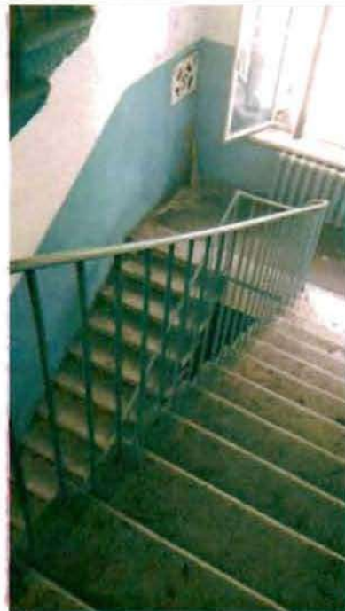
Фото 144. Лестница № 2 в южной части здания. Общий вид.
