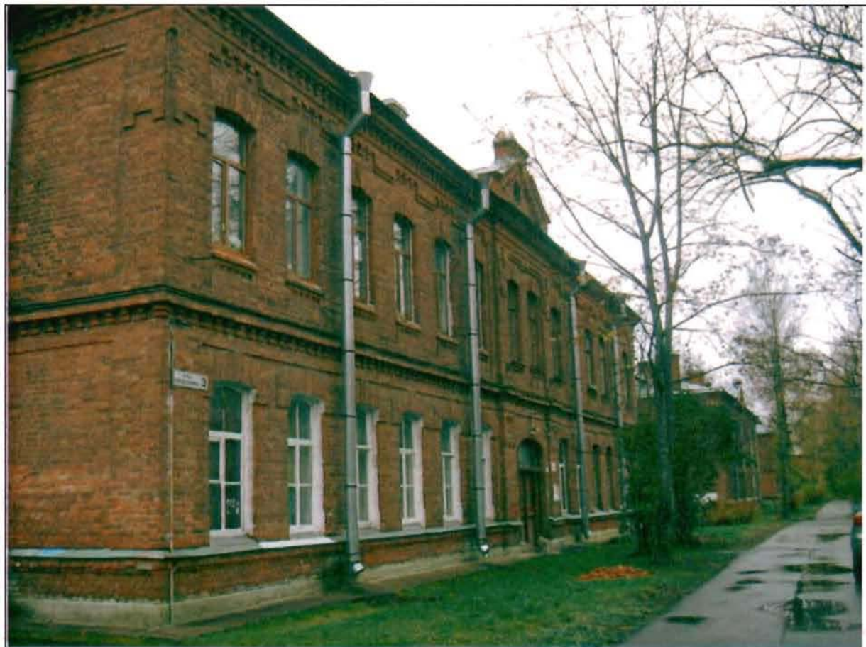
Фото 146. Западный фасад. Общий вид.
