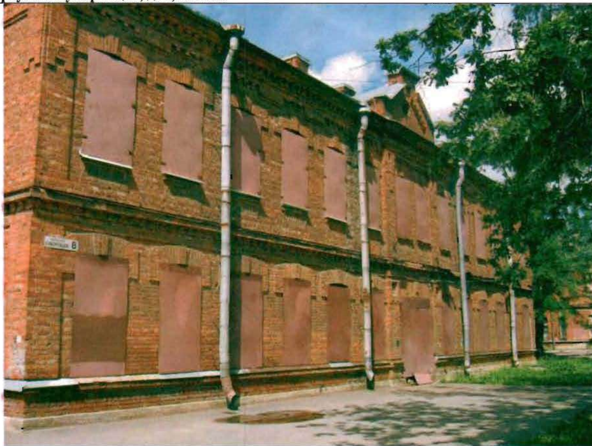
Фото 116. Восточный фасад. Общий вид.
