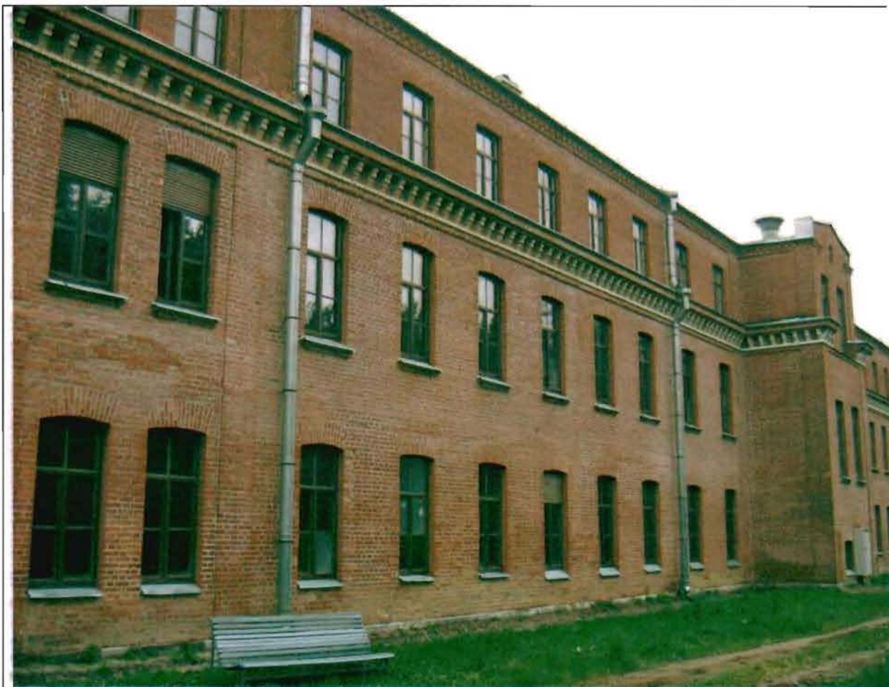
Фото 66. Южный фасад. Общий вид. 05.07.2016.
