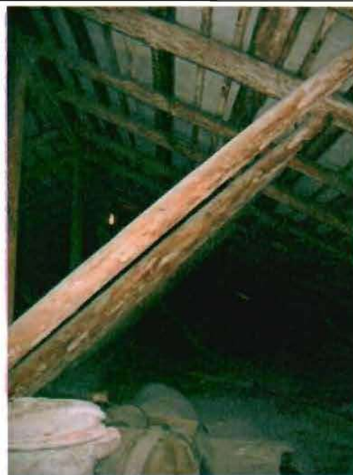
Фото 27. Конструкции крыши. Фрагмент.
