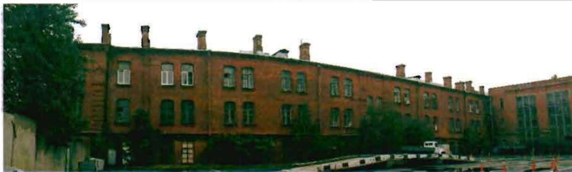
Фото 29. Западный фасад. Общий вид.
