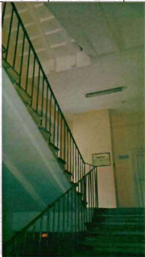
Фото 60. Интерьер. Лестница в южной части здания. Фрагмент.
