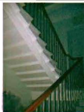
Фото 75. Интерьер. Лестница в западной части здания. Общий вид.
