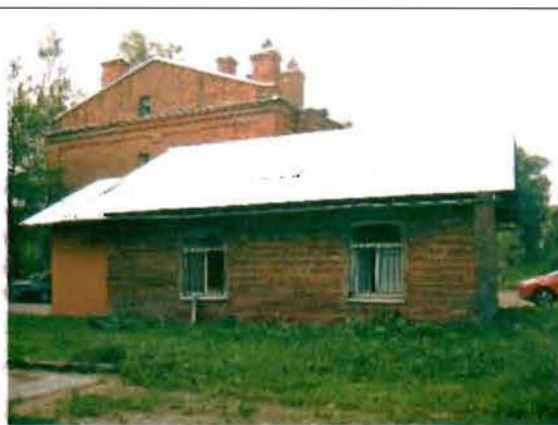
Фото 156. Западный фасад. Общий вид.
