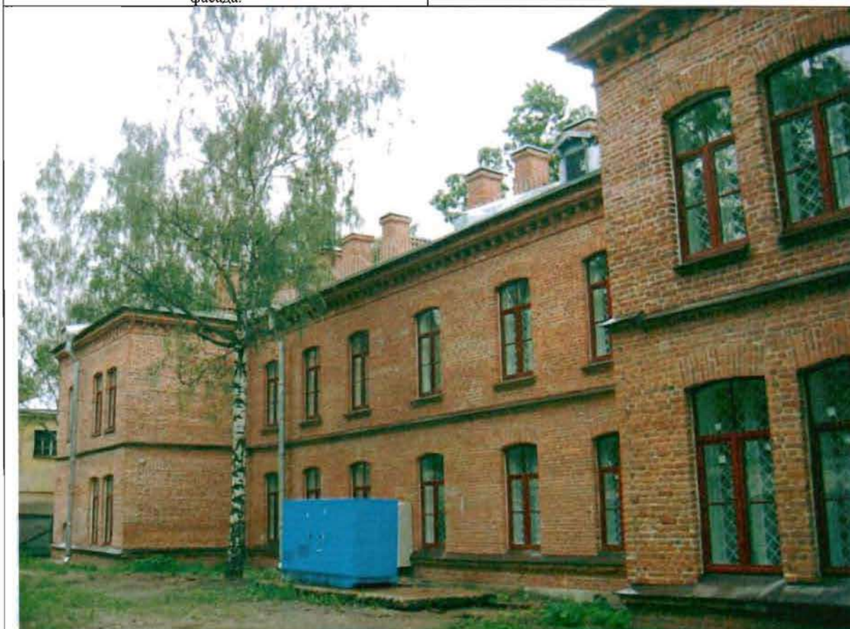
Фото 42. Западный фасад. Общий вид.
