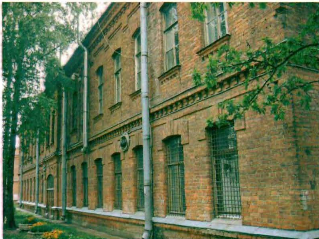
Фото 163. Восточный фасад. Общий вид.
