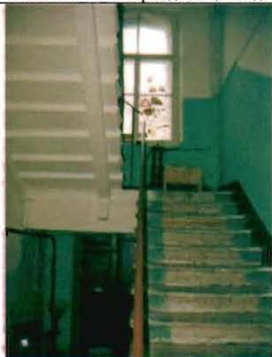
Фото 168. Лестница в южной части здания. Общий вид.
