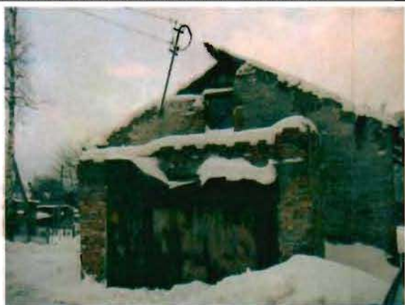
Фото 184. Восточный фасад. Общий вид. 14.01.2015.
