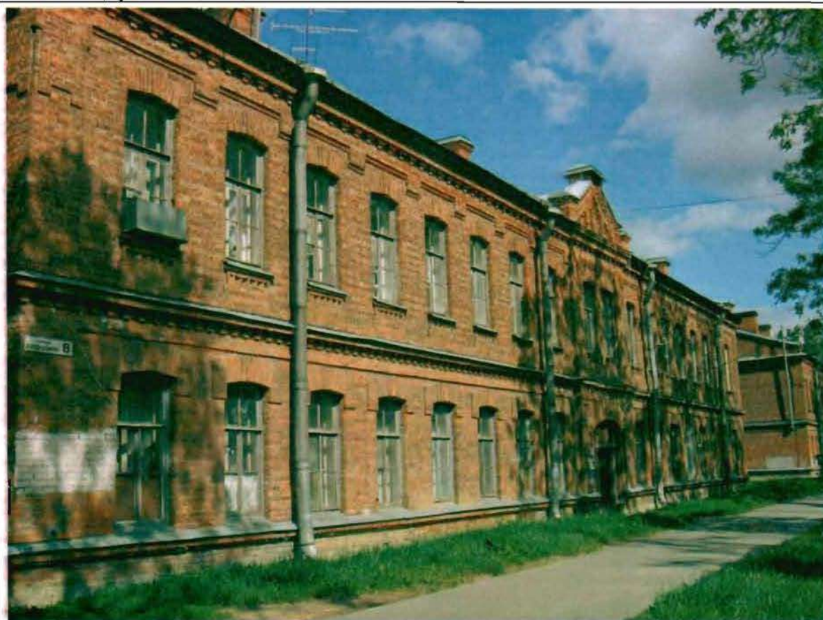
Фото 176. Восточный фасад. Общий вид.
