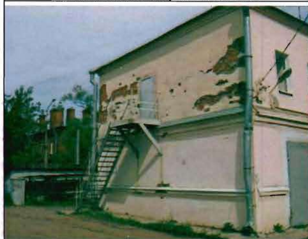
Фото 112. Южный фасад. Общий вид.
