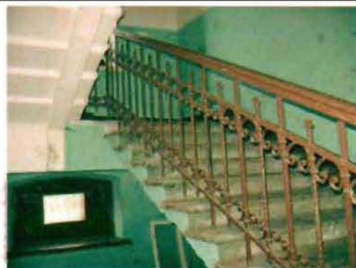
Фото 182. Парадная лестница в центральной части здания. Фрагмент.
