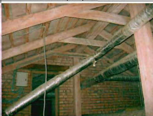
Фото 115. Конструкции крыши. Фрагмент.
