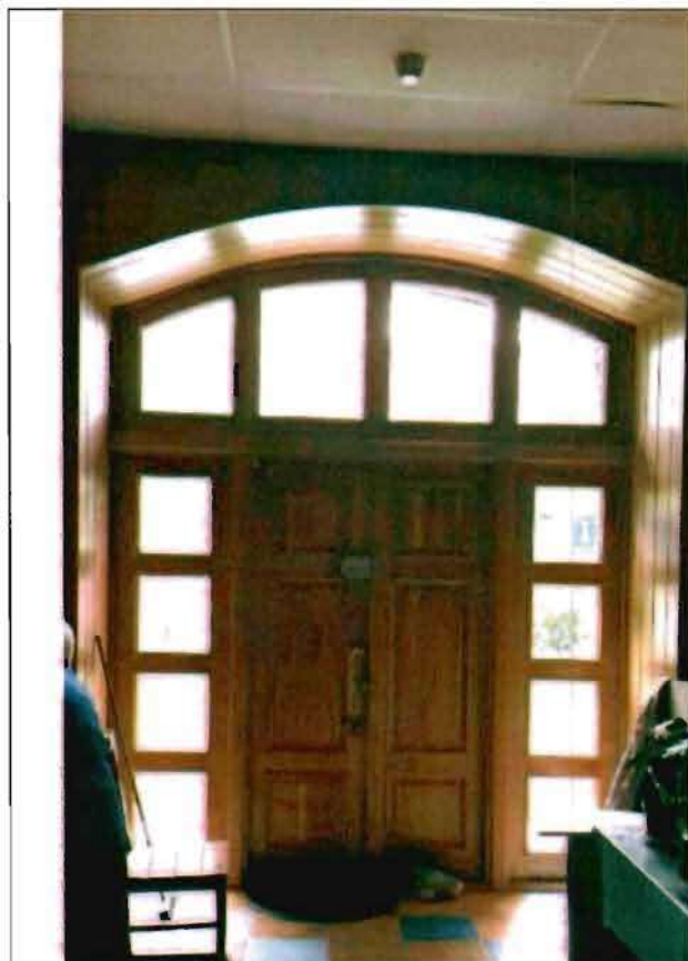
Фото 92. Помещение в уровне 1-го этажа.
