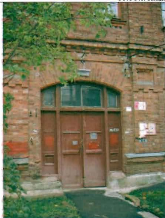
Фото 147. Дверной проем западного фасада. Общий вид.
