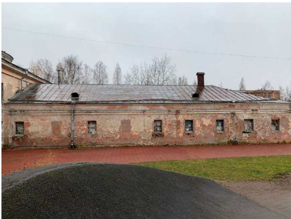
Фото 12. Общий вид фасада по оси 8.
