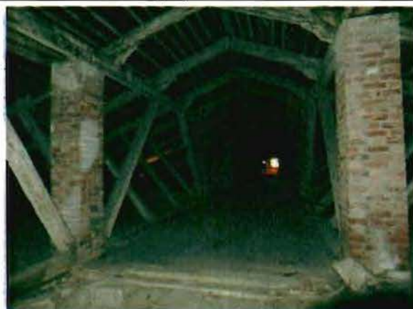
Фото 12. Конструкции крыши. Общий вид. 29.12.2015.
