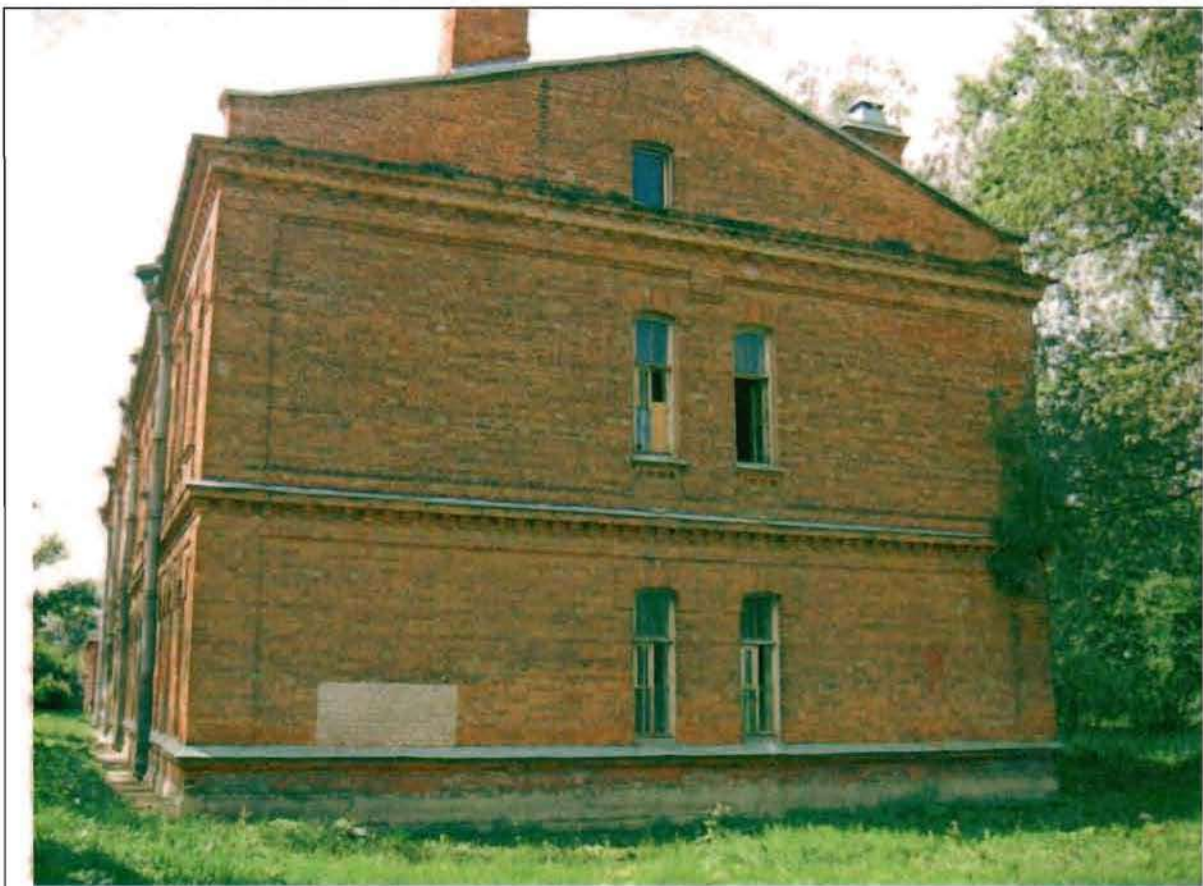
Фото 180. Северный фасад. Общий вид.
