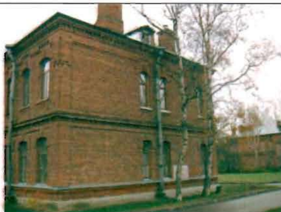
Фото 160. Северный фасад. Общий вид.
