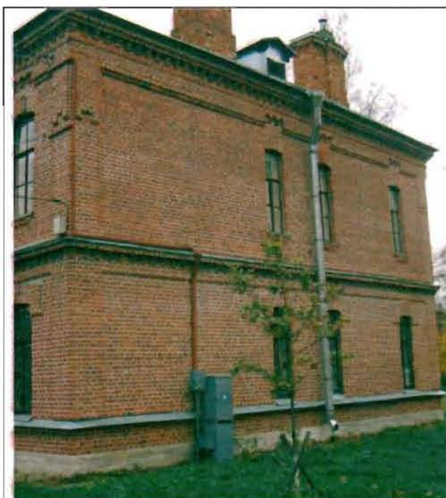
Фото 134. Южный фасад. Общий вид.
