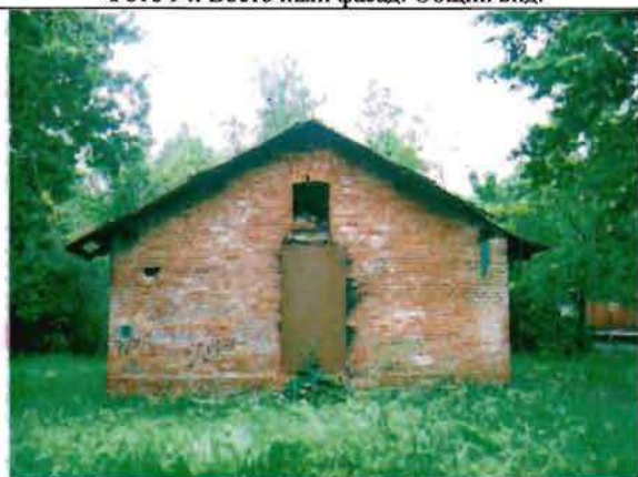
Фото 96. Западный фасад. Общий вид.
