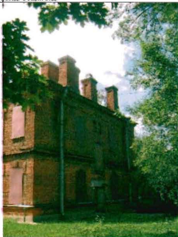
Фото 118. Северный фасад. Общий вид.
