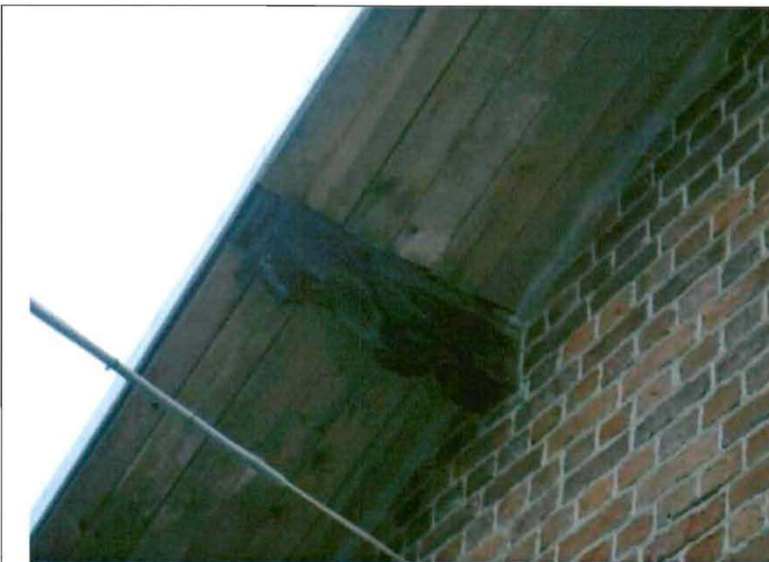
Деревянные кобылки. Съёмка 20.11.2012, Воронина Н.В.
