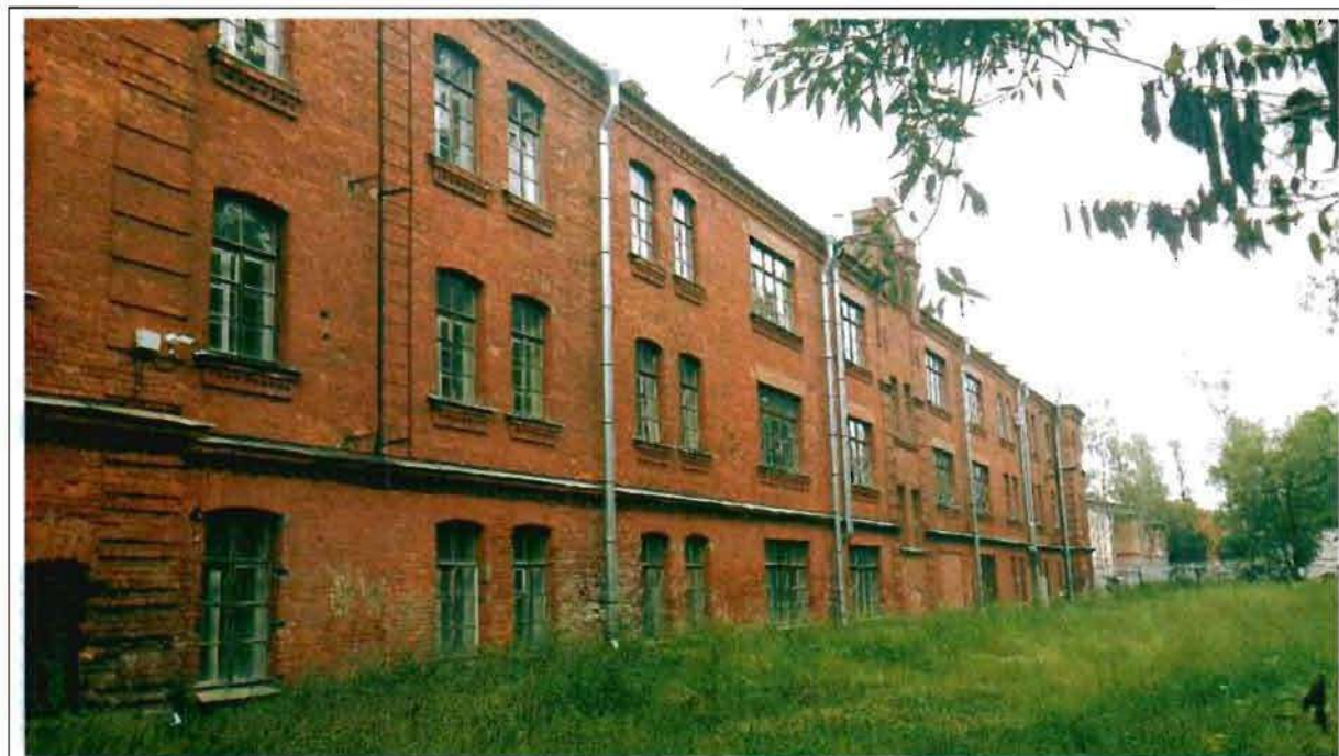
Фото 48. Западный фасад. Общий вид.
