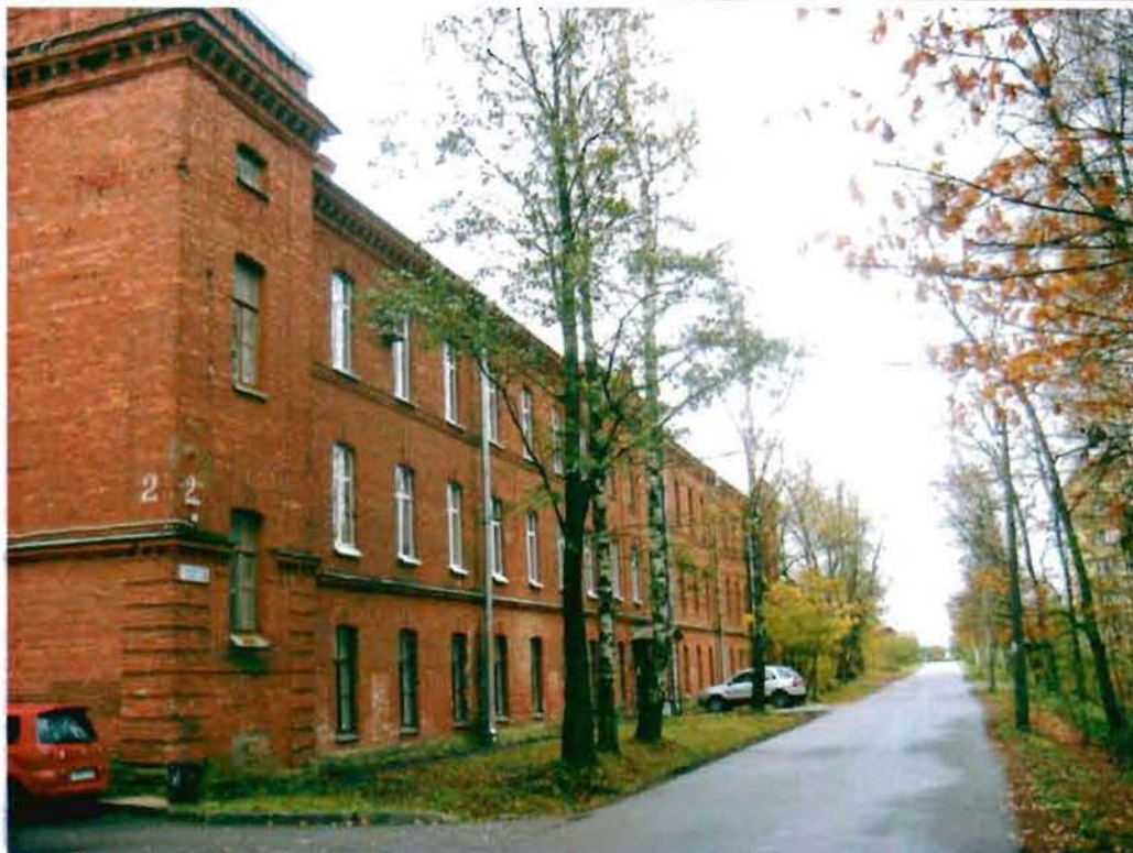
Фото 13. Западный фасад. Общий вид.
