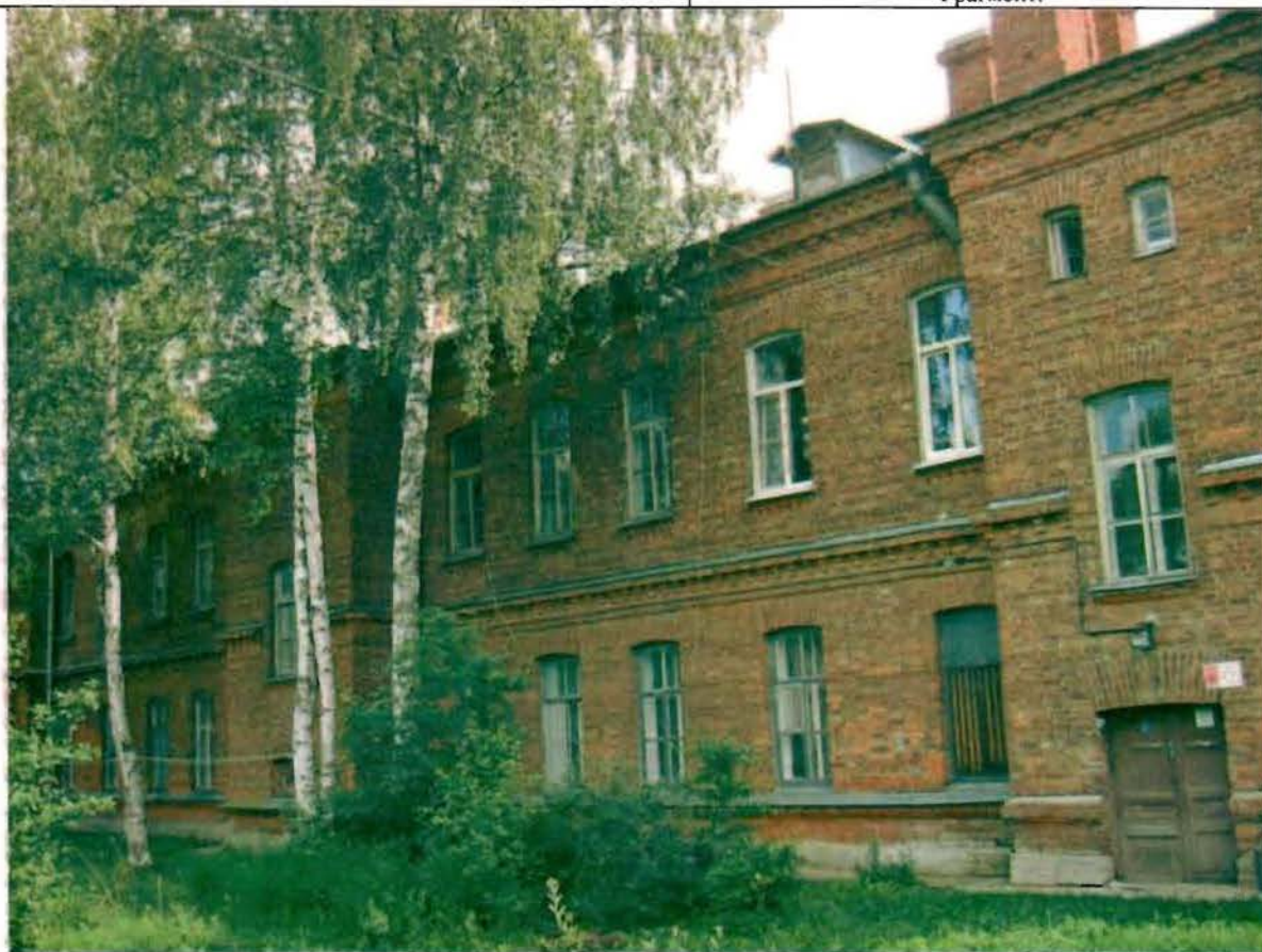
Фото 179. Западный фасад. Общий вид.
