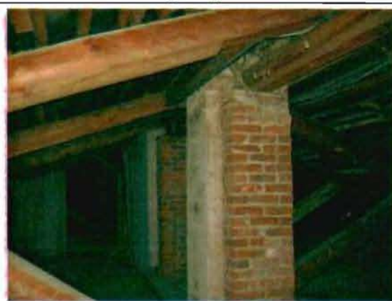
Фото 142. Конструкции крыши. Фрагмент.
