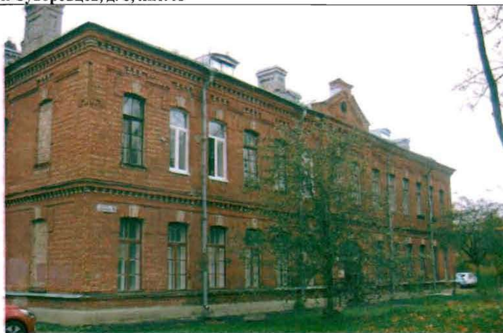
Фото 103. Восточный фасад. Общий вид.
