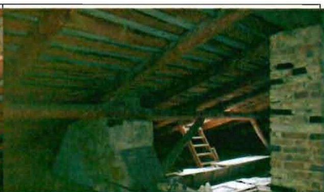
Фото 63. Конструкции крыши. Общий вид.
