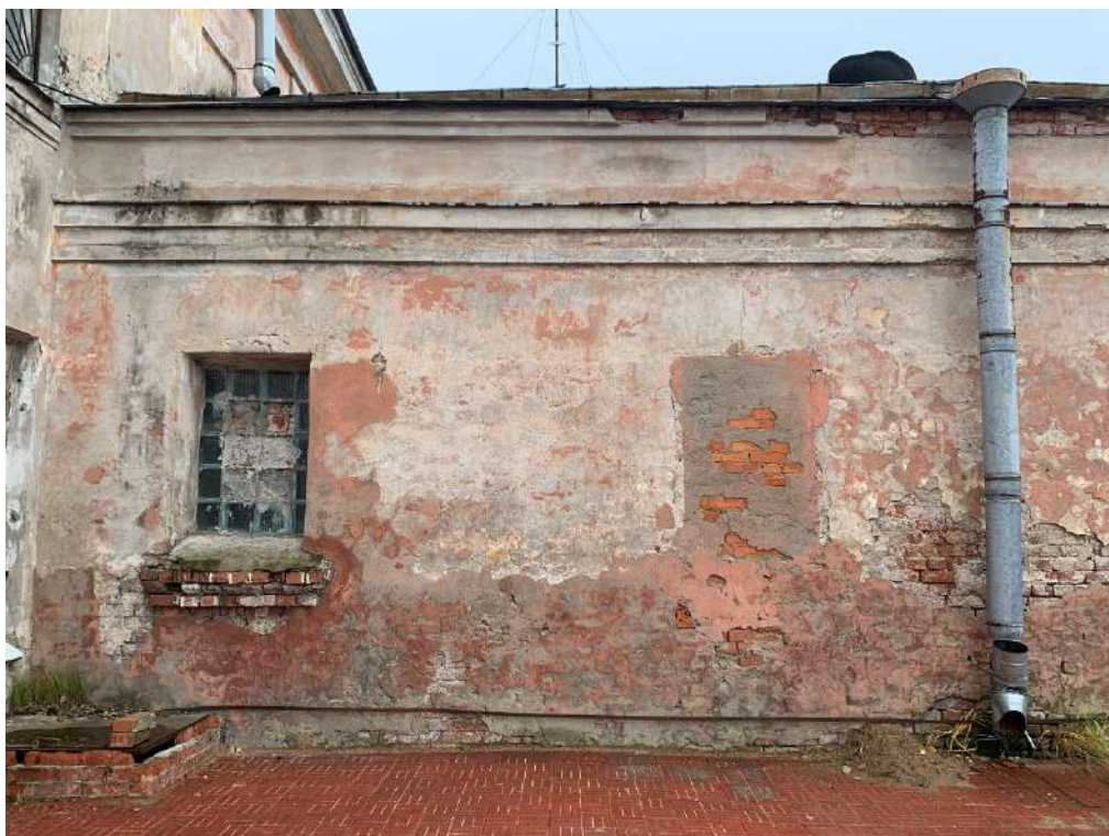
Фото 17. Вид на фрагмент фасада по оси 8.
