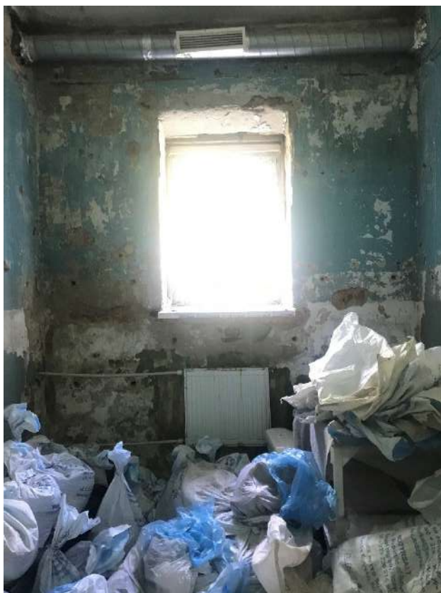
Фото 25. Общий вид помещения №3.
