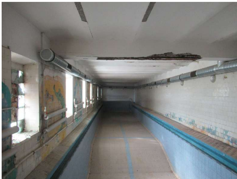
Фото 20. Общий вид помещения №14.
