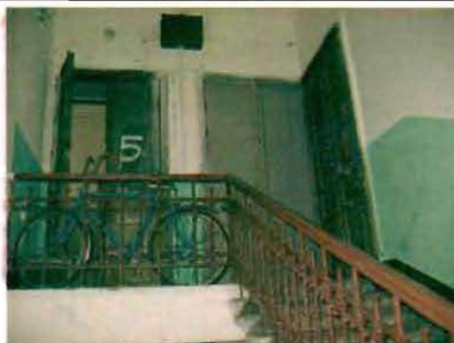
Фото 183. Парадная лестница в центральной части здания. Фрагмент.
