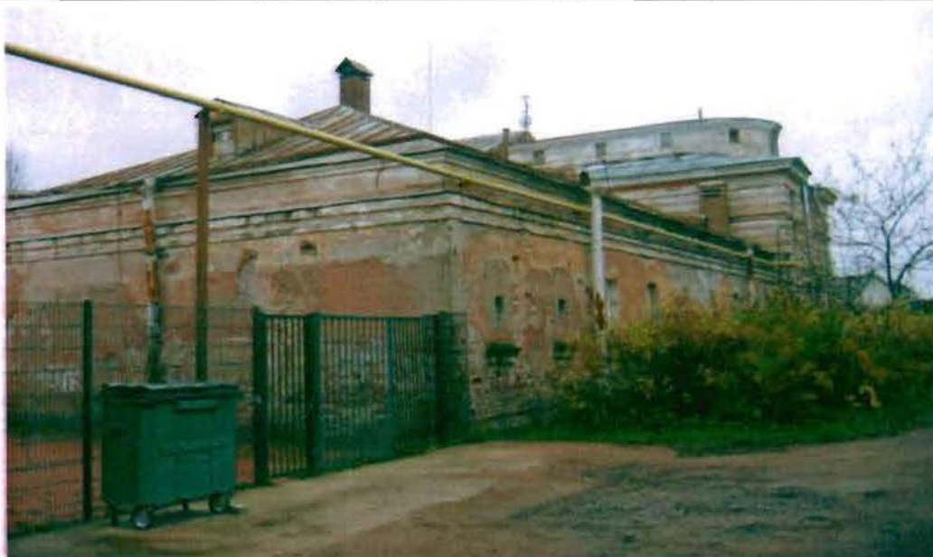
Фото 24. Западный, северный фасады. Общий вид.
