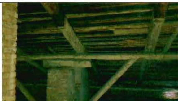
Фото 38. Конструкции крыши. Фрагмент.
