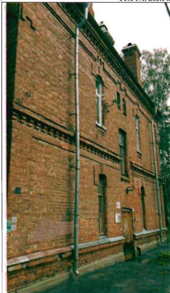
Фото 172. Южный фасад. Общий вид.
