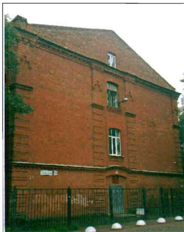
Фото 49. Северный фасад. Общий вид.
