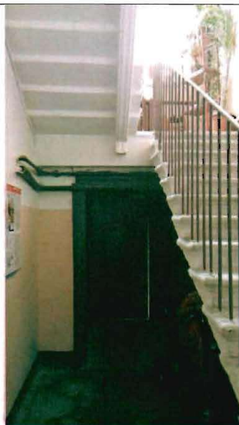
Фото 131. Лестница № 2 в северной части здания. Общий вид.
