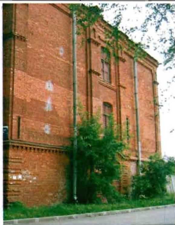
Фото 5. Южный фасад. Общий вид.
