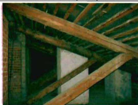
Фото 141. Конструкции крыши. Фрагмент.
