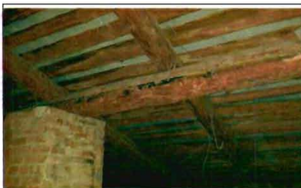
Фото 62. Конструкции крыши. Общий вид.
