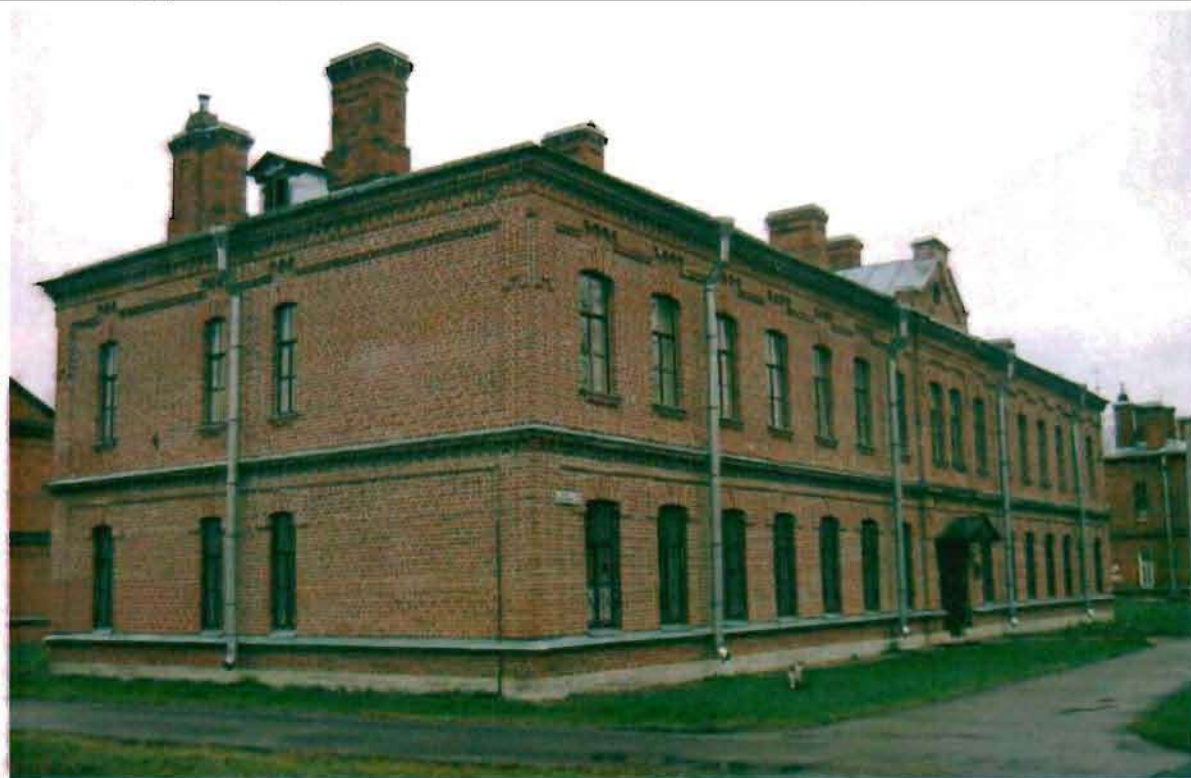
Фото 132. Западный, северный фасады. Общий вид.
