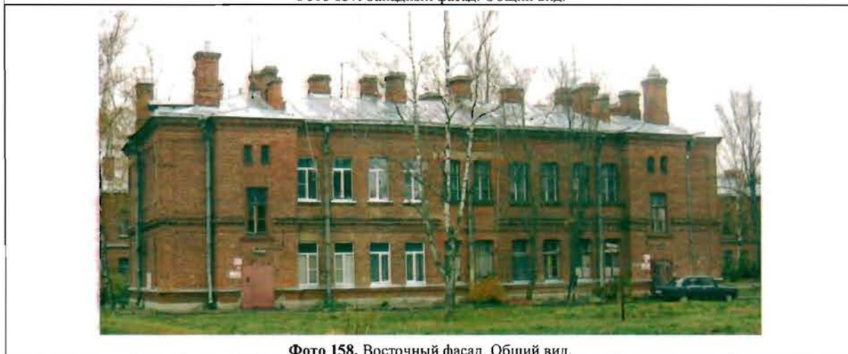
Фото 158. Восточный фасад. Общий вид.
