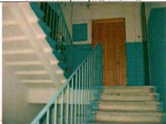
Фото 161. Лестница № 1 в южной части здания. Фрагмент.
