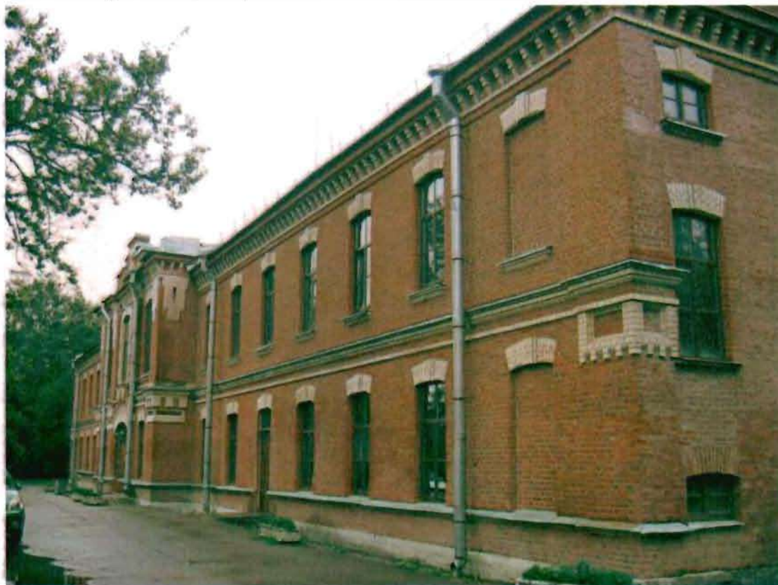
Фото 64. Северный фасад. Общий вид.
