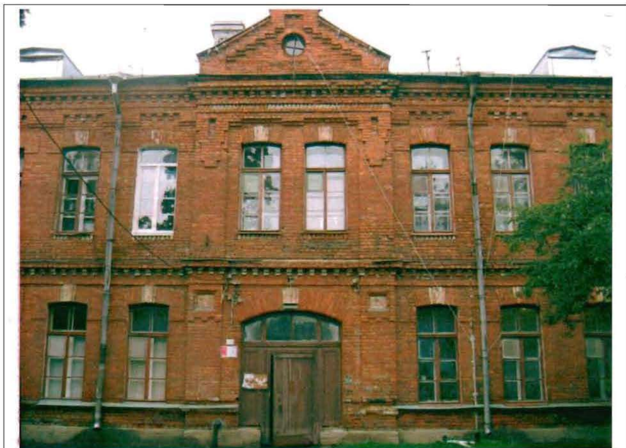
Фото 104. Восточный фасад. Центральная часть. Общий вид.
