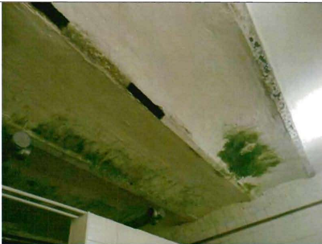
Своды по металлическим балкам. Съёмка 27.11.2012, Воронина Н.В.
