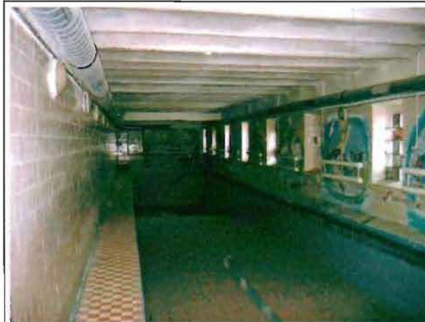
Фото 26. Интерьер. Помещение в уровне 1-го этажа. Система прусских сводов по металлическим балкам. Общий вид.
