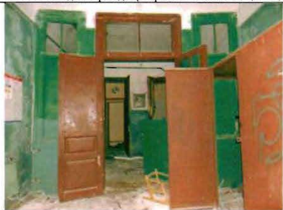
Фото 101. Дверной проем тамбура. Общий вид.
