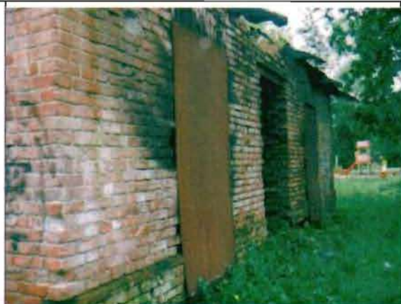
Фото 95. Северный фасад. Общий вид.
