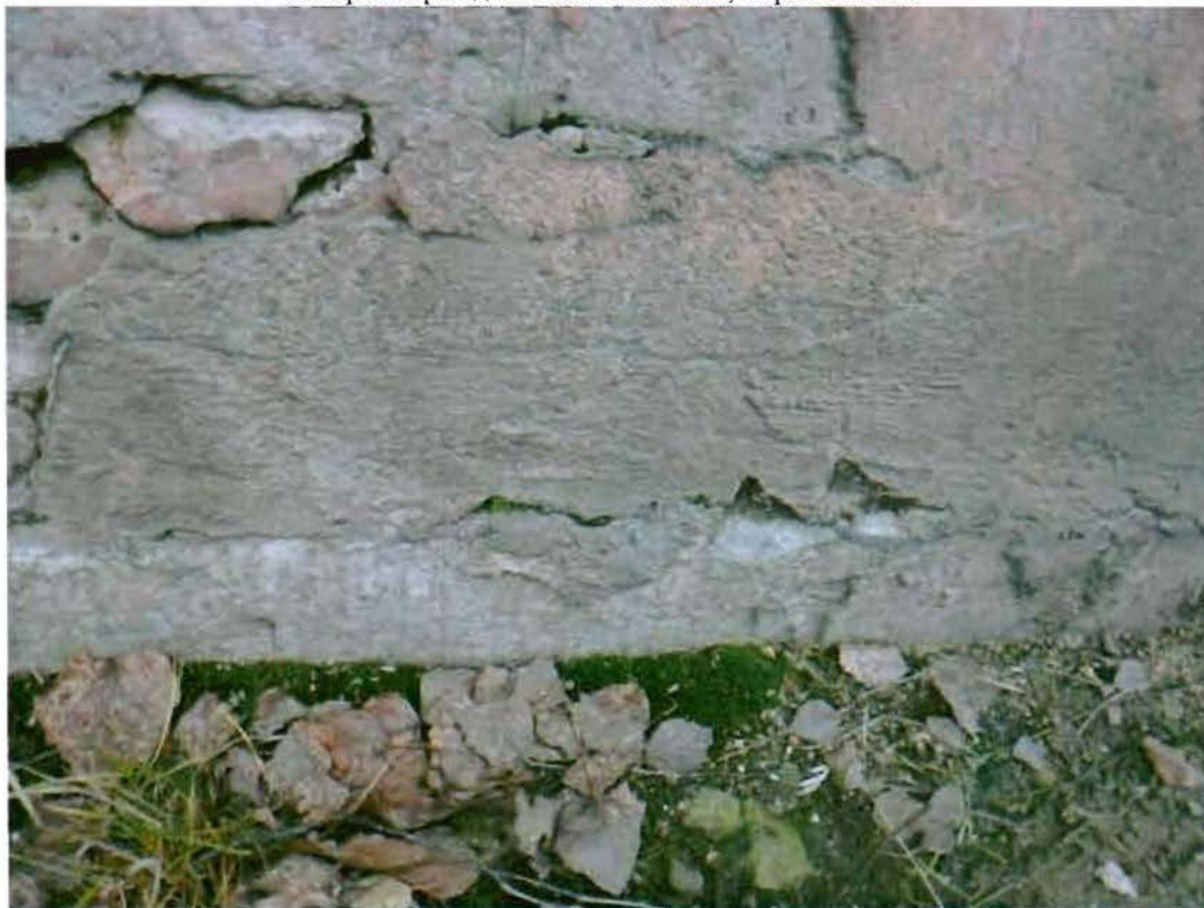
Цоколь, облицованный известняковой скобой. Съемка 27.11.2012, Воронина Н.В.
