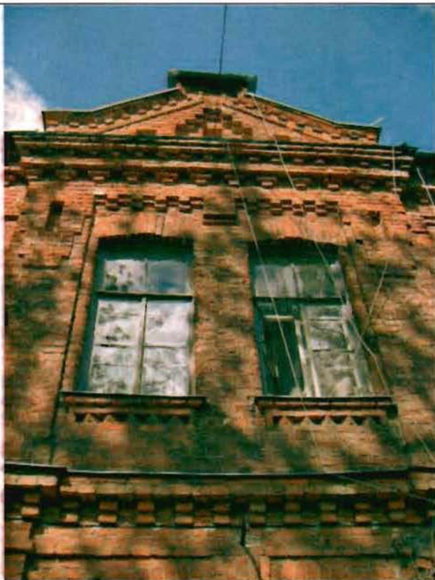
Фото 177. Восточный фасад. Центральная часть. Фрагмент.
