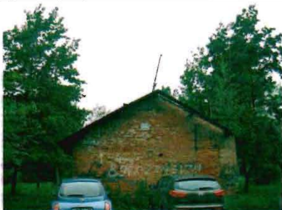
Фото 94. Восточный фасад. Общий вид.
