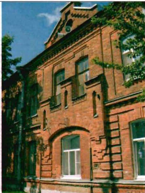
Фото 137. Восточный фасад. Фрагмент.
