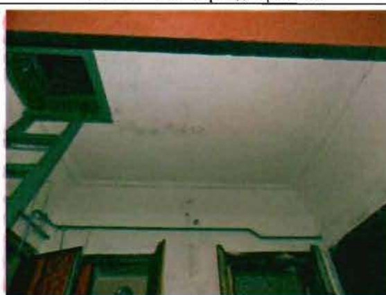
Фото 102. Отделка потолка тамбура. Общий вид.
