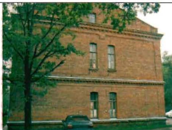
Фото 167. Северный фасад. Общий вид.
