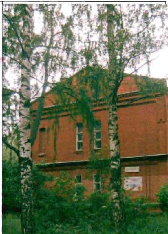
Фото 91. Северный фасад. Общий вид.
