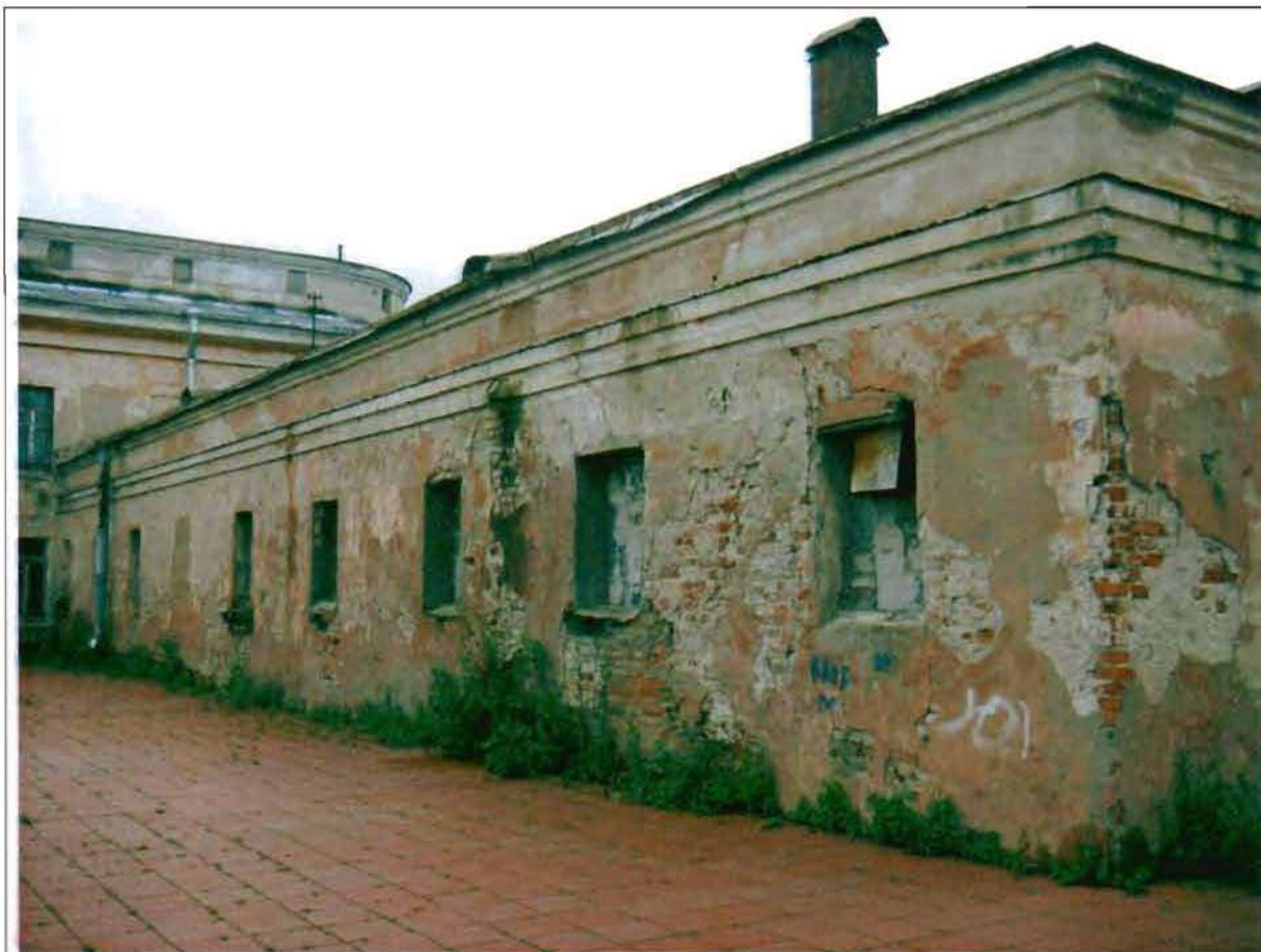
Фото 25. Восточный фасад. Общий вид.
