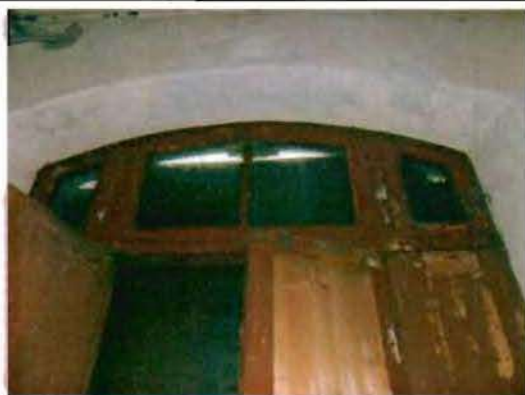
Фото 126. Дверное заполнение центральной части лестницы. Фрагмент.
