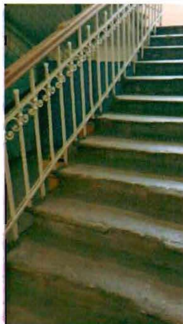
Фото 57. Лестница в центральной части здания. Фрагмент.
