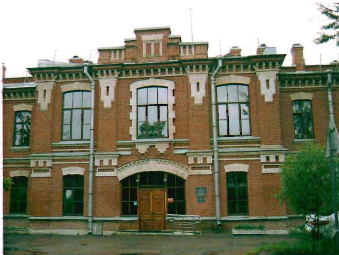
Фото 65. Северный фасад. Фрагмент центральной части фасада.
