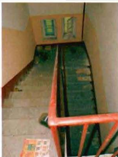
Фото 124. Лестница в южной части здания. Общий вид.
