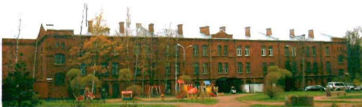
Фото 28. Восточный фасад. Общий вид.
