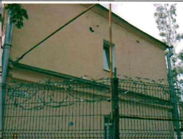
Фото 113. Северный фасад. Общий вид.
