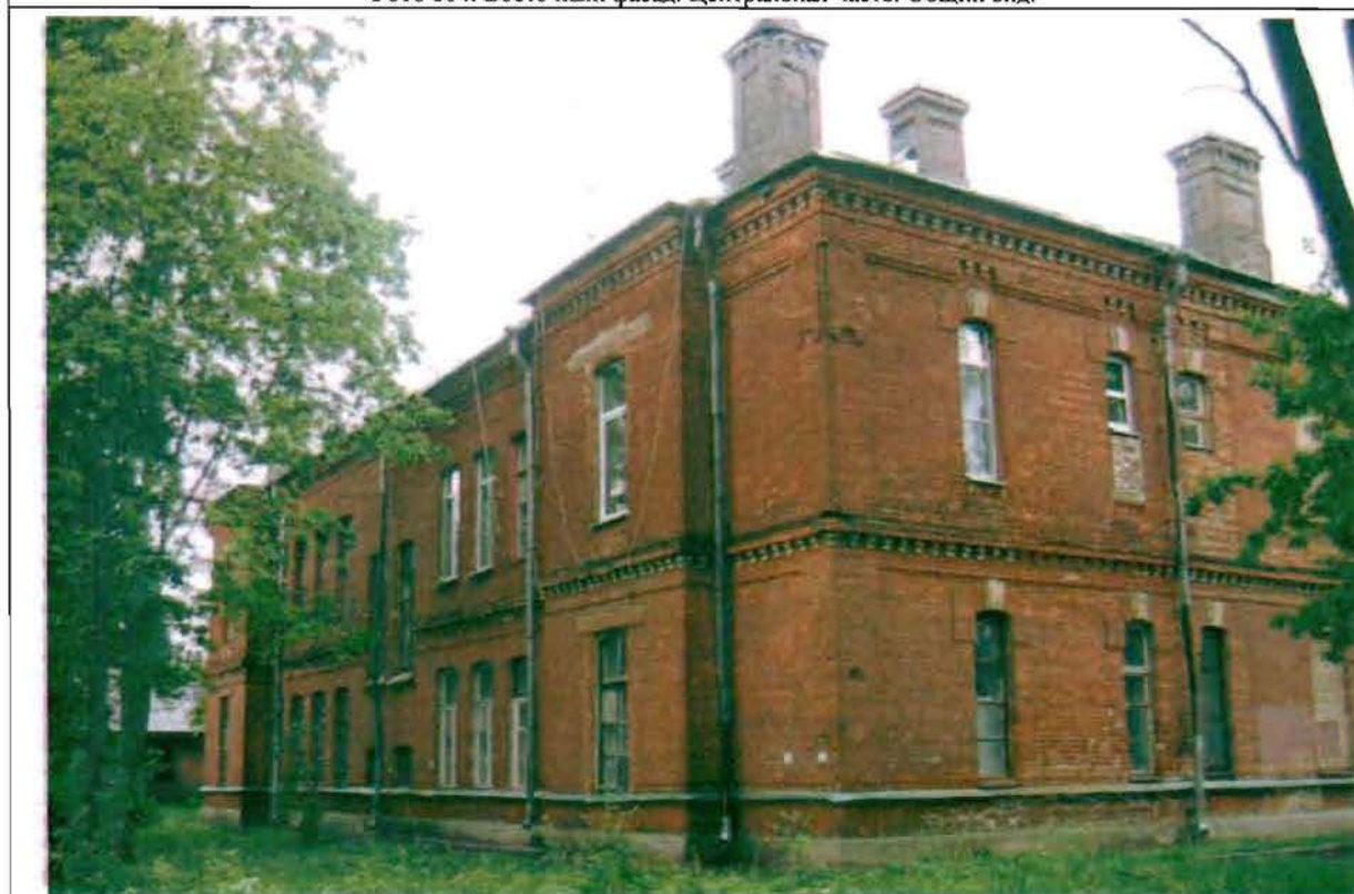
Фото 105. Западный, южный фасады. Общий вид.
