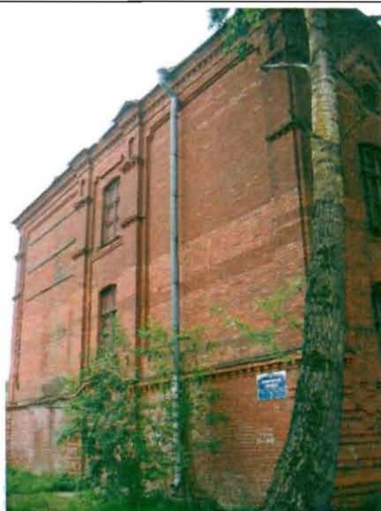
Фото 6. Северный фасад. Общий вид.
