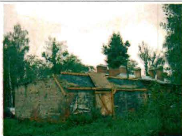
Фото 186. Западный, северный фасады. Общий вид.
