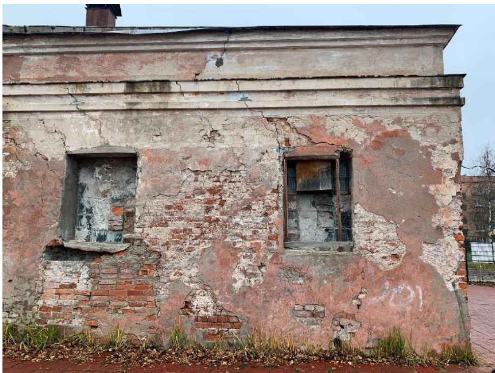
Фото 13. Вид на фрагмент фасада по оси 8.
