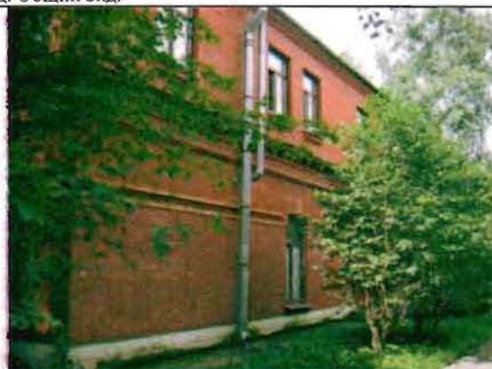
Фото 80. Северный фасад. Фрагмент.
