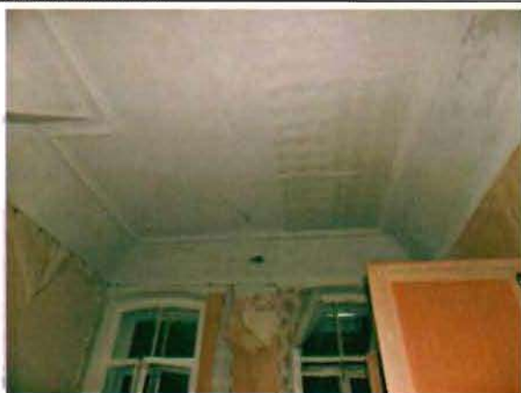
Фото 121. Помещение 1-го этажа.
