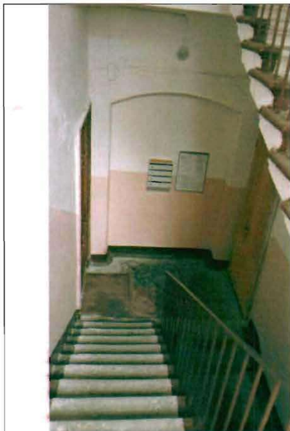
Фото 130. Лестница № 1 в южной части здания. Общий вид.
