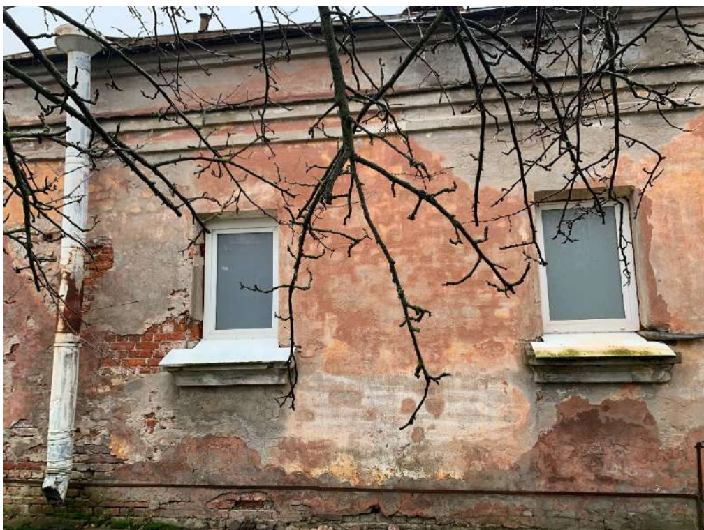
Фото 6. Вид на фрагмент фасада по оси А.
