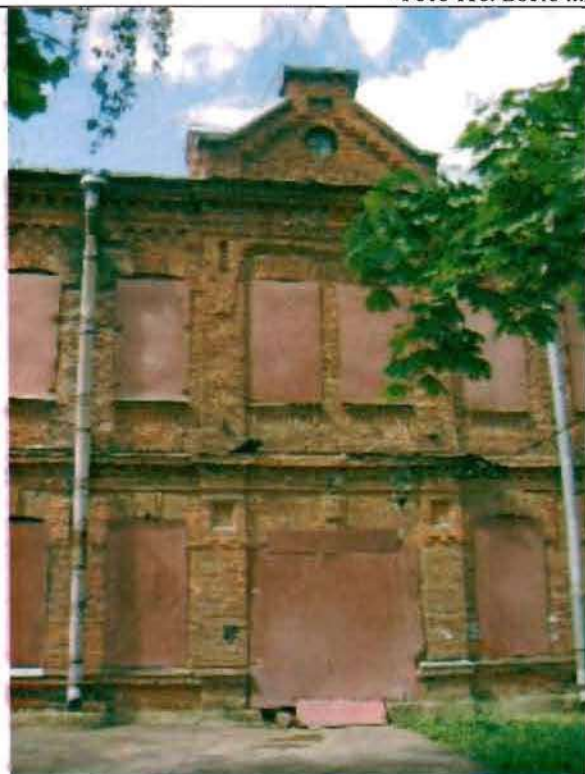
Фото 117. Восточный фасад. Фрагмент центральной части фасада.
