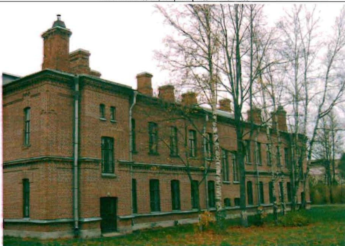
Фото 133. Восточный фасад. Общий вид.
