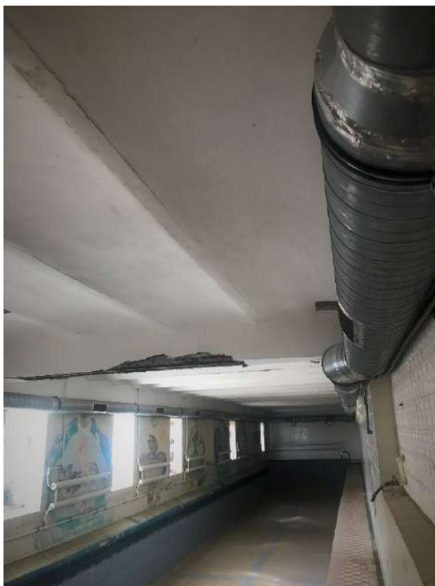
Фото 19. Общий вид помещения №14.
