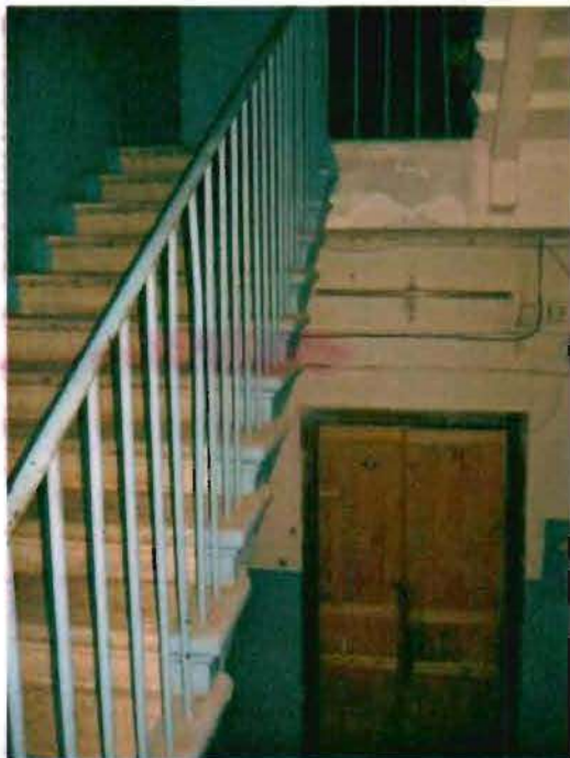
Фото 143. Лестница № 1 в северной части здания. Общий вид.
