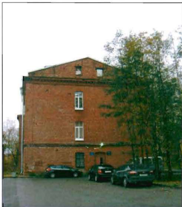
Фото 15. Северный фасад. Общий вид.
