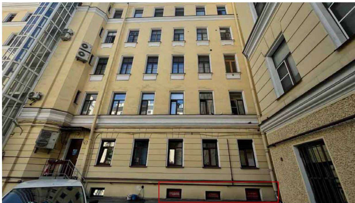
18. Вид на главный фасад здания и окна помещения №2-Н.
