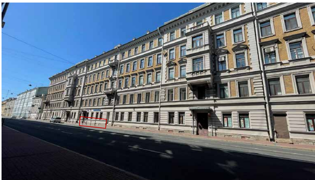
17. Вид на главный фасад здания и окна помещения №2-Н;
