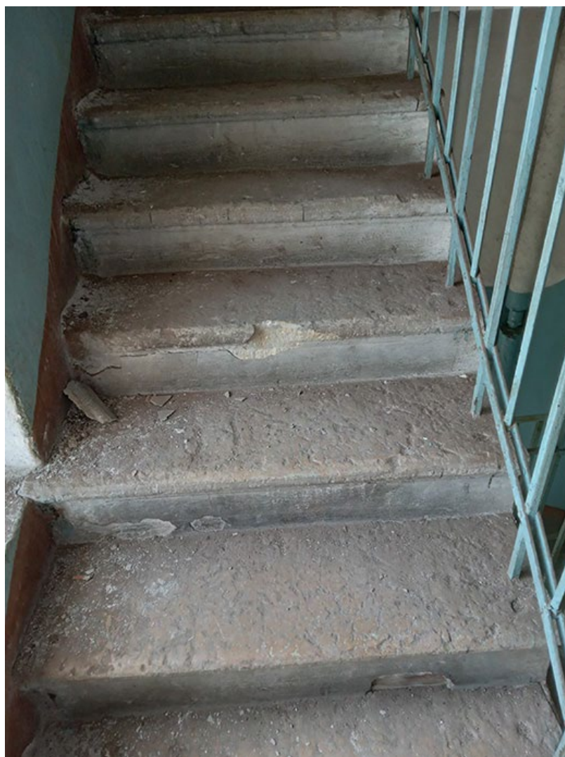
Фото 49. Выявленный объект культурного наследия «Здание детского приюта вел. кн. Александры Николаевны (со служебными постройками)» по адресу: г. Санкт-Петербург, Лермонтовский пр. 51, 12-я Красноармейская б/№
