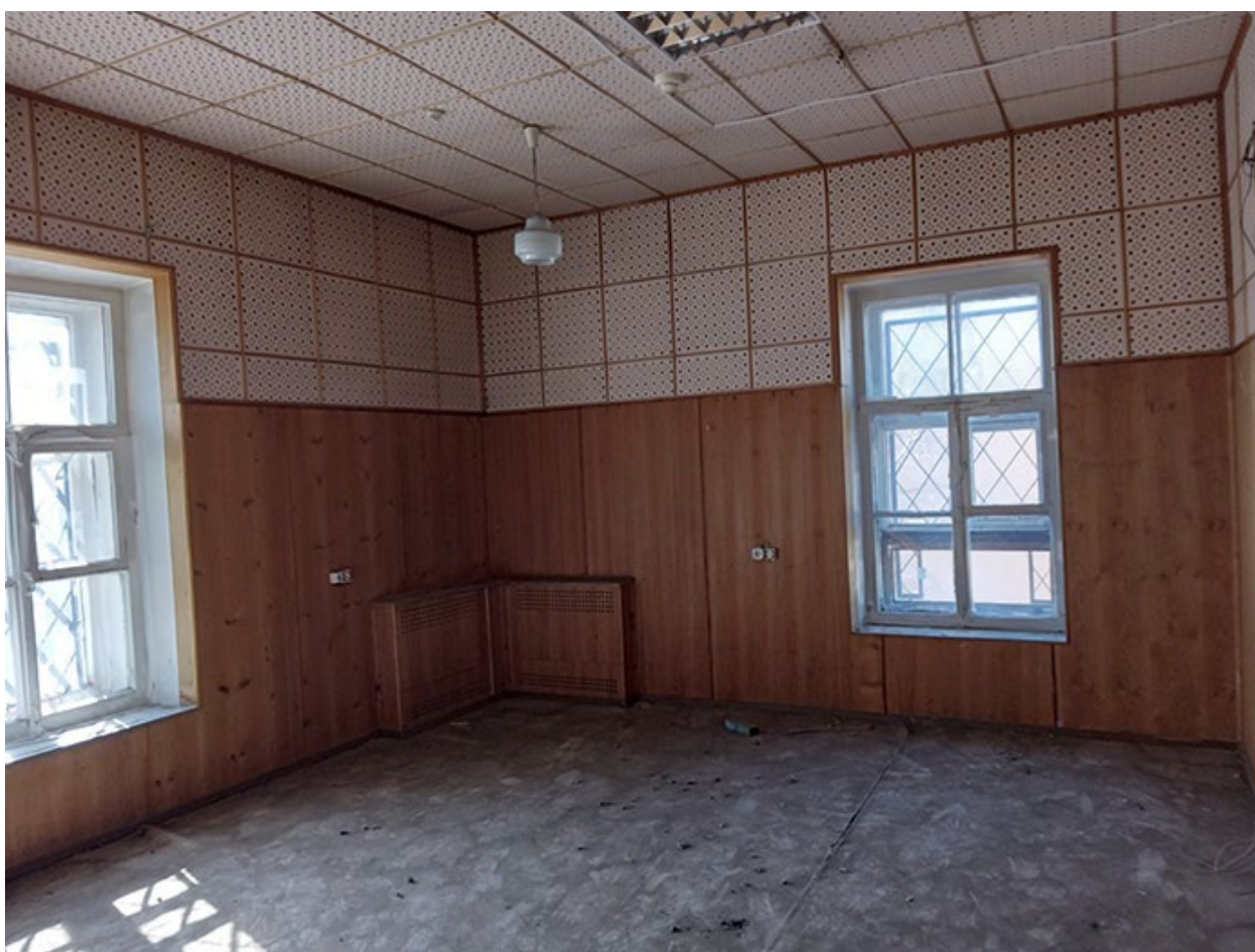
Фото 83. Выявленный объект культурного наследия «Здание детского приюта вел. кн. Александры Николаевны (со служебными постройками)» по адресу: г. Санкт-Петербург, Лермонтовский пр. 51, 12-я Красноармейская б/№
