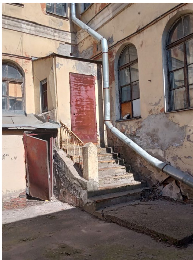
Фото 21. Выявленный объект культурного наследия «Здание детского приюта вел. кн. Александры Николаевны (со служебными постройками)» по адресу: г. Санкт-Петербург, Лермонтовский пр. 51, 12-я Красноармейская б/№
