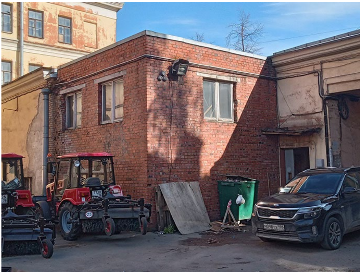
Фото 31. Выявленный объект культурного наследия «Здание детского приюта вел. кн. Александры Николаевны (со служебными постройками)» по адресу: г. Санкт-Петербург, Лермонтовский пр. 51, 12-я Красноармейская б/№
