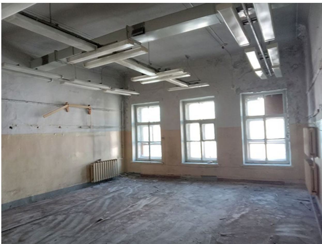
Фото 78. Выявленный объект культурного наследия «Здание детского приюта вел. кн. Александры Николаевны (со служебными постройками)» по адресу: г. Санкт-Петербург, Лермонтовский пр. 51, 12-я Красноармейская б/№
