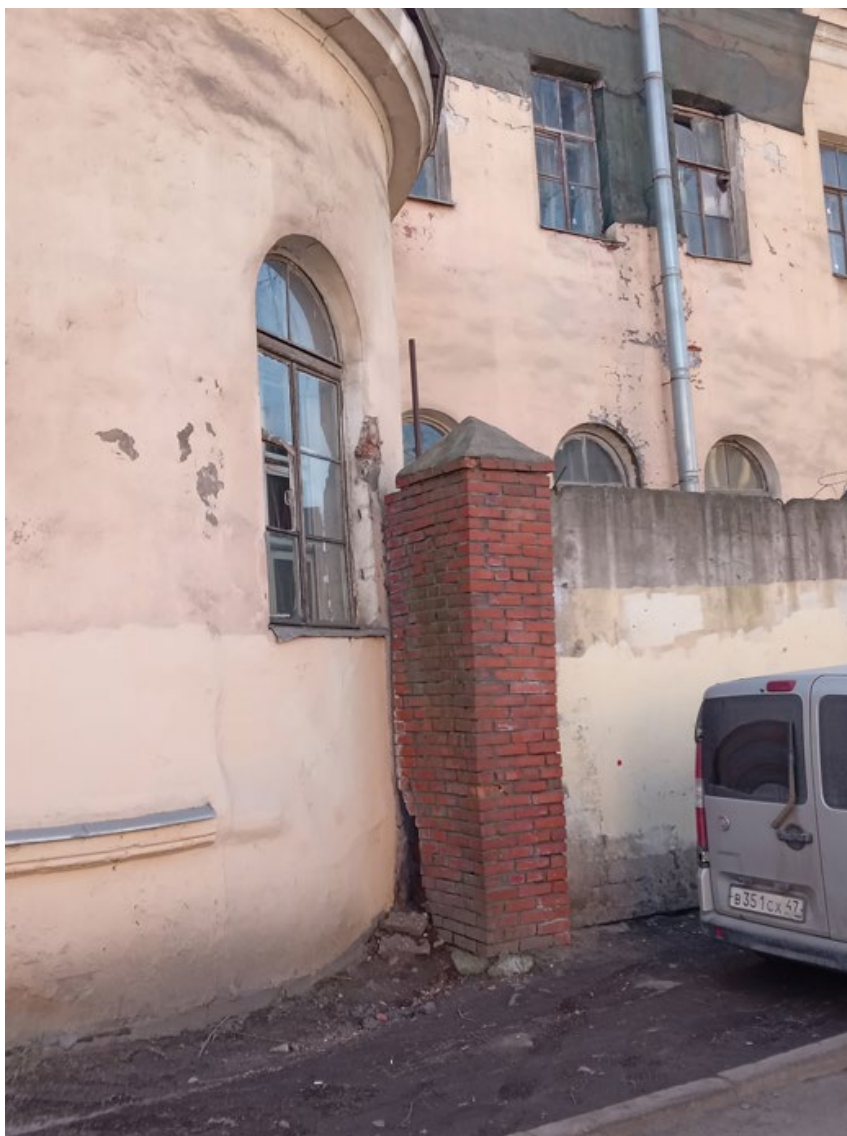
Фото 37. Выявленный объект культурного наследия «Здание детского приюта вел. кн. Александры Николаевны (со служебными постройками)» по адресу: г. Санкт-Петербург, Лермонтовский пр. 51, 12-я Красноармейская б/№
