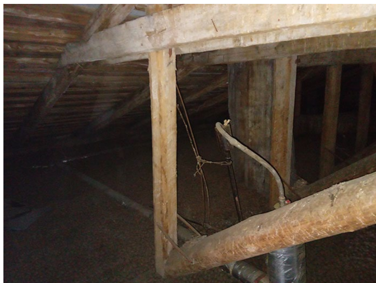
Фото 89, 90. Выявленный объект культурного наследия «Здание детского приюта вел. кн. Александры Николаевны (со служебными постройками)» по адресу: г. Санкт-Петербург, Лермонтовский пр. 51, 12-я Красноармейская б/№
