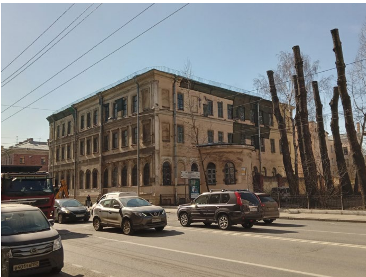
Фото 42. Выявленный объект культурного наследия «Здание детского приюта вел. кн. Александры Николаевны (со служебными постройками)» по адресу: г. Санкт-Петербург, Лермонтовский пр. 51, 12-я Красноармейская б/№
