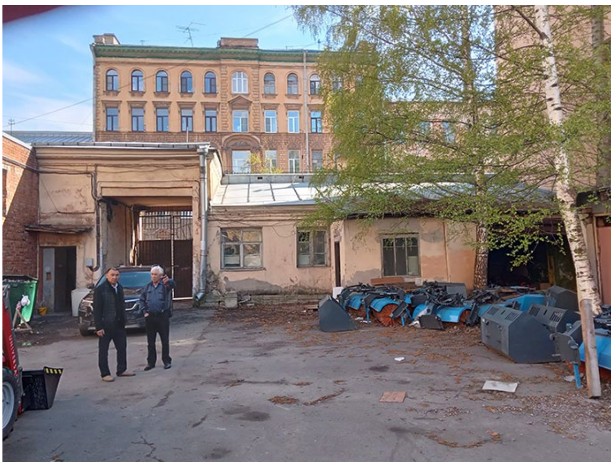
Фото 34. Выявленный объект культурного наследия «Здание детского приюта вел. кн. Александры Николаевны (со служебными постройками)» по адресу: г. Санкт-Петербург, Лермонтовский пр. 51, 12-я Красноармейская б/№
