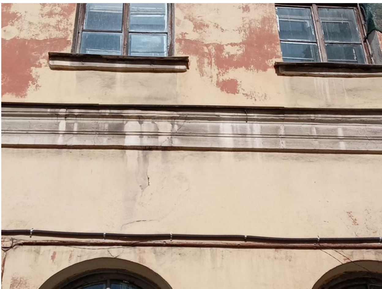
Фото 25. Выявленный объект культурного наследия «Здание детского приюта вел. кн. Александры Николаевны (со служебными постройками)» по адресу: г. Санкт-Петербург, Лермонтовский пр. 51, 12-я Красноармейская б/№
