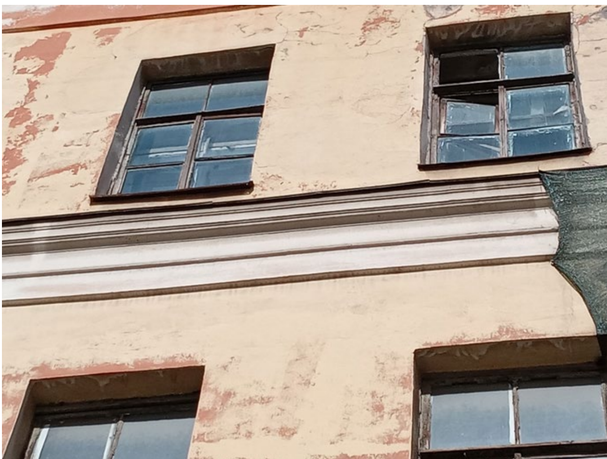
Фото 26. Выявленный объект культурного наследия «Здание детского приюта вел. кн. Александры Николаевны (со служебными постройками)» по адресу: г. Санкт-Петербург, Лермонтовский пр. 51, 12-я Красноармейская б/№
