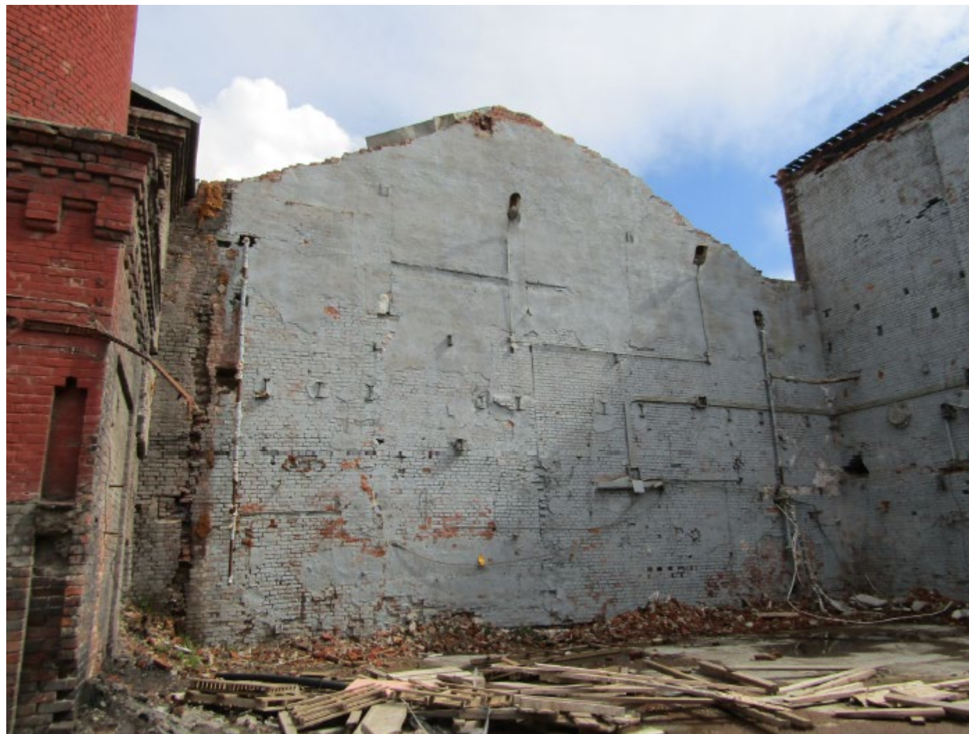
14. Выявленный ОКН «Производственное здание с дымовой трубой Киновиевского Ультрамаринового завода Г.И. Веге», по адресу: г. Санкт-Петербург, Октябрьская набережная, дом 38, литера АН. Литера АН-6. Вид с юго-запада. Дата съемки: 13.09.2023.
