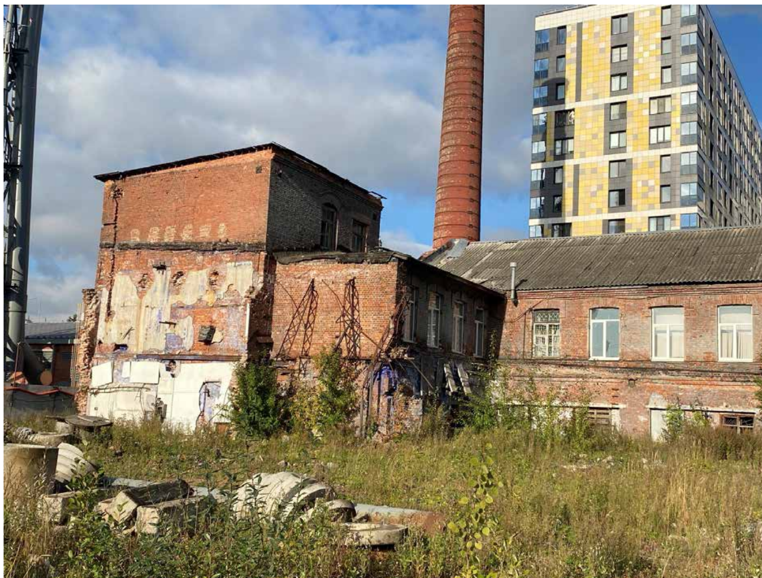
7. Выявленный ОКН «Производственное здание с дымовой трубой Киновиевского Ультрамаринового завода Г.И. Веге», по адресу: г. Санкт-Петербург, Октябрьская набережная, дом 38, литера АН. Общий вид Лит. АН-5 с северо-востока. Дата съемки: 13.09.2023.
