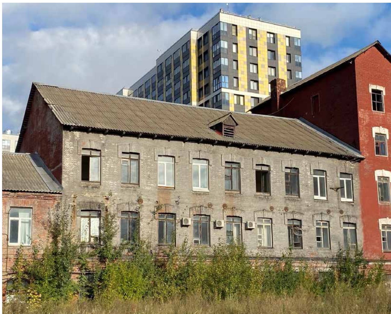
10. Выявленный ОКН «Производственное здание с дымовой трубой Киновиевского Ультрамаринового завода Г.И. Веge», по адресу: г. Санкт-Петербург, Октябрьская набережная, дом 38, литера АН. Фрагмент фасада Лит. АН-6. Вид с юго-востока. Дата съемки: 13.09.2023.
