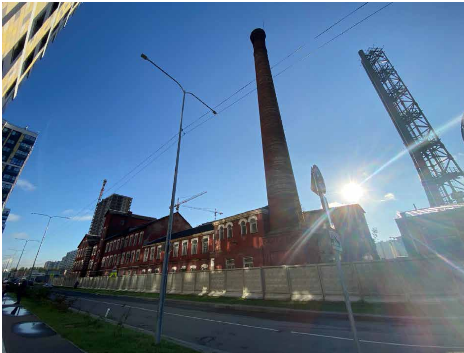
2. Выявленный ОКН «Производственное здание с дымовой трубой Киновиевского Ультрамаринового завода Г.И. Веге», по адресу: г. Санкт-Петербург, Октябрьская набережная, дом 38, литера АН. Лицевой фасад здания (Лит. АН-6; АН-8; АН-10). Общий вид с юго-запада. Дата съемки: 13.09.2023.
