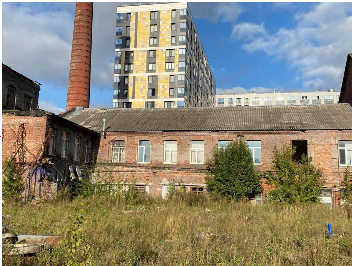
9. Выявленный ОКН «Производственное здание с дымовой трубой Киновиевского Ультрамаринового завода Г.И. Веге», по адресу: г. Санкт-Петербург, Октябрьская набережная, дом 38, литера АН. Фрагмент фасада Лит. АН-6. Вид с востока. Дата съемки: 13.09.2023.
