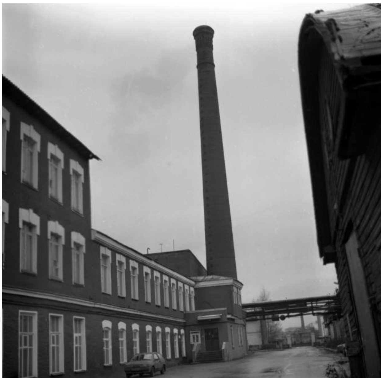
42. Историческое здание Ультрамаринового завода. 26.11.1996 г. Личный архив Е. Иванова.
