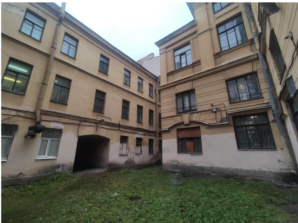
13. Часть объекта культурного наследия «Здания, в которых 1885-1918 гг. находились Высшие женские (Бестужевские) курсы. Здесь преподавали Бестужев-Рюмин К.Н., Менделеев Д.И., Бутлеров А.М., Сеченов И.М. и другие деятели науки» по адресу: Санкт-Петербург, 10-я линия В.О., дом 31-33, литера А. Общий вид дворовых фасадов.
