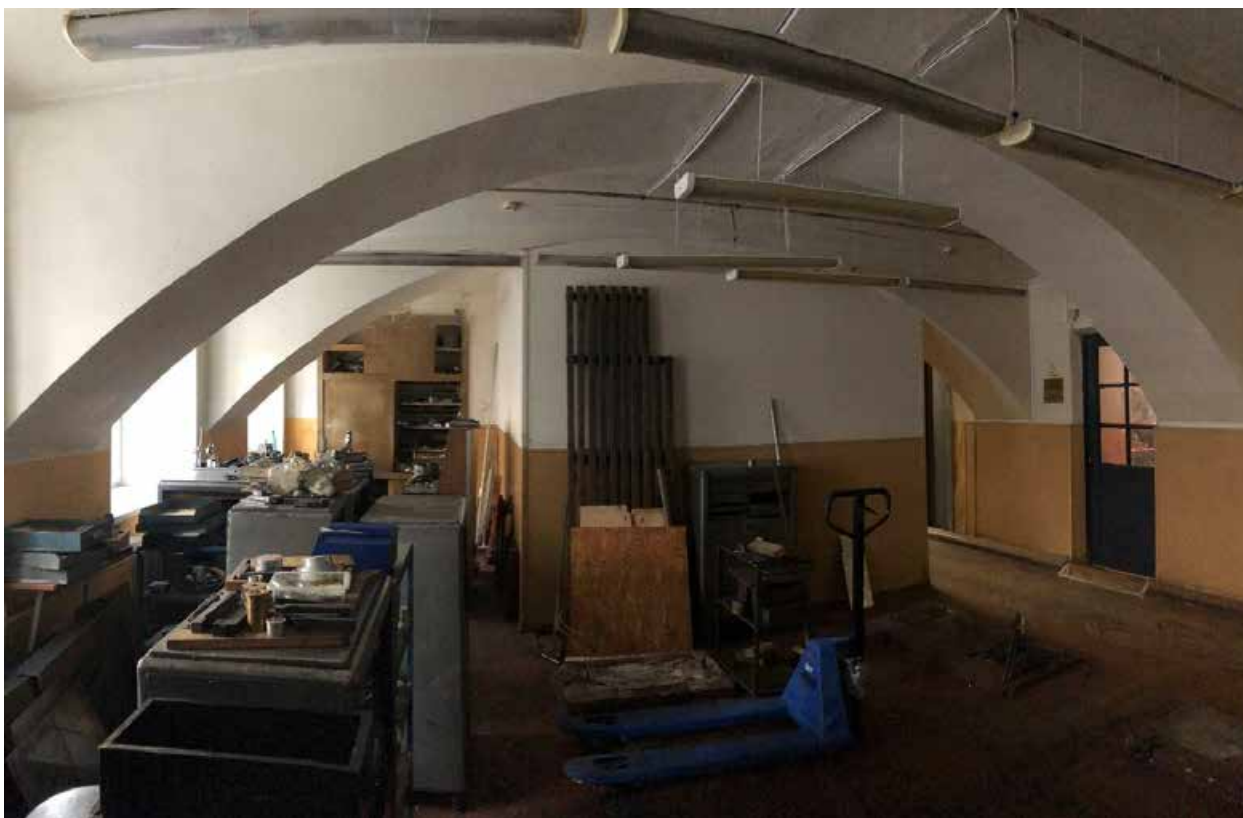
Фото 36. 1 этаж. Помещение № 14 (1-Н).
