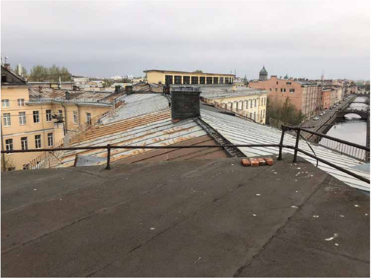
Фото 119. Вид на крышу здания.
