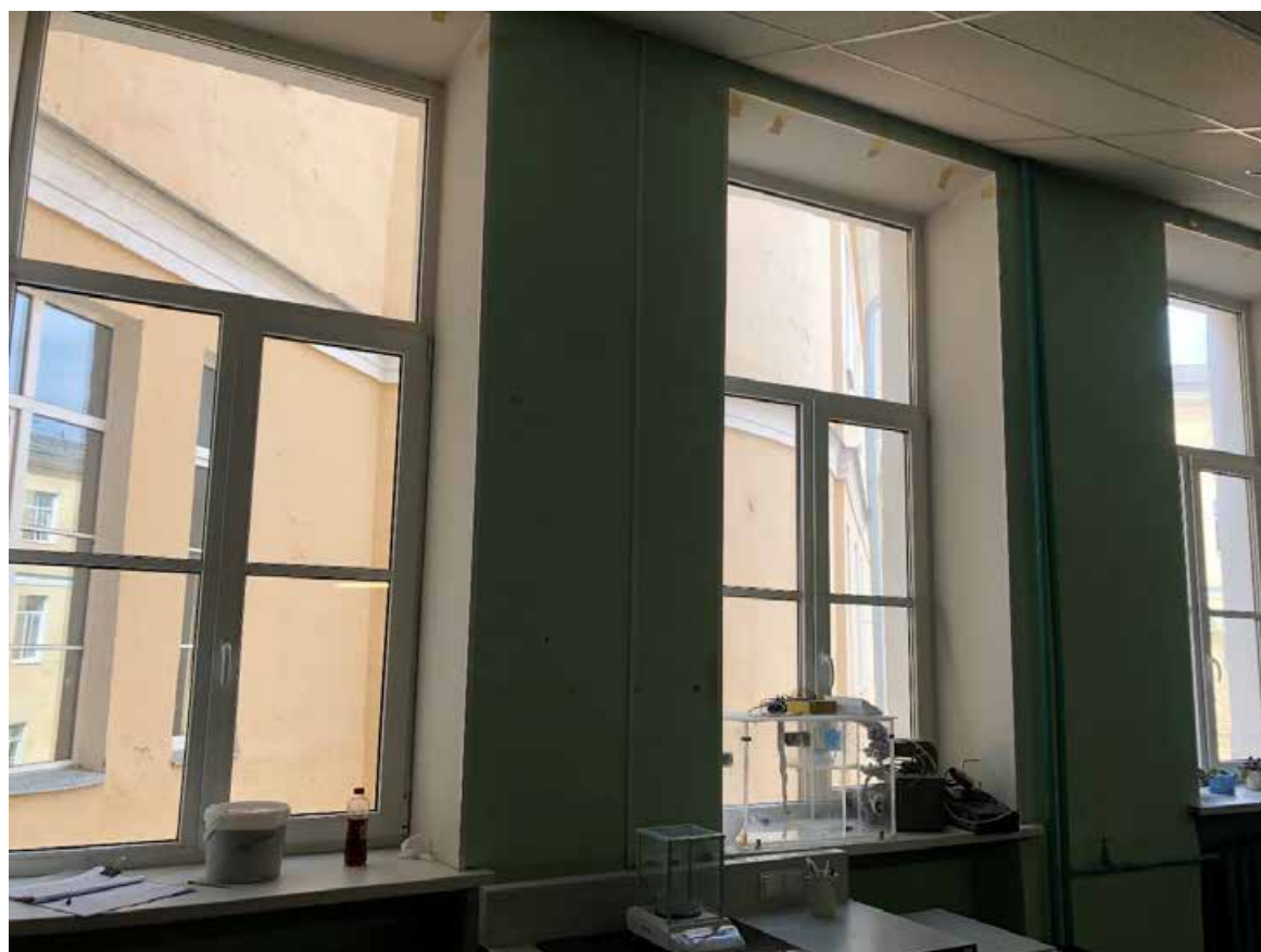
Фото 74. 3 этаж. Помещение № 3 (44-Н).
