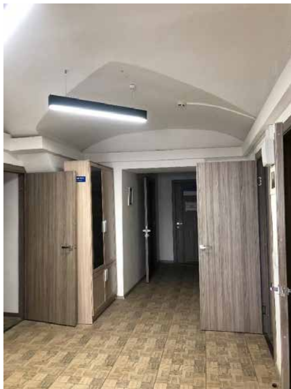
Фото 29. 1 этаж. Помещение № 21 (4-Н).
