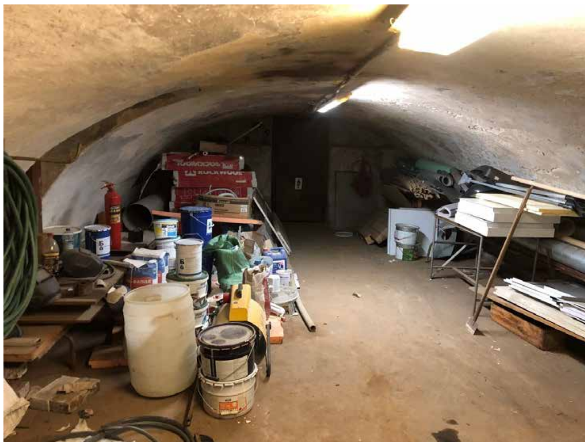
Фото 3. Вид на помещение подвала.
