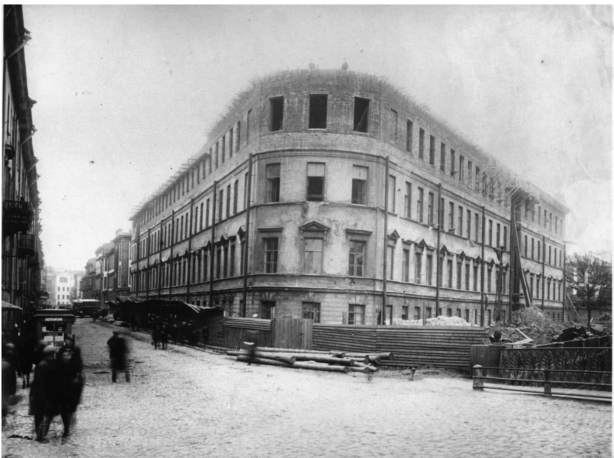
Илл. 10. Строительство 4-го этажа. Дата: 1931-1932 гг. Источник: Музей университета ИТМО ( https://museum.itmo.ru/album/4/ ).
