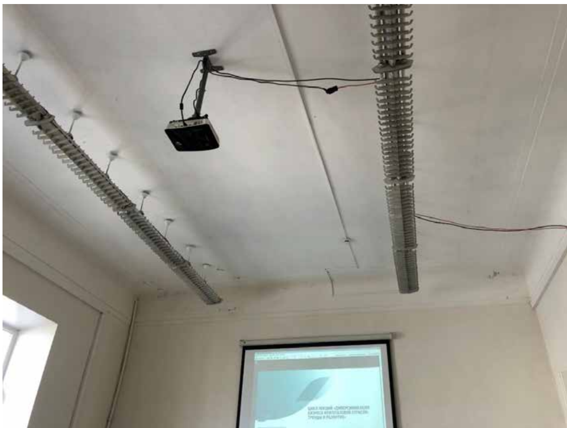
Фото 92. 3 этаж. Помещение № 9 (12-Н).
