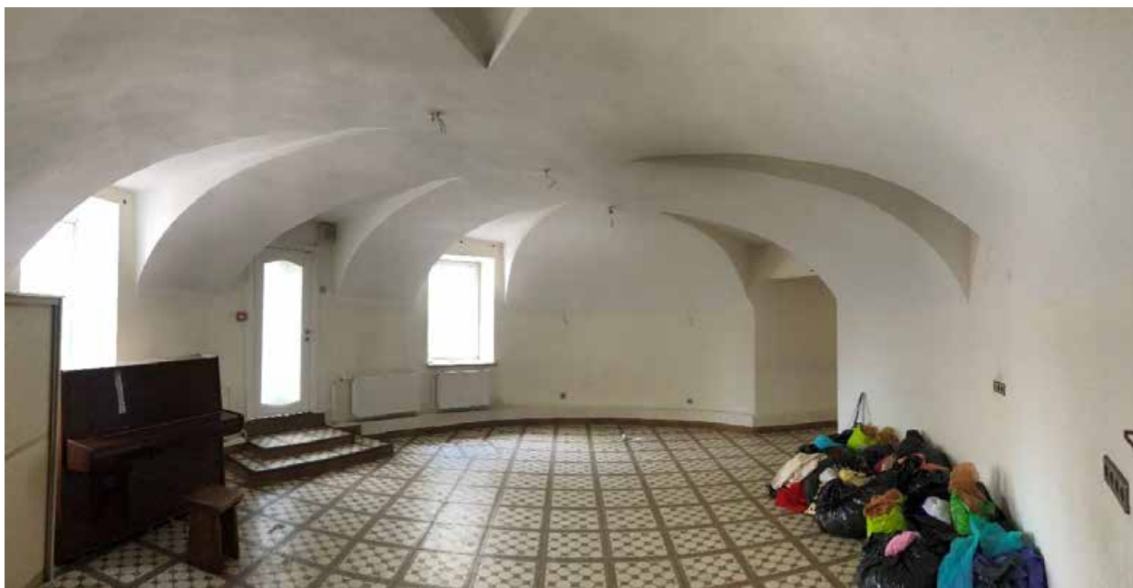
Фото 16. 1 этаж. Помещение № 1 (6-Н).
