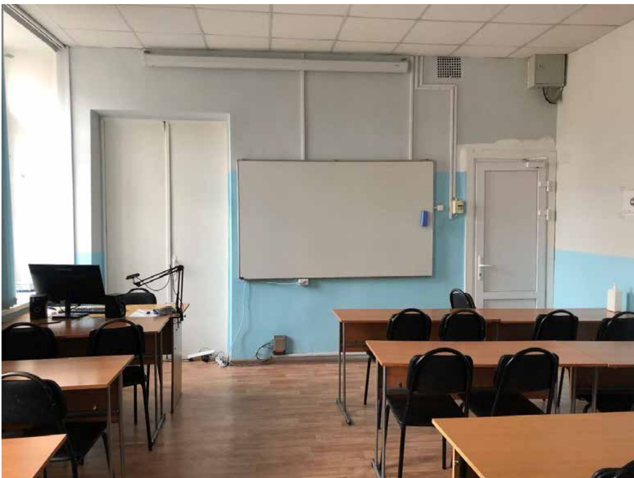
Фото 101. 4 этаж. Помещение № 3 (13-Н).
