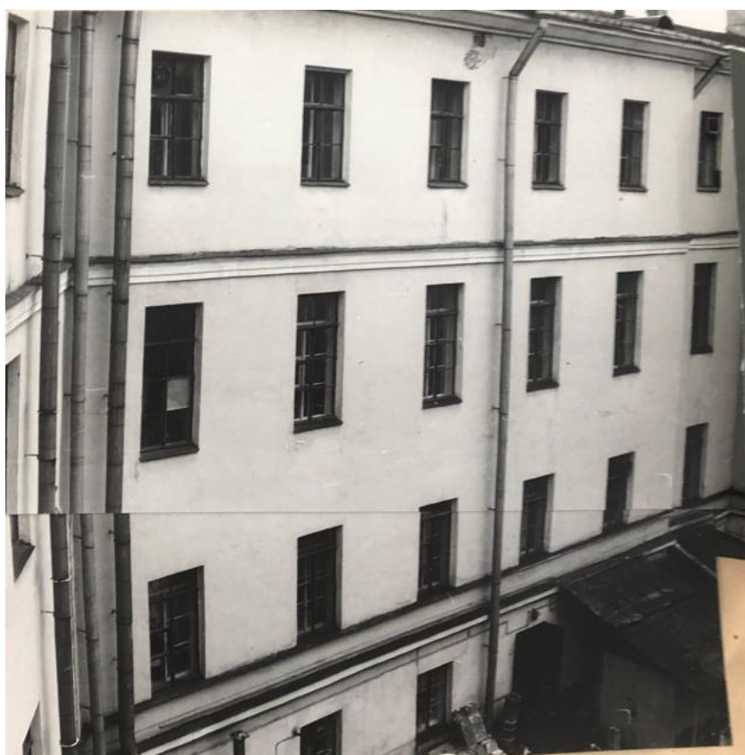
Илл. 25. Дворовые фасады. Дата: 1985 г.
