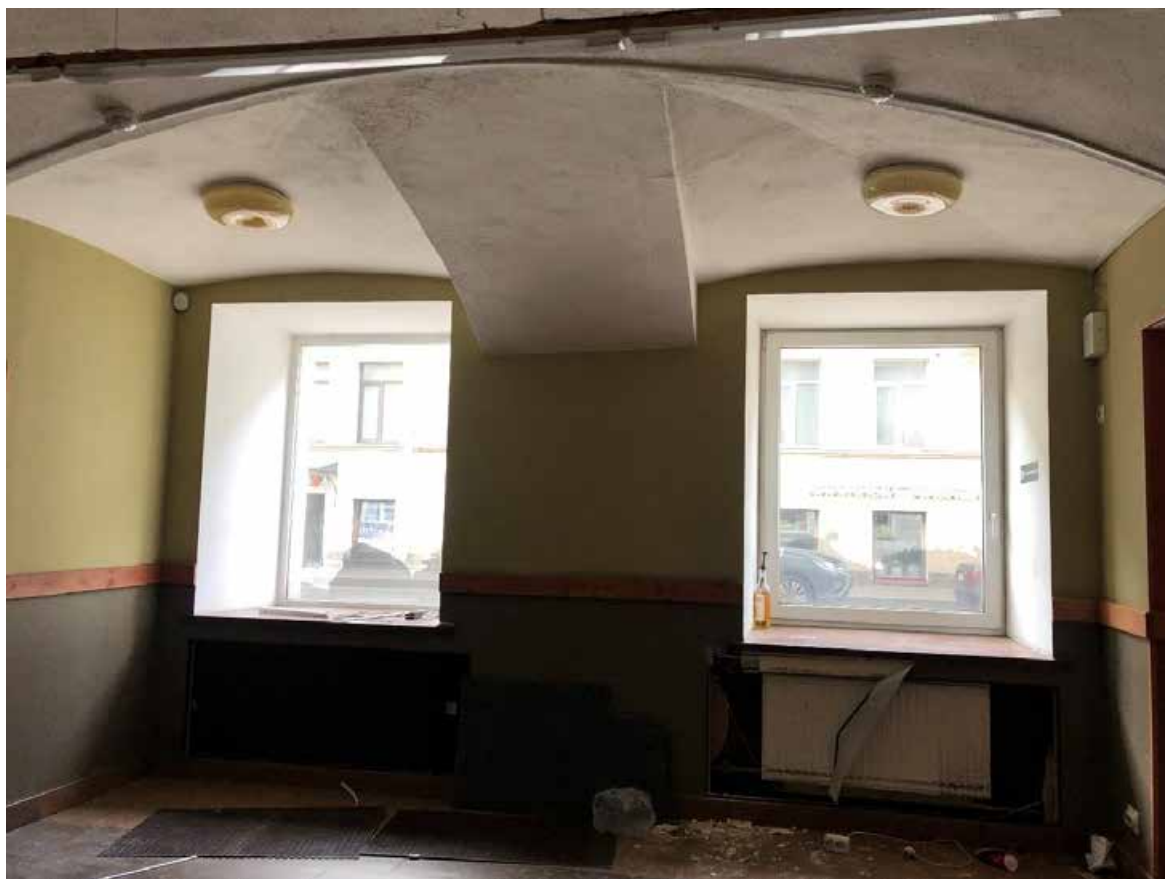
Фото 18. 1 этаж. Помещение № 15 (6-Н).
