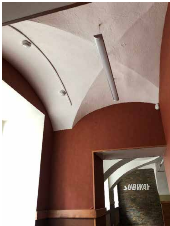
Фото 20. 1 этаж. Помещение № 17 (6-Н).
