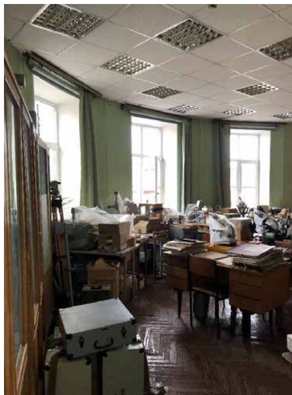
Фото 108. 4 этаж. Помещение № 2 (47-Н).
