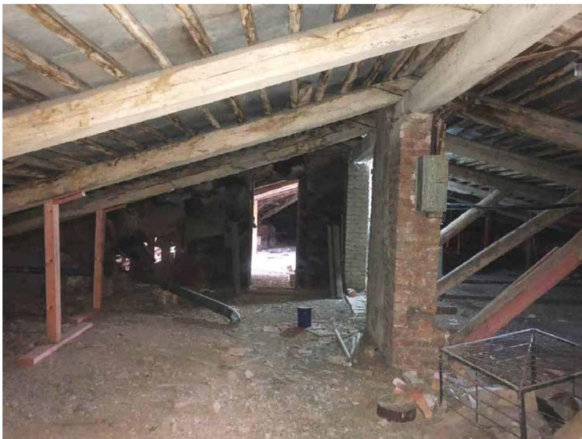
Фото 116. Вид чердачного помещения.
