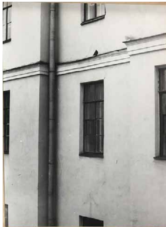
Илл. 31. Фрагмент дворового фасада. Дата: 1985 г. Источник: отчет «Инженерное обследование строительных конструкций Учебного корпуса № 2 по переулку Гривцова, дом № 14», предоставленный администрацией ИТМО.
