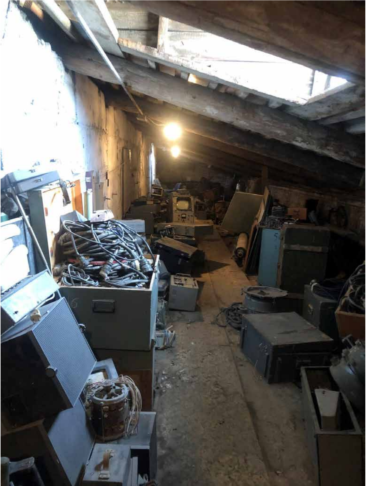
Фото 118. Вид на чердачное помещение.
