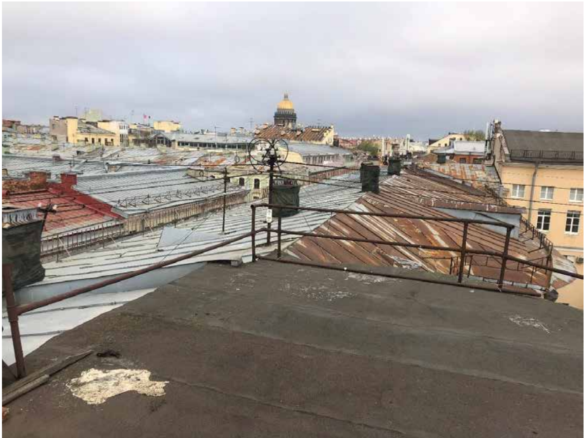
Фото 120. Вид на крышу здания.
