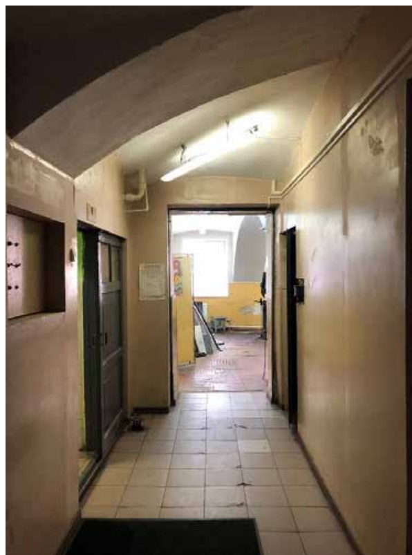
Фото 34. 1 этаж. Помещение № 26 (1-Н).
