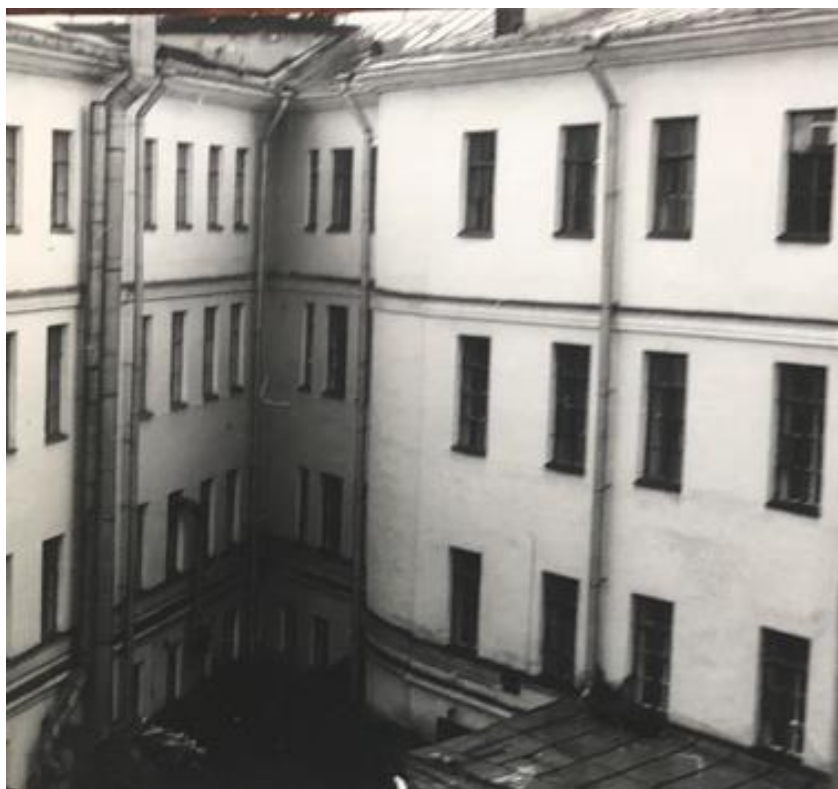
Илл. 24. Дворовые фасады. Дата: 1985 г.
