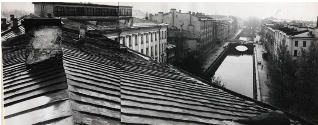
Илл. 29. Вид на кровлю. Дата: 1985 г.
