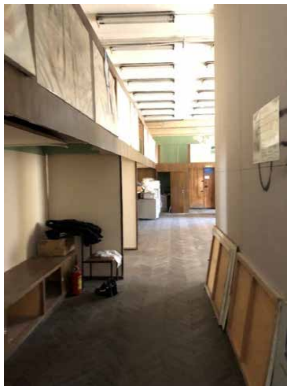
Фото 67. 2 этаж. Помещение № 13 (40-Н).
