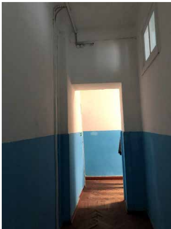
Фото 99. 4 этаж. Помещение № 1 (13-Н).
