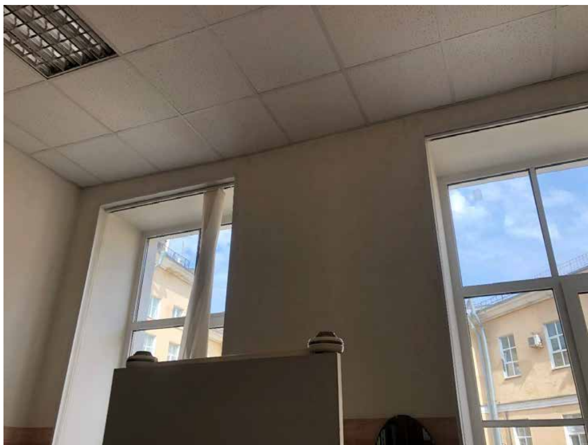
Фото 81. 3 этаж. Помещение № 5 (10-Н).
