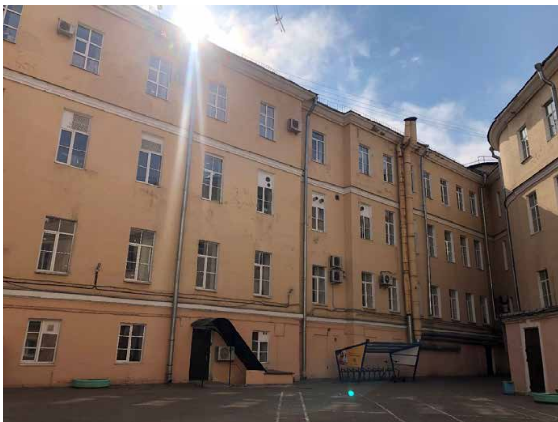
Фото 10. Вид на дворовой фасад.
