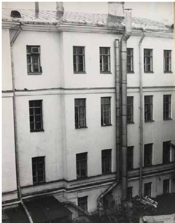
Илл. 30. Фрагмент дворового фасада. Дата: 1985 г. Источник: отчет «Инженерное обследование строительных конструкций Учебного корпуса № 2 по переулку Гривцова, дом № 14», предоставленный администрацией ИТМО.
