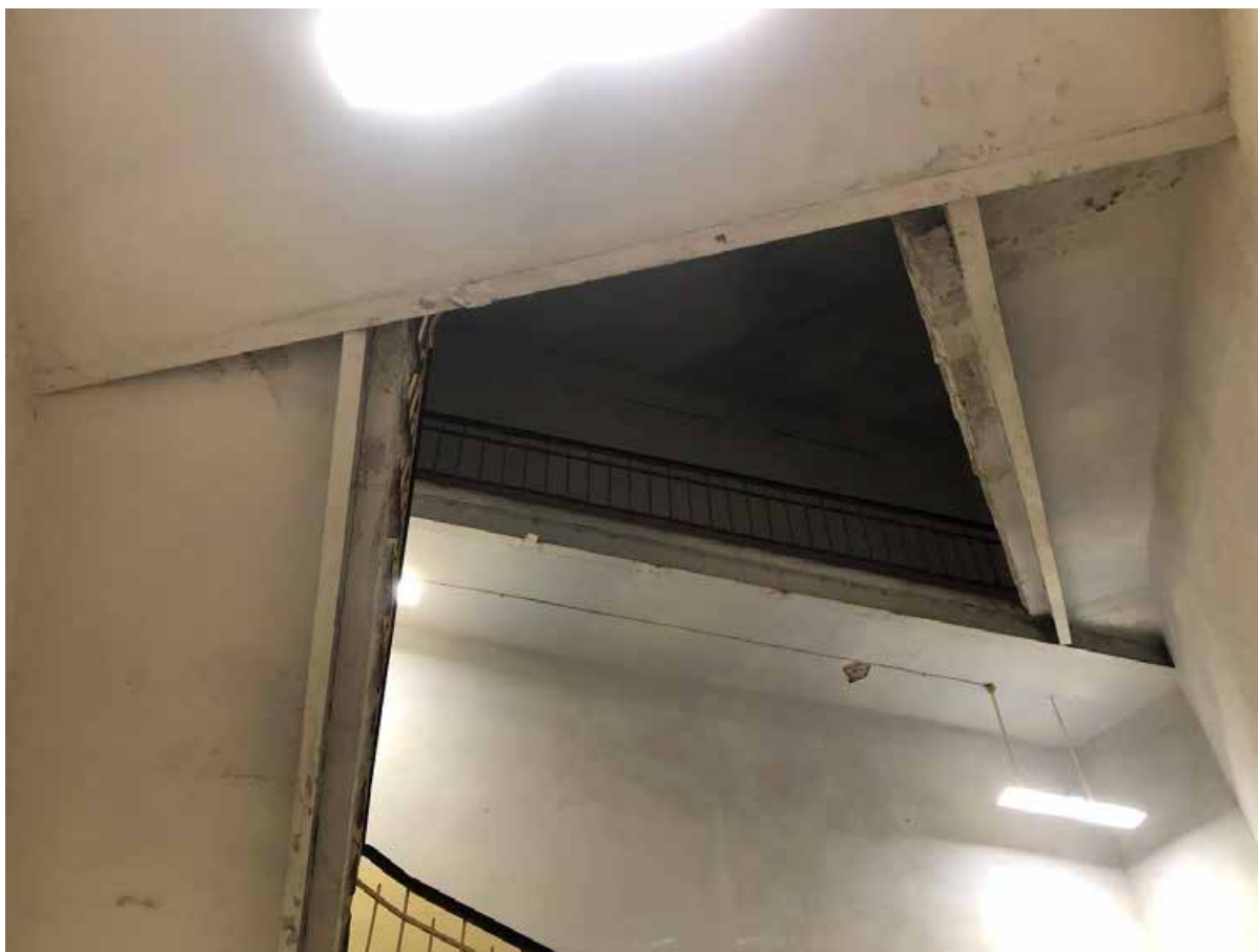
Фото 26. Вид на лестницу 6 ЛК.
