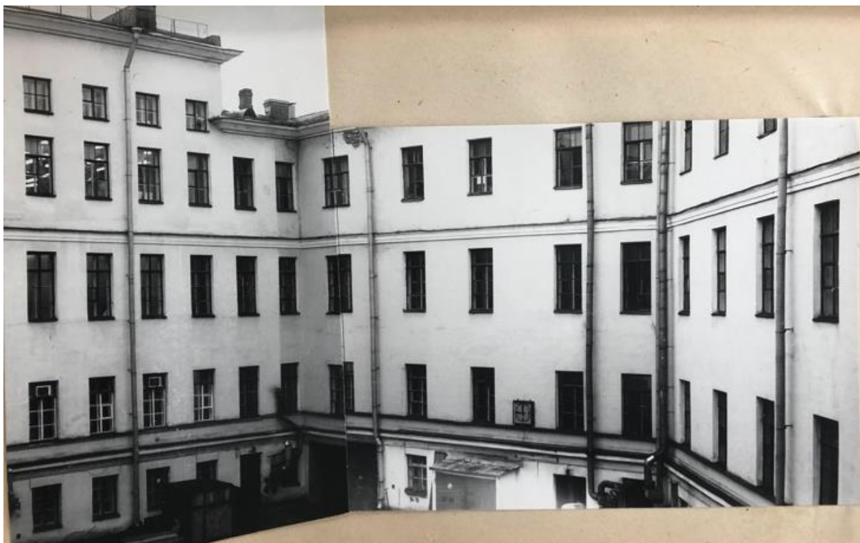
Илл. 26. Дворовые фасады. Дата: 1985 г.
