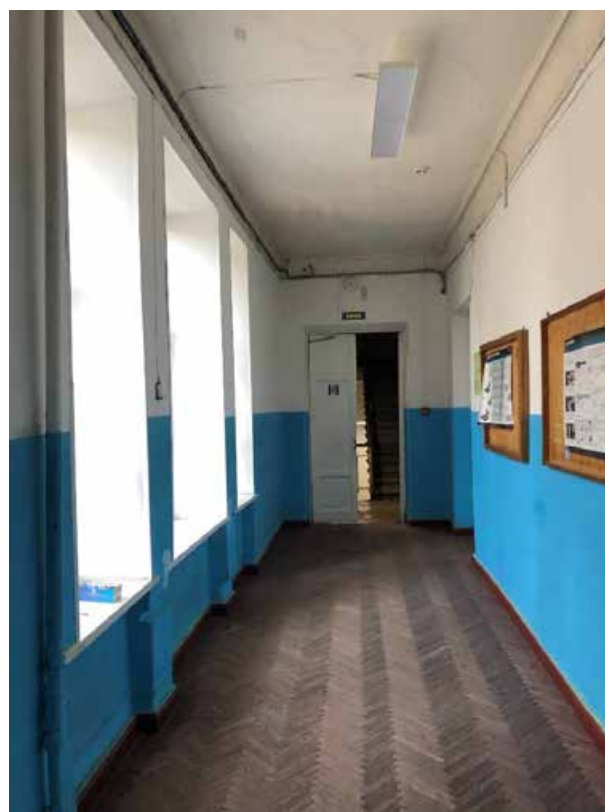
Фото 103. 4 этаж. Помещение № 2 (13-Н).
