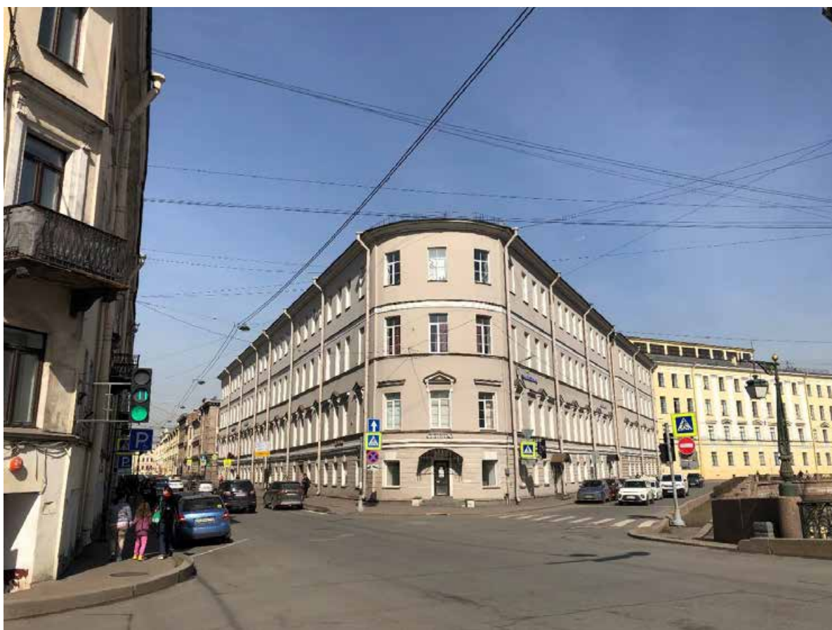
Фото 4. Вид на угол пересечения набережной канала Грибоедова и переулка Гривцова.
