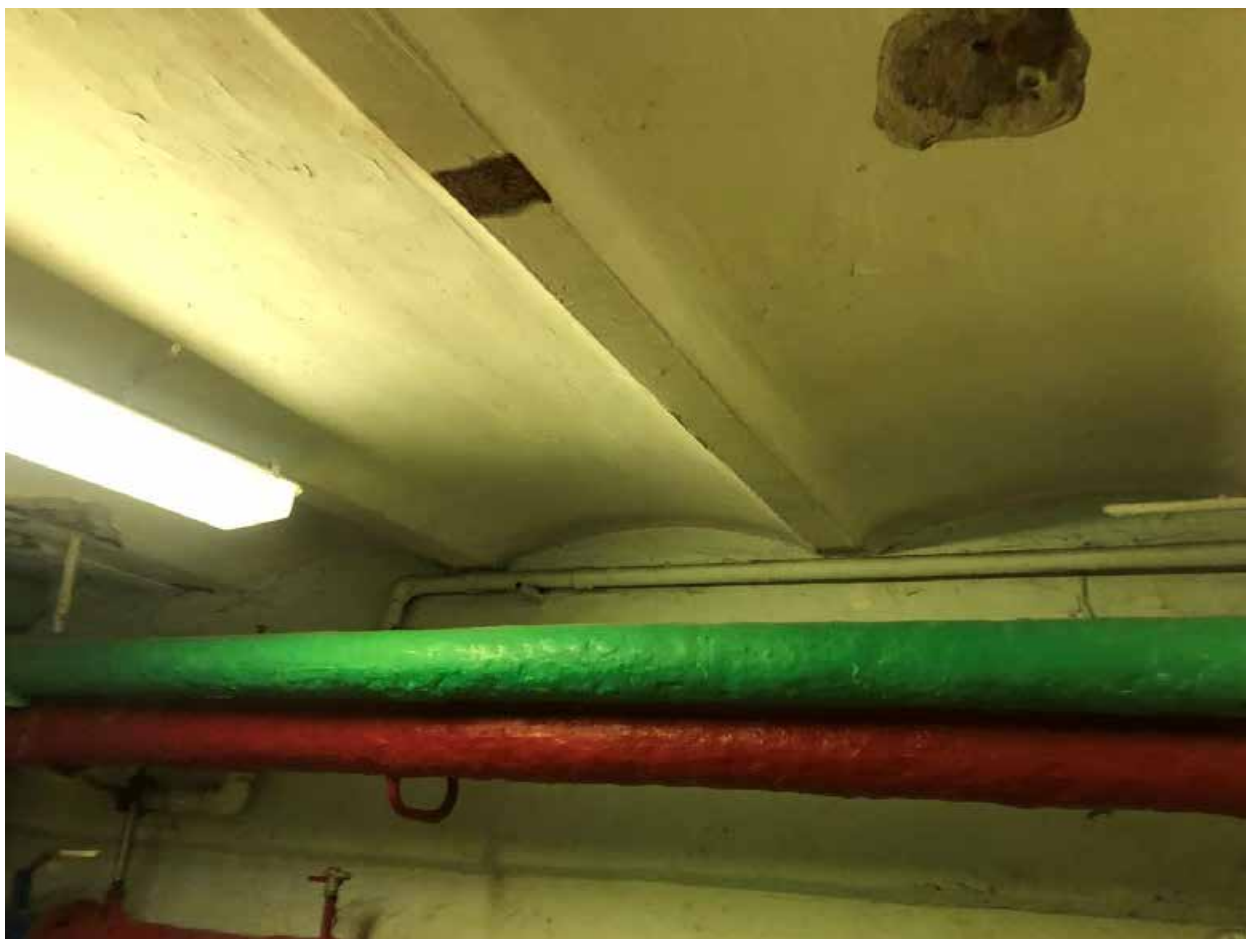
Фото 4. Прусские своды в помещении подвала.
