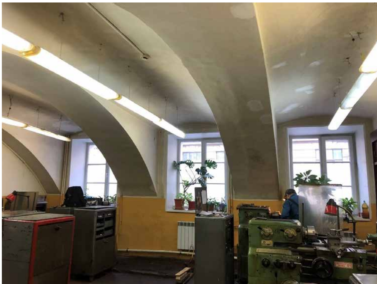
Фото 38. 1 этаж. Помещение № 13 (1-Н).
