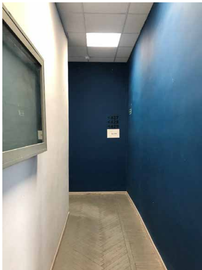
Фото 94. 4 этаж. Помещение № 1 (14-Н).
