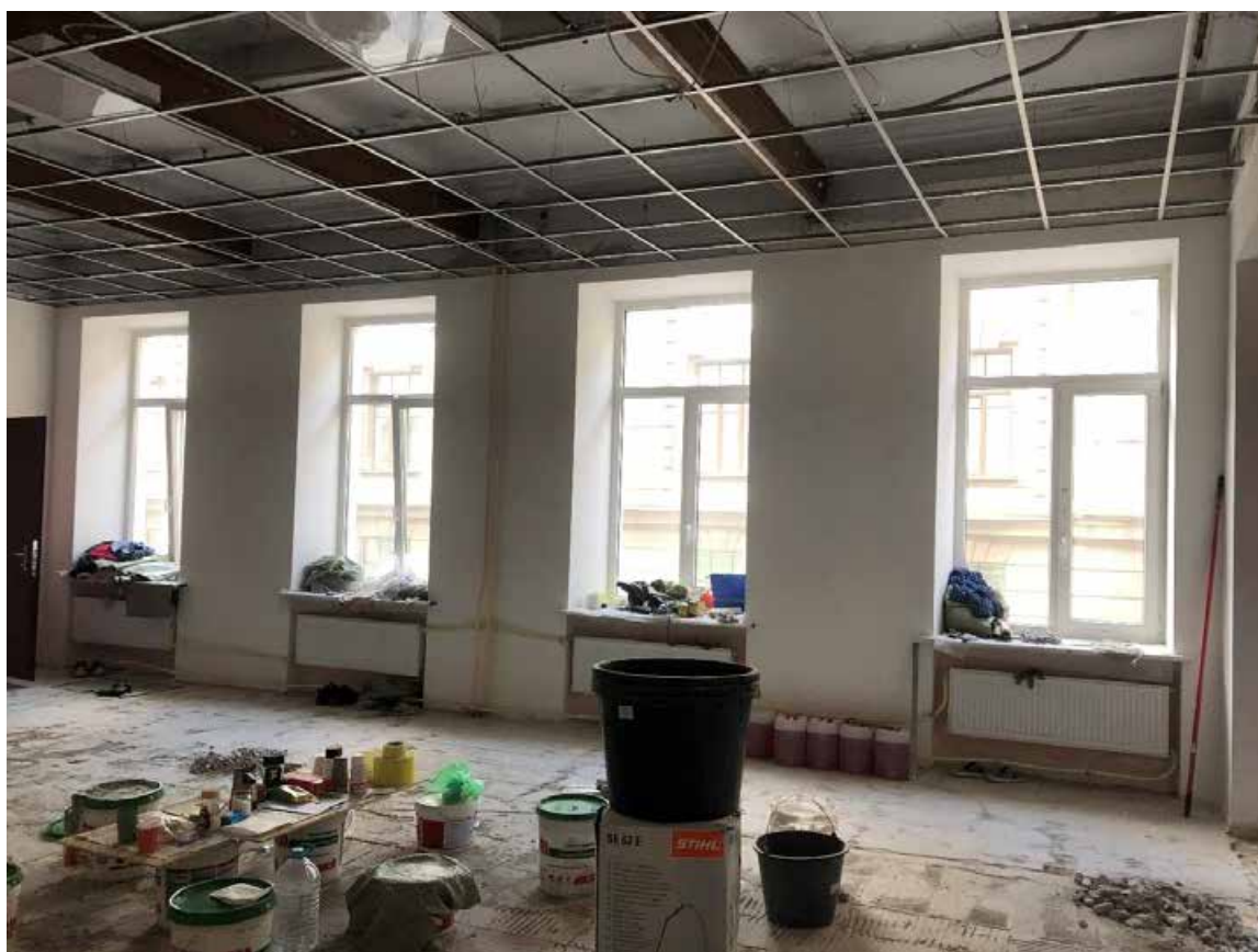
Фото 47. 2 этаж. Помещение № 34 (7-Н).
