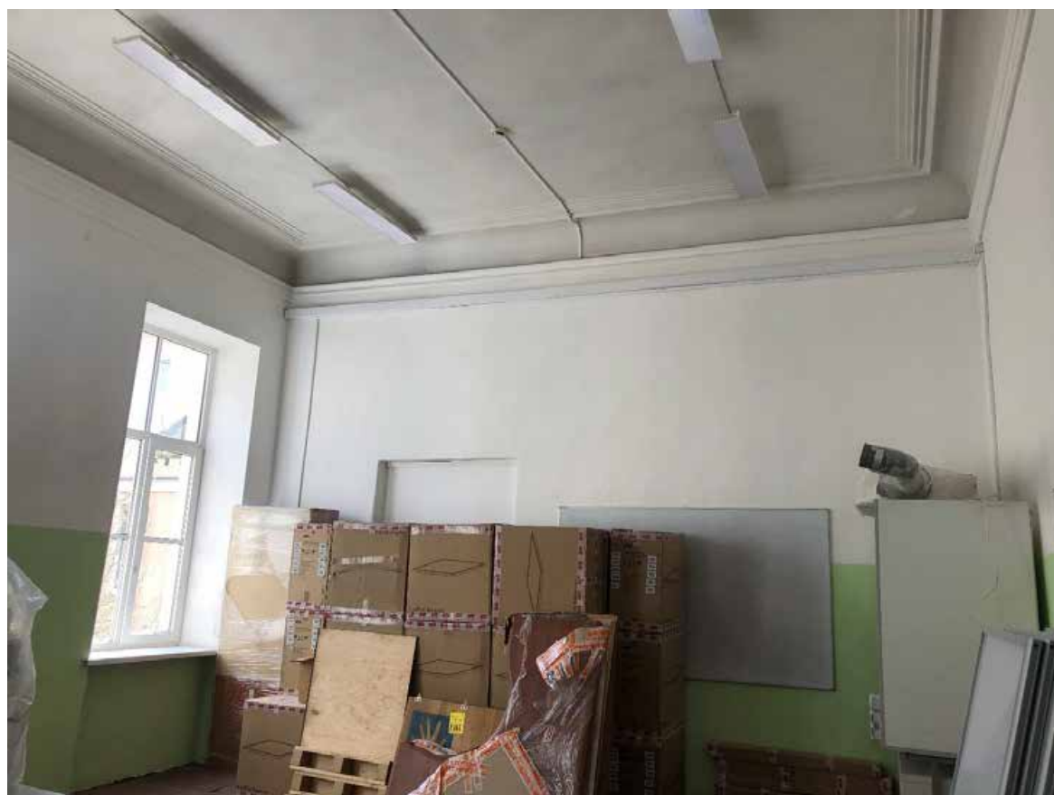
Фото 88. 3 этаж. Помещение № 12 (12-Н).
