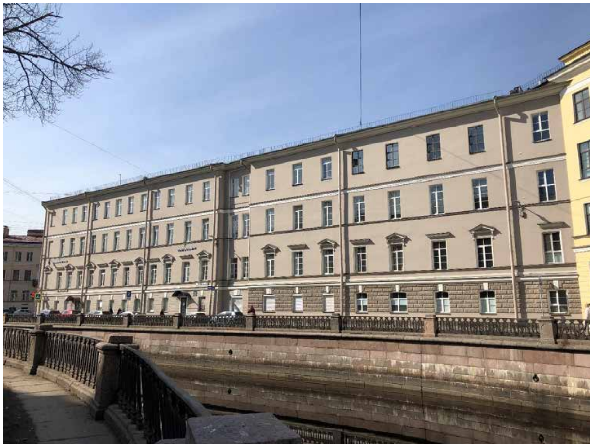
Фото 2. Юго-восточный лицевой фасад.
