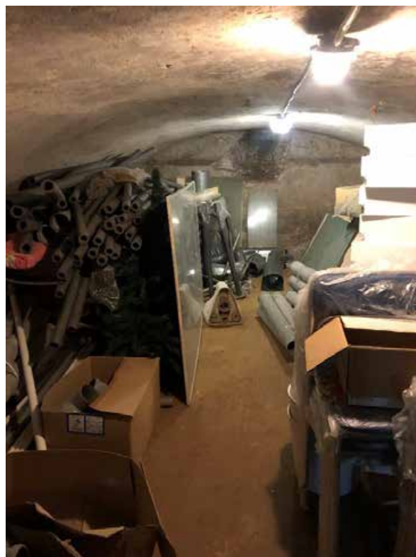
Фото 2. Вид на помещение подвала.
