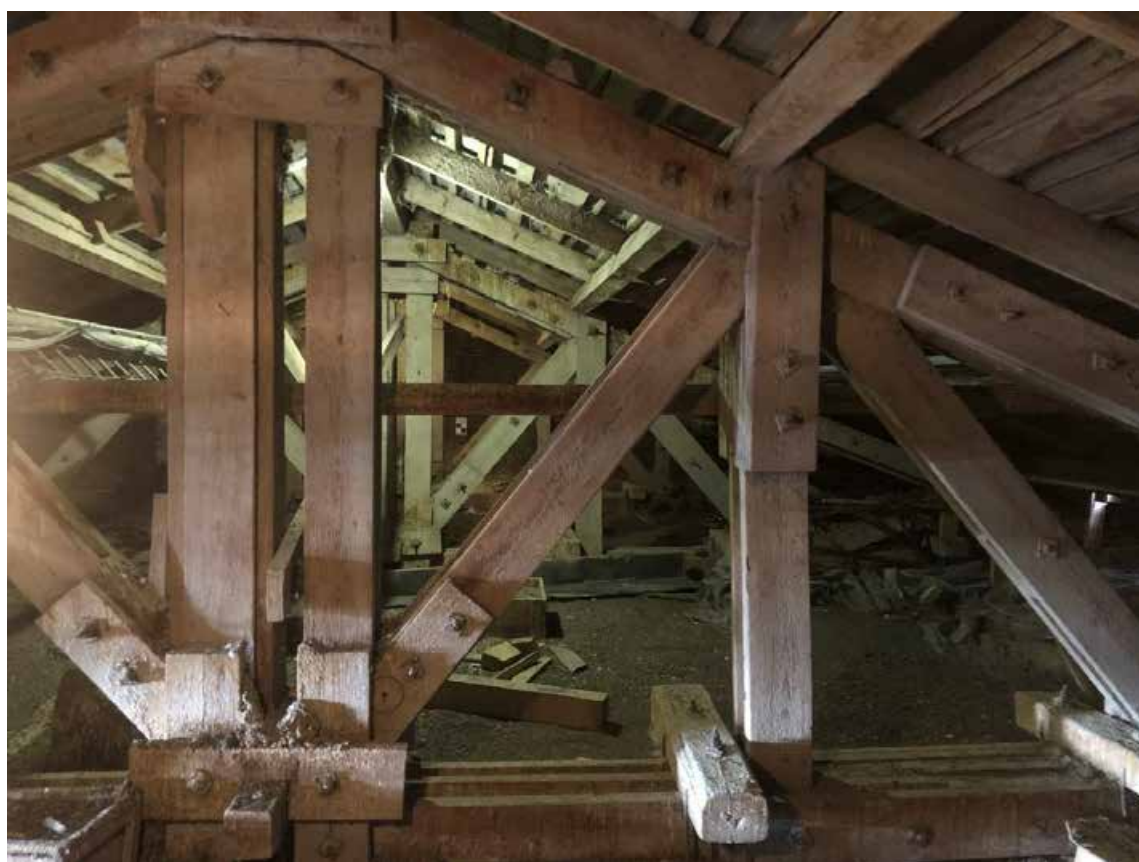
Фото 117. Вид чердачного помещения.
