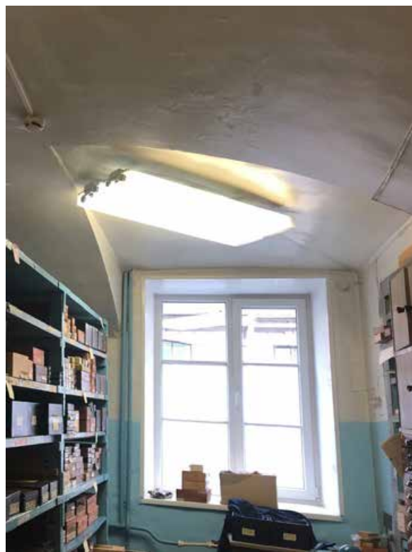
Фото 41. 1 этаж. Помещение № 7 (1-Н).
