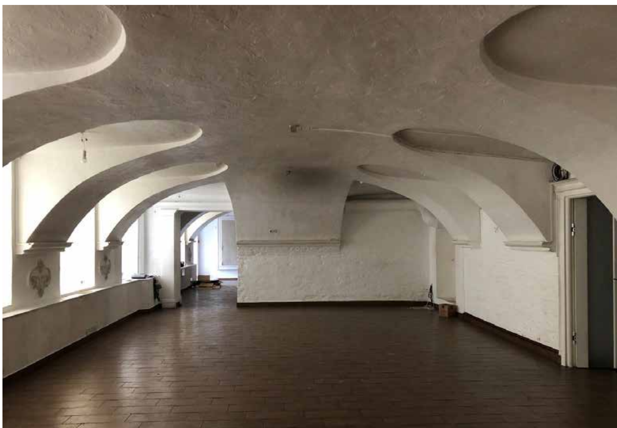
Фото 13. 1 этаж. Помещение № 2 (5-Н).
