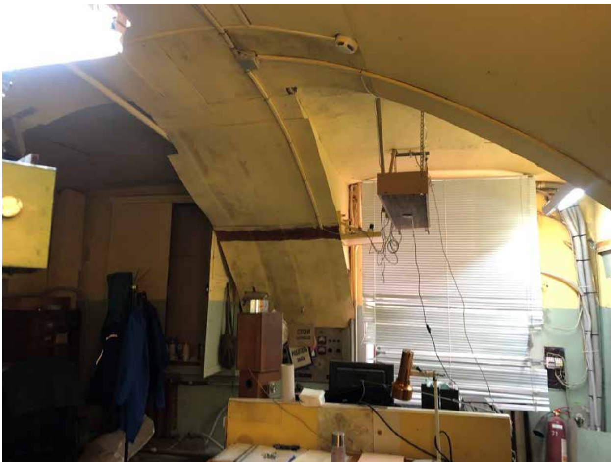
Фото 22. 1 этаж. Помещение № 2 (33-Н).
