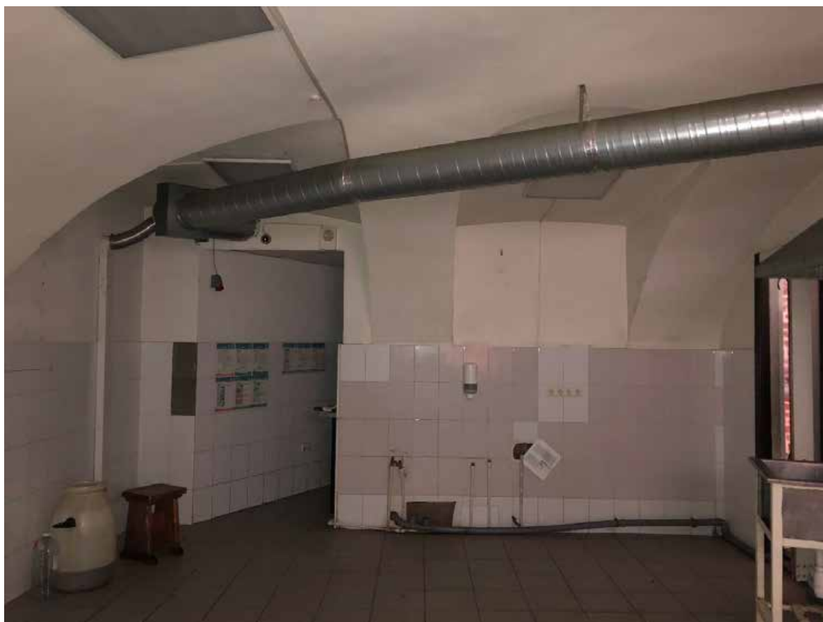
Фото 15. 1 этаж. Помещение № 2 (6-Н).
