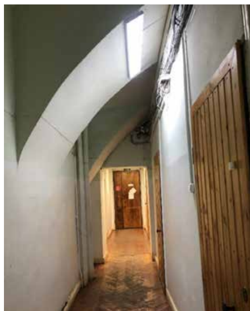
Фото 63. 2 этаж. Помещение № 21 (40-Н).
