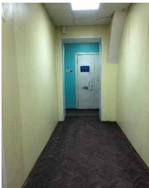
Фото 62. 2 этаж. Помещение № 1 (40-Н).
