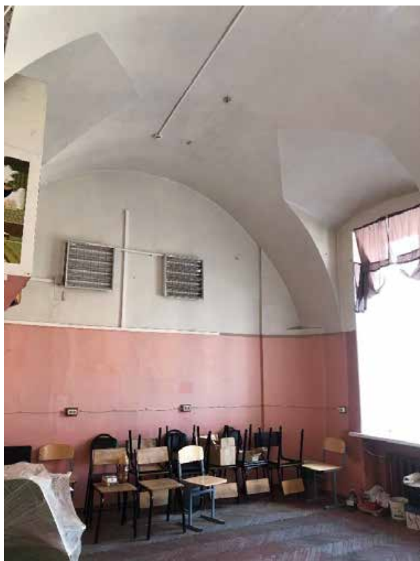
Фото 82. 3 этаж. Помещение № 3 (10-Н).
