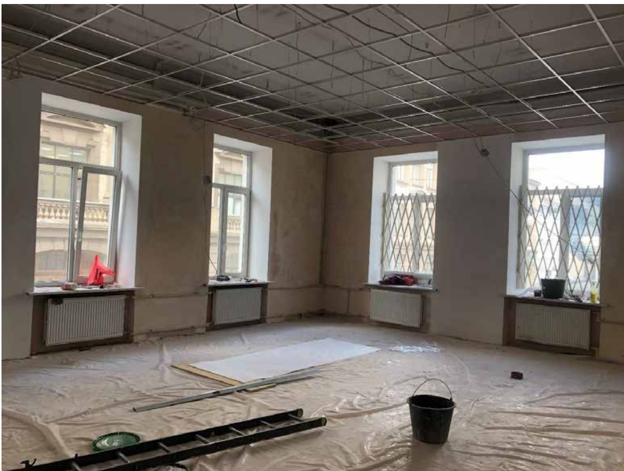
Фото 46. 2 этаж. Помещение № 36 (7-Н).
