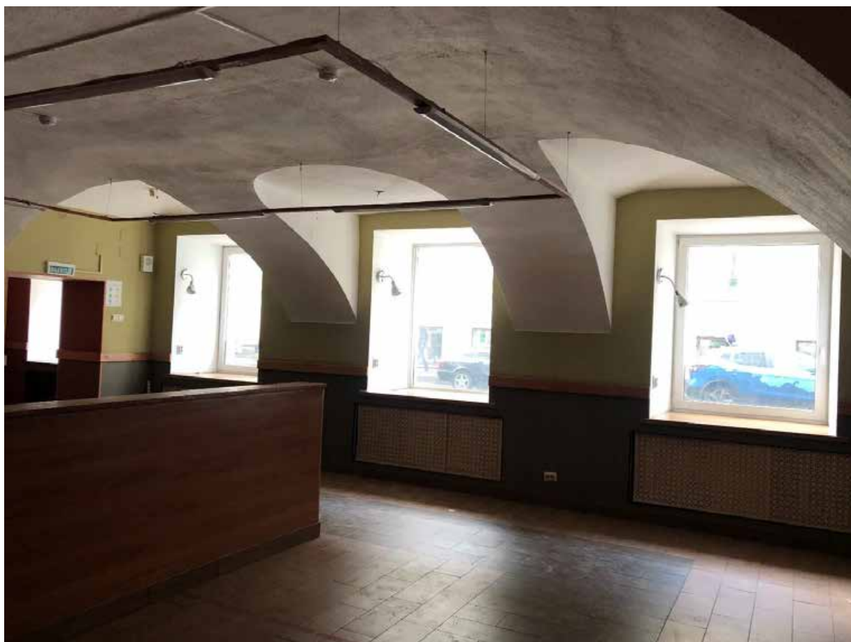
Фото 19. 1 этаж. Помещение № 20 (6-Н).
