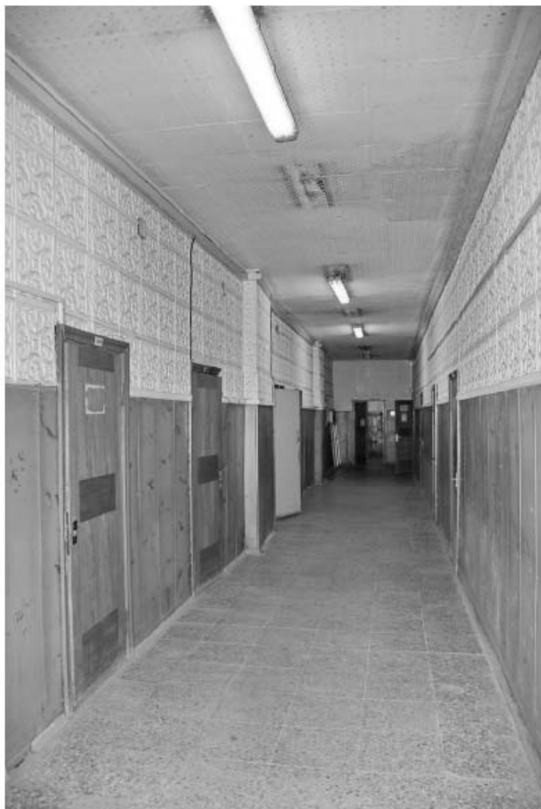
50 Выявленный ОКН «Производственное здание с дымовой трубой Киновиевского Ультрамаринового завода Г.И. Веге», по адресу: г. Санкт-Петербург, Октябрьская набережная, дом 38, литера АН, Лит. АН7, 1 этаж. Помещение 15 (согласно планам ПИБ) Дата съемки: 13.09.2023
