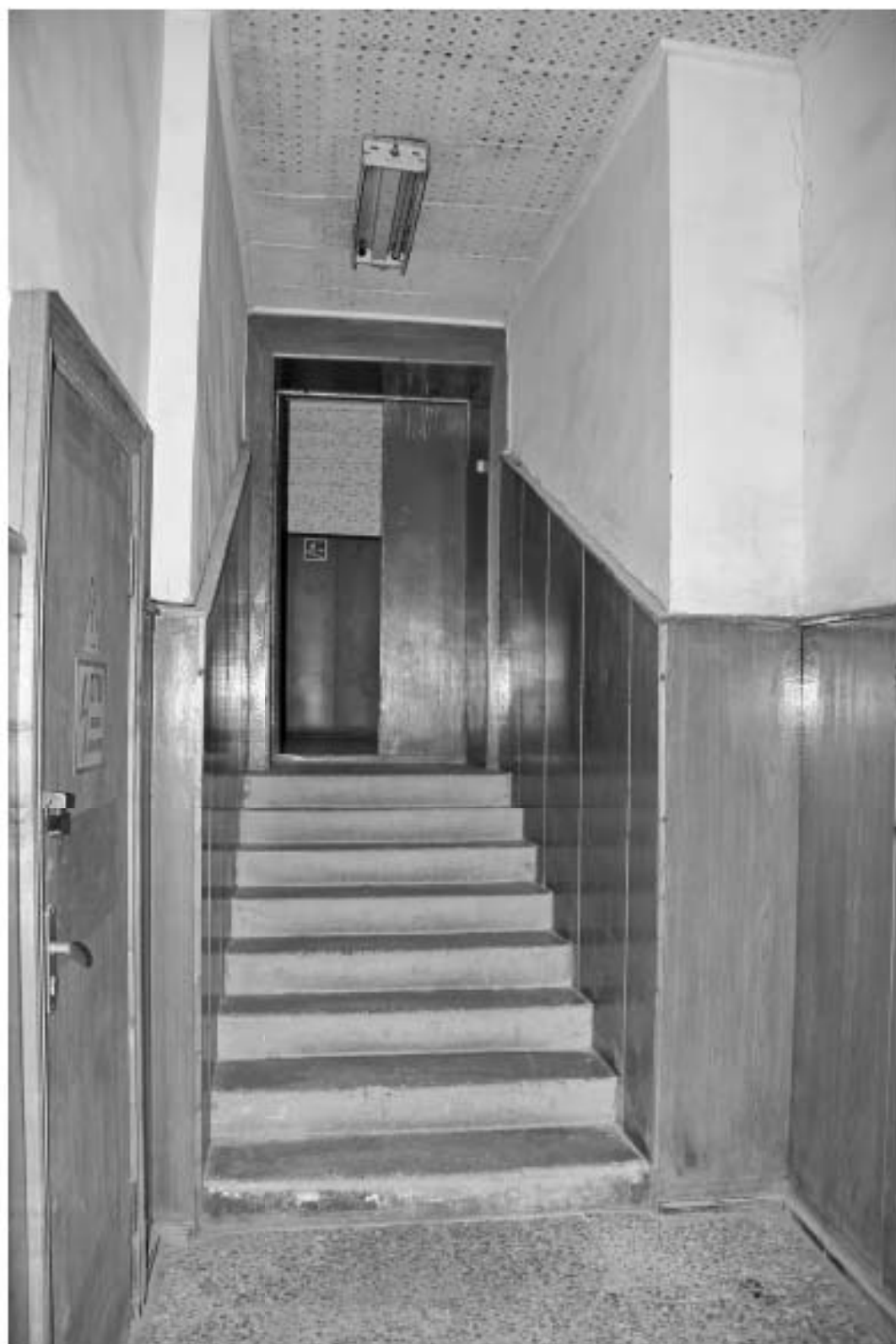
54 Выявленный ОКН «Производственное здание с дымовой трубой Киновиевского Ультрамаринового завода Г.И. Веге», по адресу: г. Санкт-Петербург, Октябрьская набережная, дом 38, литера АН, Лит. АН7, 1 этаж. Помещение 1 (согласно планам ПИБ) Дата съемки: 13.09.2023
