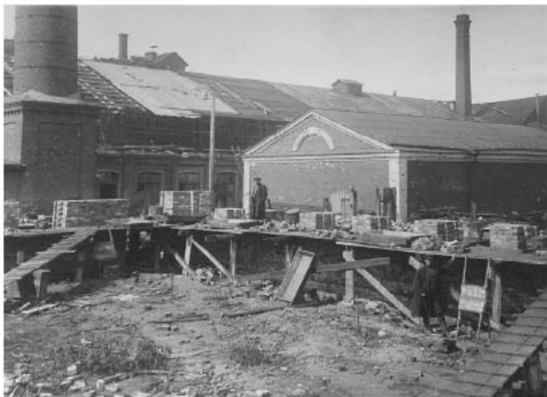
17. Вид здания для обжигательных печей. 1925 г. ЦГАКФФД СПб, Гр 40387.
