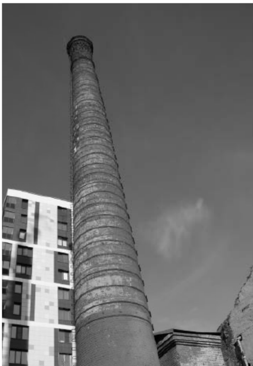
12. Выявленный ОКН «Производственное здание с дымовой трубой Киновиевского Ультрамаринового завода Г.И. Веге», по адресу: г. Санкт-Петербург, Октябрьская набережная, дом 38, литера АН. Ствол дымовой трубы литеры АН-10. Вид с юго-востока.
