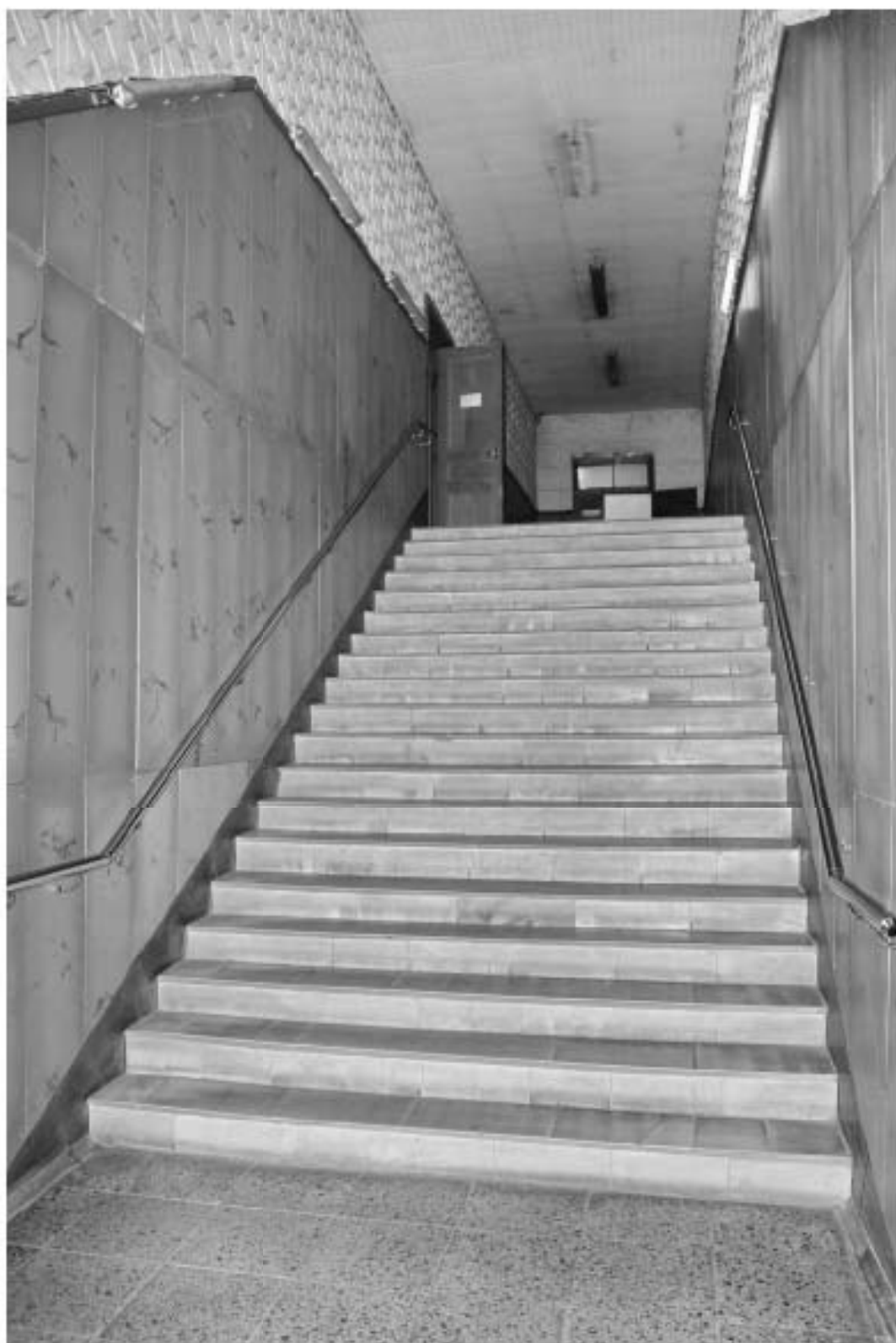
53 Выявленный ОКН «Производственное здание с дымовой трубой Киновиевского Ультрамаринового завода Г.И. Веге», по адресу: г. Санкт-Петербург, Октябрьская набережная, дом 38, литера АН, Лит. АН7, 1 этаж. Лестница на 2 этаж Дата съемки: 13.09.2023
