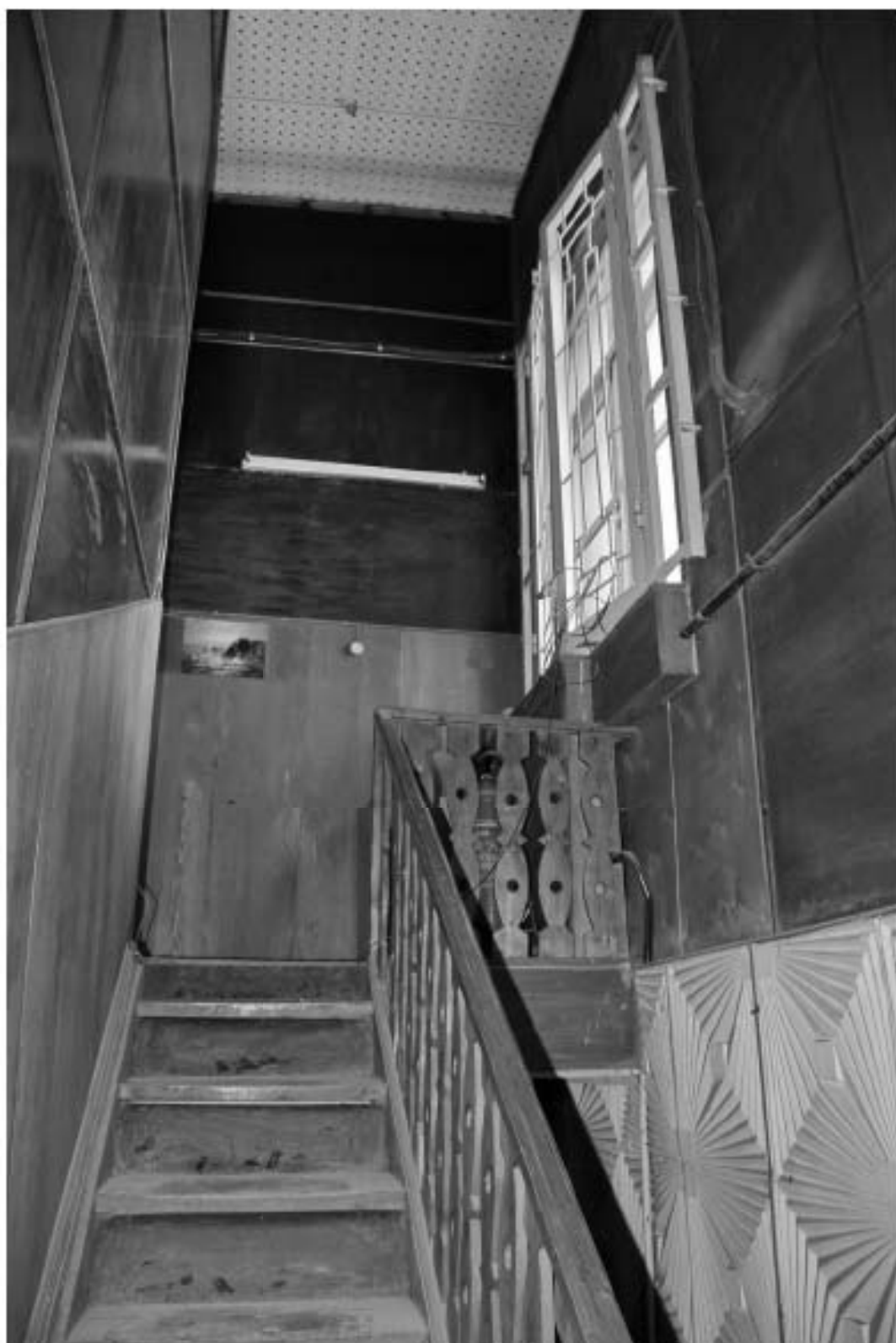
60 Выявленный ОКН «Производственное здание с дымовой трубой Киновиевского Ультрамаринового завода Г.И. Веге», по адресу: г. Санкт-Петербург, Октябрьская набережная, дом 38, литера АН, Лит. АН5, 3 этаж, Помещение 7 (согласно планам ПИБ) Дата съемки: 13.09.2023
