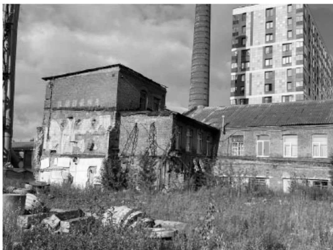
7. Выявленный ОКН «Производственное здание с дымовой трубой Кизоминского Ультрамаринового завода Г.И. Вега», по адресу: г. Санкт-Петербург, Октябрьская набережная, дом 38, литера АН. Общий вид Лиг. АН-5 с северо-востока. Дата съемки: 13.09.2023.
