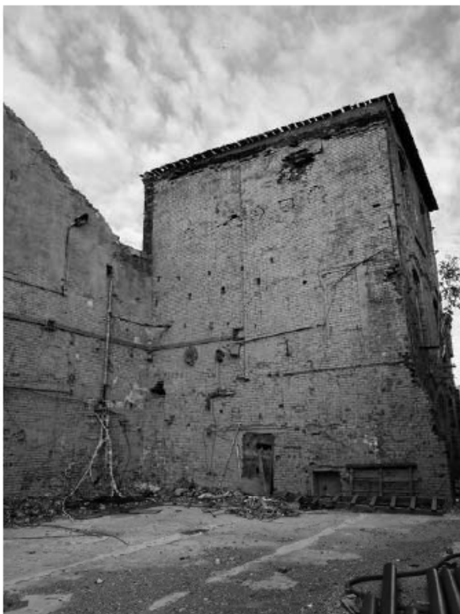
15. Выявленный ОКН «Производственное здание с дымовой трубой Киновиевского Ультрамаринного завода Г.И. Веge», по адресу: г. Санкт-Петербург, Октябрьская набережная, дом 38, литера АН. Литеры АН-5. Вид с юга-запада. Дата съемки: 13.09.2023.
