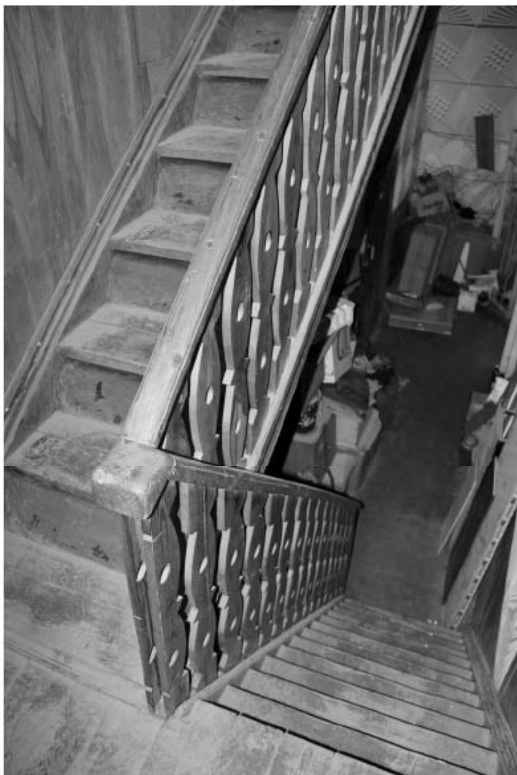
58 Выявленный ОКН «Производственное здание с дымовой трубой Киновиевского Ультрамаринового завода Г.И. Веге», по адресу: г. Санкт-Петербург, Октябрьская набережная, дом 38, литера АН, Лит. АН5, 2 этаж, Помещение 4 (согласно планам ПИБ) Дата съемки: 13.09.2023
