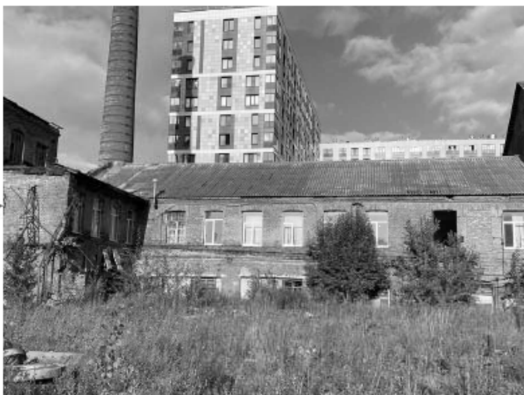
9. Выявленный ОКН «Производственное здание с дымовой трубой Кизовского Ультрамаринового завода Г.И. Веге», по адресу: г. Санкт-Петербург, Октябрьская набережная, дом 38, литера АН. Фрагмент фасада Лит. АН-6. Вид с востока. Дата съемки: 13.09.2023.
