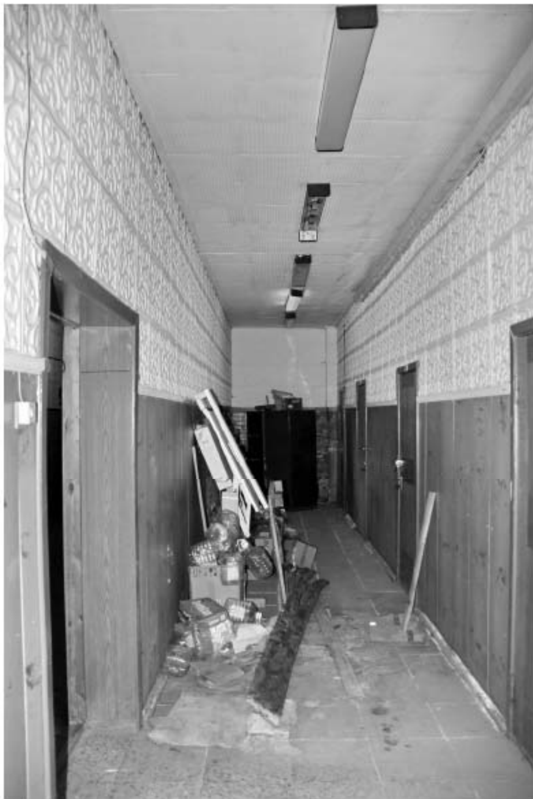
28 Выявленный ОКН «Производственное здание с дымовой трубой Киновиевского Ультрамаринового завода Г.И. Веге», по адресу: г. Санкт-Петербург, Октябрьская набережная, дом 38, литера АН, Лит. АН6, 1 этаж. Помещение 17 (согласно планам ПИБ) Дата съемки: 13.09.2023
