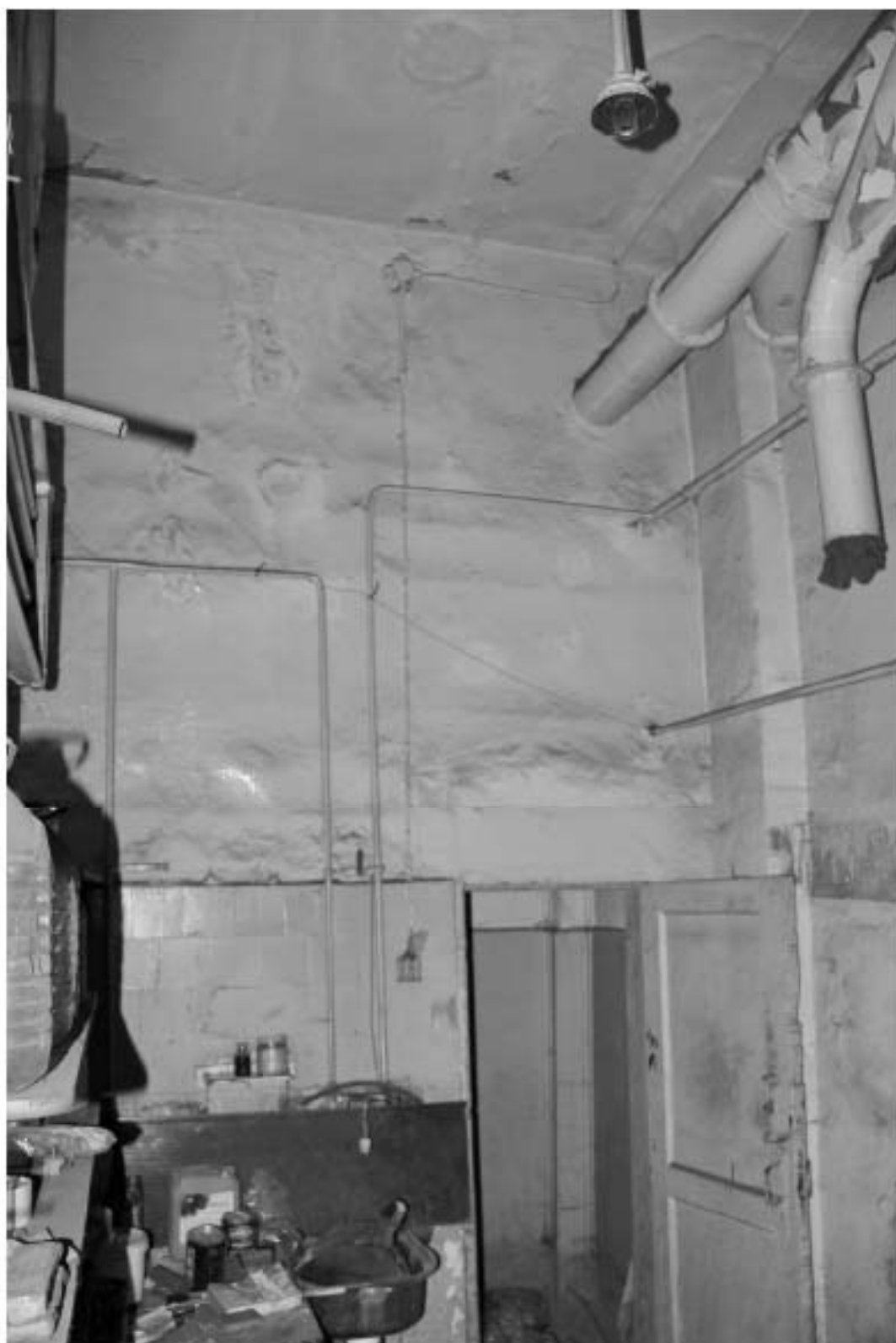
19 Выявленный ОКН «Производственное здание с дымовой трубой Киновиевского Ультрамаринового завода Г.И. Вега», по адресу: г. Санкт-Петербург, Октябрьская набережная, дом 38, литера АН, Лит. АН6, 1 этаж. Помещение 2 (согласно планам ПИБ) Дата съемки: 13.09.2023
