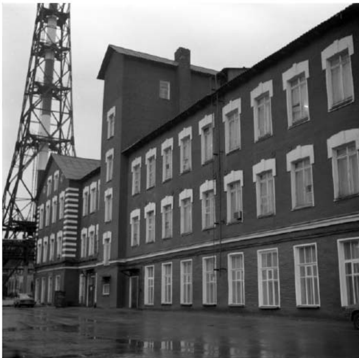
41. Историческое здание Ультрамаринового завода. 26.11.1996 г. Личный архив Е. Иванова.
