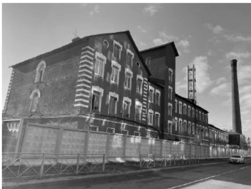
5. Выключенный ОКН «Производственное здание с дымовой трубой Кинновского Ультрамаринового завода Г.И. Вега», по адресу: г. Санкт-Петербург, Октябрьская набережная, дом 38, литера АН. Лицевой фасад здания (Лит. АН-6; АН-8; АН-10). Общий вид с северо-запада. Дата съемки: 13.09.2023.
