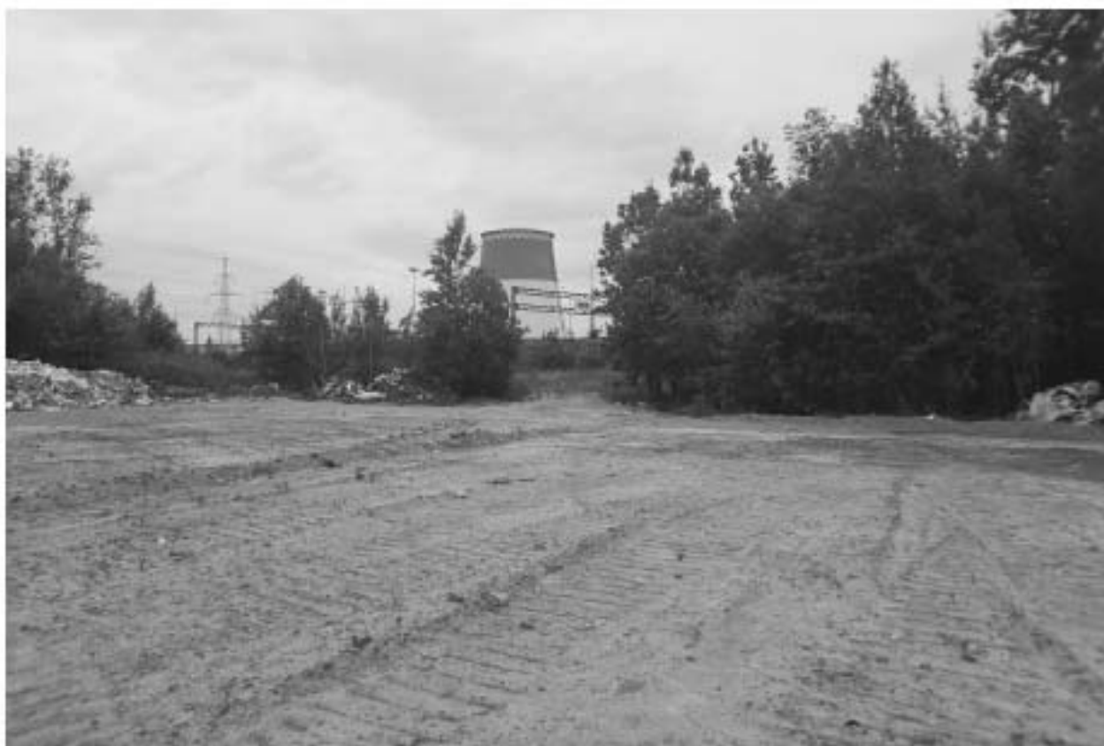
Илл. 43. Участок проектирования. Работы по ликвидации несанкционированной свалки. Фото 18.07.2023 г.
