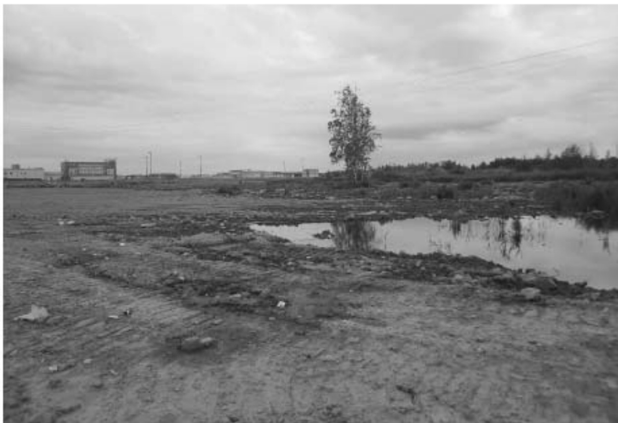
Илл. 46. Участок проектирования. Работы по ликвидации несанкционированной свалки. Фото 18.07.2023 г.
