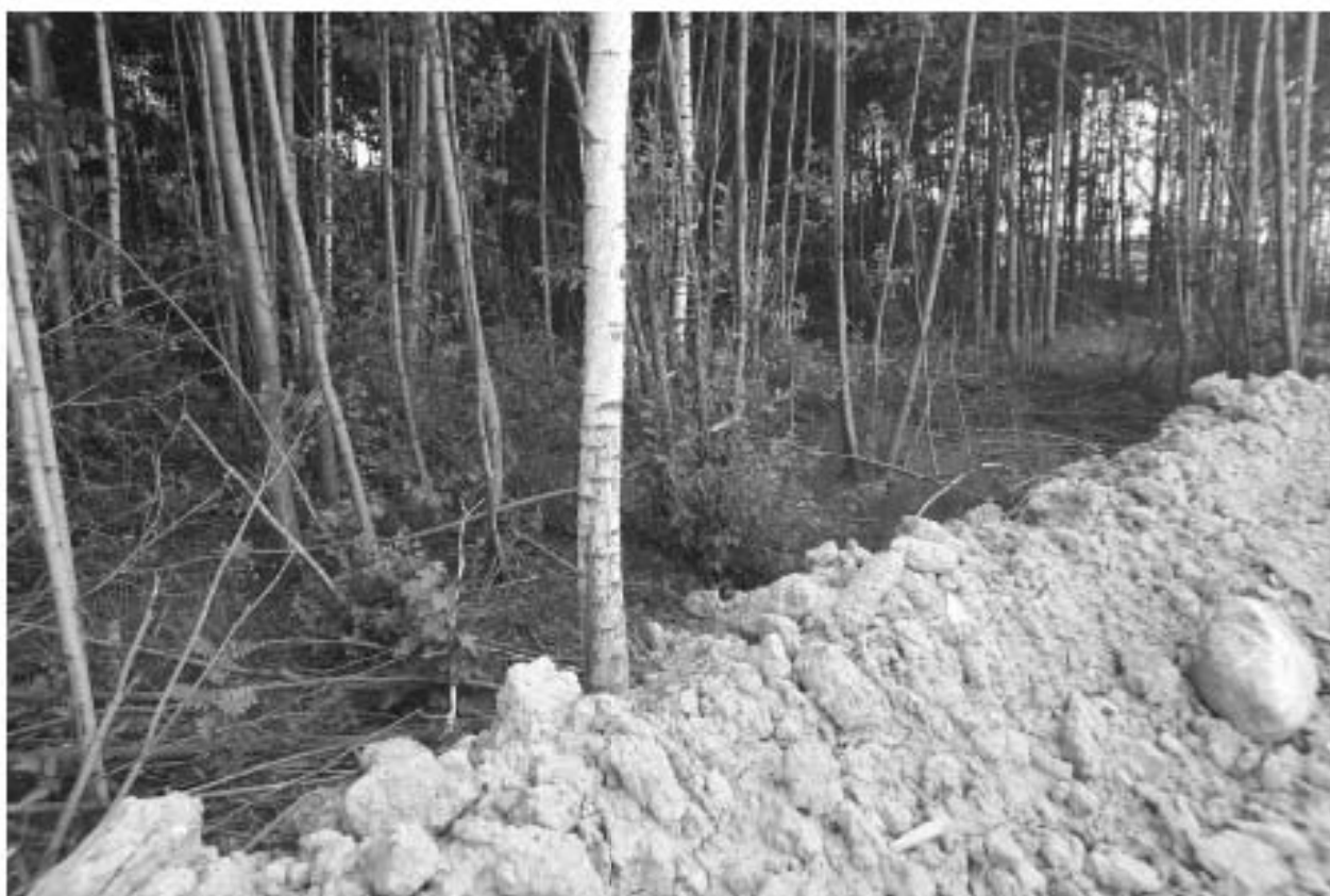
Илл. 44. Участок проектирования. Работы по ликвидации несанкционированной свалки. Фото 18.07.2023 г.
