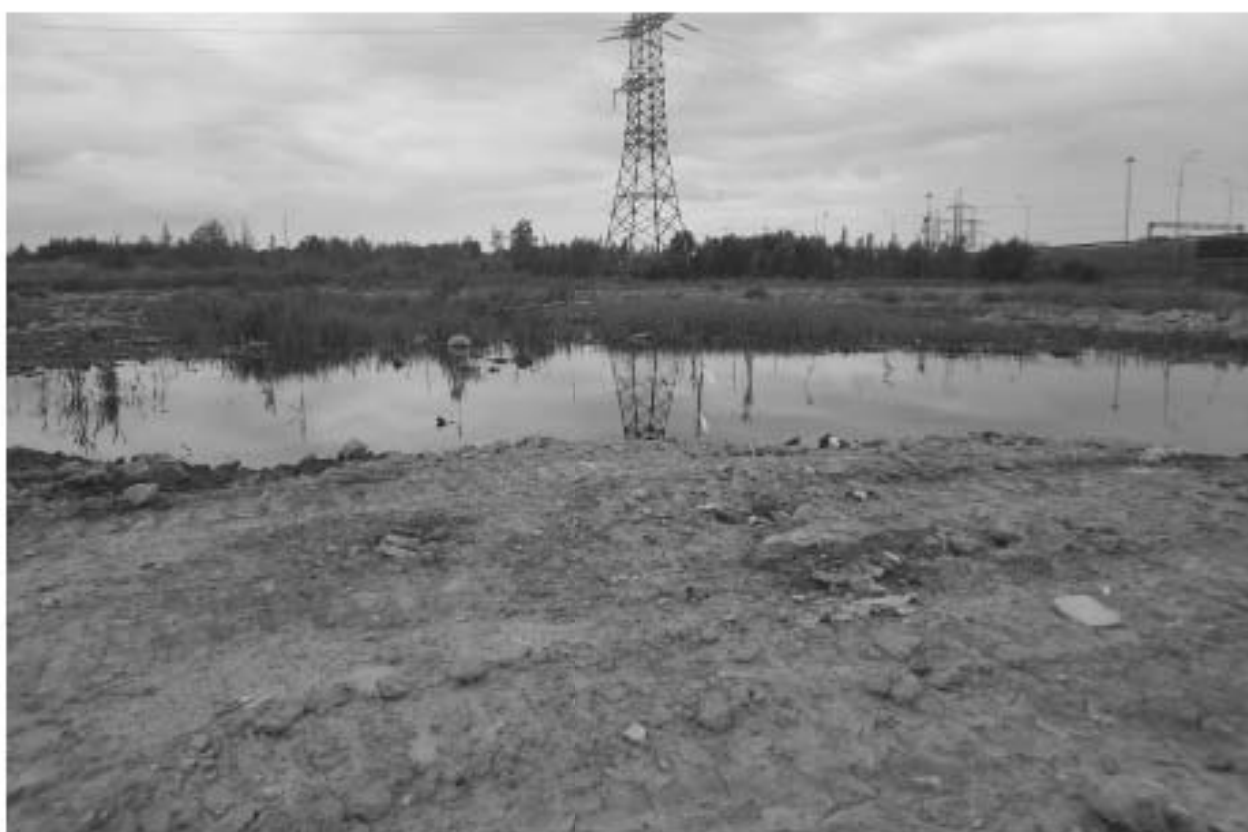
Илл. 47. Участок проектирования. Работы по ликвидации несанкционированной свалки. Фото 18.07.2023 г.
