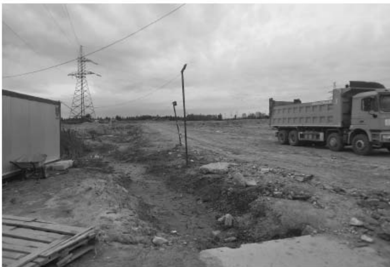
Илл. 42. Участок проектирования. Работы по ликвидации несанкционированной свалки. Фото 18.07.2023 г.
