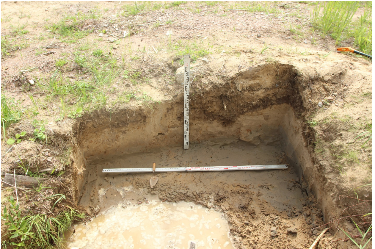
Рис. 27. СПб-2023. Загребский б. КН: 78:13:0744702:1607. Шурф 1. Фиксация по уровню окончания работ, вид на юг, южная стенка.
