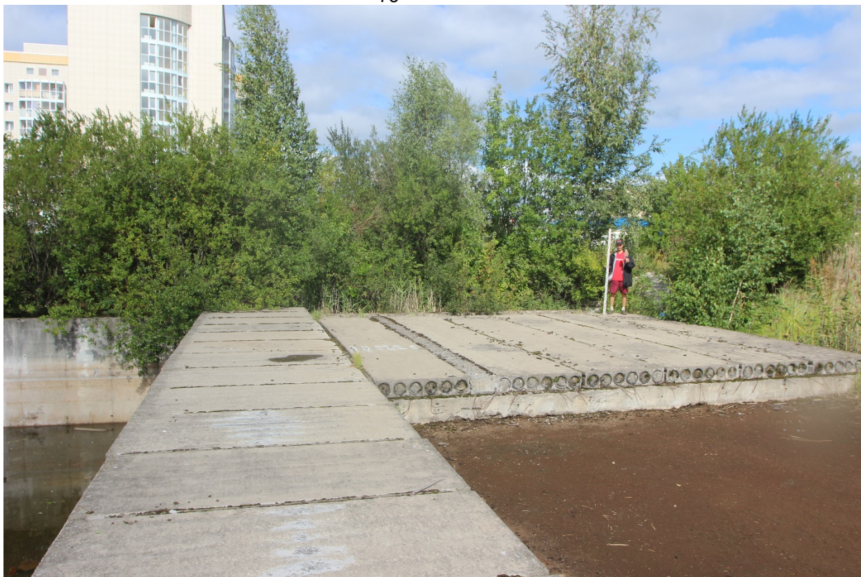
Рис. 11. СПб-2023. Загребский б. КН: 78:13:0744702:1607. Точка фотофиксации 1, вид на северо-запад.
