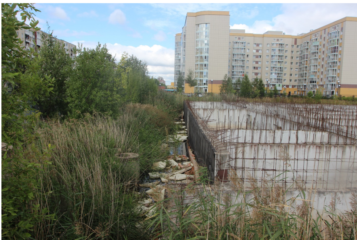
Рис. 20. СПб-2023. Загребский б. КН: 78:13:0744702:1607. Точка фотофиксации 3, вид на северо-запад.
