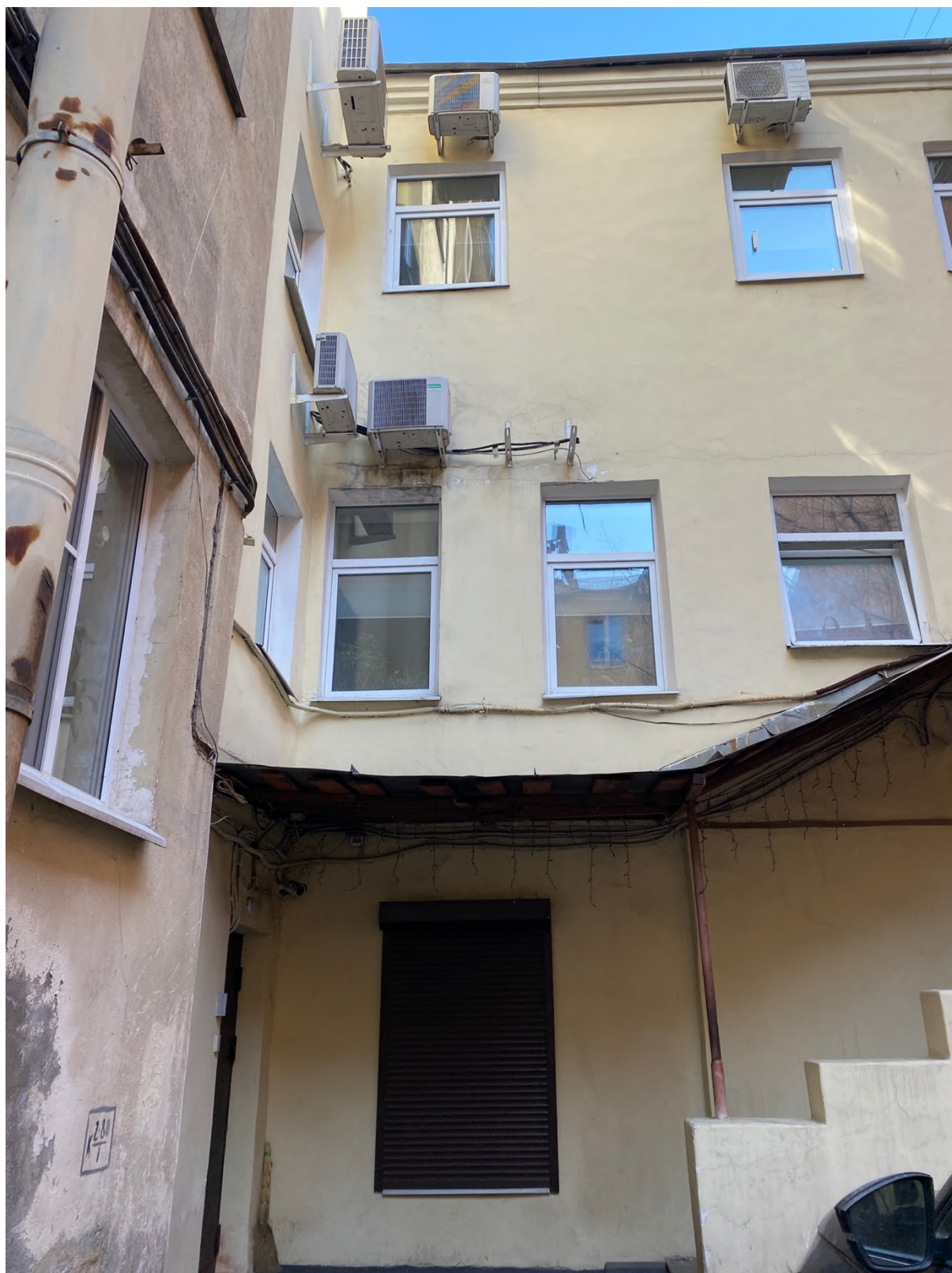
12. Фрагмент дворового фасада объекта культурного наследия
