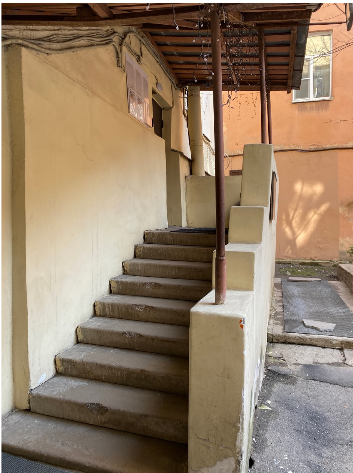
14. Фрагмент дворового фасада объекта культурного наследия
