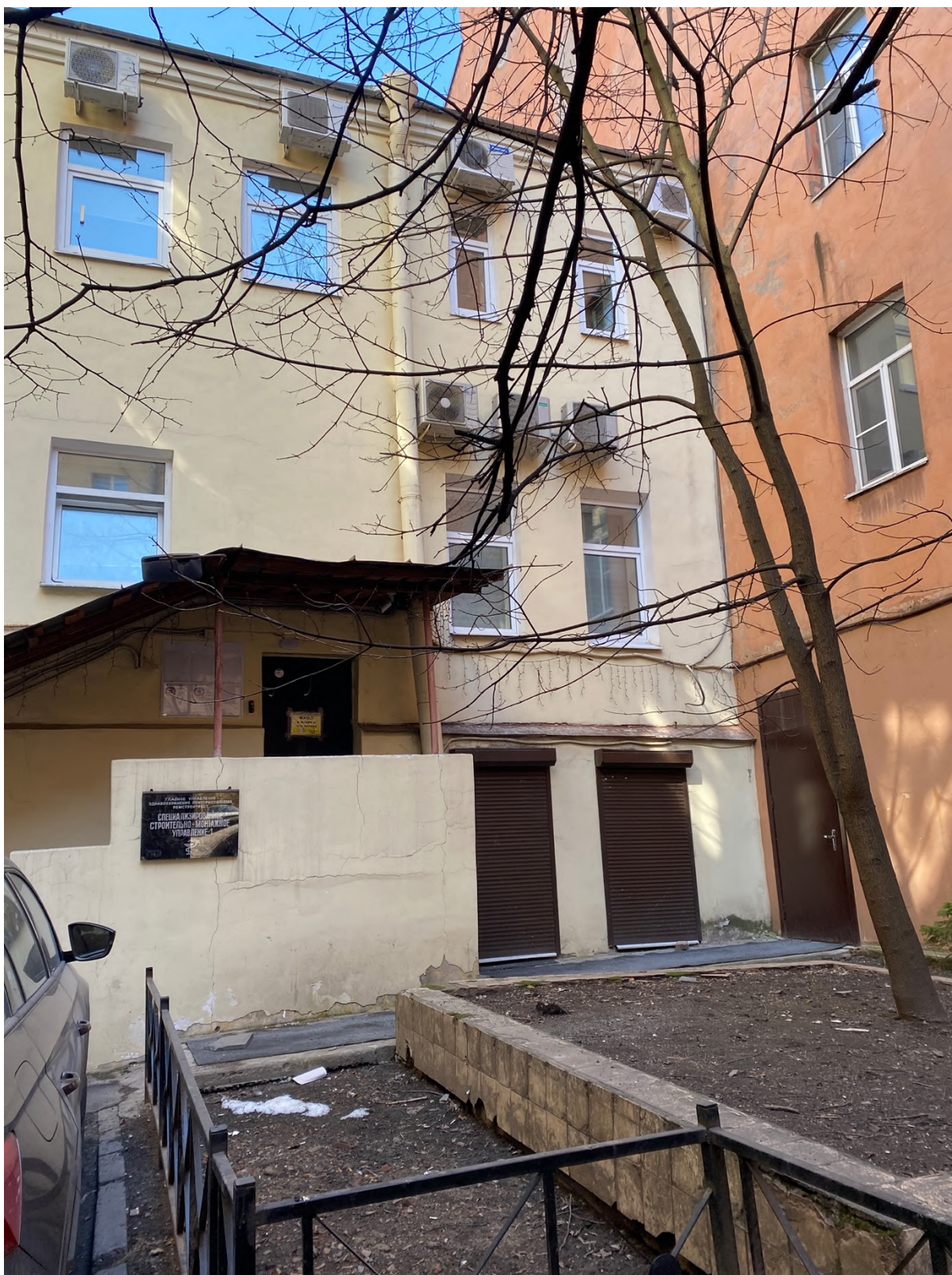
11. Фрагмент дворового фасада объекта культурного наследия
