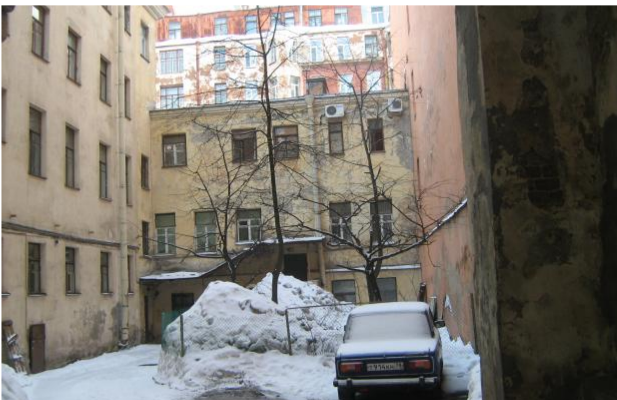
55. Дворовый фасад, 2009 г. [Электронный ресурс] URL: https://p0.citywalls.ru/photo_68-70452.jpg?mt=1293221696
