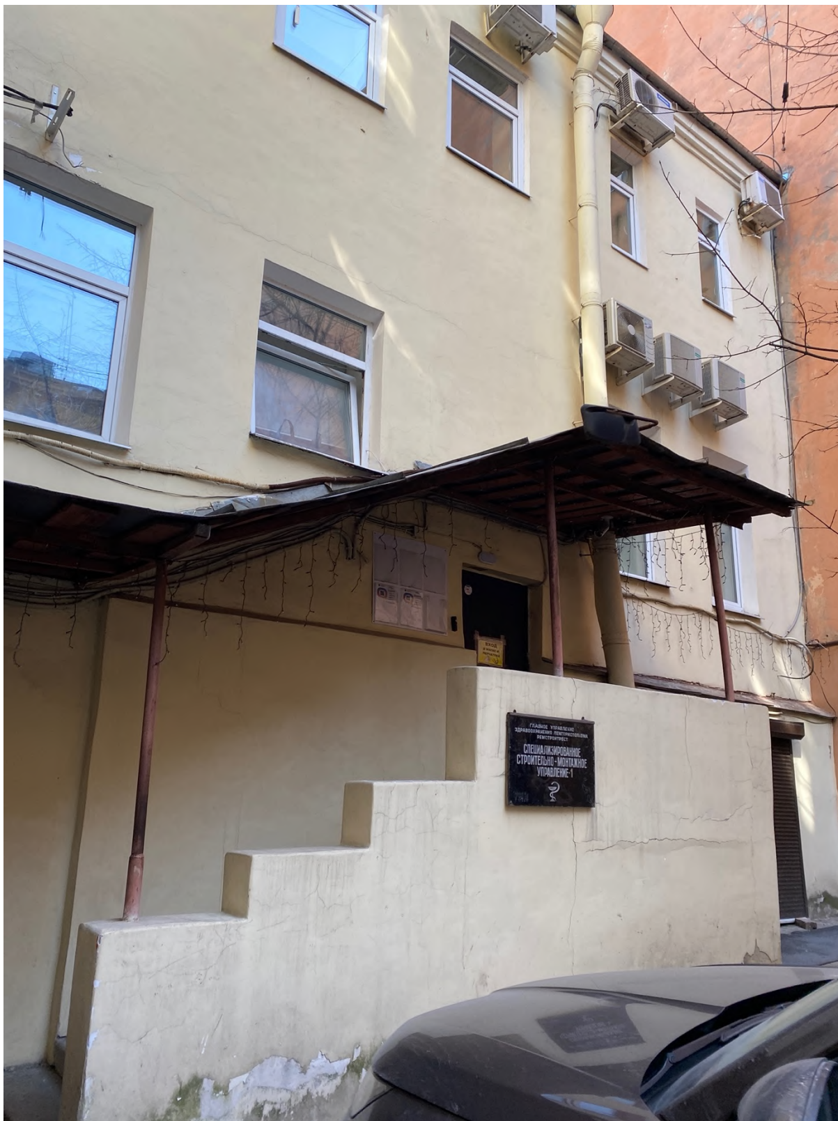
13. Фрагмент дворового фасада объекта культурного наследия
