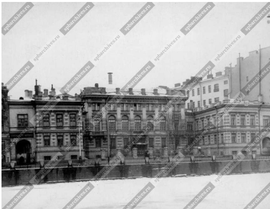
Илл. 32. Внешний вид Петровского училища Петербургского купеческого общества (наб. Фонтанки, д.62). Дата: нач. 1900-х гг. Источник: ЦГАКФФД СПб Е 16518.
