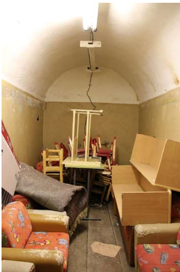
Фото 5. Вид на помещение 3-Н (10).
