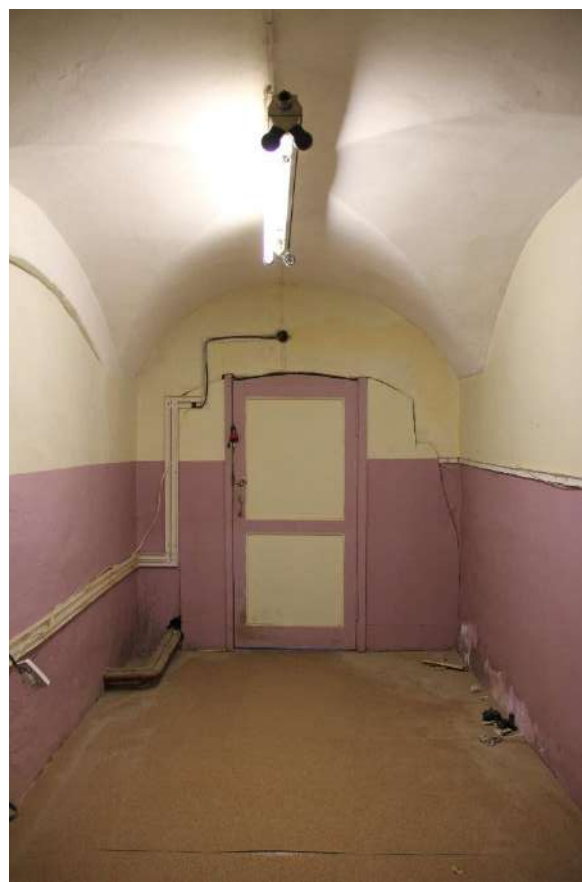
Фото 6. Вид на помещение 3-Н (11).
