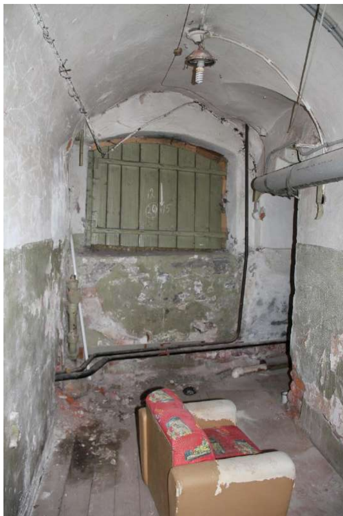
Фото 1. Вид на помещение 3-Н (1).
