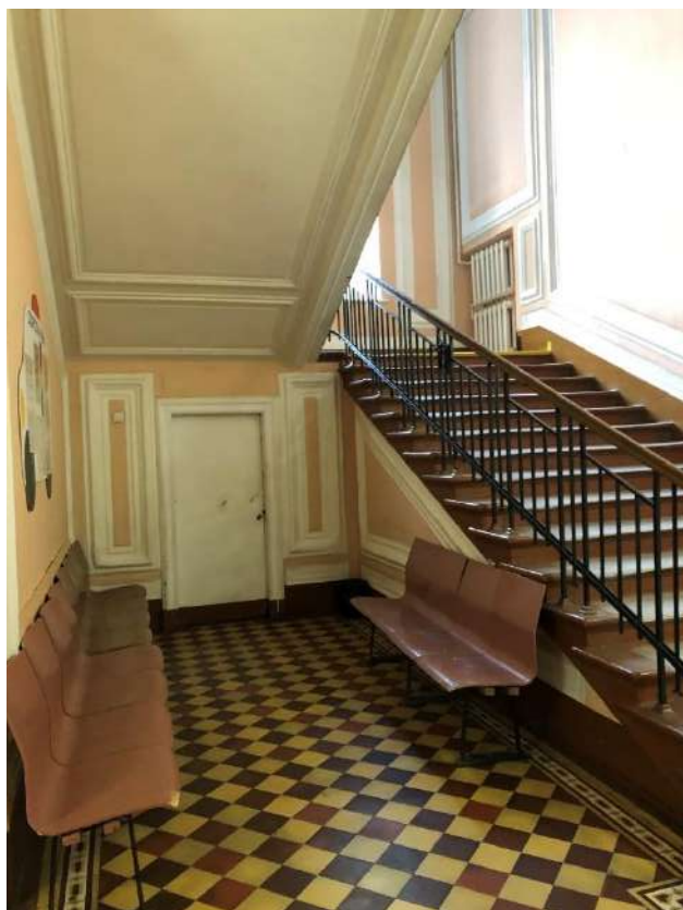
Фото 43. Вид на лестницу в юго-западной части корпуса 1906 г.
