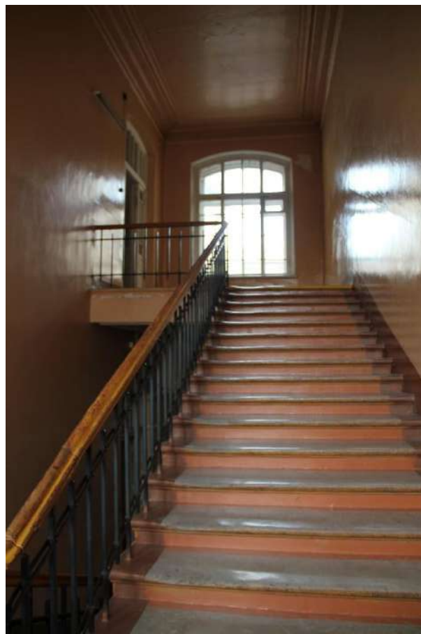
Фото 52. Вид на лестницу в юго-западной части корпуса 1906 г.
