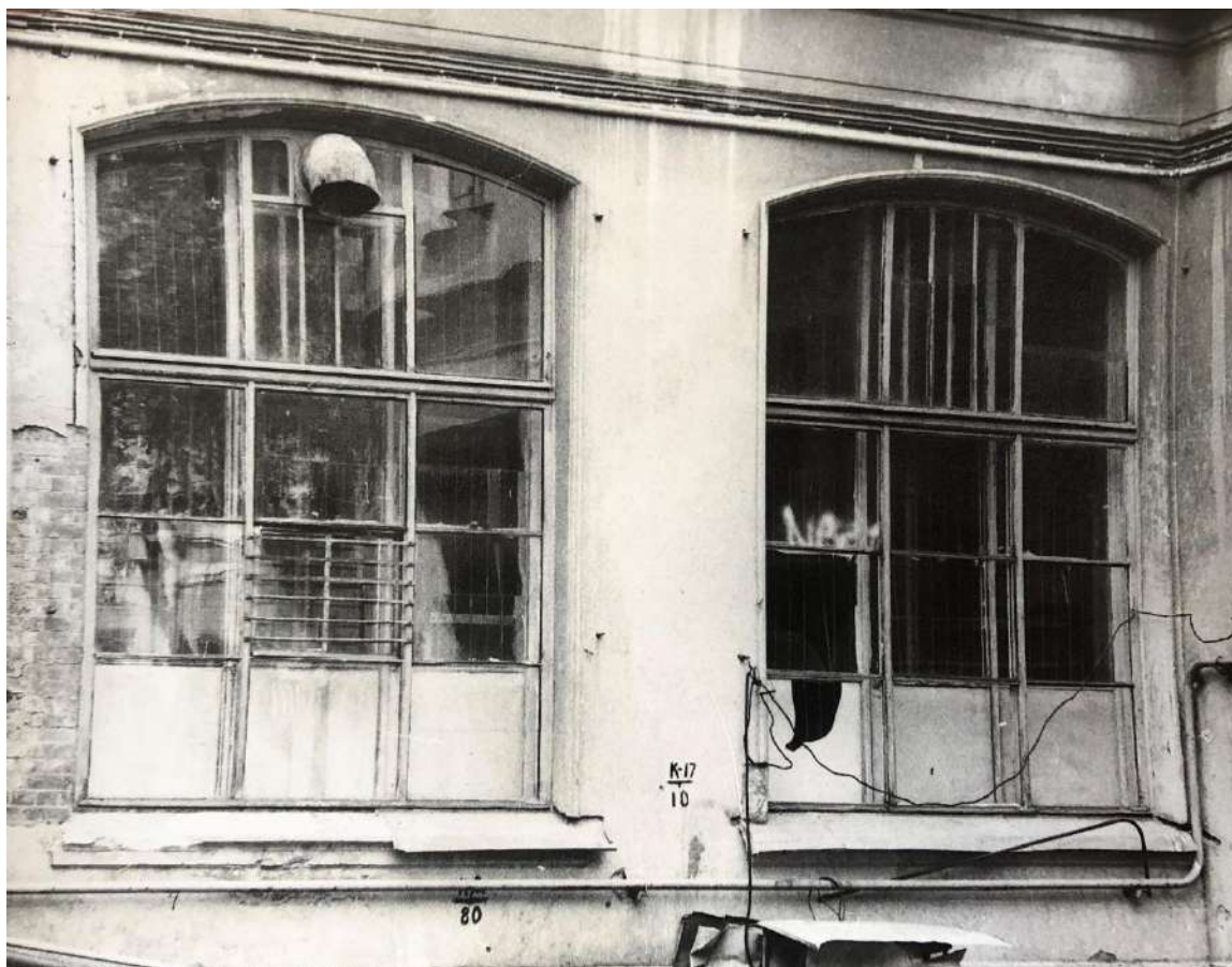
Илл. 76. Оконные заполнения спортивного зала (дворовый фасад). Дата: 1989 г. Источник: Архив КГИОП.
