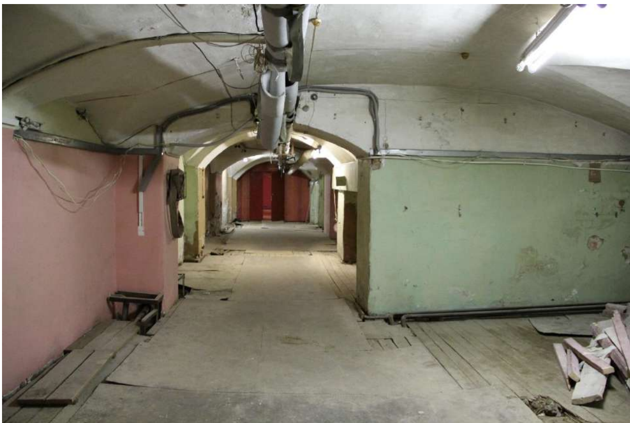
Фото 9. Вид на помещение 3-Н (21).
