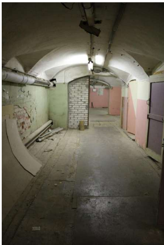
Фото 3. Вид на помещение 3-Н (7).
