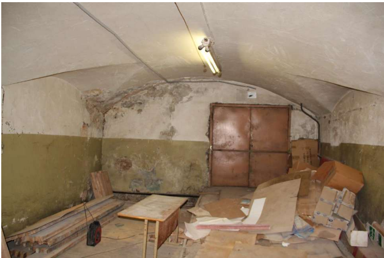
Фото 16. Вид на помещение 3-Н (24).
