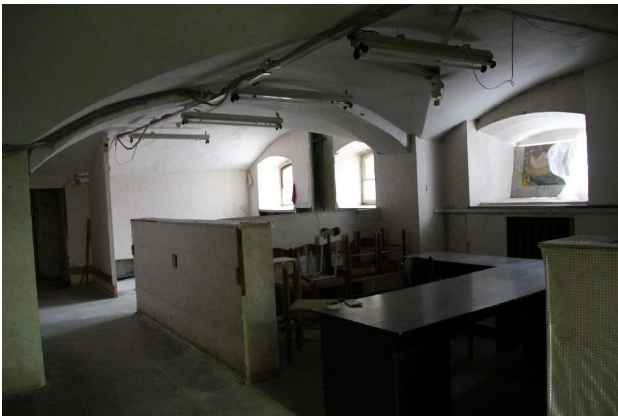
Фото 13. Вид на помещение 3-Н (19).
