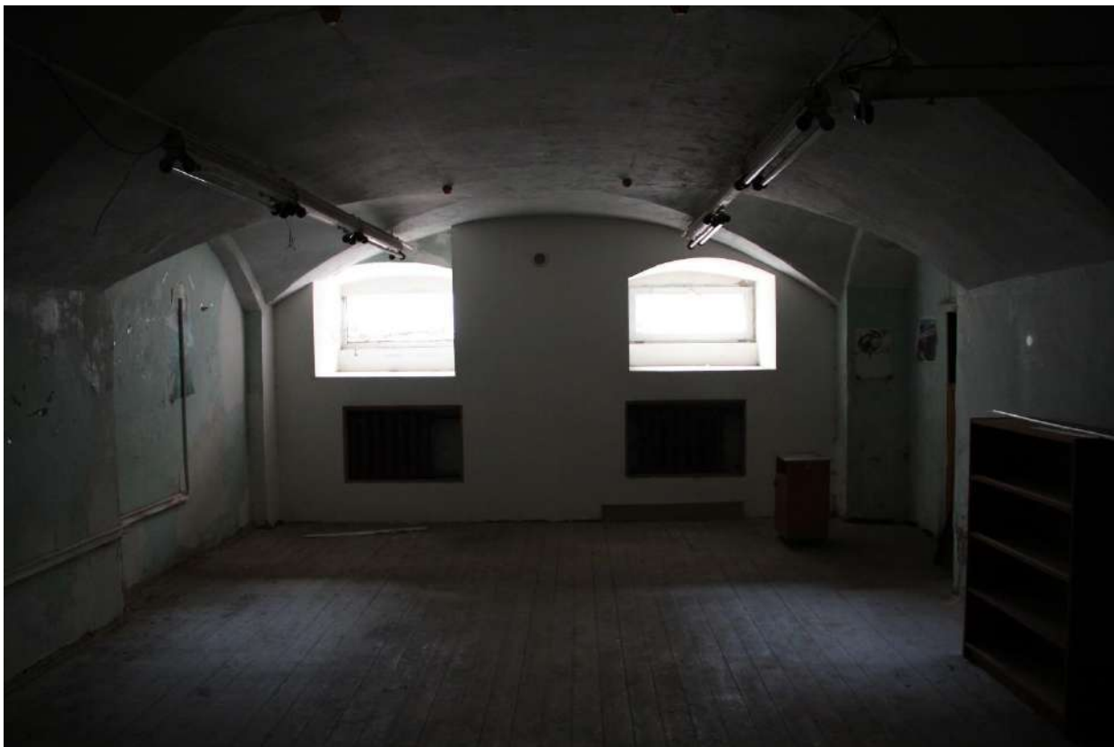
Фото 15. Вид на помещение 3-Н (28).
