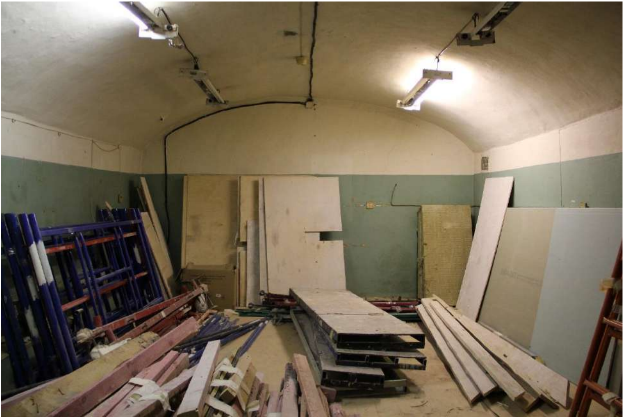
Фото 8. Вид на помещение 3-Н (17).
