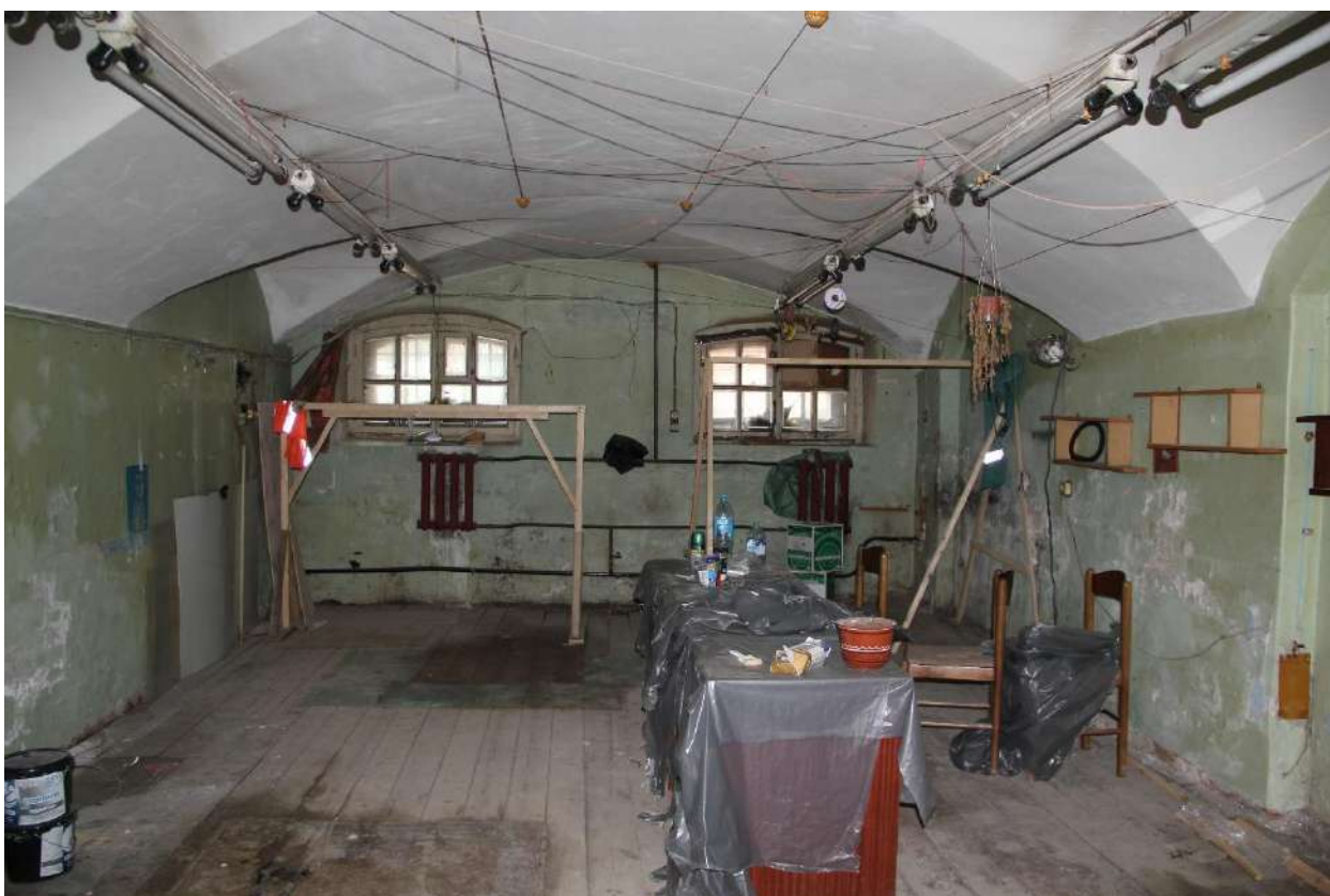
Фото 14. Вид на помещение 3-Н (29).
