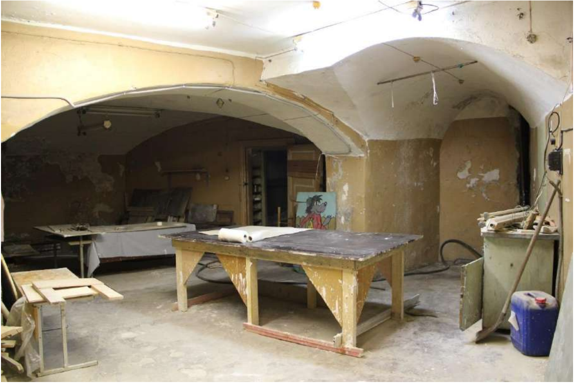
Фото 11. Вид на помещение 3-Н (15).
