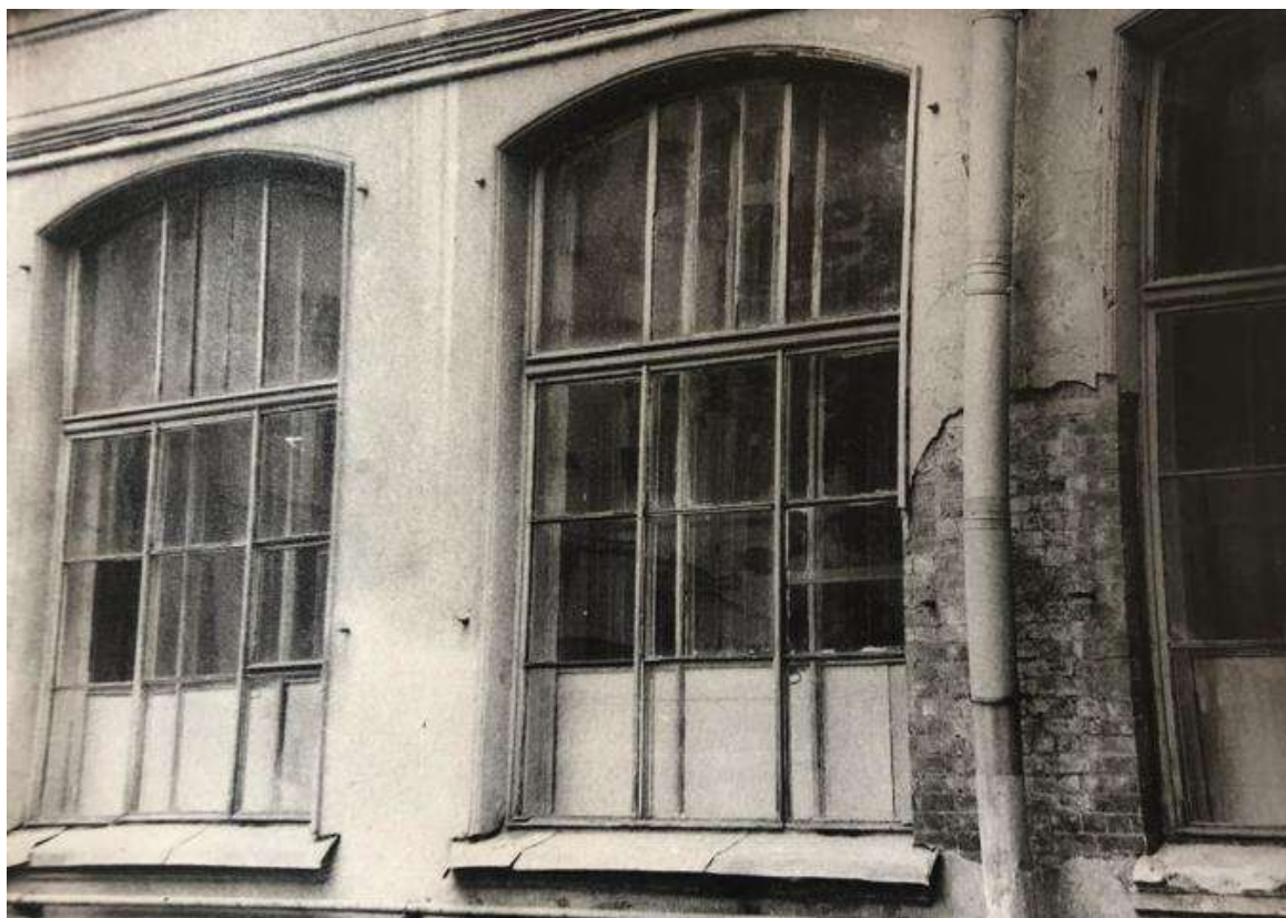
Илл. 77. Оконные заполнения спортивного зала (дворовый фасад). Дата: 1989 г. Источник: Архив КГИОП.
