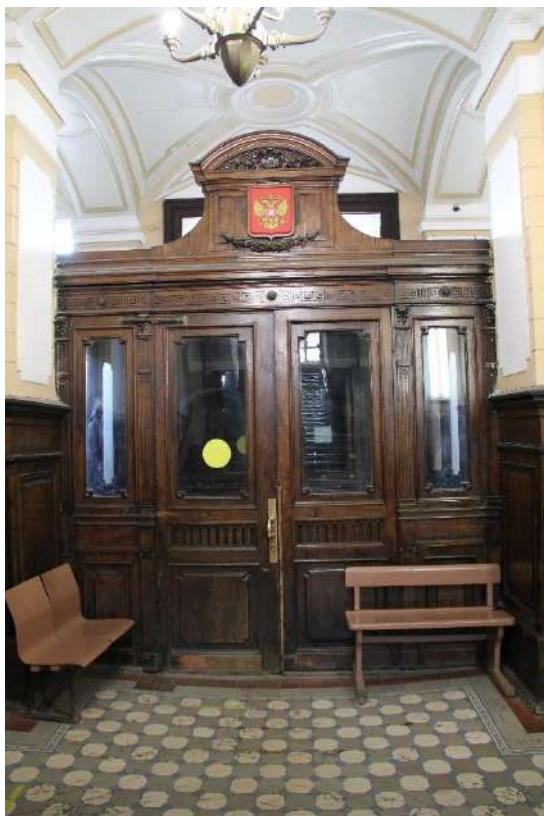
Фото 24. Тамбур в помещении 1-Н (3).
