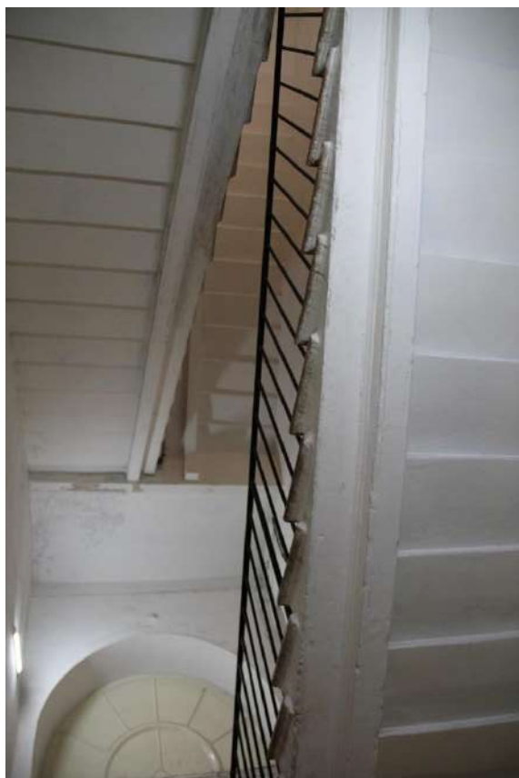
Фото 49. Лестница в юго-восточной части корпуса 1883 г.
