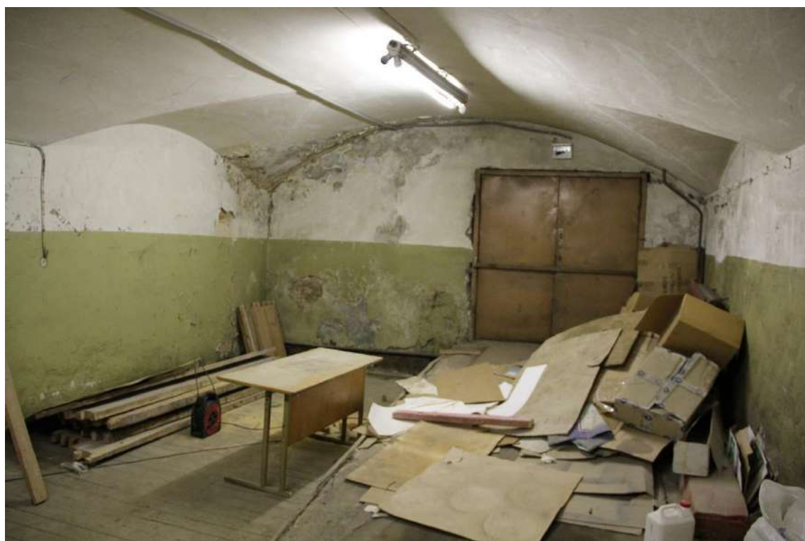
Фото 2. Вид на помещение 3-Н (6).
