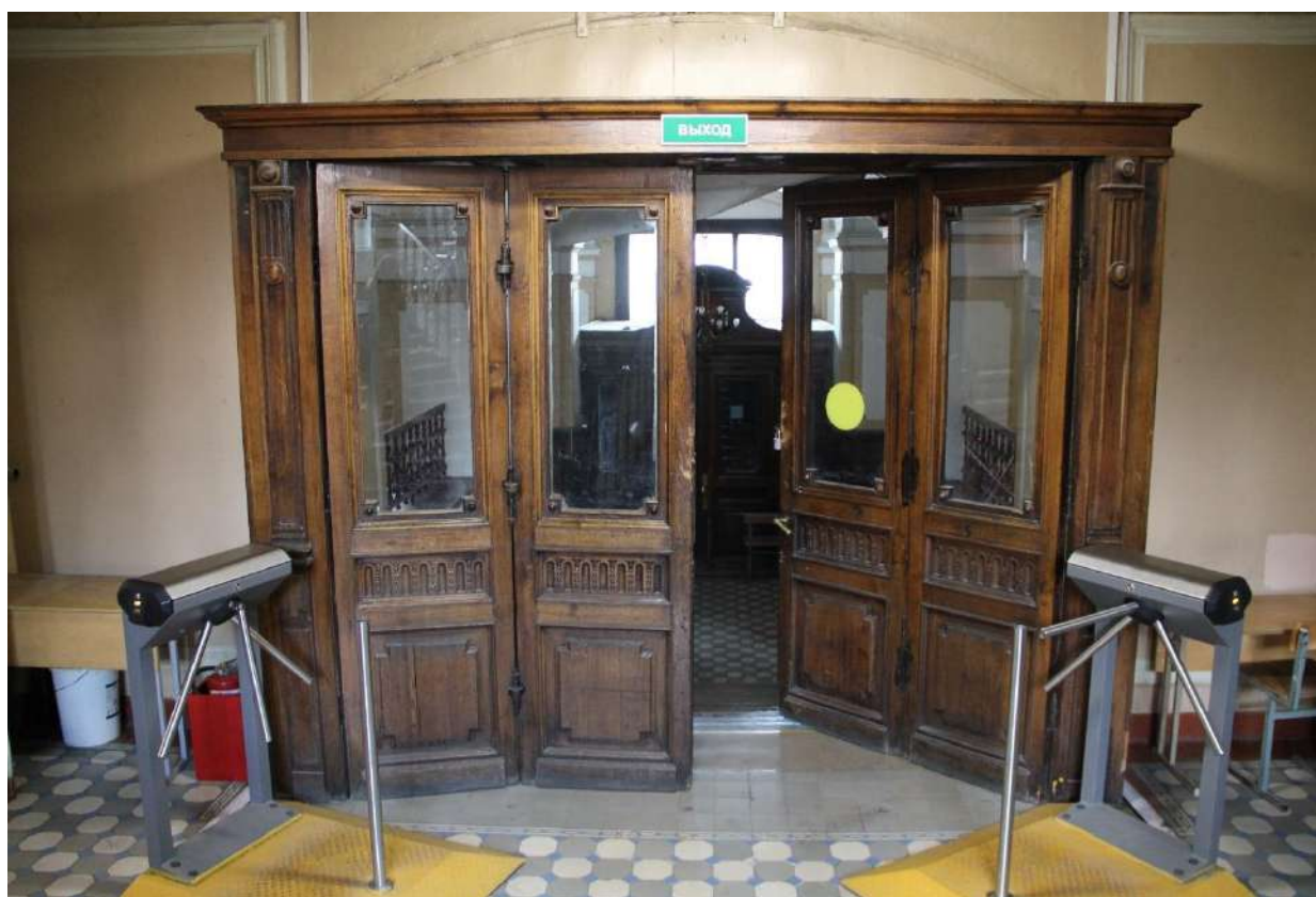
Фото 26. Двери между помещениями 1-Н (3, 4).
