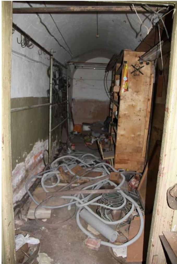
Фото 12. Вид на помещение 3-Н (18).
