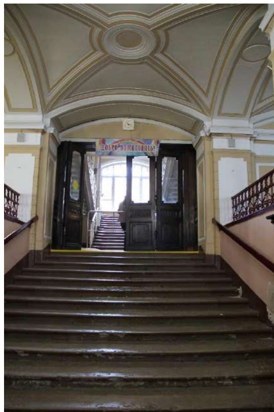
Фото 25. Лестница в пом. 1-Н (3).
