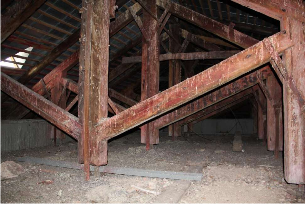
Фото 70. Вид на чердачное пространство.
