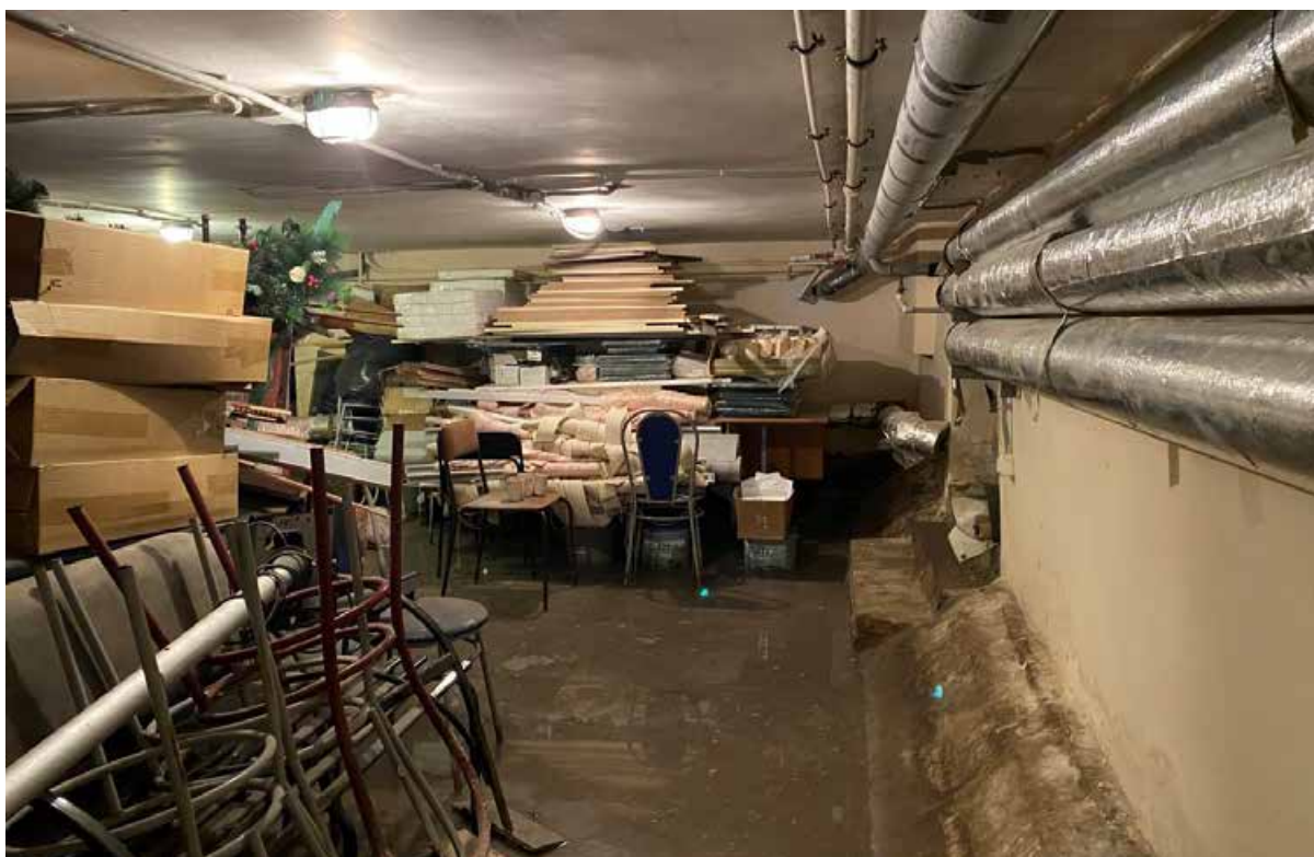
26. Помещение подвального этажа объекта культурного наследия.
