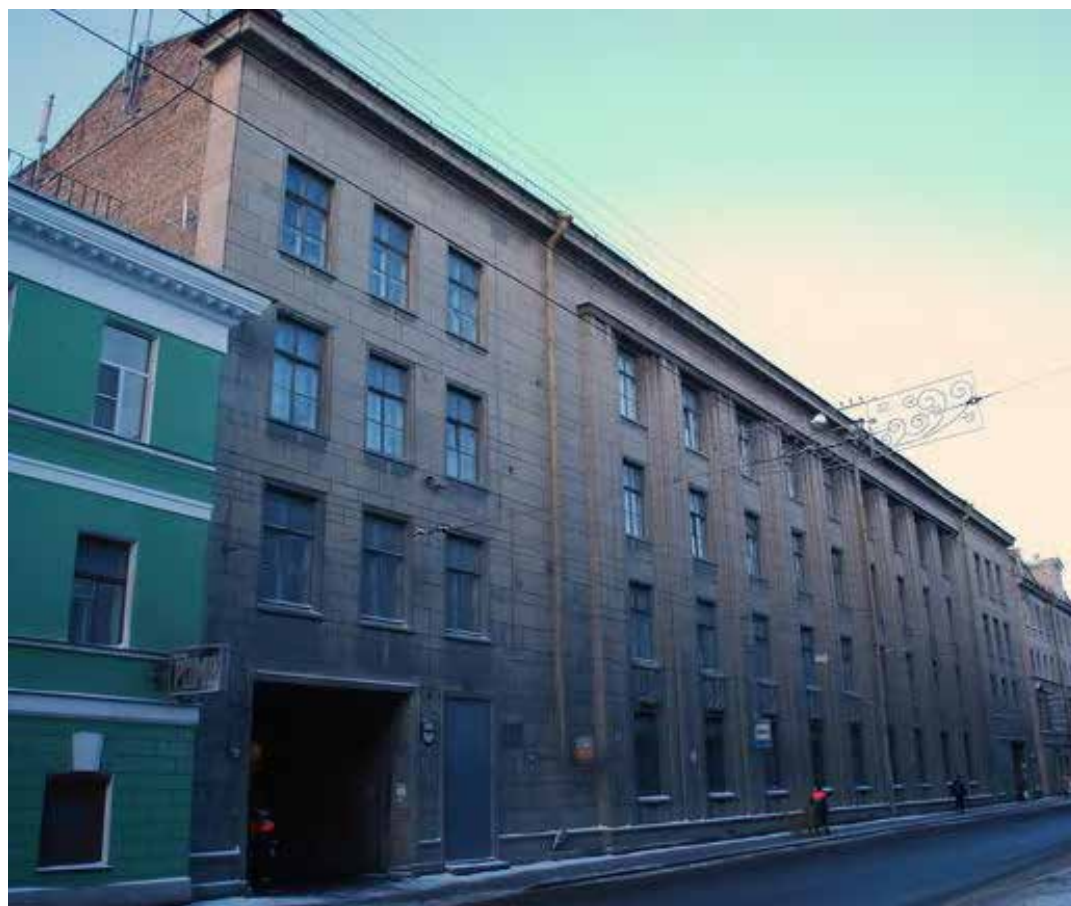
74. Школа № 261 Октябрьского района - ЛОККИ, 2009 г. [Электронный ресурс] URL: https://p3.citywalls.ru/photo_42-43459.jpg?mt=1274554833
