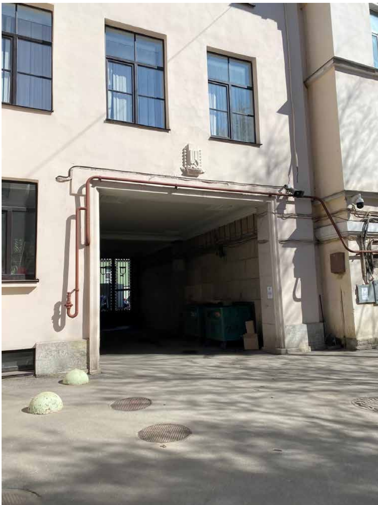
11. Воротный проезд (южный) объекта культурного наследия.
