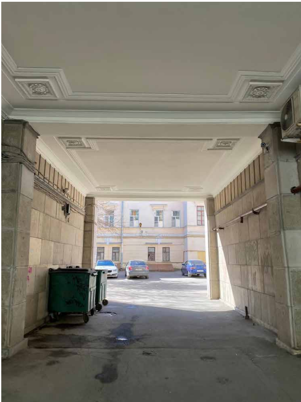
8. Воротный проезд (южный) объекта культурного наследия.
