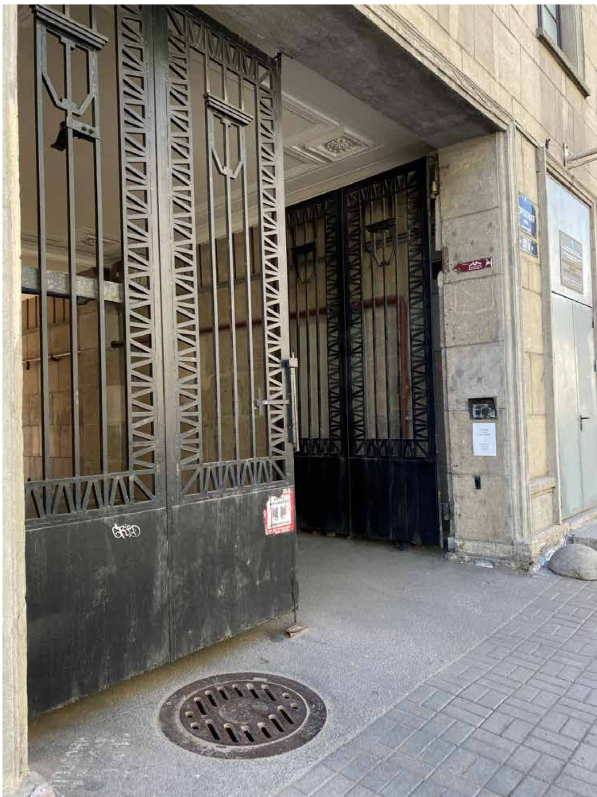
7. Вторичный проезд лицевого фасада объекта культурного наследия по Гороховой улице.
