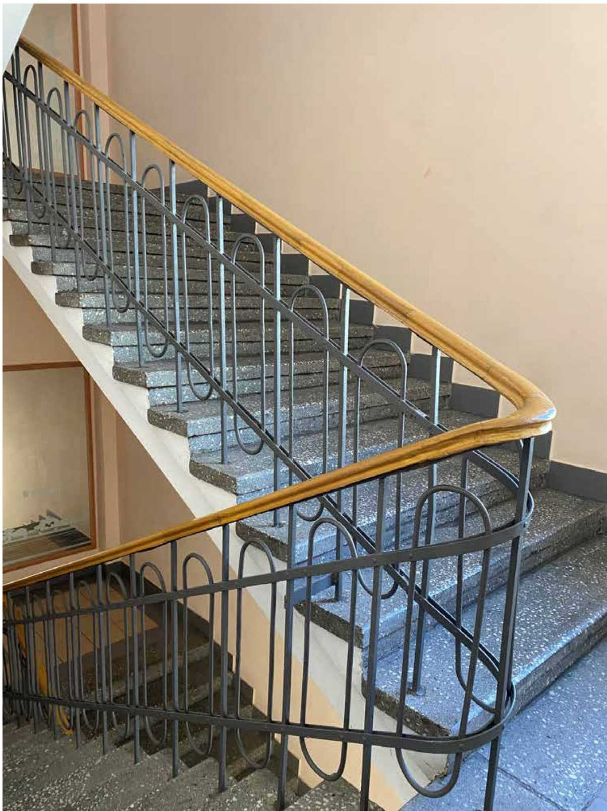
40. Общий вид южной северной объекта культурного наследия в уровне 3-го этажа.
