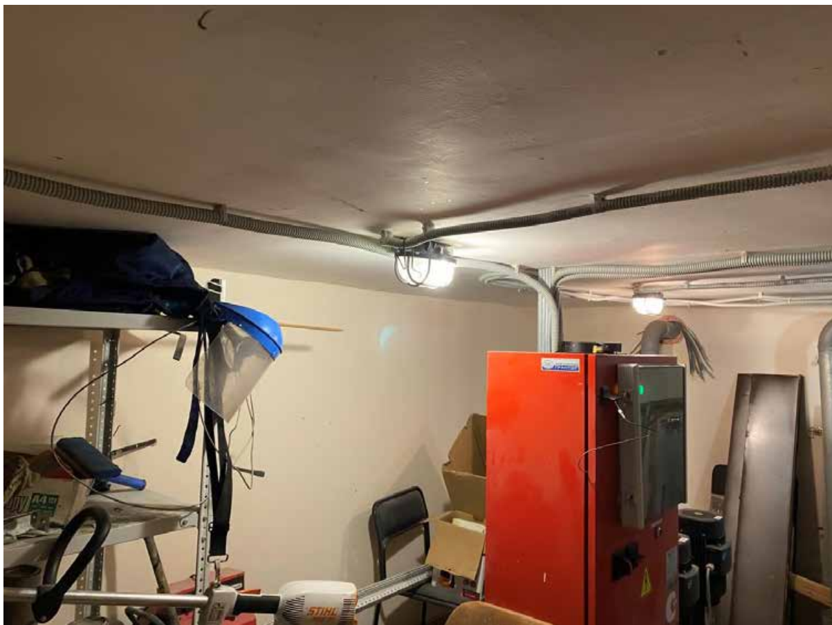
17. Помещение подвального этажа объекта культурного наследия.
