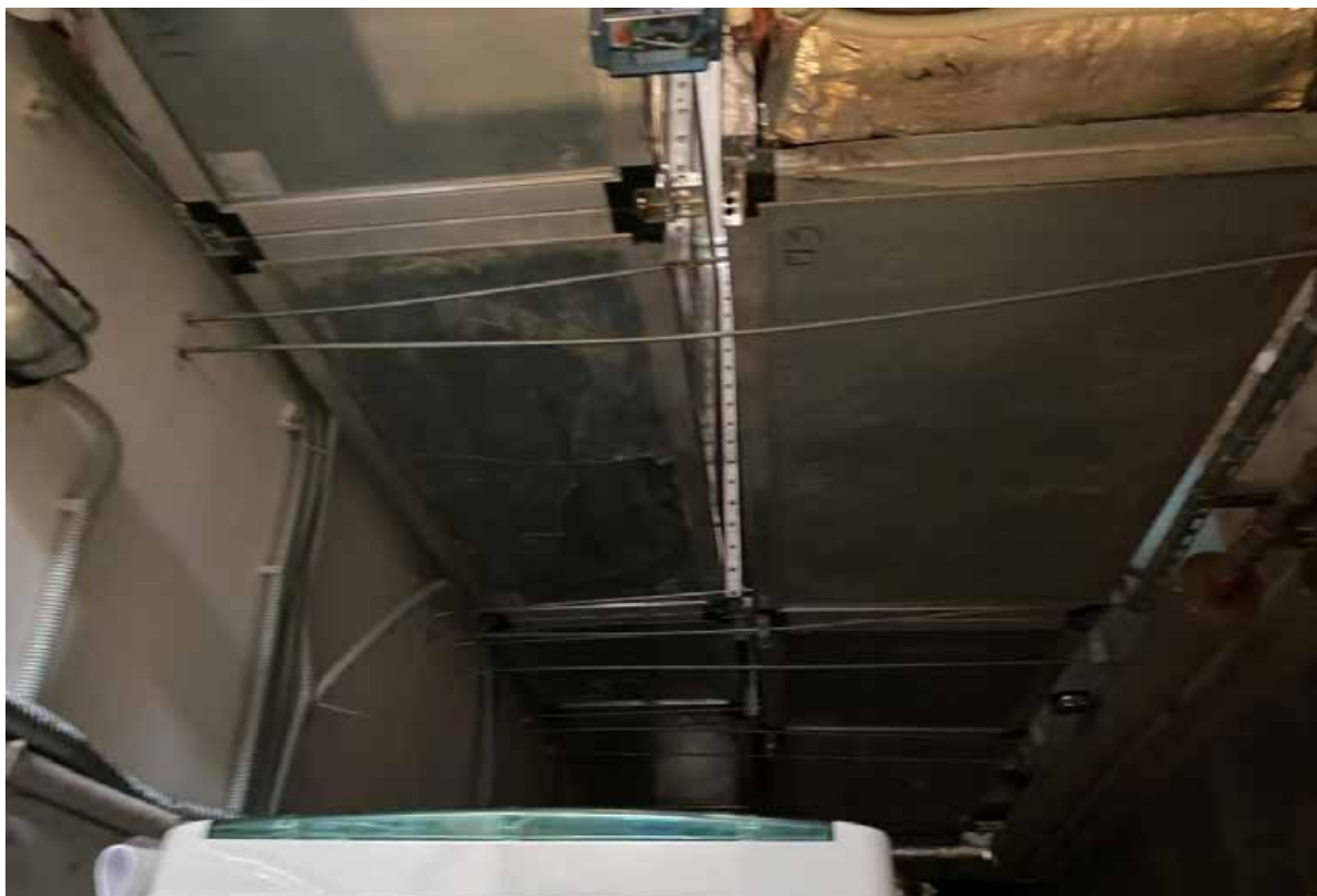
21. Помещение подвального этажа объекта культурного наследия.
