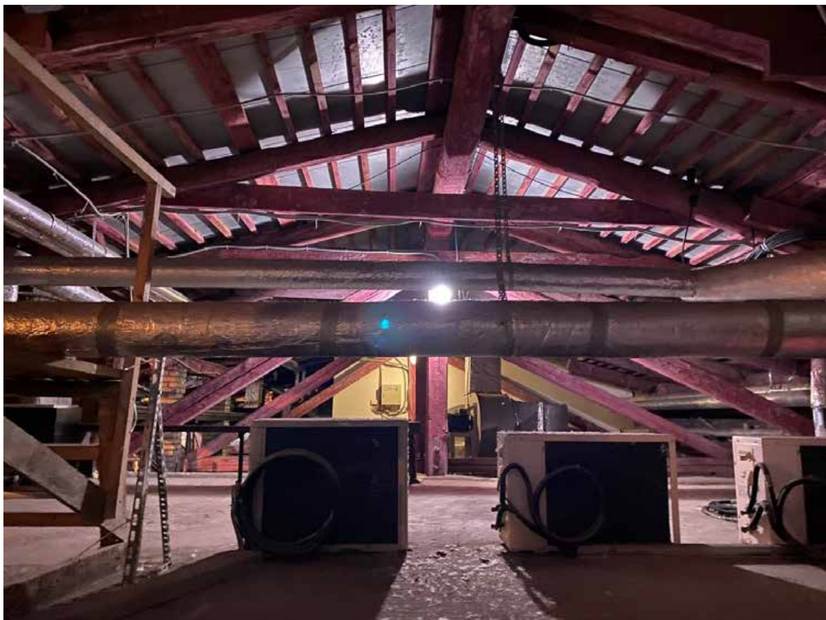
49. Стропильная система объекта культурного наследия.
