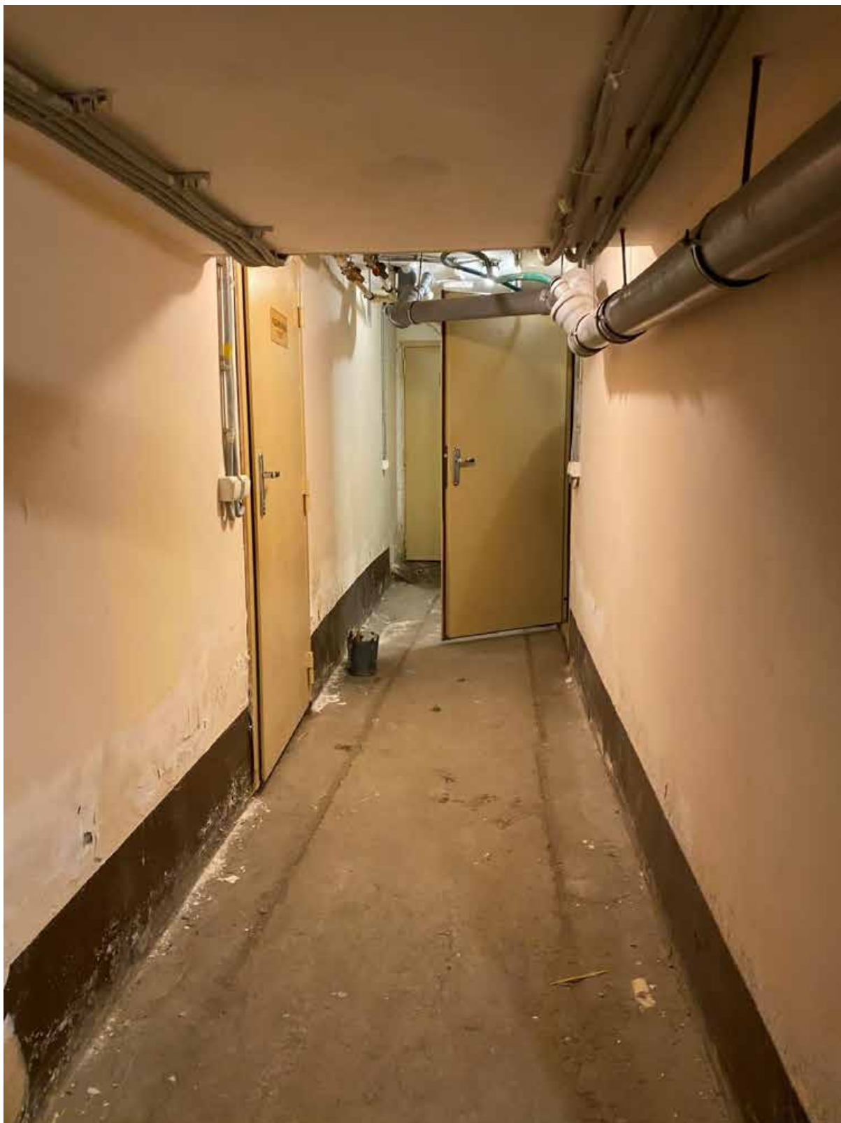
23. Помещение подвального этажа объекта культурного наследия.
