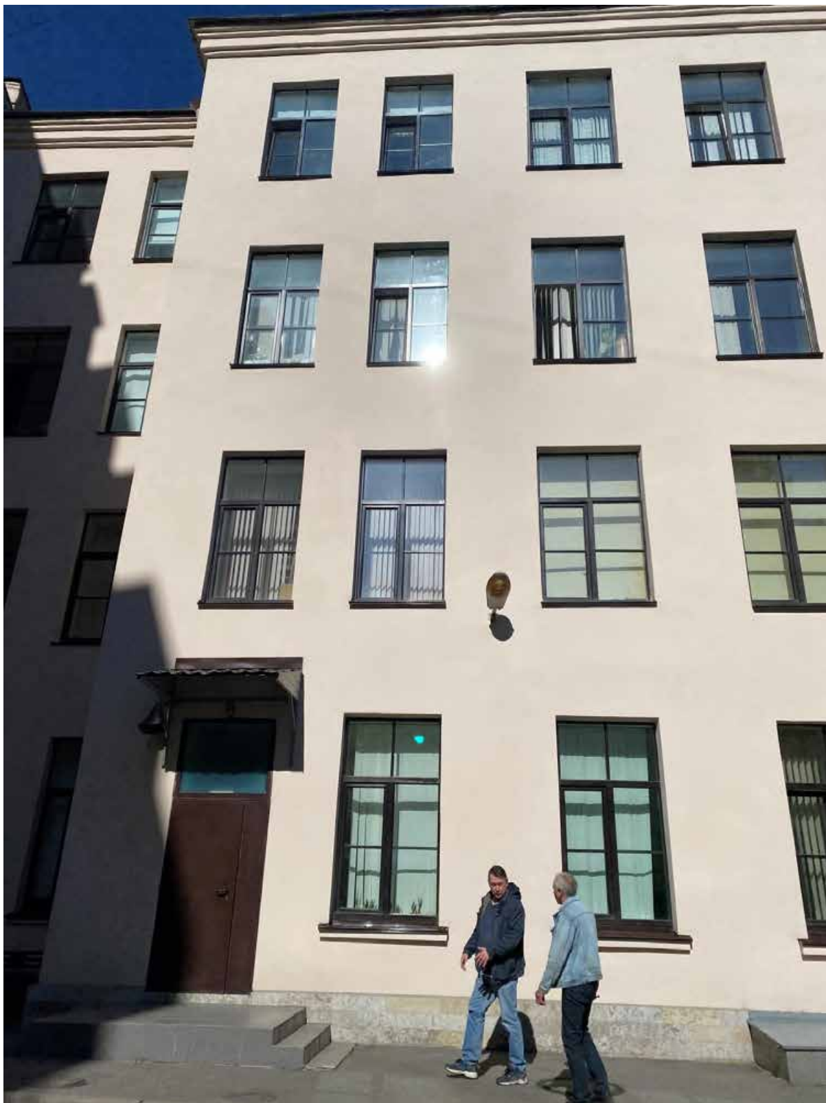
14. Фрагмент северной части дворового фасада объекта культурного наследия.
