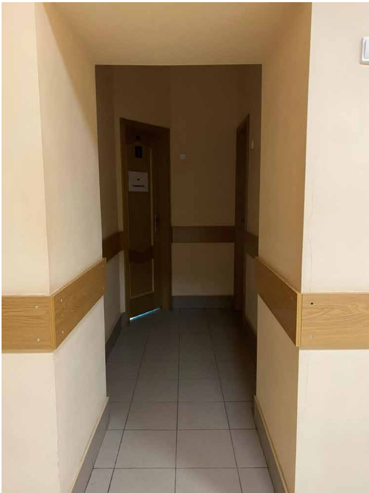
34. Интерьер помещения объекта культурного наследия в уровне 2-го этажа.
