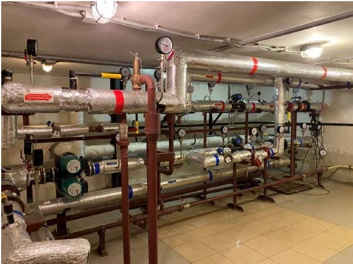
24. Помещение подвального этажа объекта культурного наследия.
