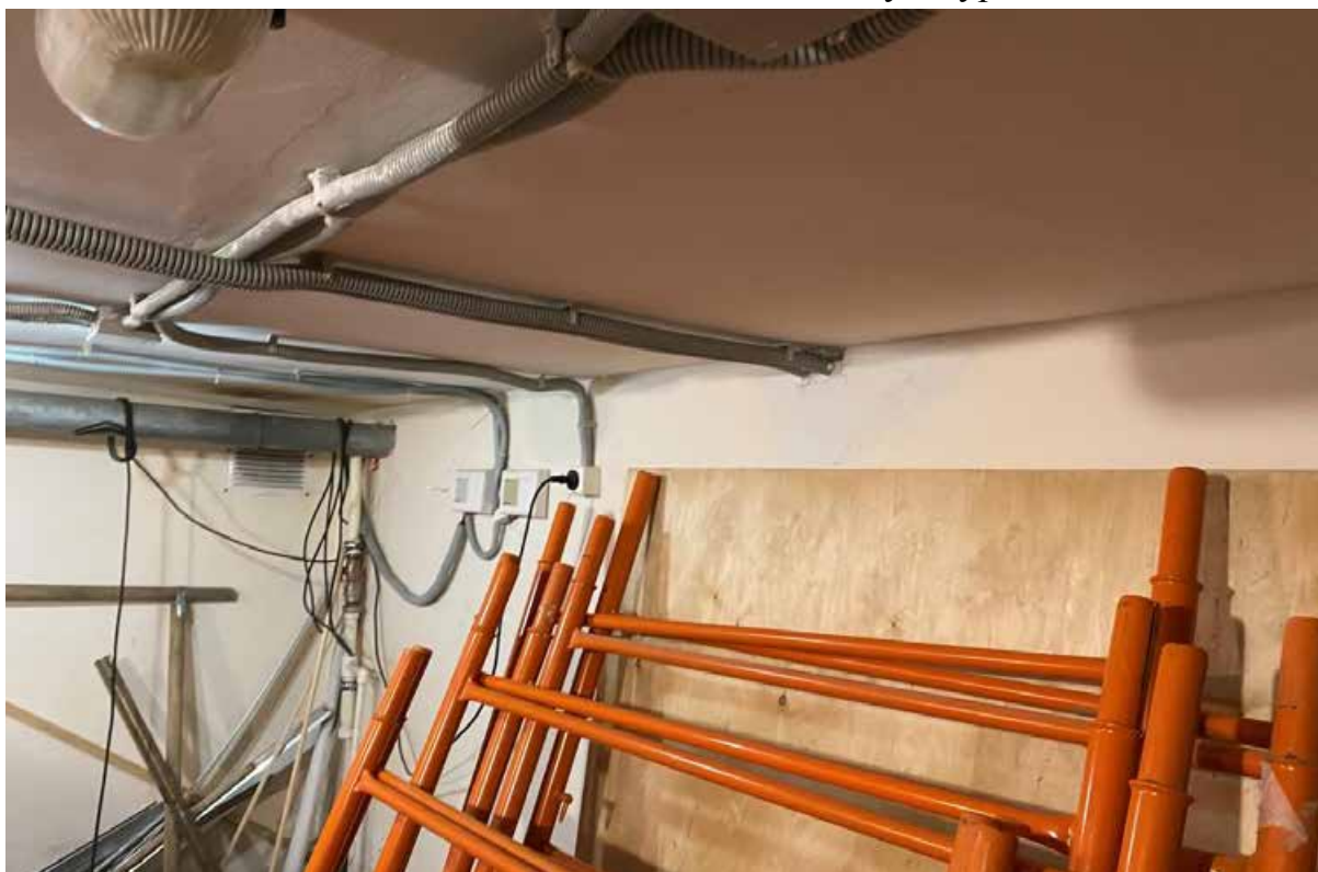
18. Помещение подвального этажа объекта культурного наследия.
