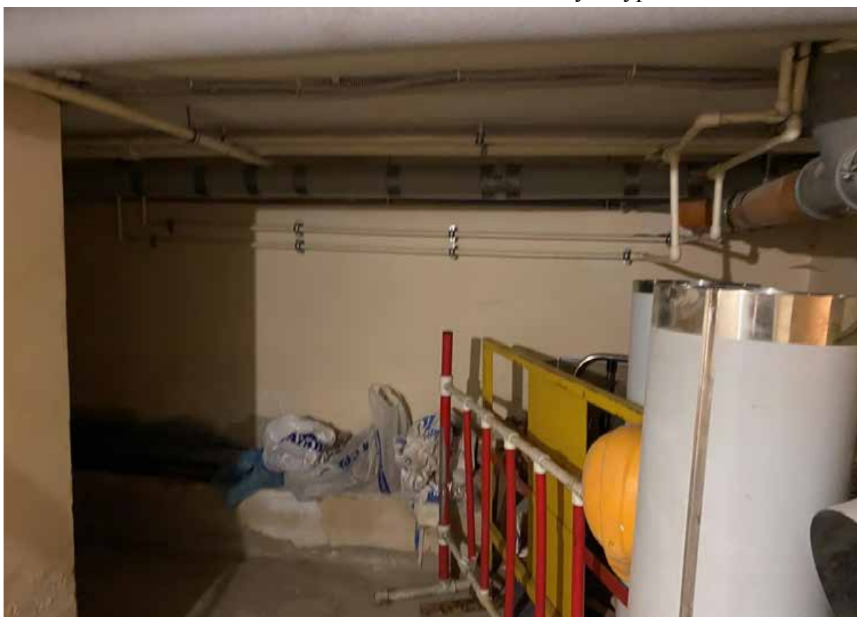
22. Помещение подвального этажа объекта культурного наследия.
