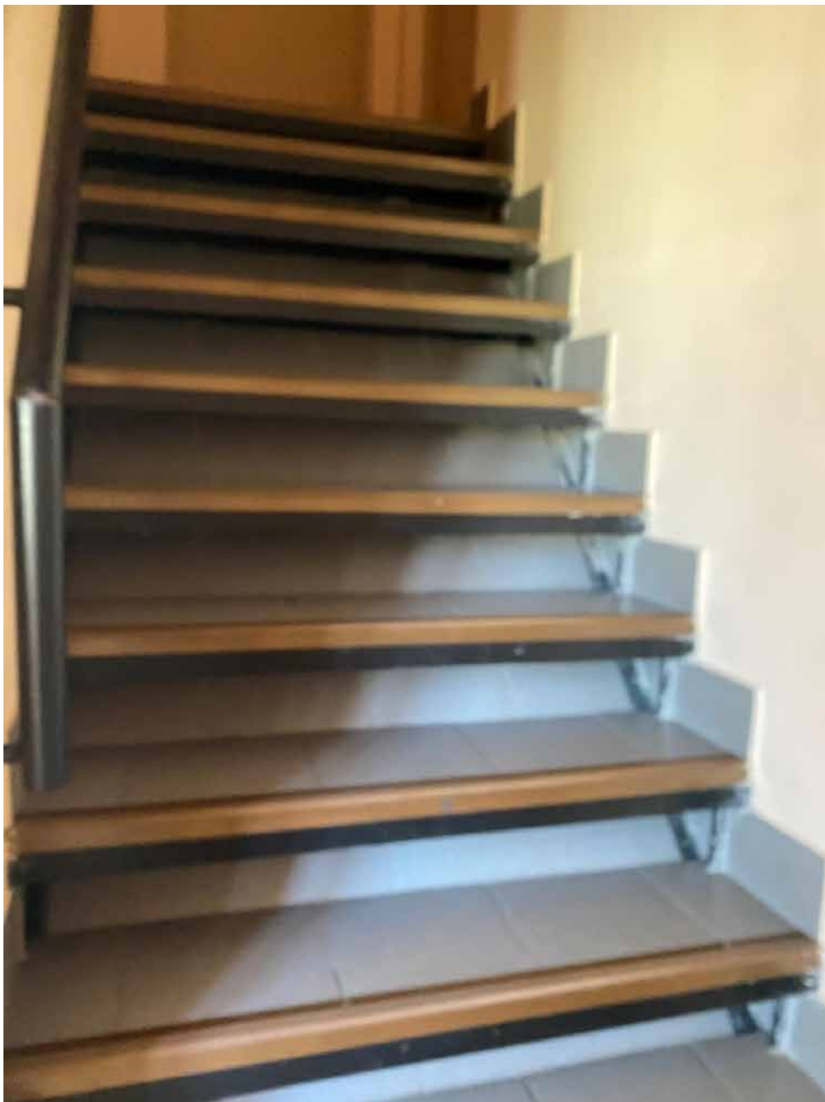
46. Общий вид лестницы восхода объекта культурного наследия в уровне 4-го этажа.
