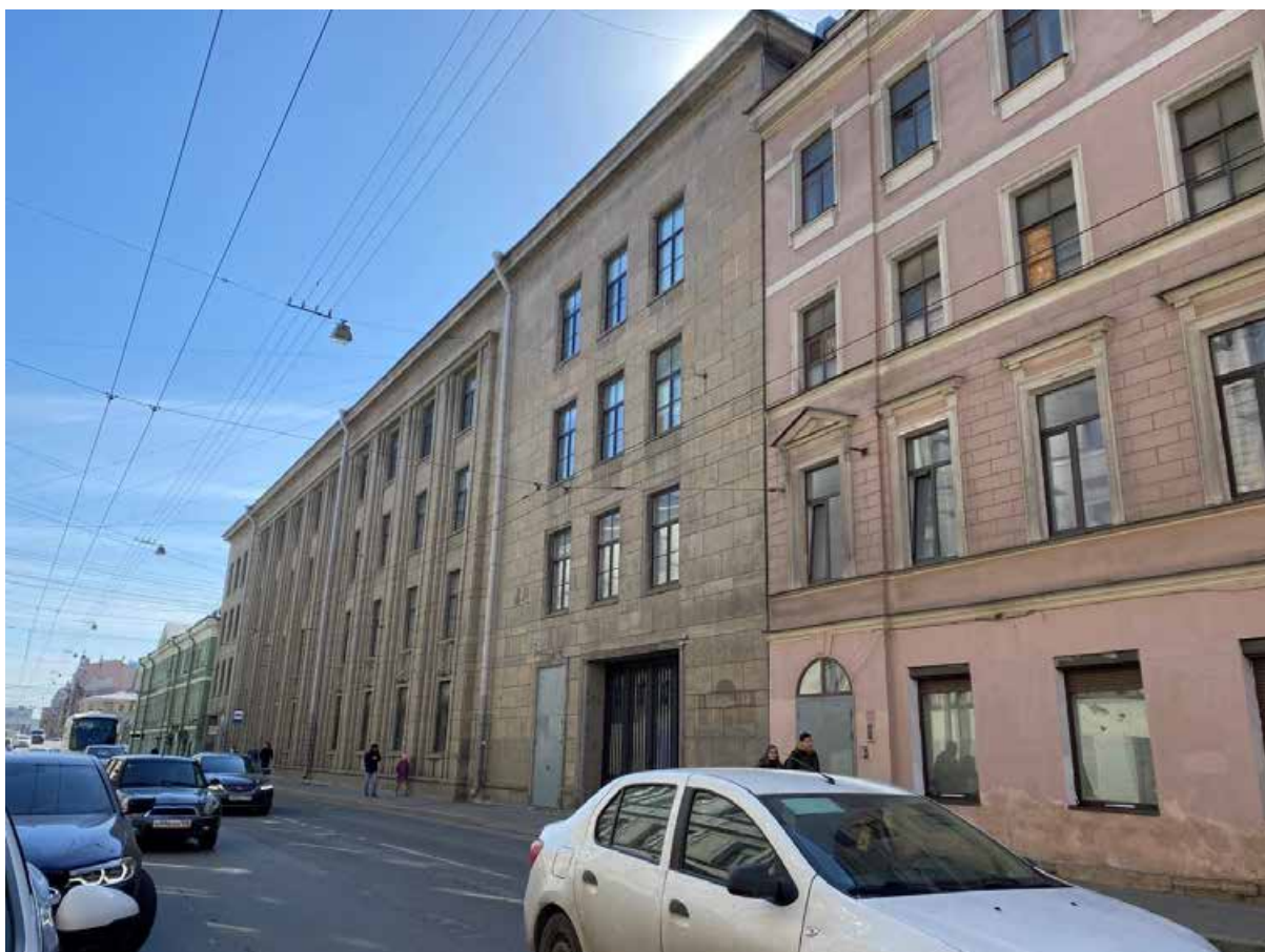
1. Общий вид лицевого фасада объекта культурного наследия по Гороховой улице.
