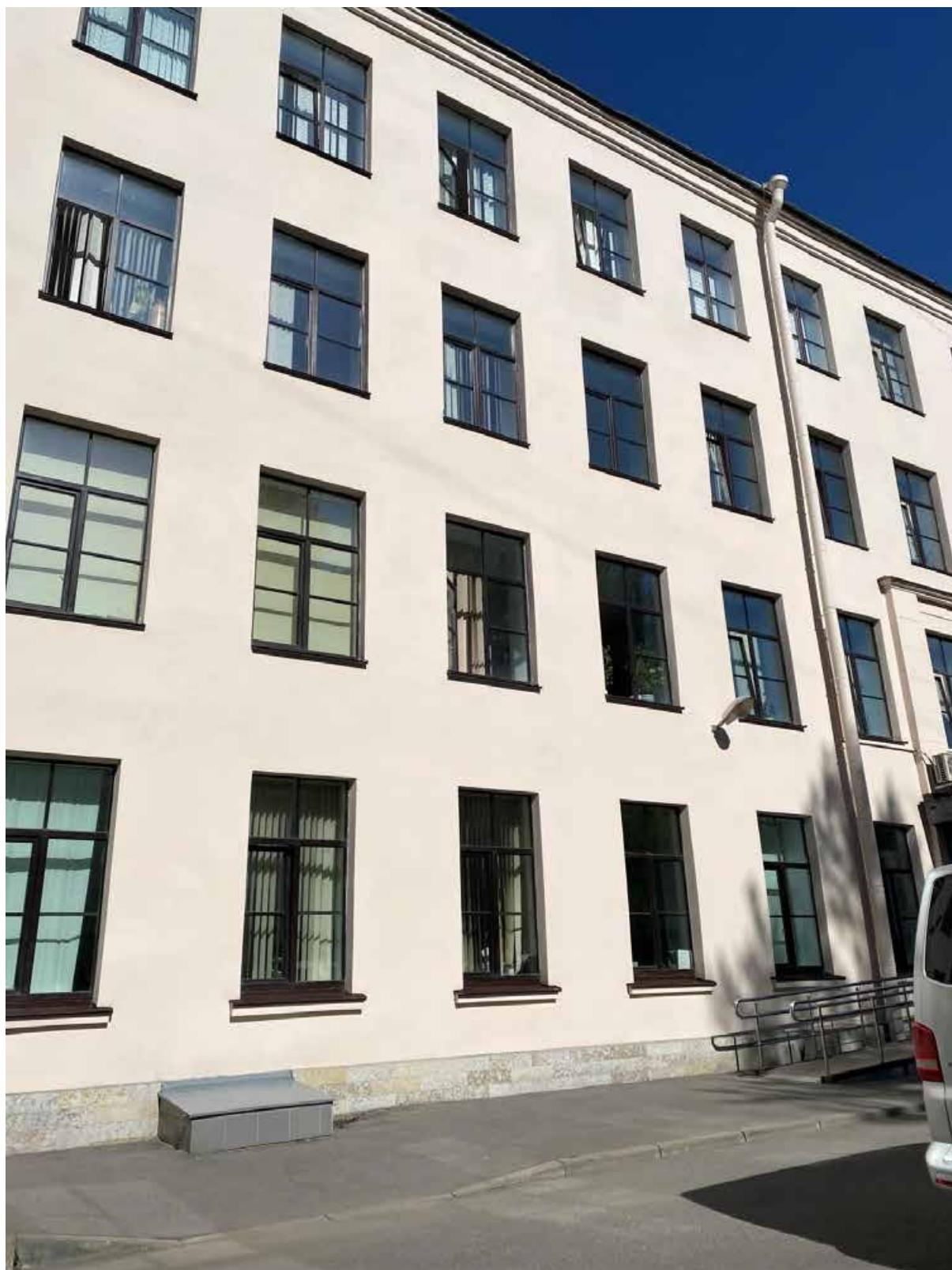
15. Фрагмент центральной части дворового фасада объекта культурного наследия.
