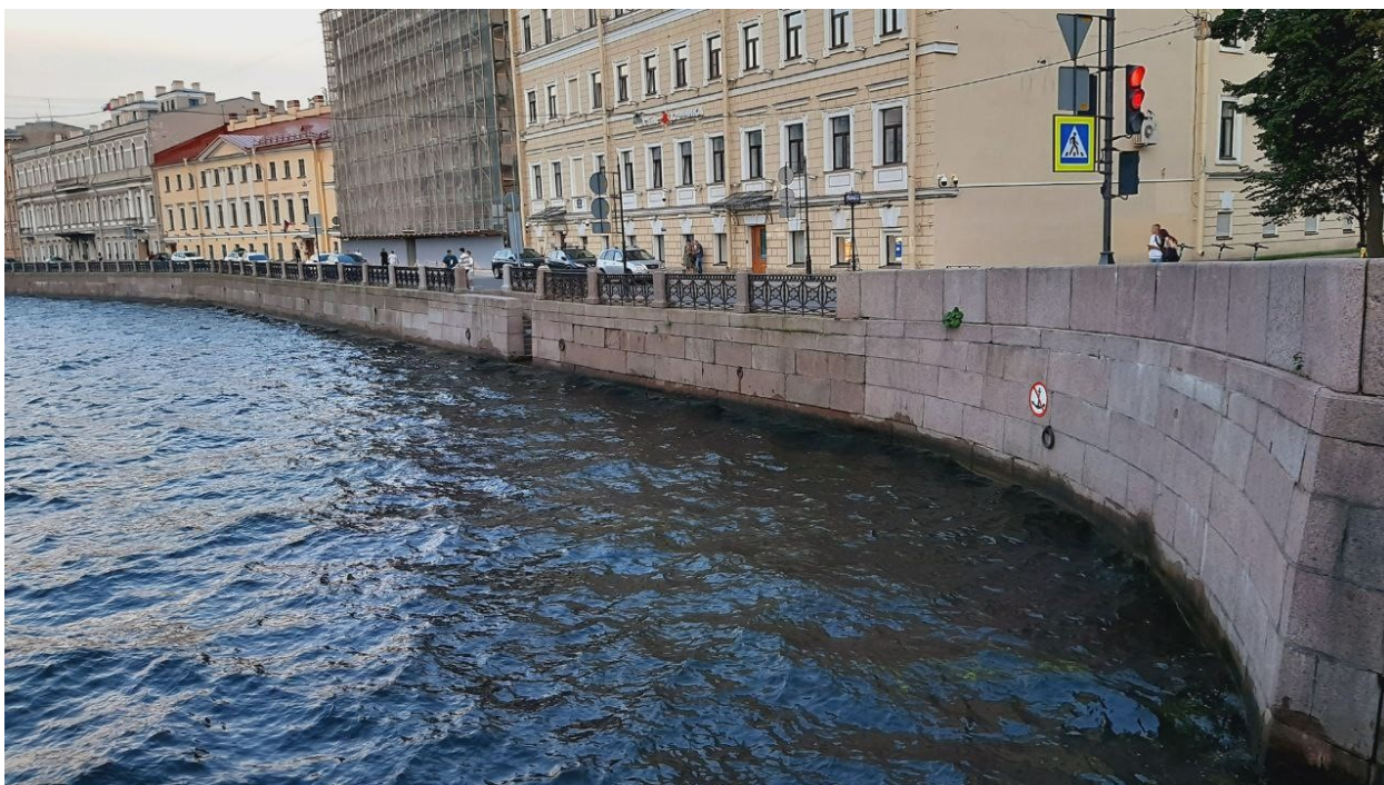
Ф.5 Фрагмент объекта культурного наследия федерального значения «Набережные со спусками», входящего в состав ансамбля «Набережные и мосты реки Мойки» по адресу: г. Санкт-Петербург, участок набережной реки Мойки "Синий мост – Фонарный мост" (вид на левый берег)
