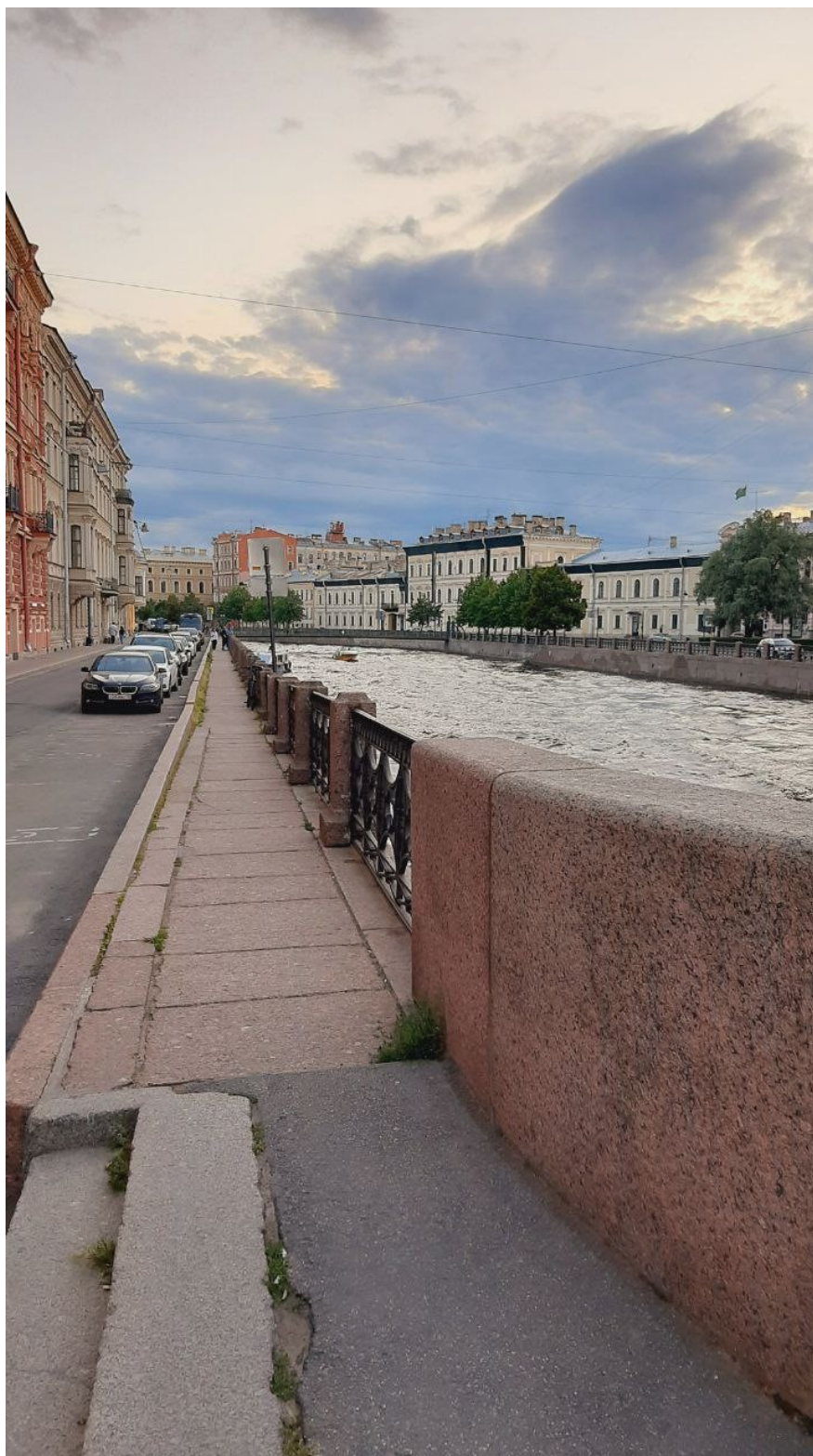
Ф.6 Фрагмент объекта культурного наследия федерального значения «Набережные со спусками», входящего в состав ансамбля «Набережные и мосты реки Мойки» по адресу: г. Санкт-Петербург, участок набережной реки Мойки "Фонарный мост – Почтамтский мост" (левый берег)
