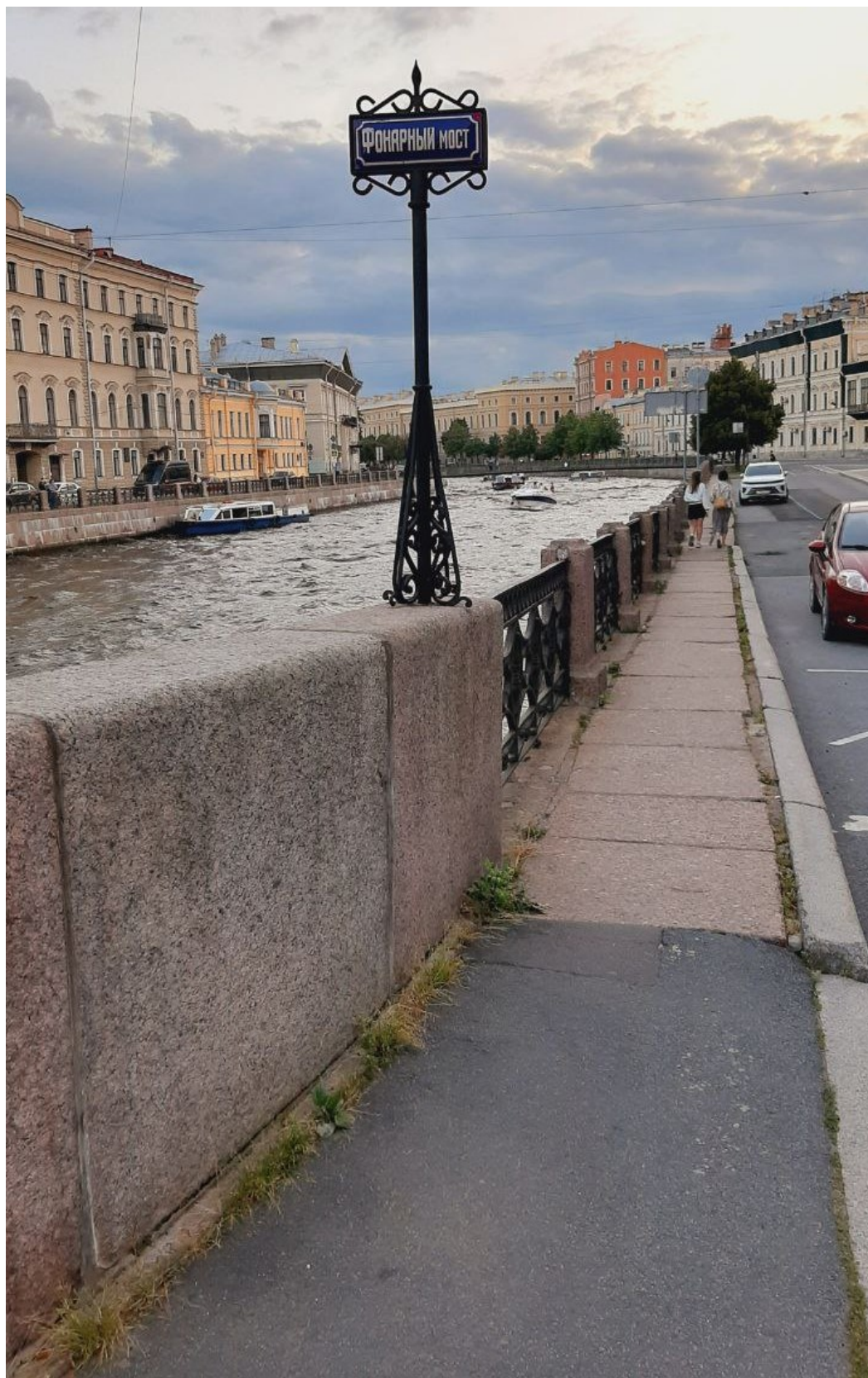
Ф.6 Фрагмент объекта культурного наследия федерального значения «Набережные со спусками», входящего в состав ансамбля «Набережные и мосты реки Мойки» по адресу: г. Санкт-Петербург, участок набережной реки Мойки "Фонарный мост – Почтамтский мост" (правый берег)
