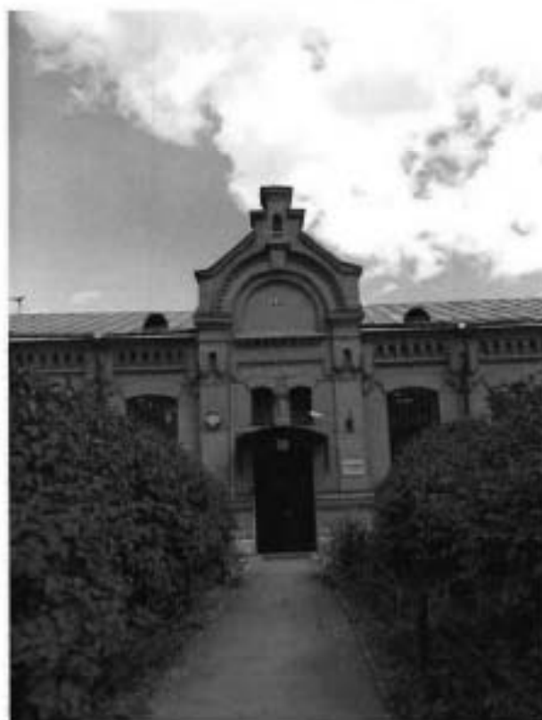
4. Фрагмент центральной части западного фасада.
