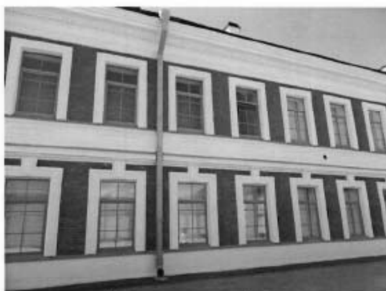
4. Фрагмент восточного фасада.
