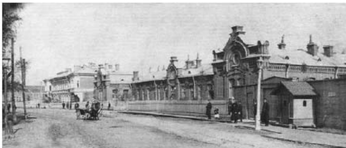
Илл. 28. Здание больницы и амбулатории завода фото 1898-1899 гг. Объект культурного наследия регионального значения «Больница Обуховского сталелитейного завода»
