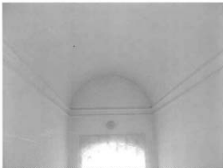
5. Цилиндрический свод и декоративные профилированные тяги.
