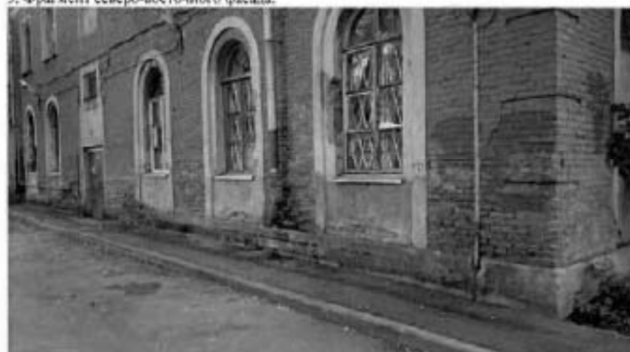
3. Фрагмент северо-восточного фасада.
