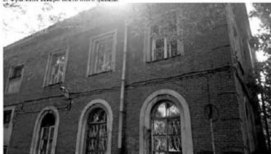
2. Фрагмент северо-восточного фасада.
