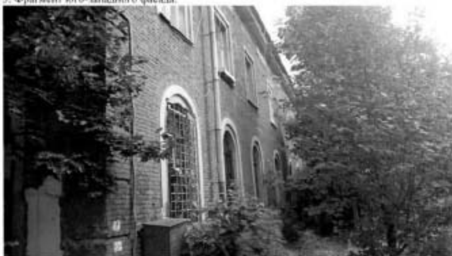
5. Фрагмент юго-западного фасада.
