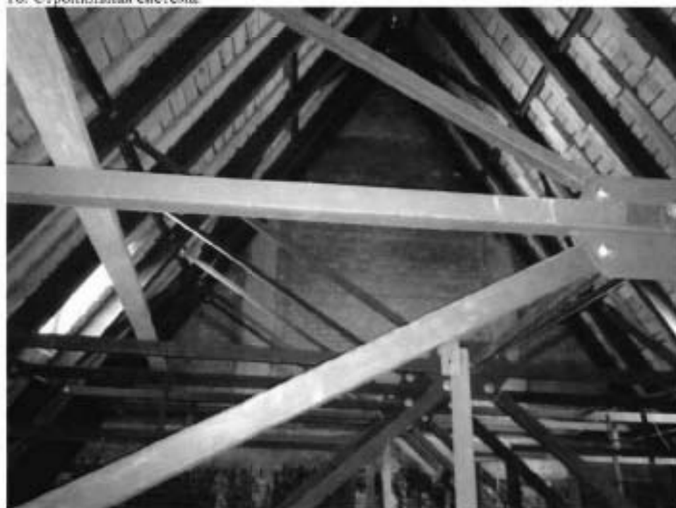
18. Стропильная система.
