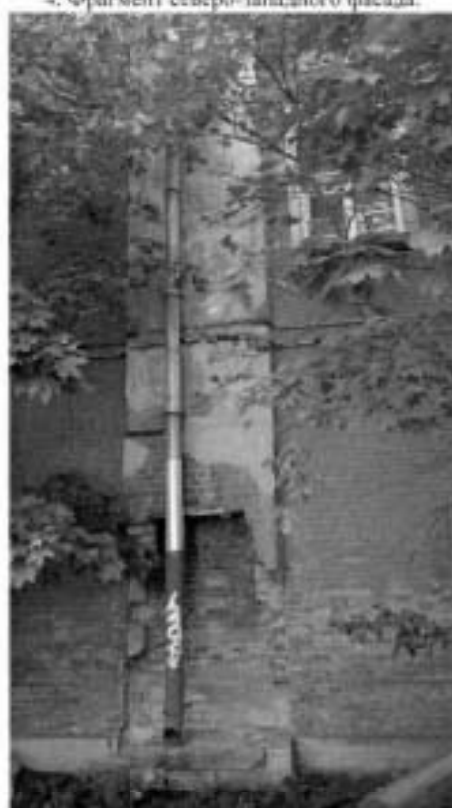
4. Фрагмент северо-западного фасада.
