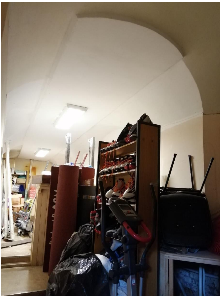
18. Объект культурного наследия федерального значения «Корпус для игры в мяч ("жедепом")», расположенный по адресу: г. Санкт-Петербург, Университетская набережная, дом 7-9-11, литера О. Общий вид пом. № 1-Н(9) в отметке подвального этажа.
