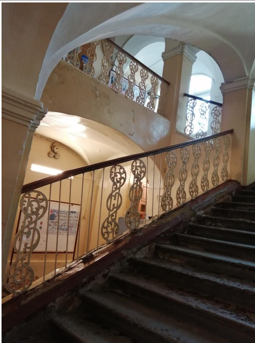
10. Объект культурного наследия федерального значения «Корпус для игры в мяч ("жедепом")», расположенный по адресу: г. Санкт-Петербург, Университетская набережная, дом 7-9-11, литера О. Общий вид парадной лестницы Л1.
