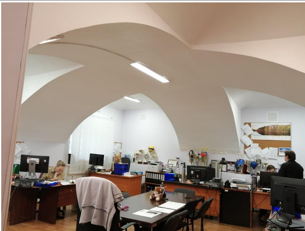
20. Объект культурного наследия федерального значения «Корпус для игры в мяч ("жедепом")», расположенный по адресу: г. Санкт-Петербург, Университетская набережная, дом 7-9-11, литера О. Общий вид пом. № 1-Н(5) в отметке подвального этажа.
