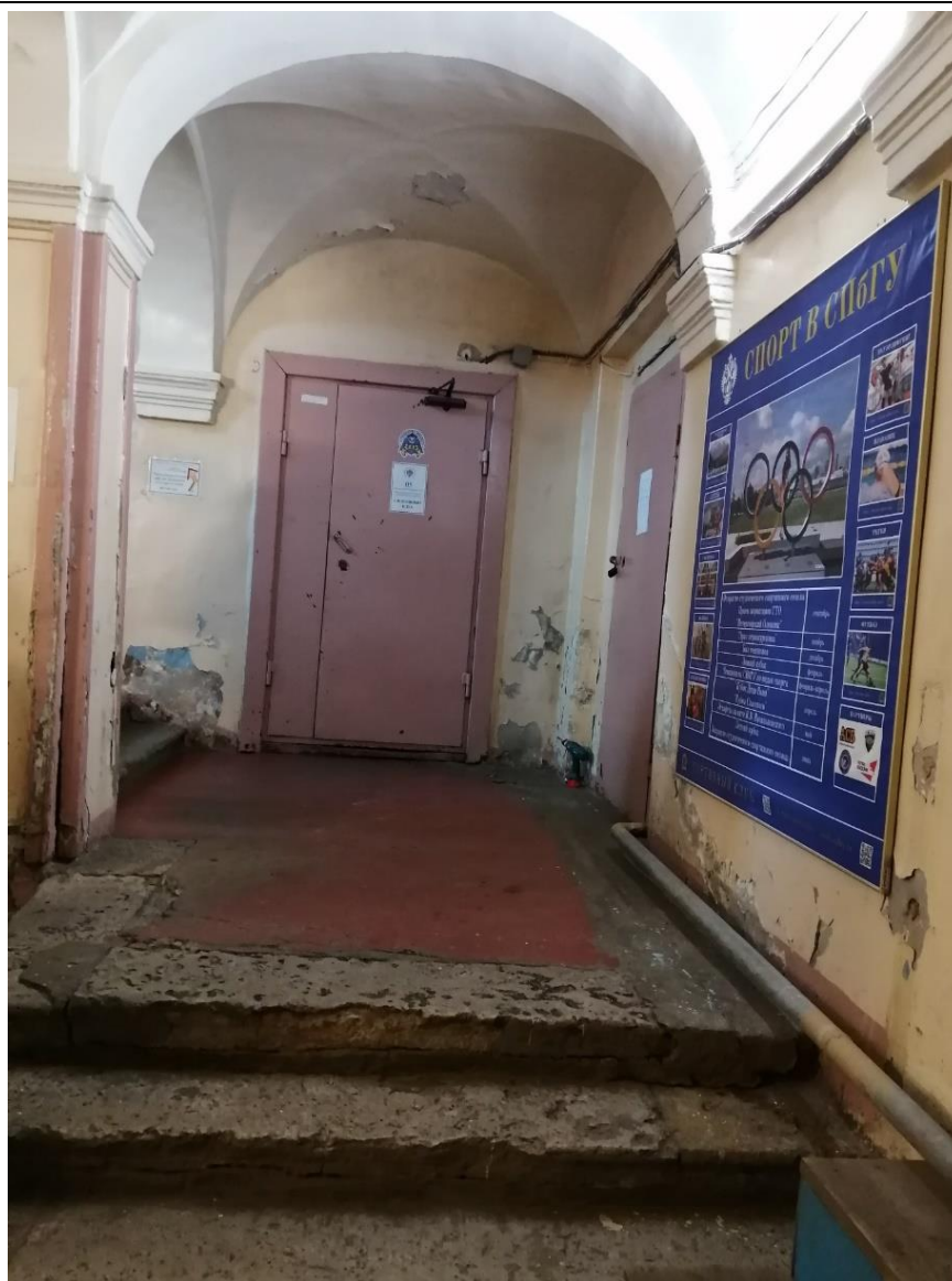
8. Объект культурного наследия федерального значения «Корпус для игры в мяч ("жедепом")», расположенный по адресу: г. Санкт-Петербург, Университетская набережная, дом 7-9-11, литера О. Общий вид пом. № 1-Н(3) в отметке первого этажа, вестибюль парадного входа, угловой лестничный марш перед парадной лестницей.
