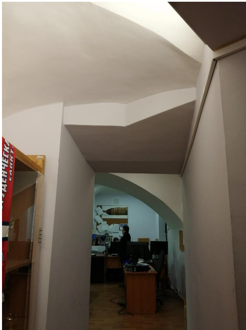
22. Объект культурного наследия федерального значения «Корпус для игры в мяч ("жедепом")», расположенный по адресу: г. Санкт-Петербург, Университетская набережная, дом 7-9-11, литера О. Фрагмент пом. № 1-Н(4) в отметке подвального этажа.
