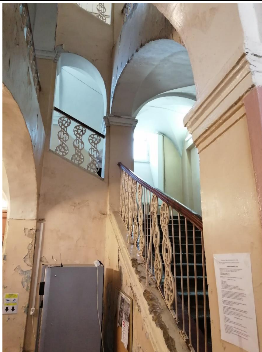
9. Объект культурного наследия федерального значения «Корпус для игры в мяч ("жедепом")», расположенный по адресу: г. Санкт-Петербург, Университетская набережная, дом 7-9-11, литера О. Общий вид парадной лестницы Л1, пом. 1-Н(3).
