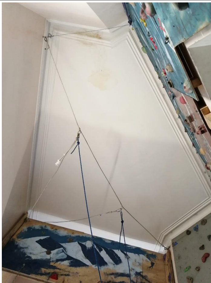
36. Объект культурного наследия федерального значения «Корпус для игры в мяч ("жедепом")», расположенный по адресу: г. Санкт-Петербург, Университетская набережная, дом 7-9-11, литера О. Фрагмент пом. № 1-Н(77) в отметке 1-го этажа.
