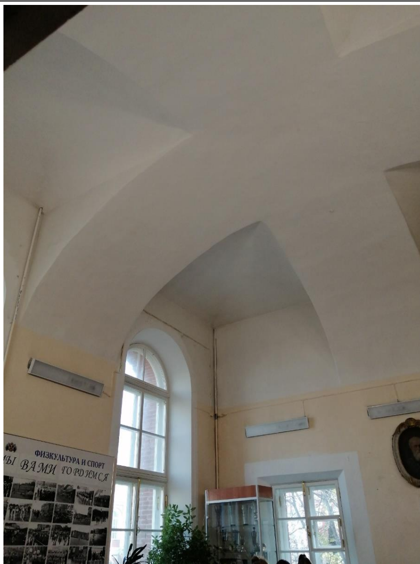
23. Объект культурного наследия федерального значения «Корпус для игры в мяч ("жедепом")», расположенный по адресу: г. Санкт-Петербург, Университетская набережная, дом 7-9-11, литера О. Общий вид пом. № 1-Н(47) в отметке 1-го этажа.
