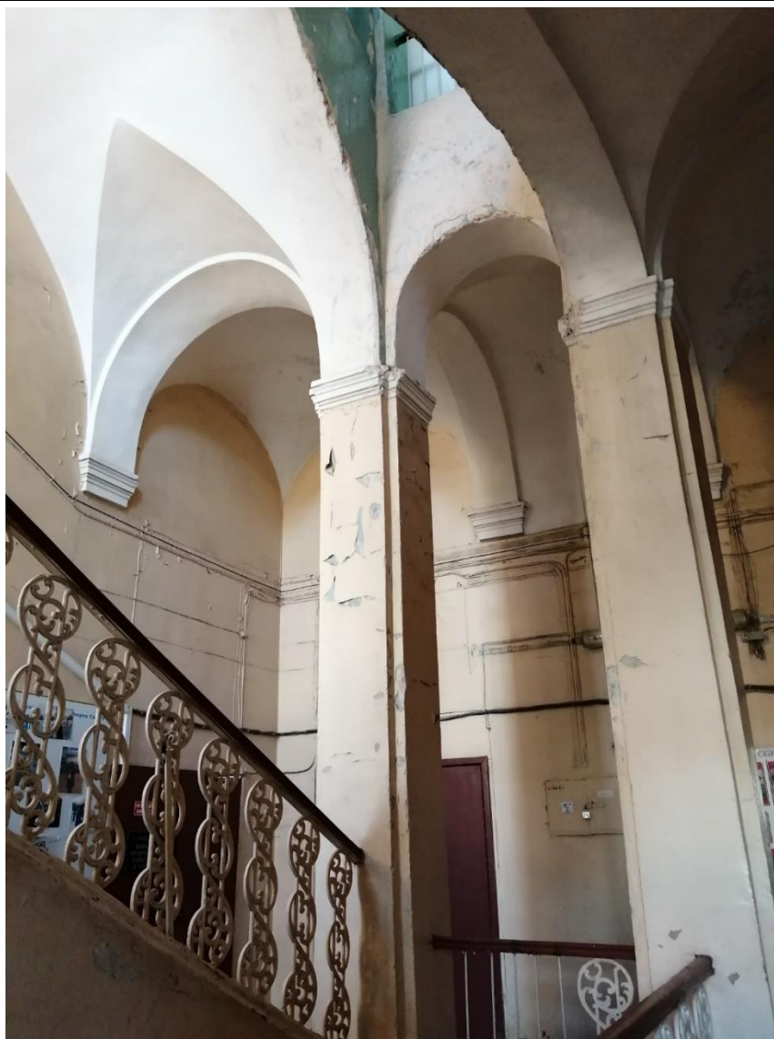
11. Объект культурного наследия федерального значения «Корпус для игры в мяч ("жедепом")», расположенный по адресу: г. Санкт-Петербург, Университетская набережная, дом 7-9-11, литера О. Общий вид парадной лестницы Л1, пом. № 1-Н(43).
