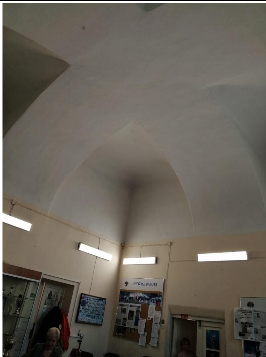
24. Объект культурного наследия федерального значения «Корпус для игры в мяч ("жедепом")», расположенный по адресу: г. Санкт-Петербург, Университетская набережная, дом 7-9-11, литера О. Фрагмент пом. № 1-Н(47) в отметке 1-го этажа.
