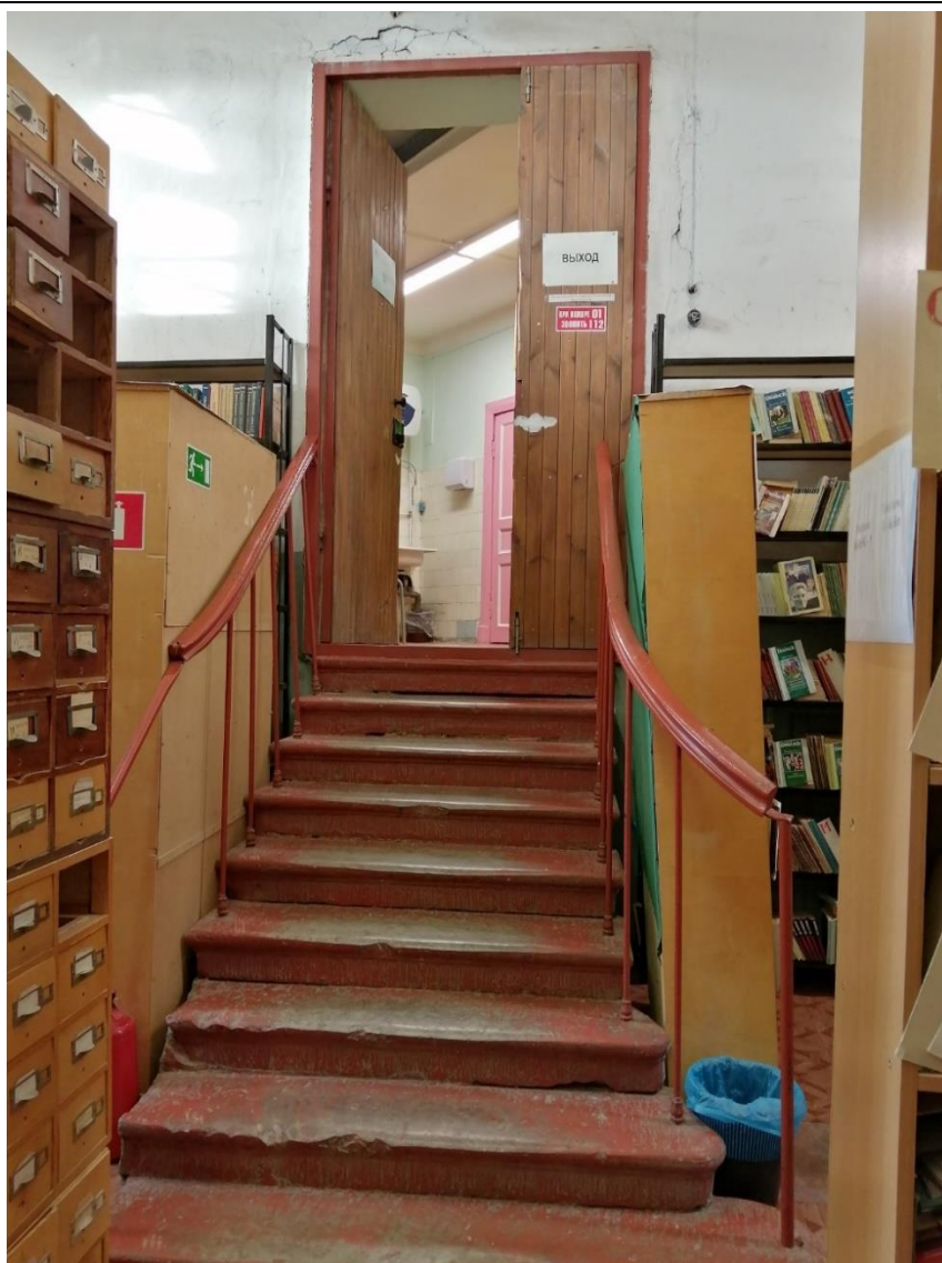
32. Объект культурного наследия федерального значения «Корпус для игры в мяч ("жедепом")», расположенный по адресу: г. Санкт-Петербург, Университетская набережная, дом 7-9-11, литера О. Фрагмент пом. № 1-Н(52) в отметке 1-го этажа.
