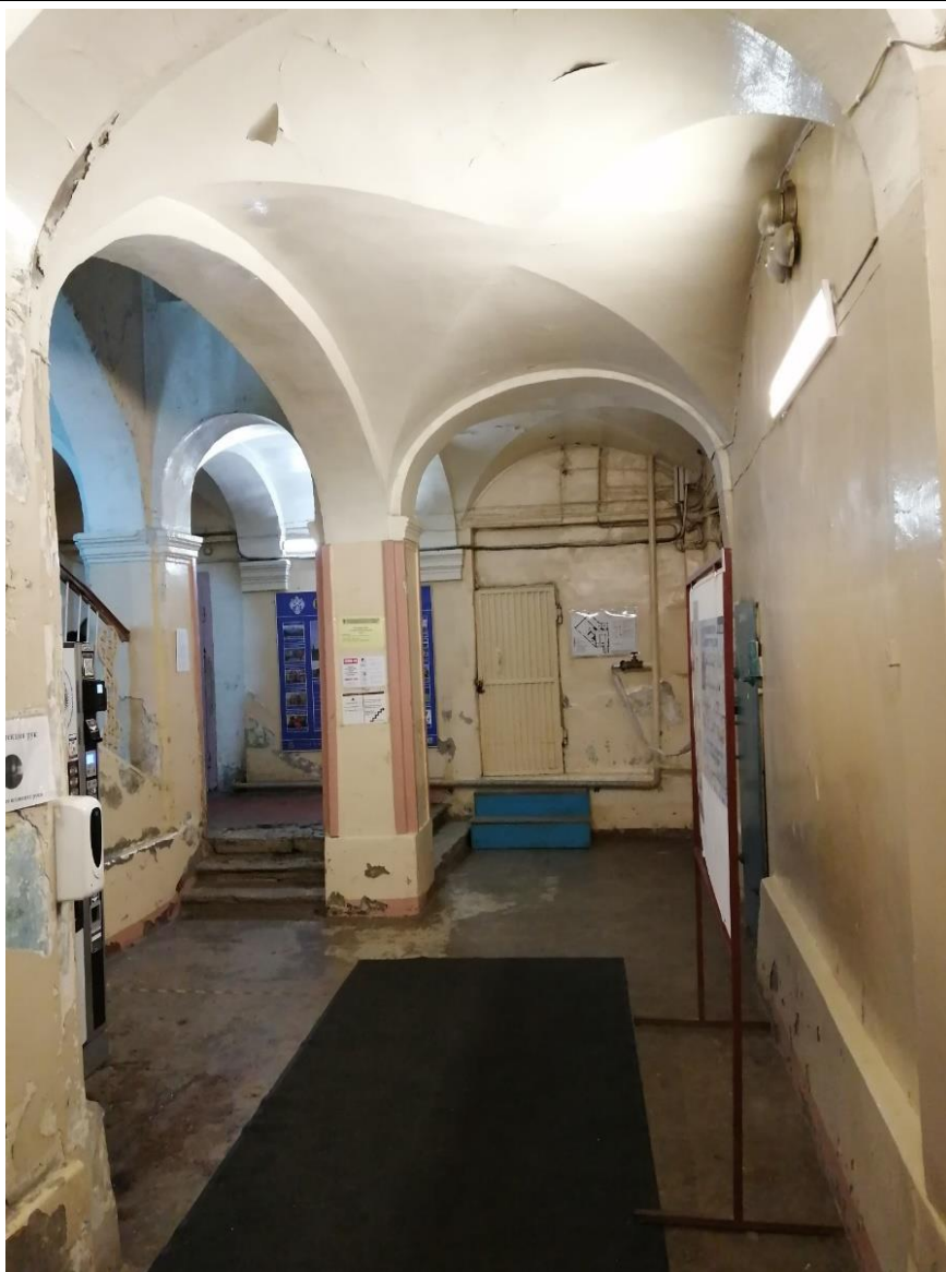
7. Объект культурного наследия федерального значения «Корпус для игры в мяч ("жедепом")», расположенный по адресу: г. Санкт-Петербург, Университетская набережная, дом 7-9-11, литера О. Общий вид пом. № 1-Н(3) в отметке первого этажа, вестибюль парадного входа, угловой лестничный марш перед парадной лестницей.
