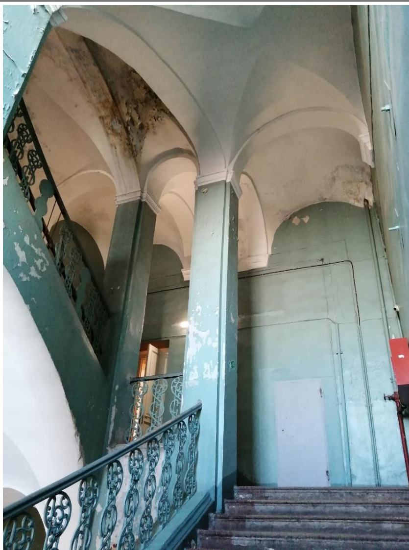
15. Объект культурного наследия федерального значения «Корпус для игры в мяч ("жедепом")», расположенный по адресу: г. Санкт-Петербург, Университетская набережная, дом 7-9-11, литера О. Общий вид парадной лестницы Л1, пом. № 1-Н(88).
