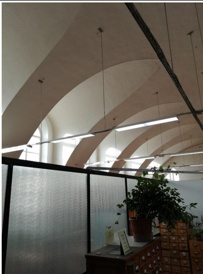
28. Объект культурного наследия федерального значения «Корпус для игры в мяч ("жедепом")», расположенный по адресу: г. Санкт-Петербург, Университетская набережная, дом 7-9-11, литера О. Фрагмент пом. № 1-Н(51) в отметке 1-го этажа.
