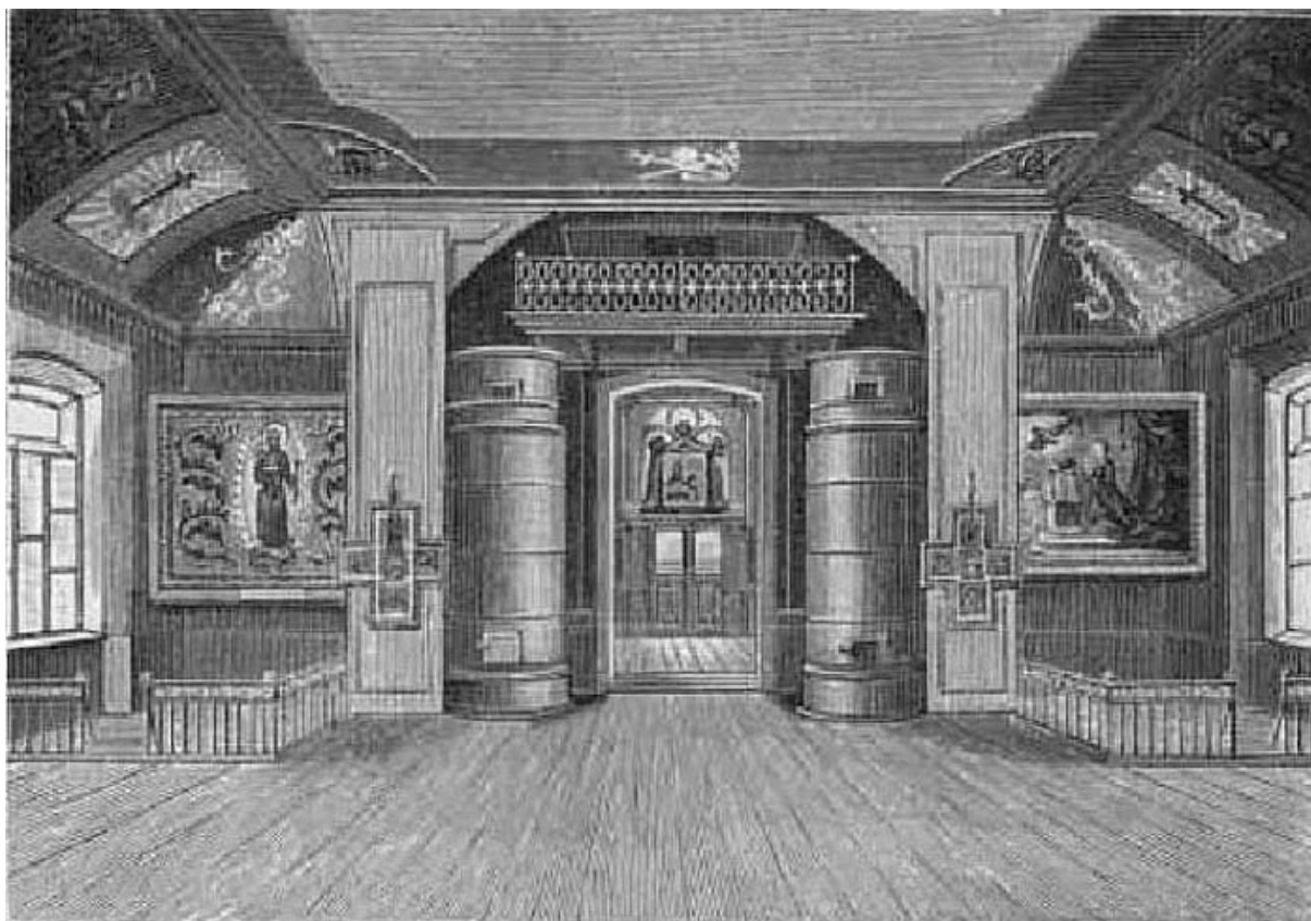
Илл. 86. Внутренний вид Троицко-Петровского собора с западной стороны в сторону входа. Гравюра // Фото из книги "Лавры, монастыри и храмы на святой Руси" СПб. 1909 г.
