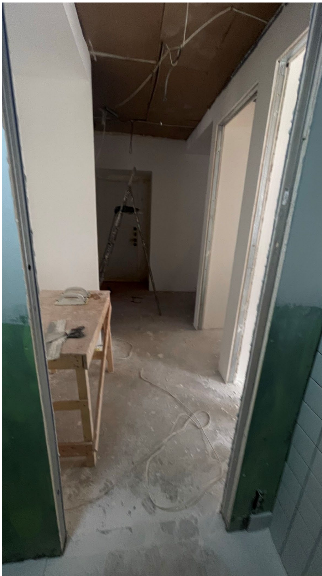
11.Фрагмент интеръера коридора (помещение 1; 8);
