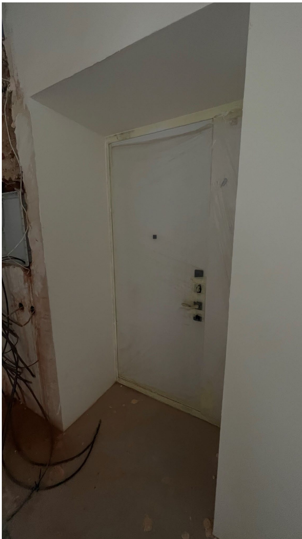
20. Вид на входную дверь в квартиру.
