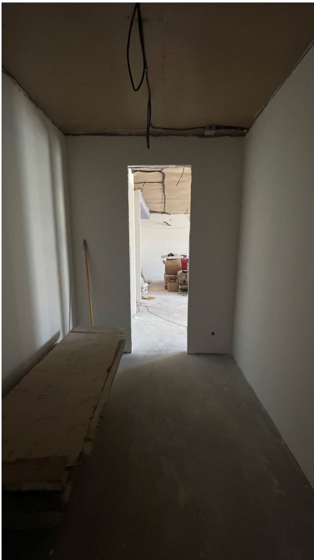
13.Фрагмент интерьера комнаты (помещение 7/26.9);
