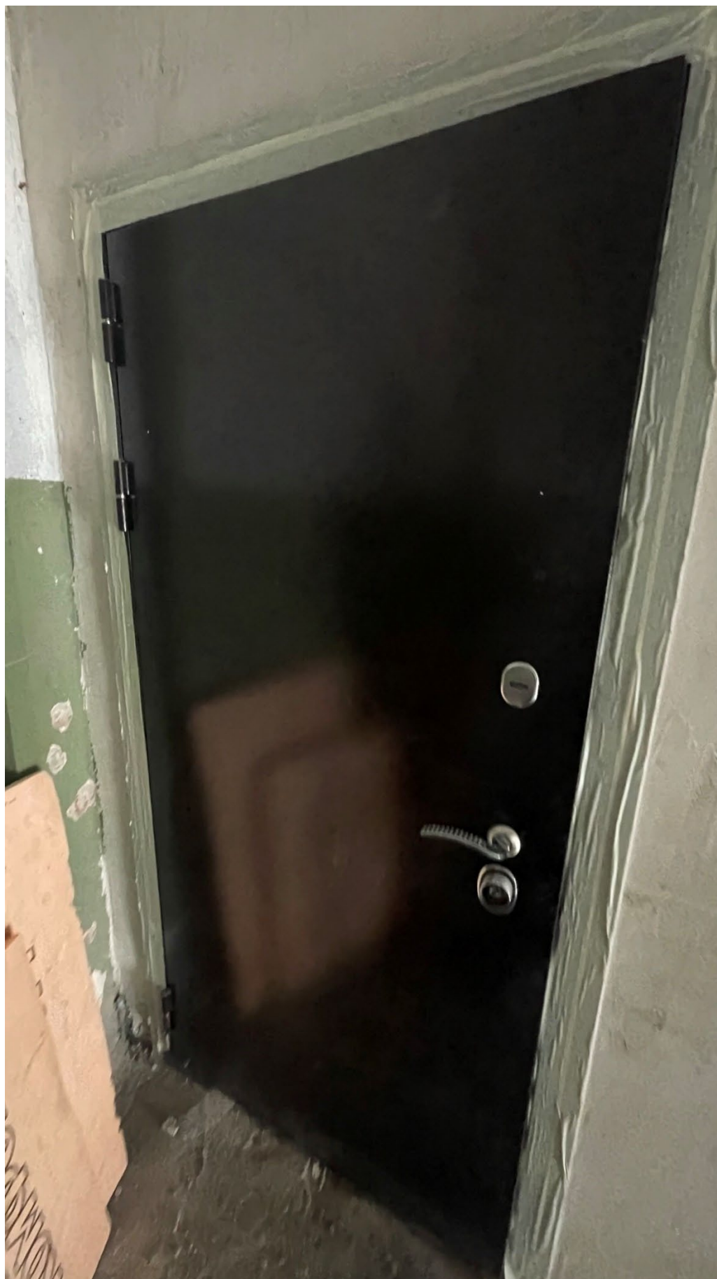
10. Вид на входную дверь в квартиру;
