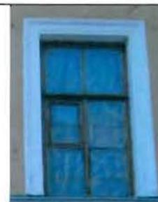
оформление оконного проема второго этажа по 4 оси северного фасада – профилированный штукатурный наличник с фланкирующими пилястрами прямоугольного сечения со штукатурными капителями;
