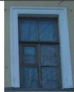
оформление оконного проема второго этажа по 4 оси северного фасада – профилированный штукатурный наличник с фланкирующими пилястрами прямоугольного сечения со штукатурными капителями;
