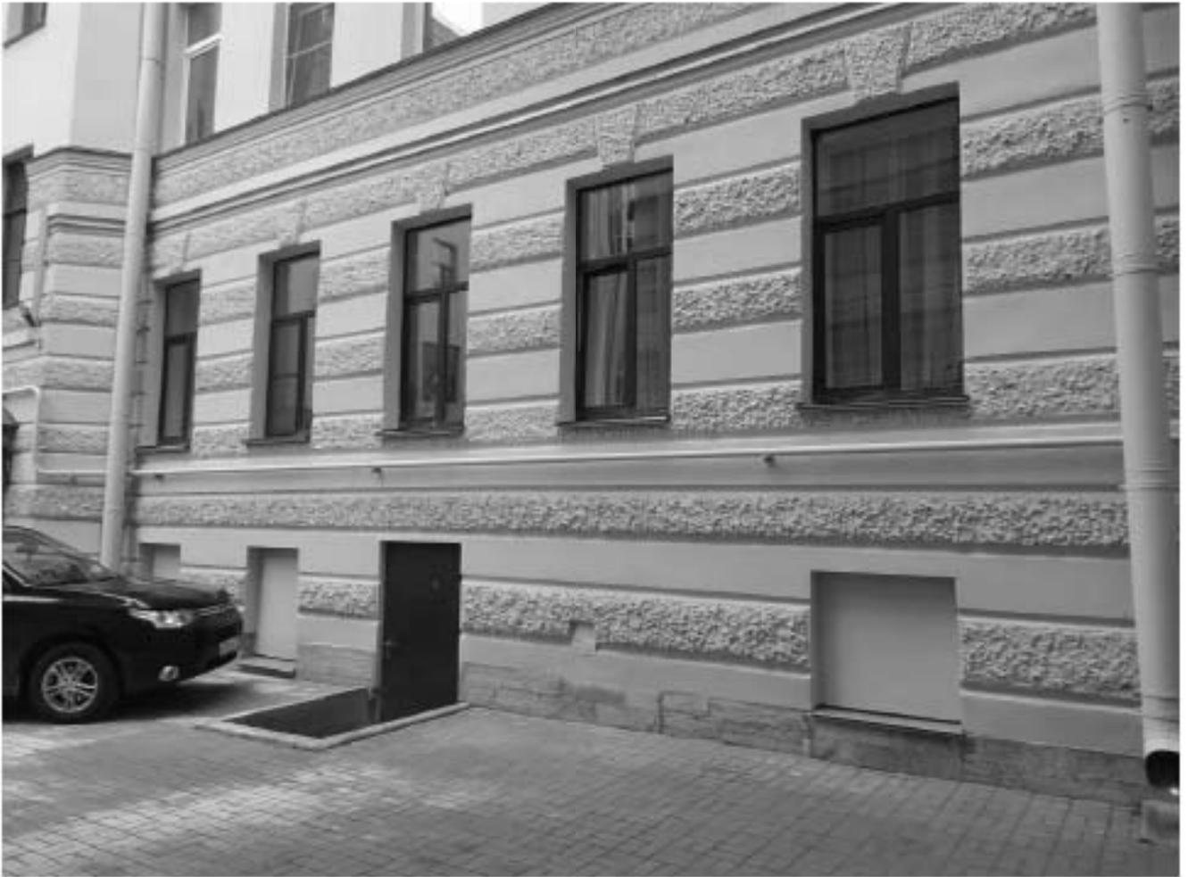
Фото 9. Фрагмент дворового фасада дворового флигеля Дома М.Б. Баструевой. Заложенные проемы подвального этажа. Дата съемки 22.07.2023 г.
