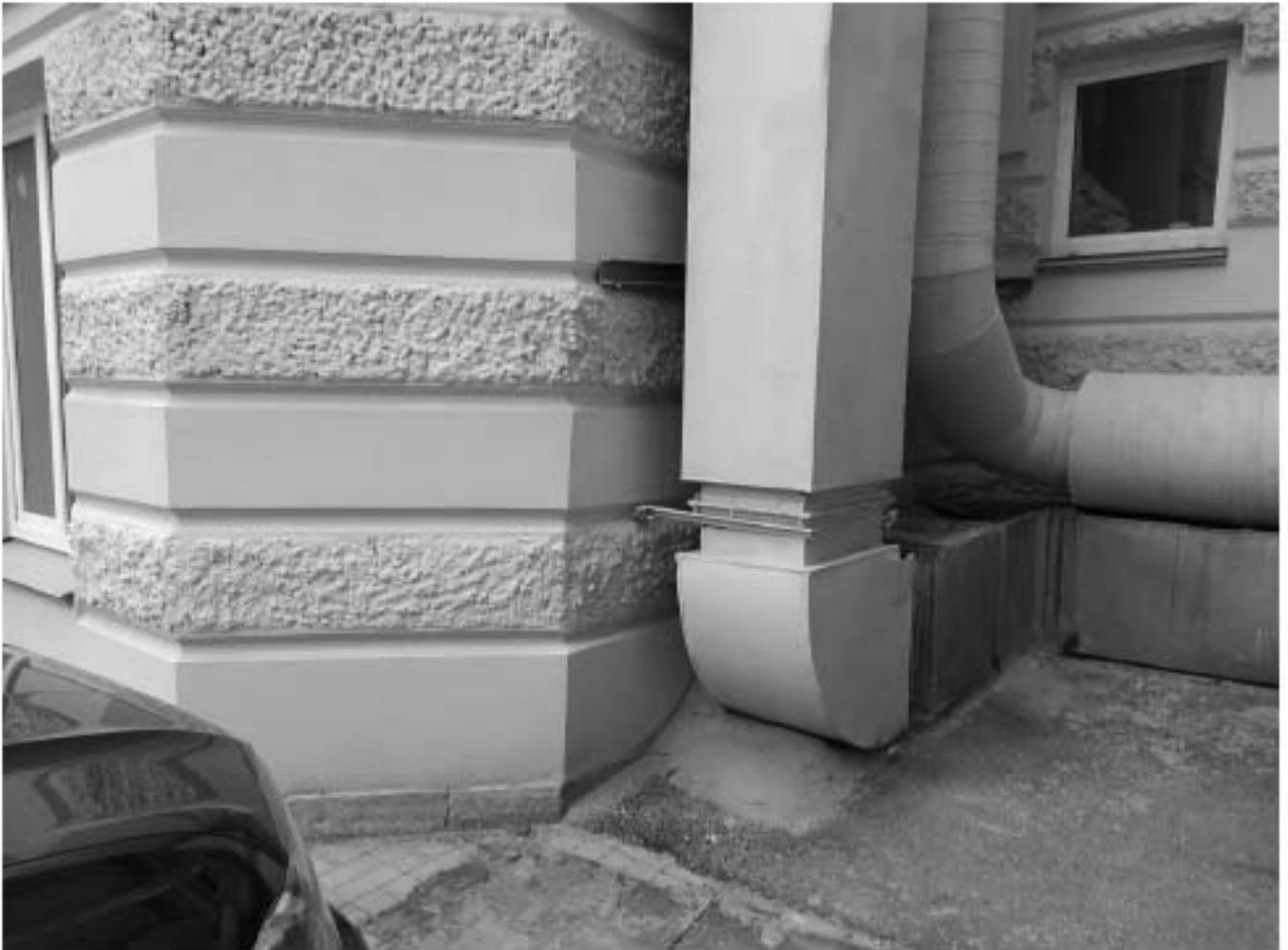
Фото 14. Фрагмент дворовых фасадов дворового флигеля Дома М.Б. Баструевой. Воздуховоды помещения 5-Н. Дата съемки 22.07.2023 г.
