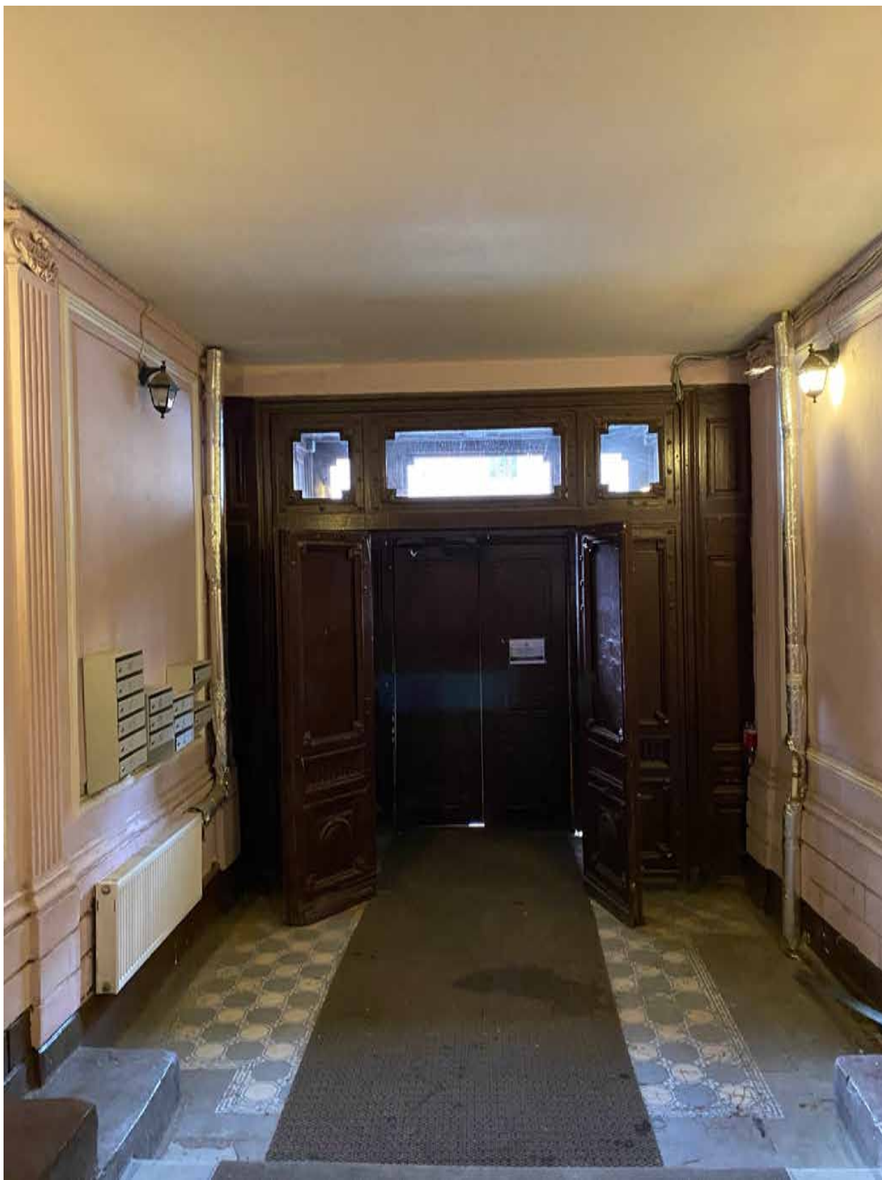
Фото 14. Общий вид вестибюля объекта культурного наследия.
