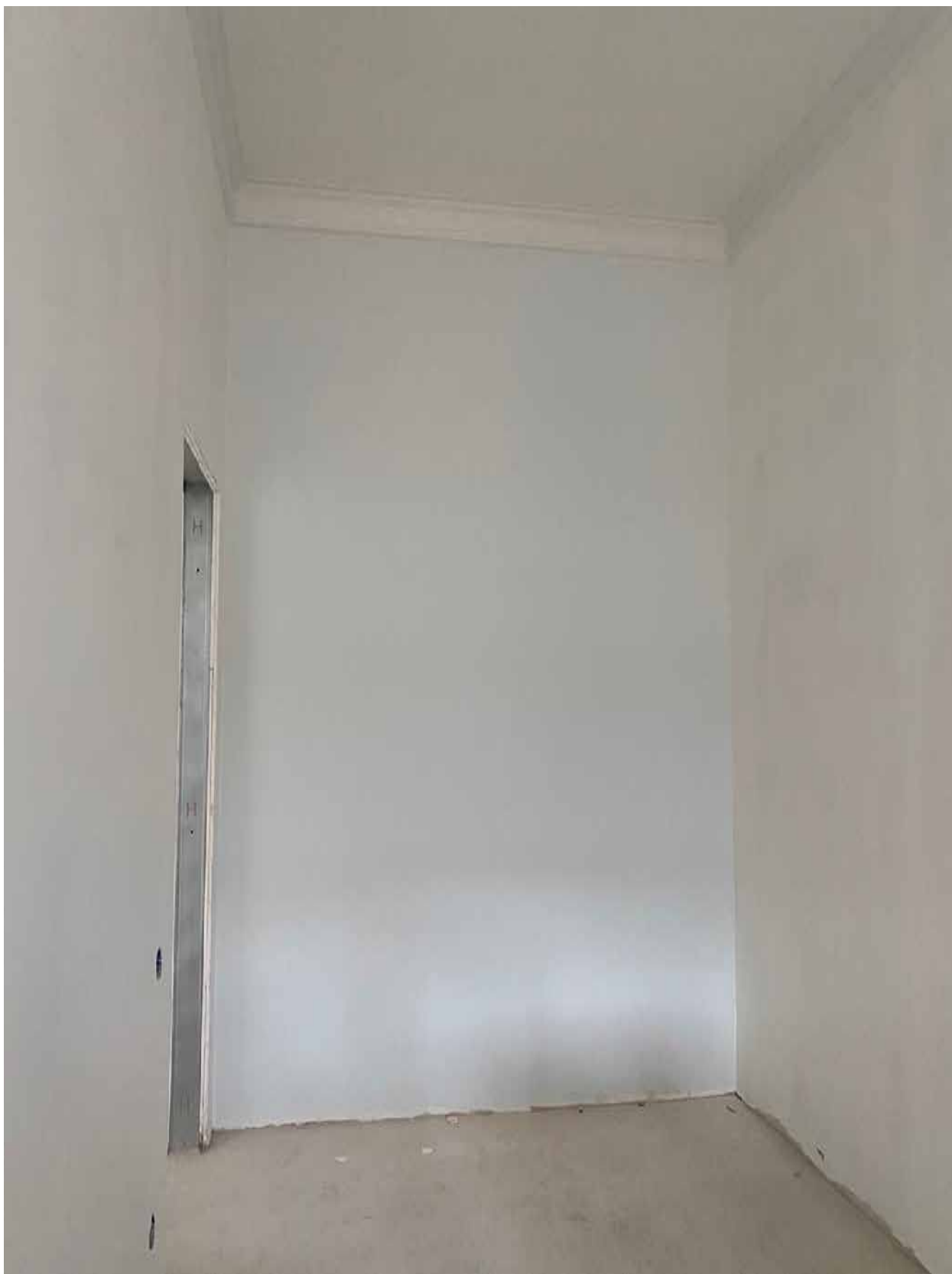
Фото 63. Вид на помещение квартиры № 45 объекта культурного наследия.
