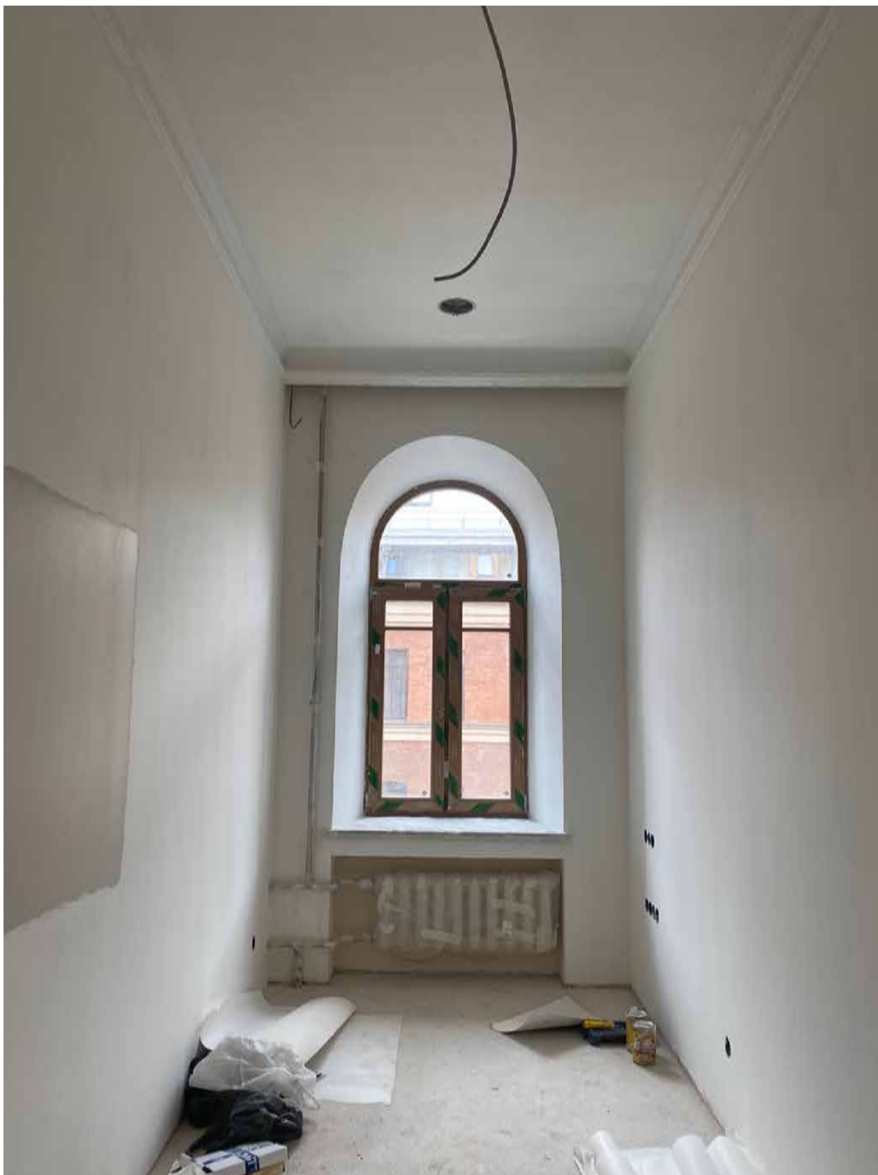
Фото 60. Вид на помещение квартиры № 45 объекта культурного наследия.
