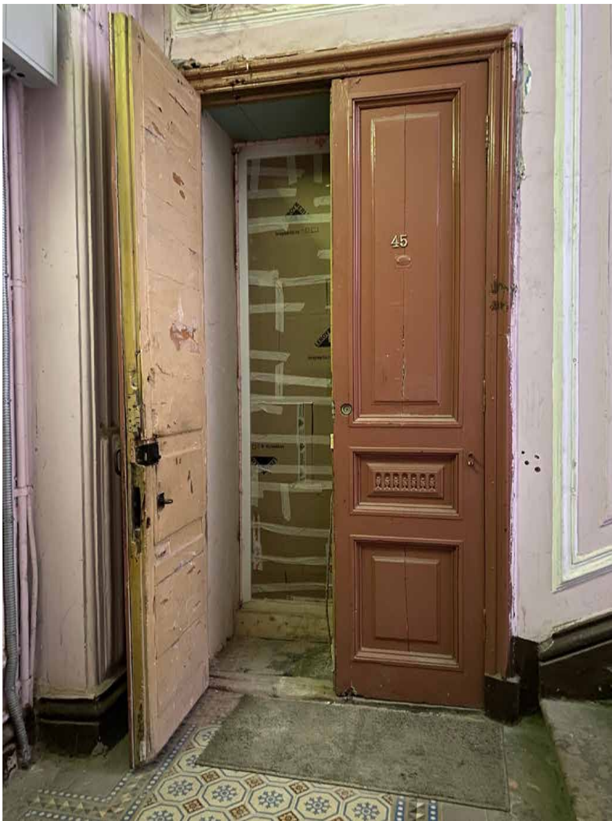
Фото 22. Вид на входное дверное заполнение квартиры № 45 объекта культурного наследия.
