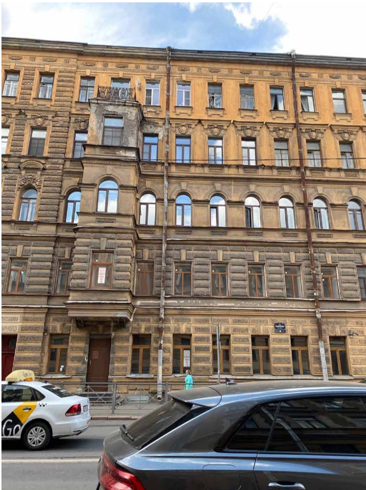
Фото 3. Фрагмент фасада объекта культурного наследия по улице Радищева.
