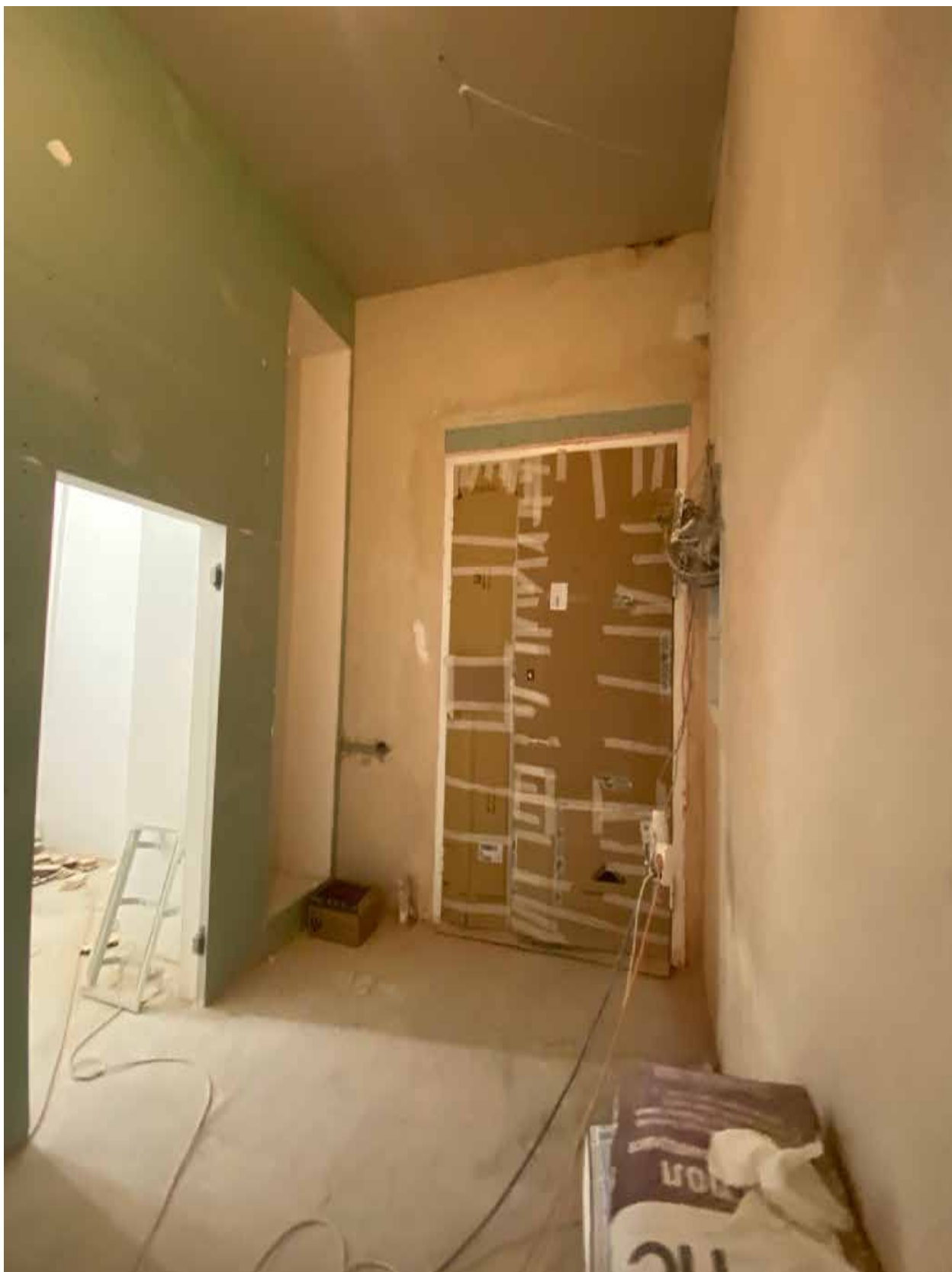
Фото 31. Вид на помещение квартиры № 45 объекта культурного наследия.
