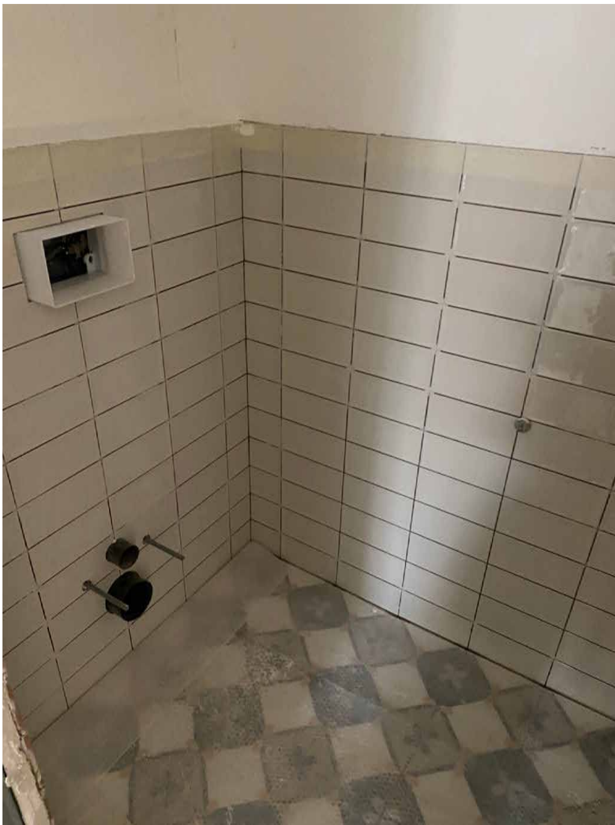
Фото 47. Вид на помещение квартиры № 45 объекта культурного наследия.
