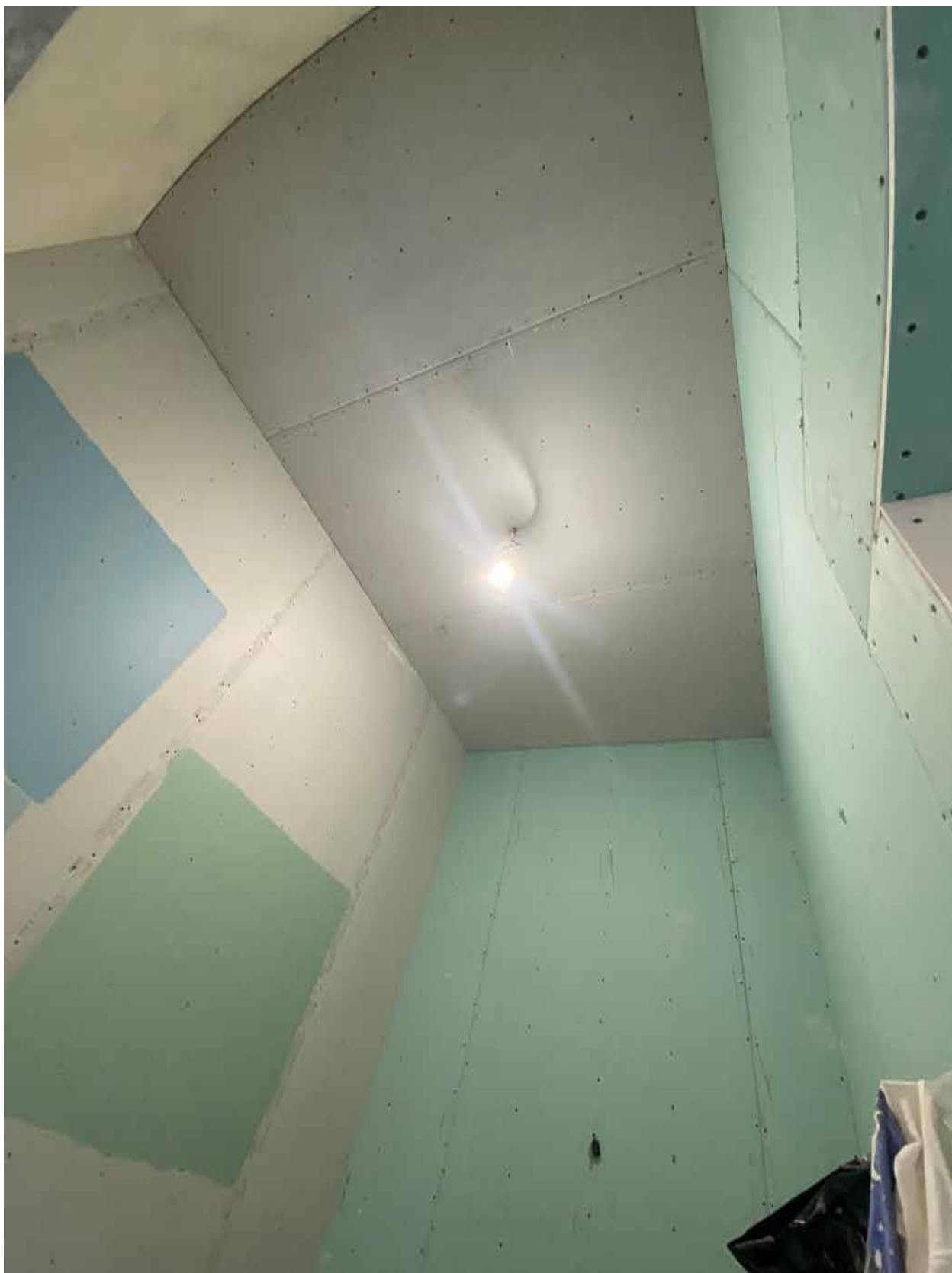
Фото 37. Вид на помещение квартиры № 45 объекта культурного наследия.
