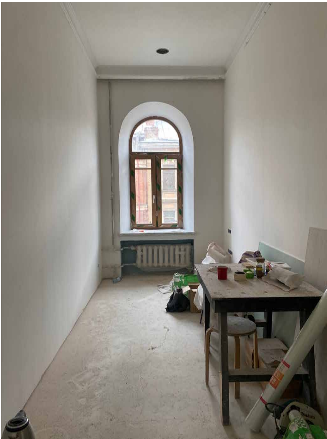
Фото 56. Вид на помещение квартиры № 45 объекта культурного наследия.
