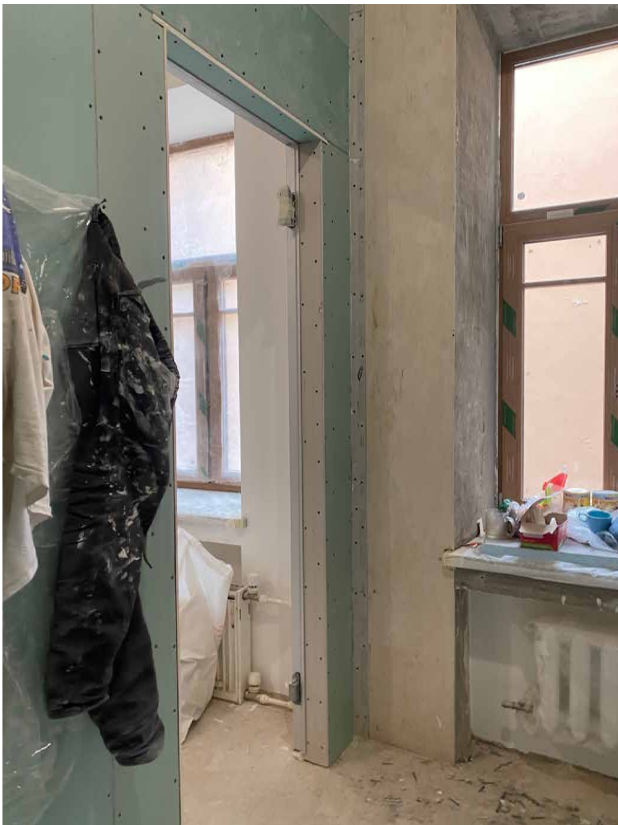
Фото 39. Вид на помещение квартиры № 45 объекта культурного наследия.
