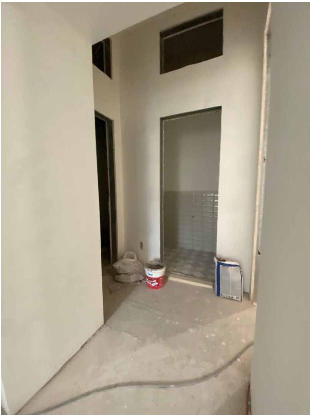
Фото 65. Вид на помещение квартиры № 45 объекта культурного наследия.
