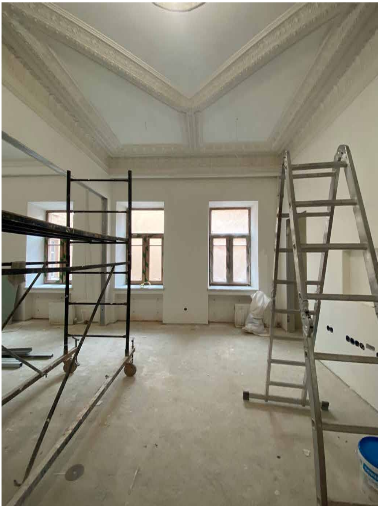
Фото 34. Вид на помещение квартиры № 45 объекта культурного наследия.
