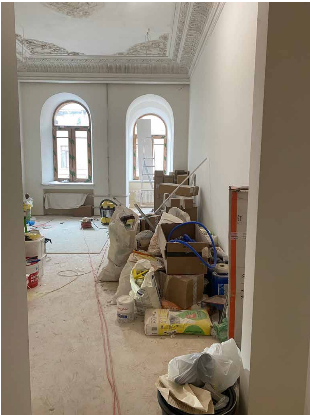
Фото 26. Вид на помещение квартиры № 45 объекта культурного наследия.
