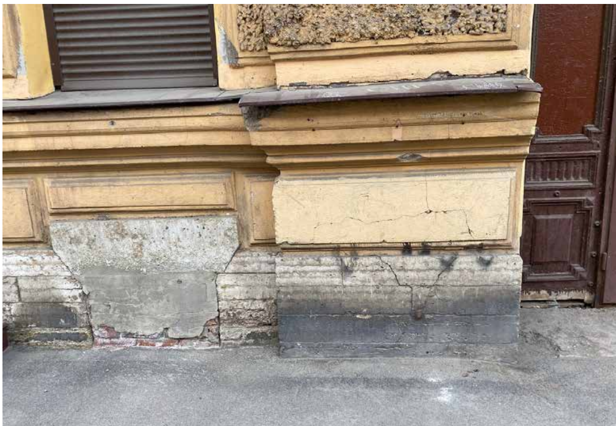
Фото 8. Фрагмент фасада объекта культурного наследия по улице Радищева.
