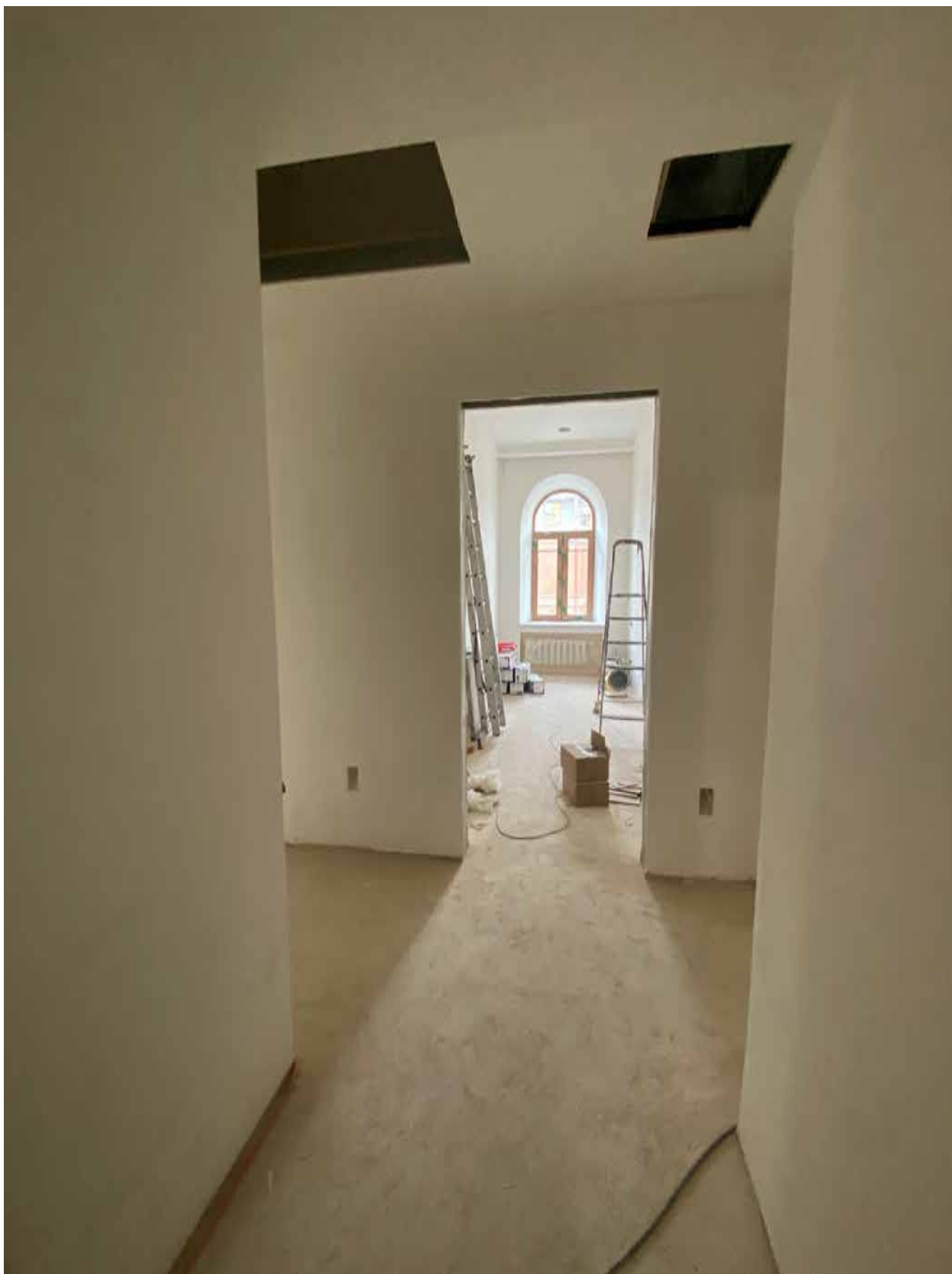
Фото 49. Вид на помещение квартиры № 45 объекта культурного наследия.
