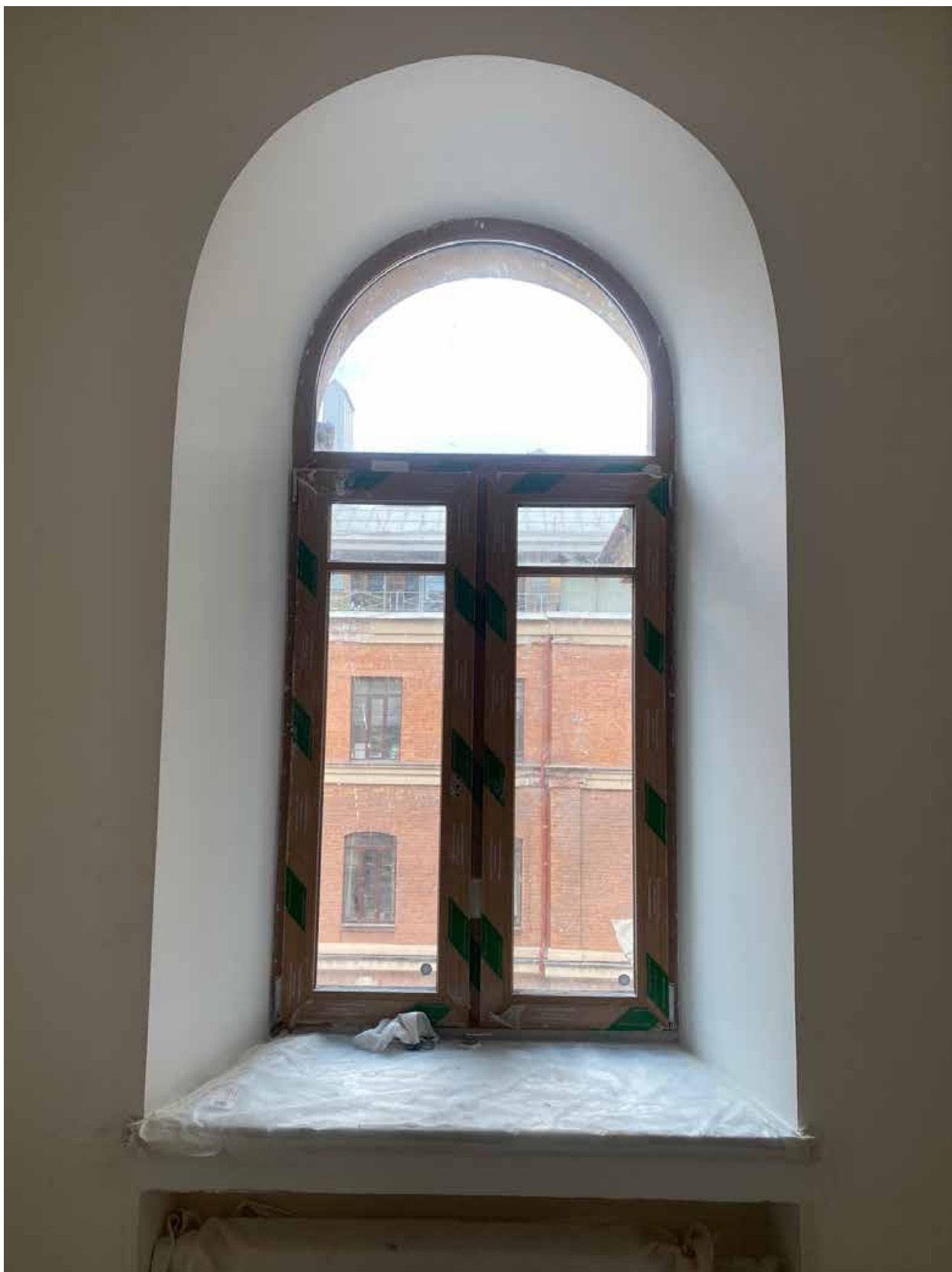
Фото 28. Оконное заполнение помещения квартиры № 45 объекта культурного наследия.
