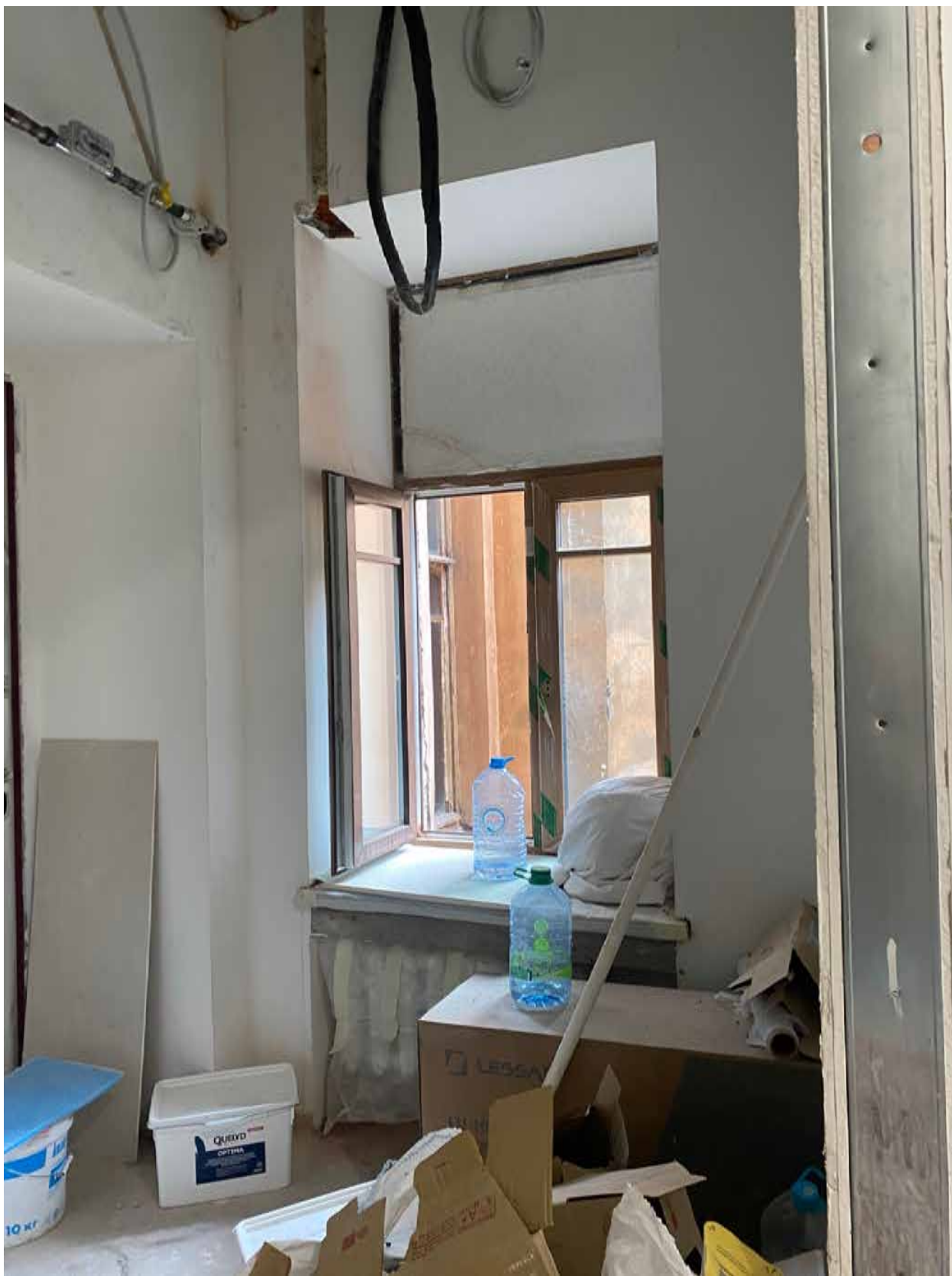
Фото 43. Вид на помещение квартиры № 45 объекта культурного наследия.
