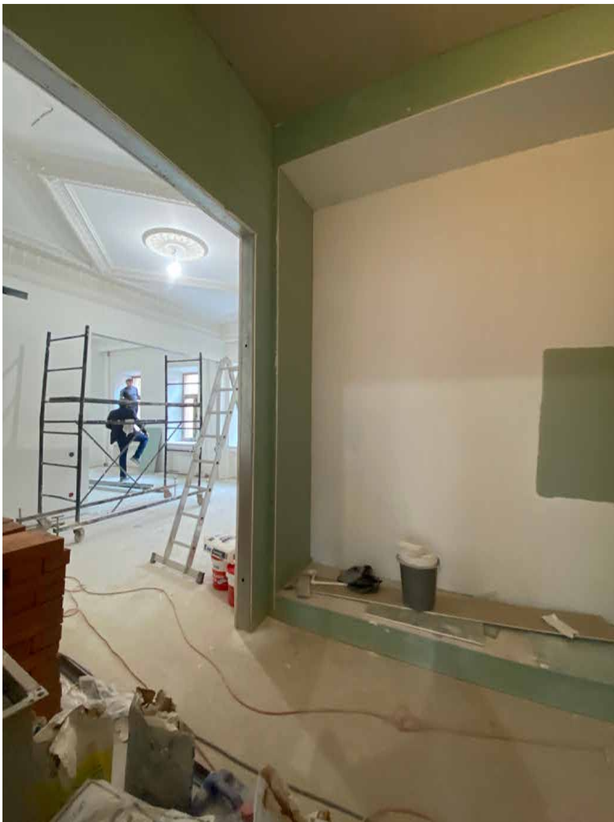
Фото 32. Вид на помещение квартиры № 45 объекта культурного наследия.
