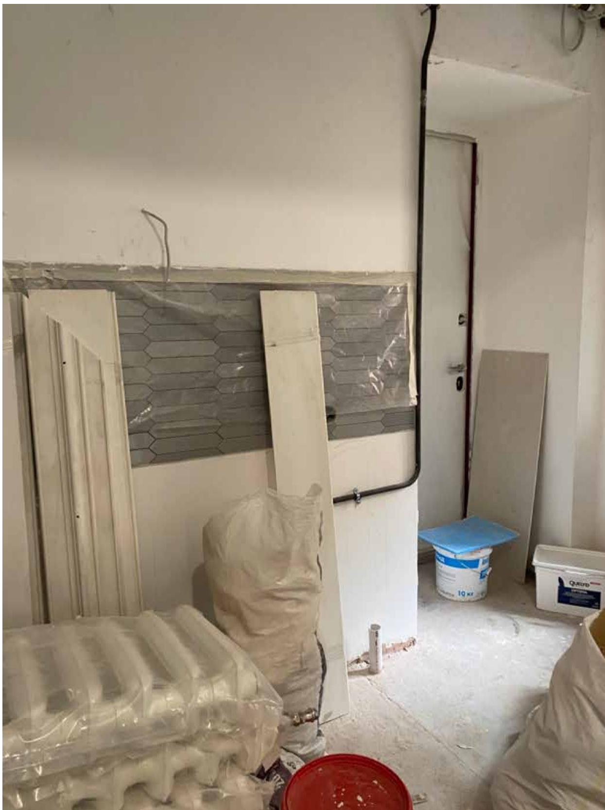
Фото 46. Вид на помещение квартиры № 45 объекта культурного наследия.
