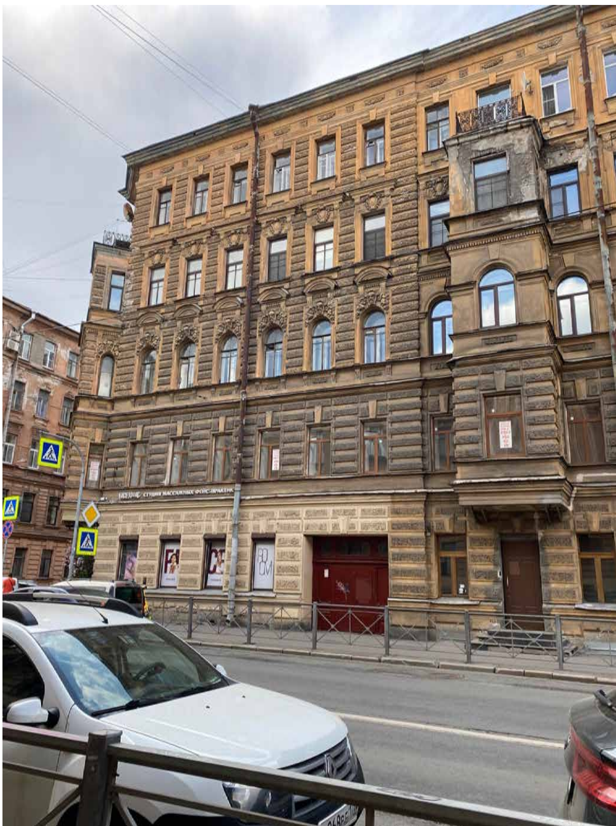
Фото 2. Фрагмент фасада объекта культурного наследия по улице Радищева.
