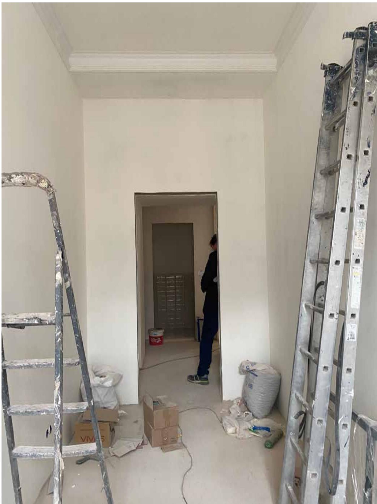
Фото 59. Вид на помещение квартиры № 45 объекта культурного наследия.
