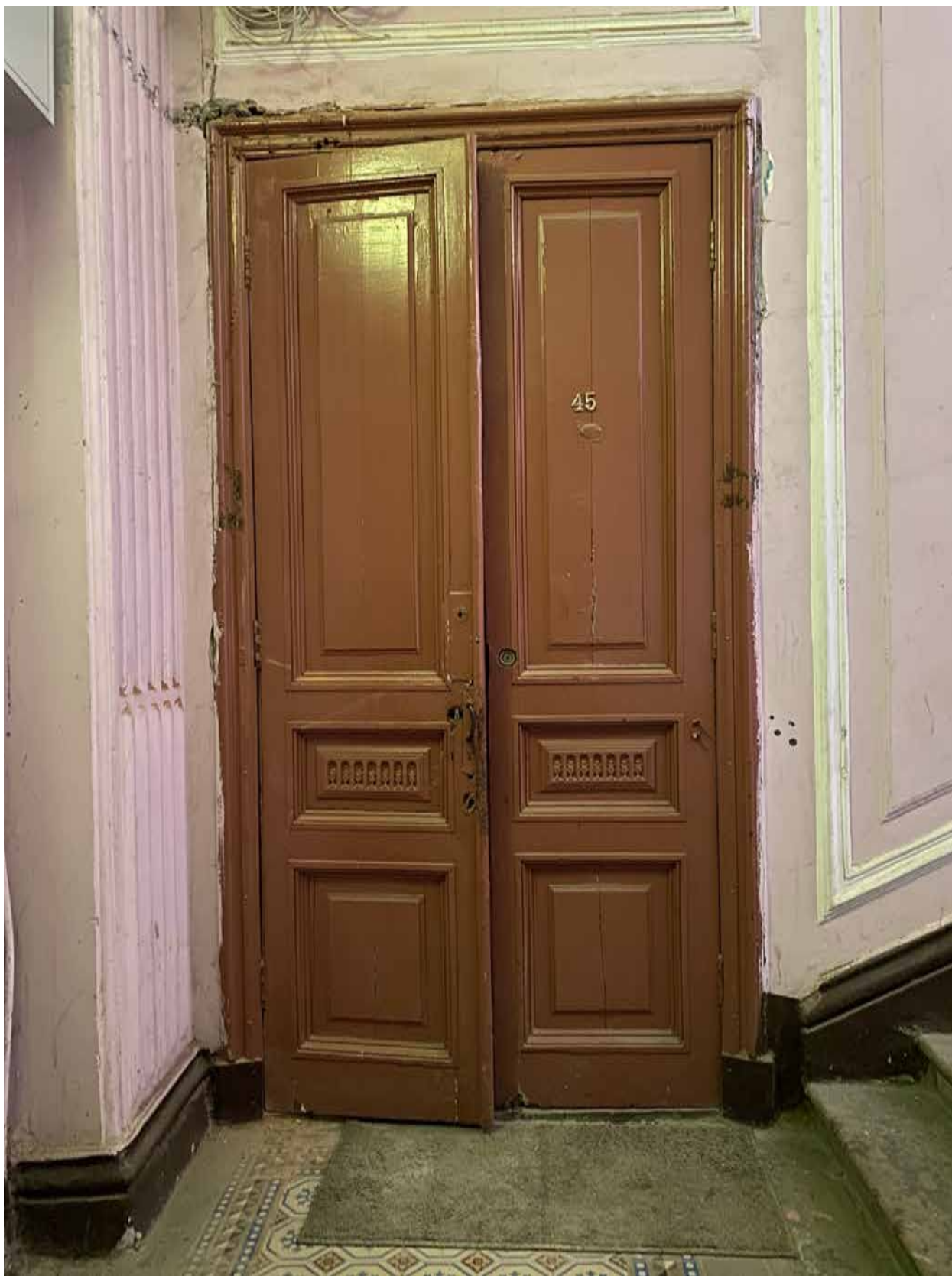
Фото 21. Вид на входное дверное заполнение квартиры № 45 объекта культурного наследия.
