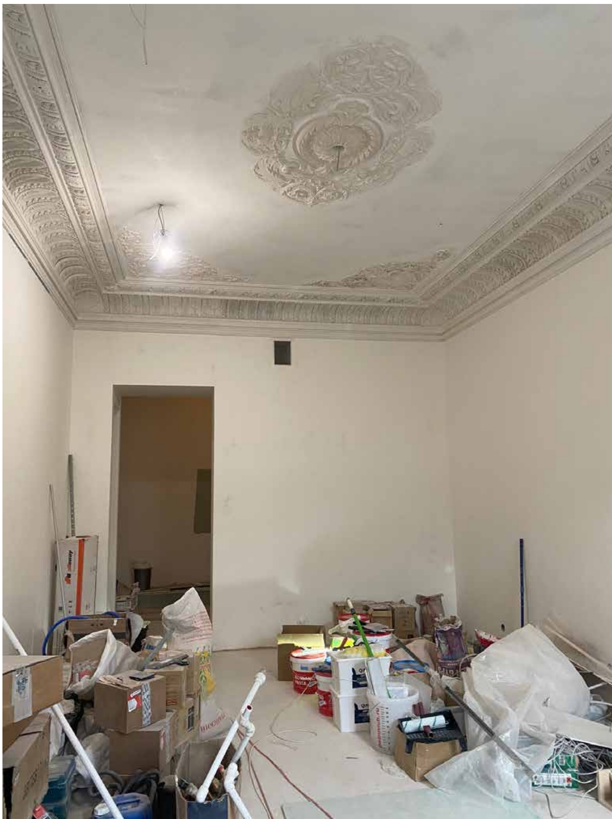
Фото 29. Вид на помещение квартиры № 45 объекта культурного наследия.
