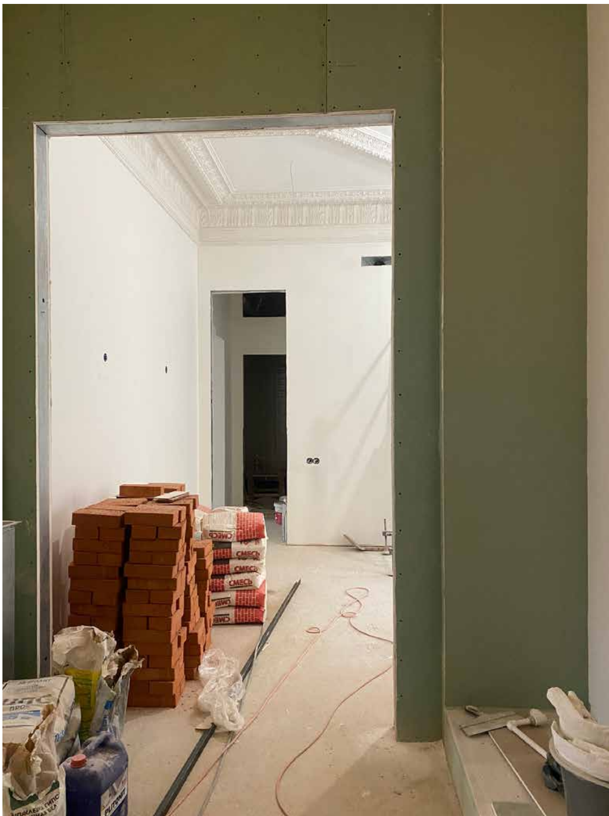
Фото 24. Вид на помещение квартиры № 45 объекта культурного наследия.
