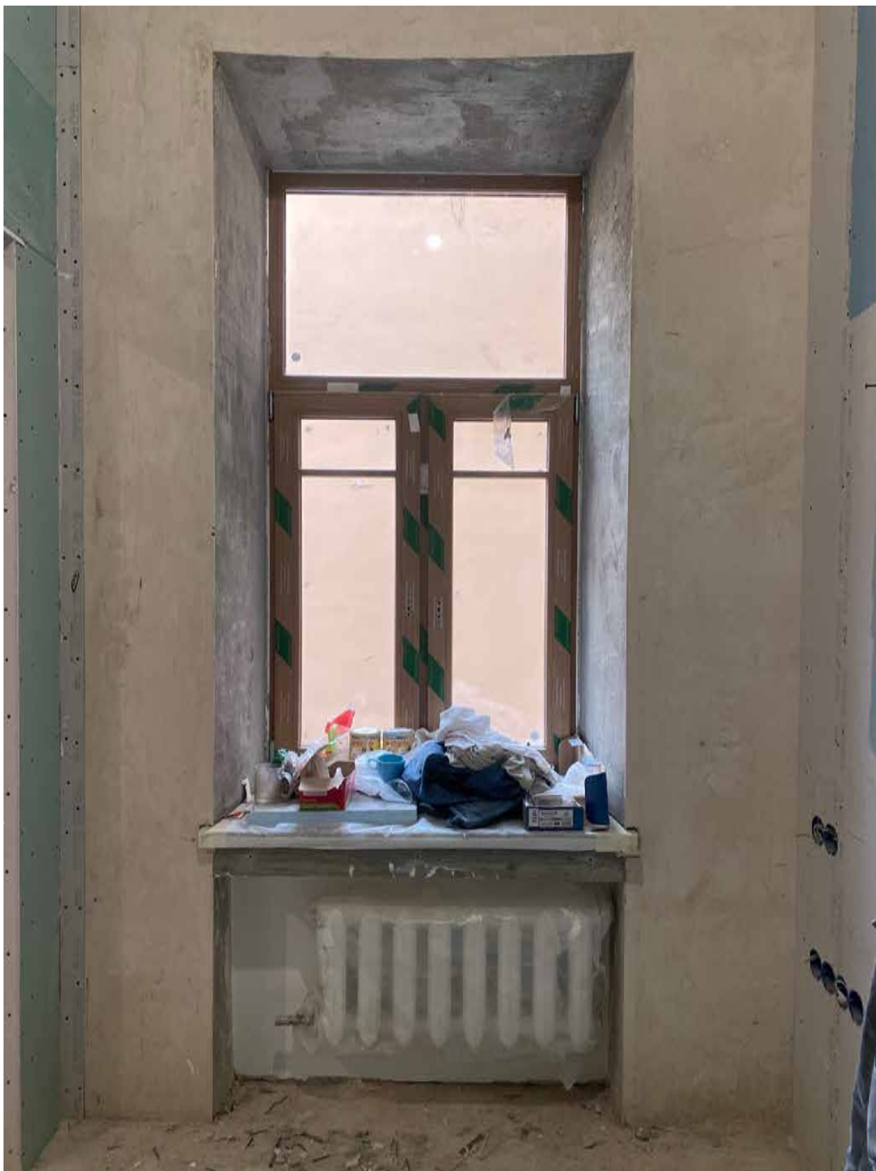
Фото 38. Вид на помещение квартиры № 45 объекта культурного наследия.
