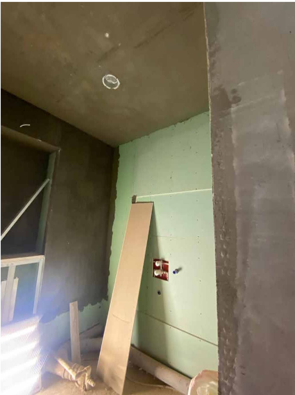
Фото 52. Вид на помещение квартиры № 45 объекта культурного наследия.
