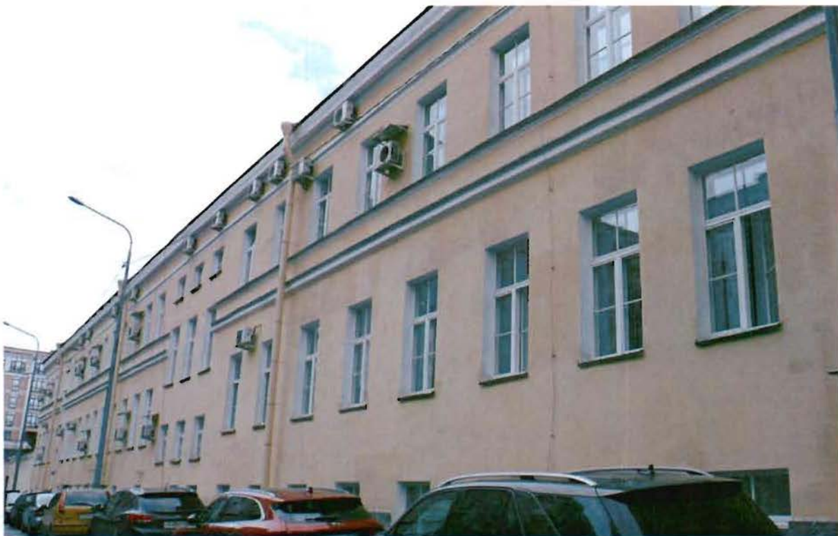
Фото №3. Вид на южный фасад со стороны дворового проезда.
