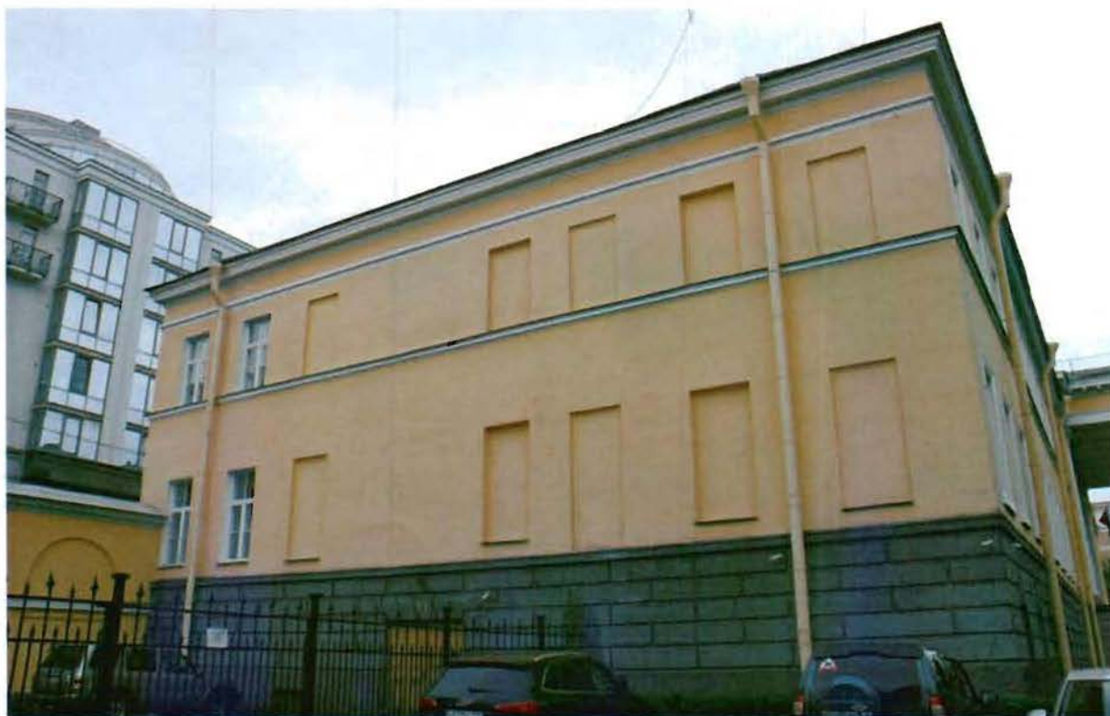
Фото №4. Вид на восточный (торцевой) фасады со стороны сада.
