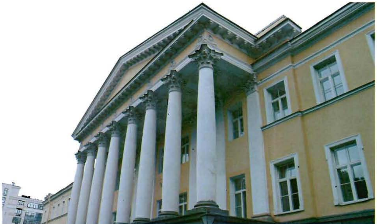
Фото №2. Портик северного (парадного) фасада.
