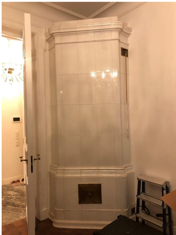
Фото 12. Печь в помещении № 2.
