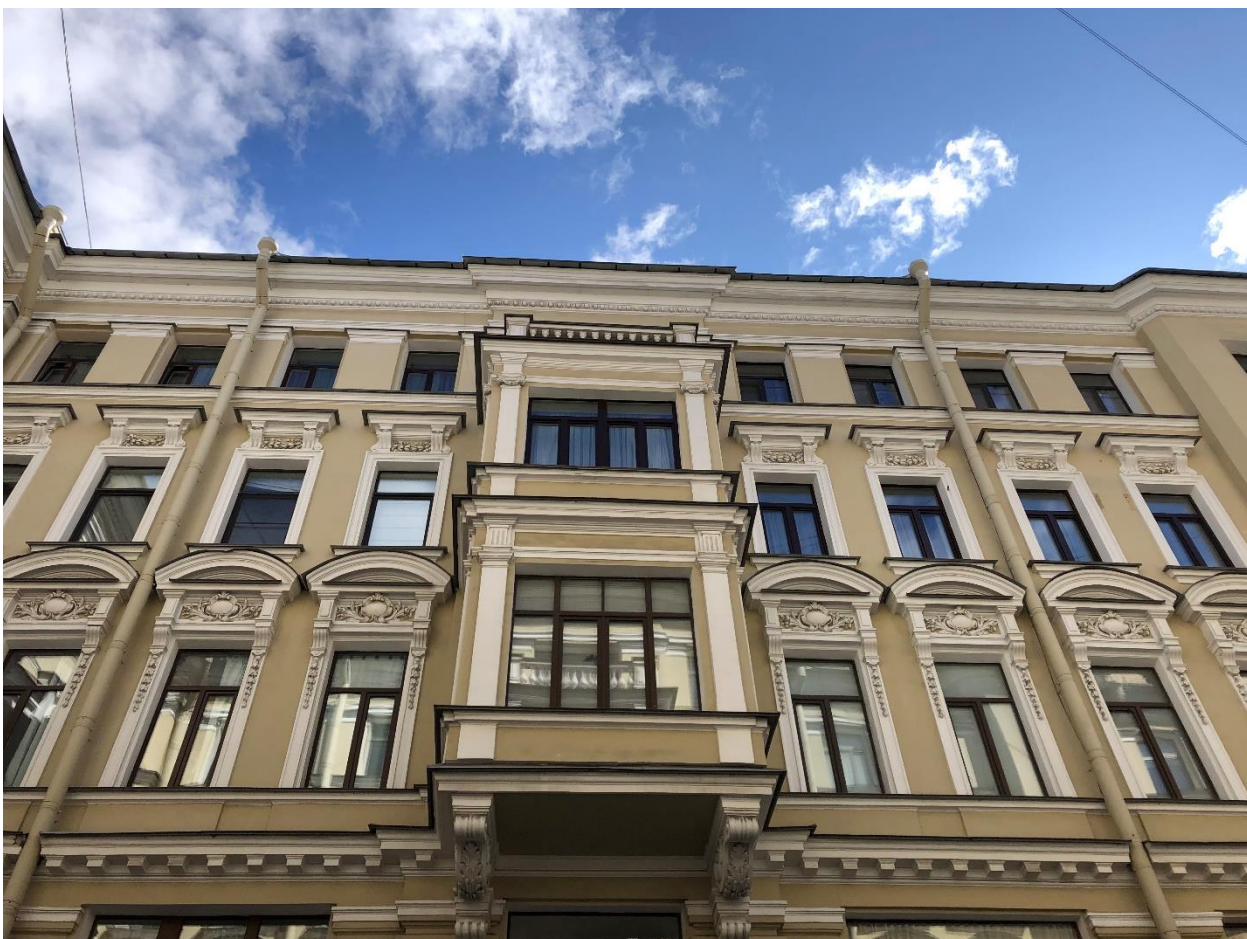
Фото 5. Вид на фрагмент фасада парадного двора.
