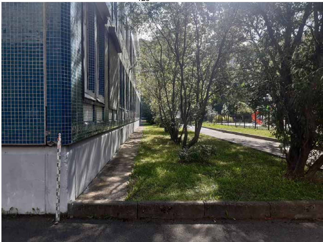
Рис. 78. Санкт-Петербург, «Квартал 61 (ул. Савушкина – Беговая ул. – Школьная ул. – Яхтенная ул.)». Общий вид трассы. Точка съемки 53. Вид на юго-запад.
