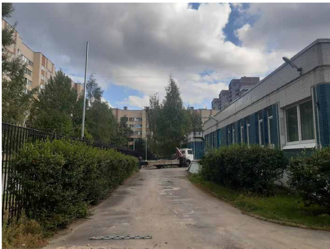
Рис. 21. Санкт-Петербург, «Квартал 61 (ул. Савушкина – Беговая ул. – Школьная ул. – Яхтенная ул.)». Общий вид трассы. Точка съемки 2. Вид на северо-восток.
