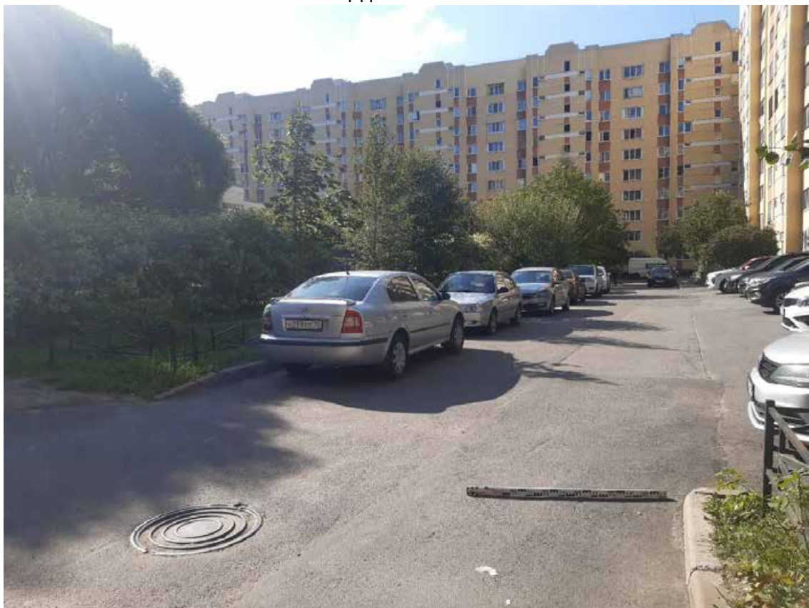
Рис. 102. Санкт-Петербург, «Квартал 61 (ул. Савушкина – Беговая ул. – Школьная ул. – Яхтенная ул.)». Общий вид трассы. Точка съемки 73. Вид на юго-запад.
