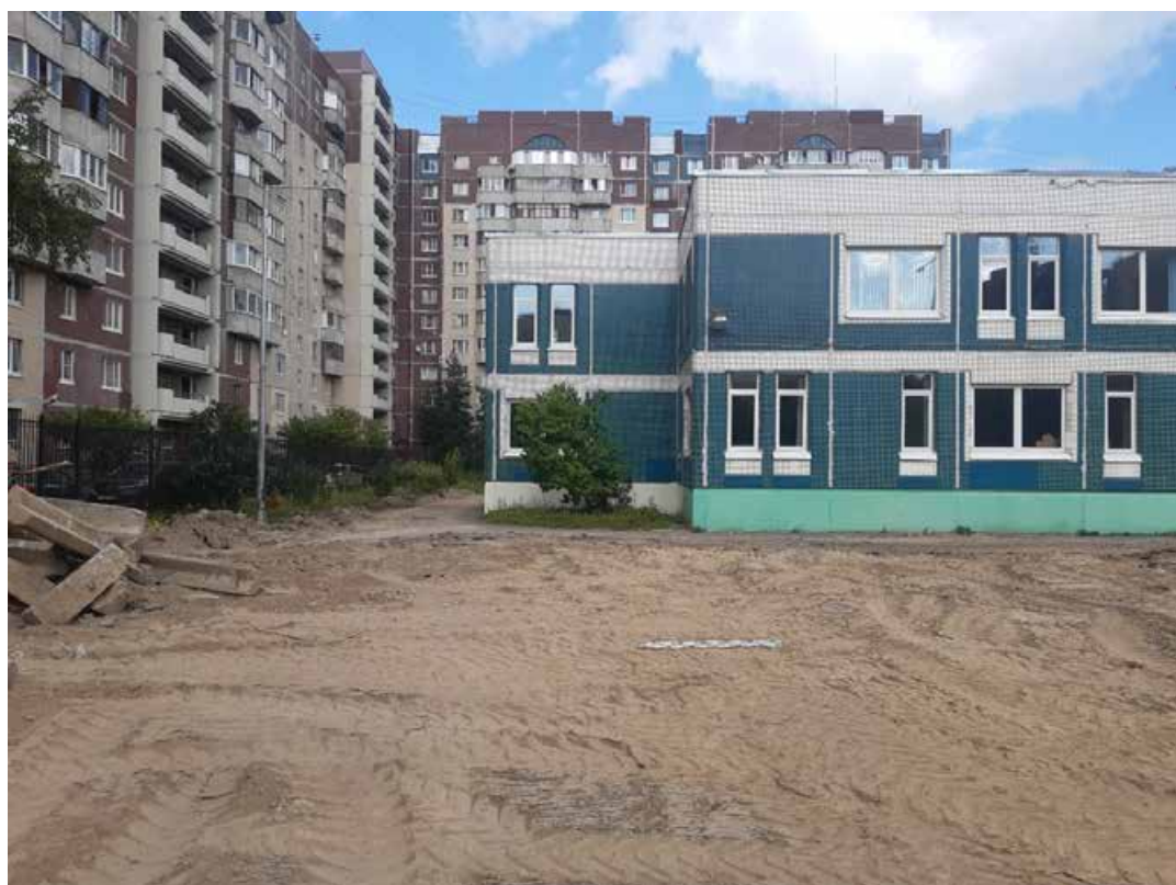
Рис. 164. Санкт-Петербург, «Квартал 61 (ул. Савушкина – Беговая ул. – Школьная ул. – Яхтенная ул.)». Шурф 4. Фотофиксация после рекультивации. Вид на север.
