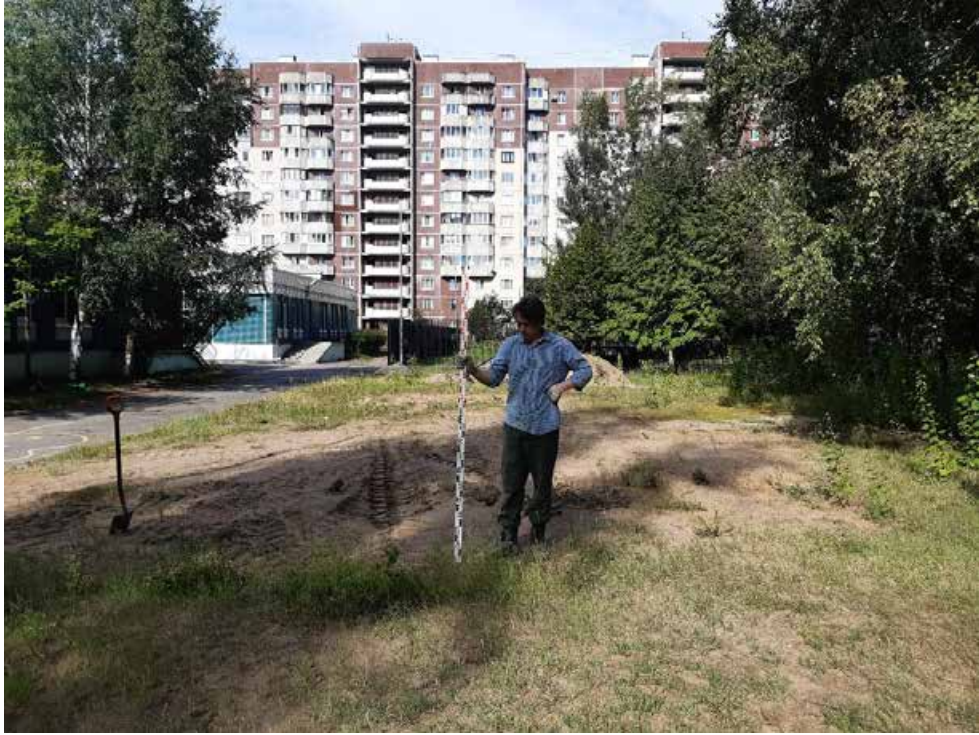
Рис. 128. Санкт-Петербург, «Квартал 61 (ул. Савушкина – Беговая ул. – Школьная ул. – Яхтенная ул.)». Шурф 2. Общий вид до начала работ. Вид на запад.
