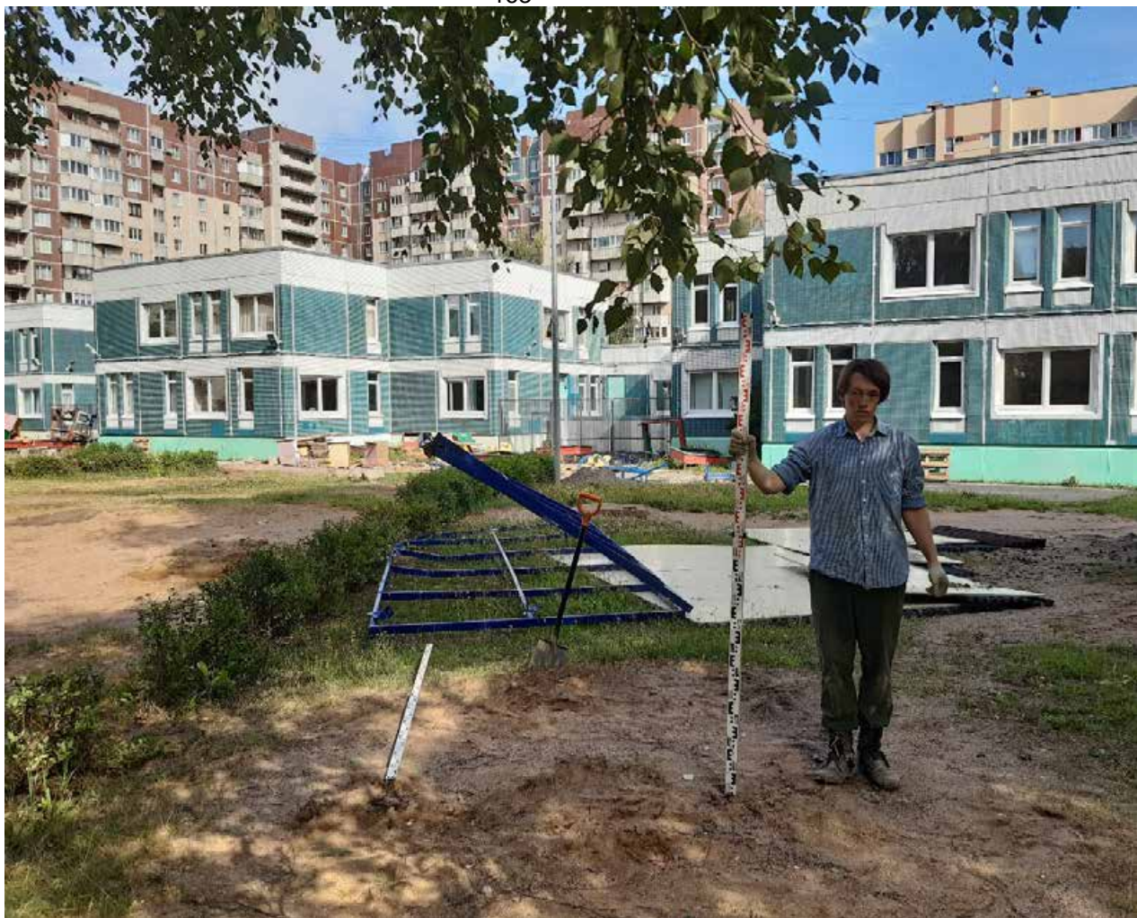
Рис. 140. Санкт-Петербург, «Квартал 61 (ул. Савушкина – Беговая ул. – Школьная ул. – Яхтенная ул.)». Шурф 3. Общий вид до начала работ. Вид на север.
