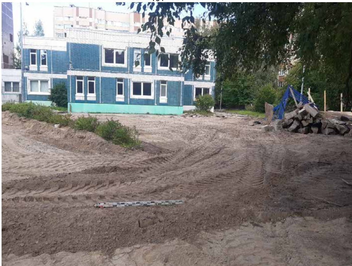
Рис. 22. Санкт-Петербург, «Квартал 61 (ул. Савушкина – Беговая ул. – Школьная ул. – Яхтенная ул.)». Общий вид трассы. Точка съемки 3. Вид на северо-восток.
