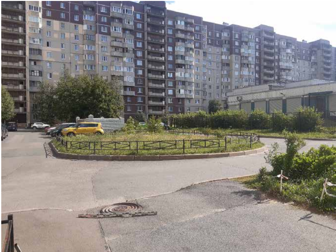
Рис. 41. Санкт-Петербург, «Квартал 61 (ул. Савушкина – Беговая ул. – Школьная ул. – Яхтенная ул.)». Общий вид трассы. Точка съемки 19. Вид на юго-восток.
