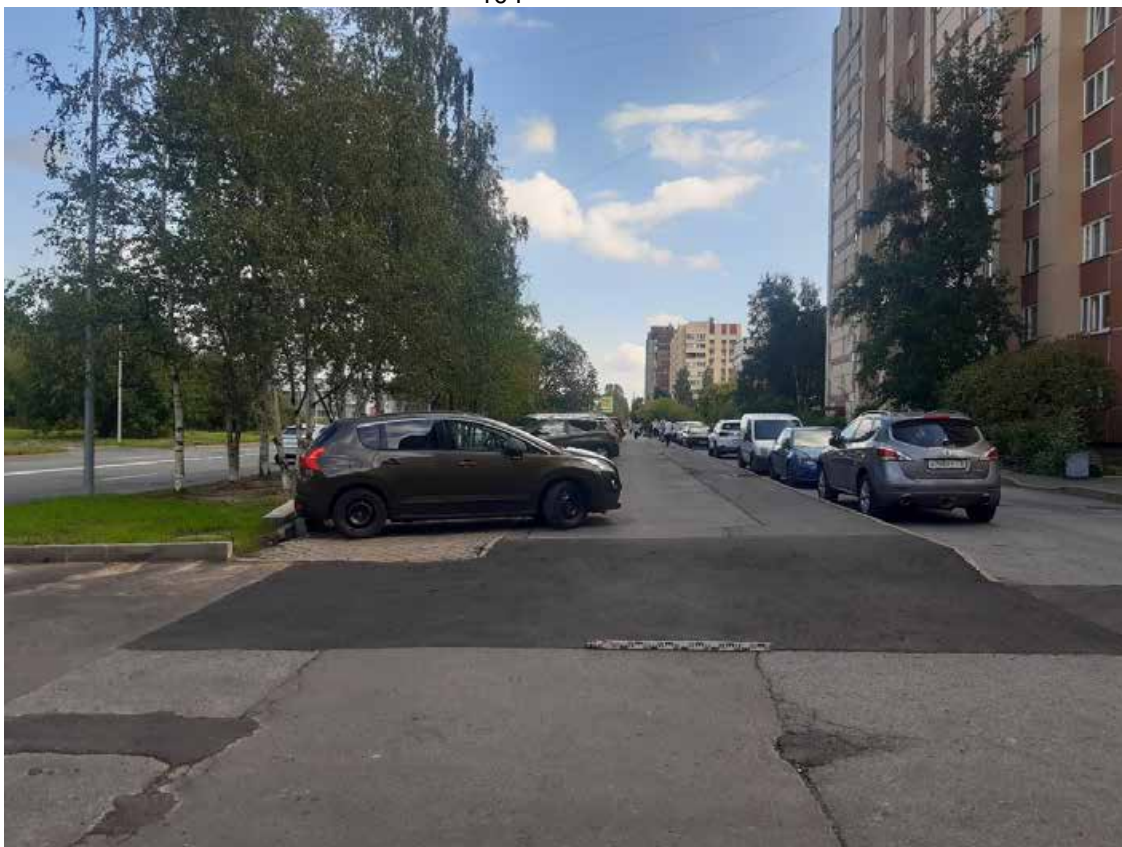
Рис. 28. Санкт-Петербург, «Квартал 61 (ул. Савушкина – Беговая ул. – Школьная ул. – Яхтенная ул.)». Общий вид трассы. Точка съемки 9. Вид на северо-восток.
