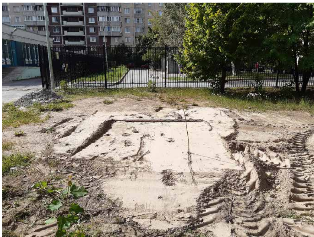
Рис. 127. Санкт-Петербург, «Квартал 61 (ул. Савушкина – Беговая ул. – Школьная ул. – Яхтенная ул.)». Фотофиксация после рекультивации вид на запад.
