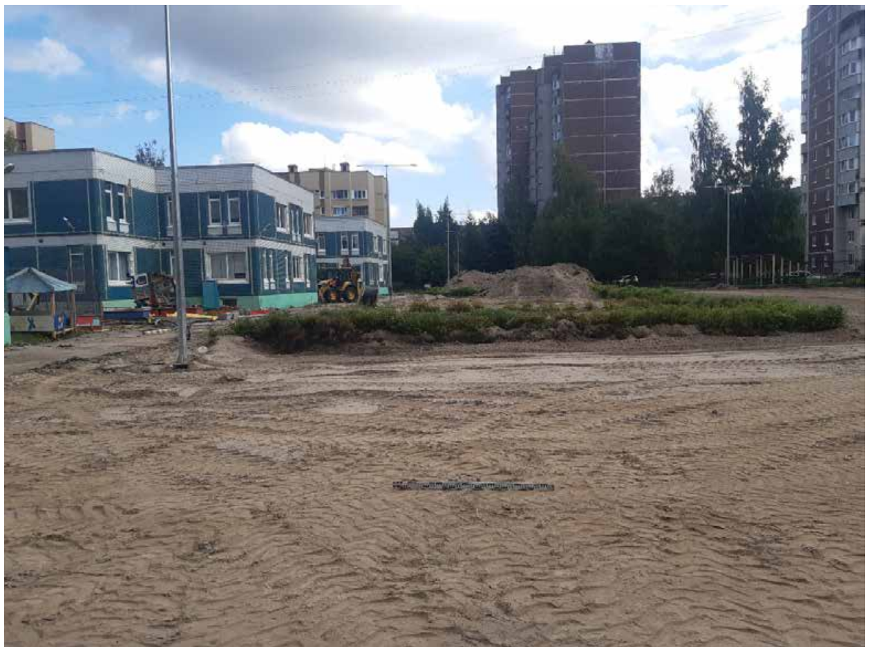
Рис. 19. Санкт-Петербург, «Квартал 61 (ул. Савушкина – Беговая ул. – Школьная ул. – Яхтенная ул.)». Общий вид трассы. Точка съемки 1. Вид на восток.
