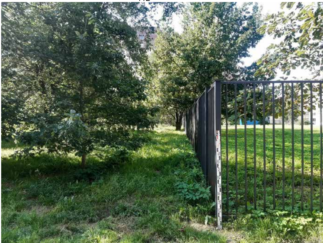
Рис. 44. Санкт-Петербург, «Квартал 61 (ул. Савушкина – Беговая ул. – Школьная ул. – Яхтенная ул.)». Общий вид трассы. Точка съемки 22. Вид на запад.
