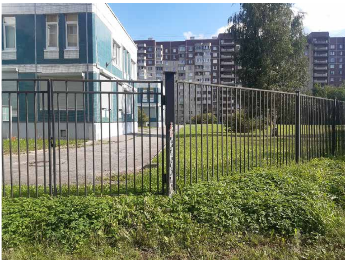
Рис. 37. Санкт-Петербург, «Квартал 61 (ул. Савушкина – Беговая ул. – Школьная ул. – Яхтенная ул.)». Общий вид трассы. Точка съемки 16. Вид на юго-восток.
