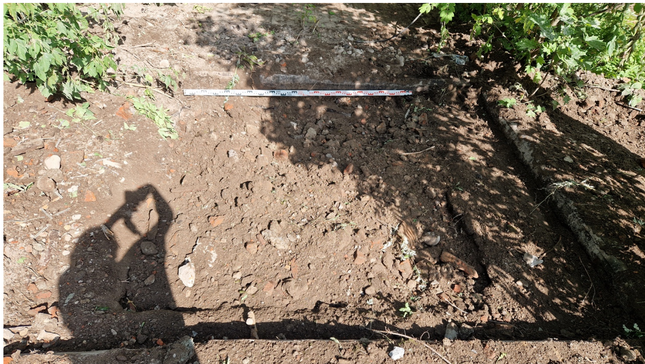
Рис.38. СПб., Василеостровский р-н., ул. Железноводская. Шурф №1. Фиксация поверхности шурфа после рекультивации. Вид на северо-восток.
