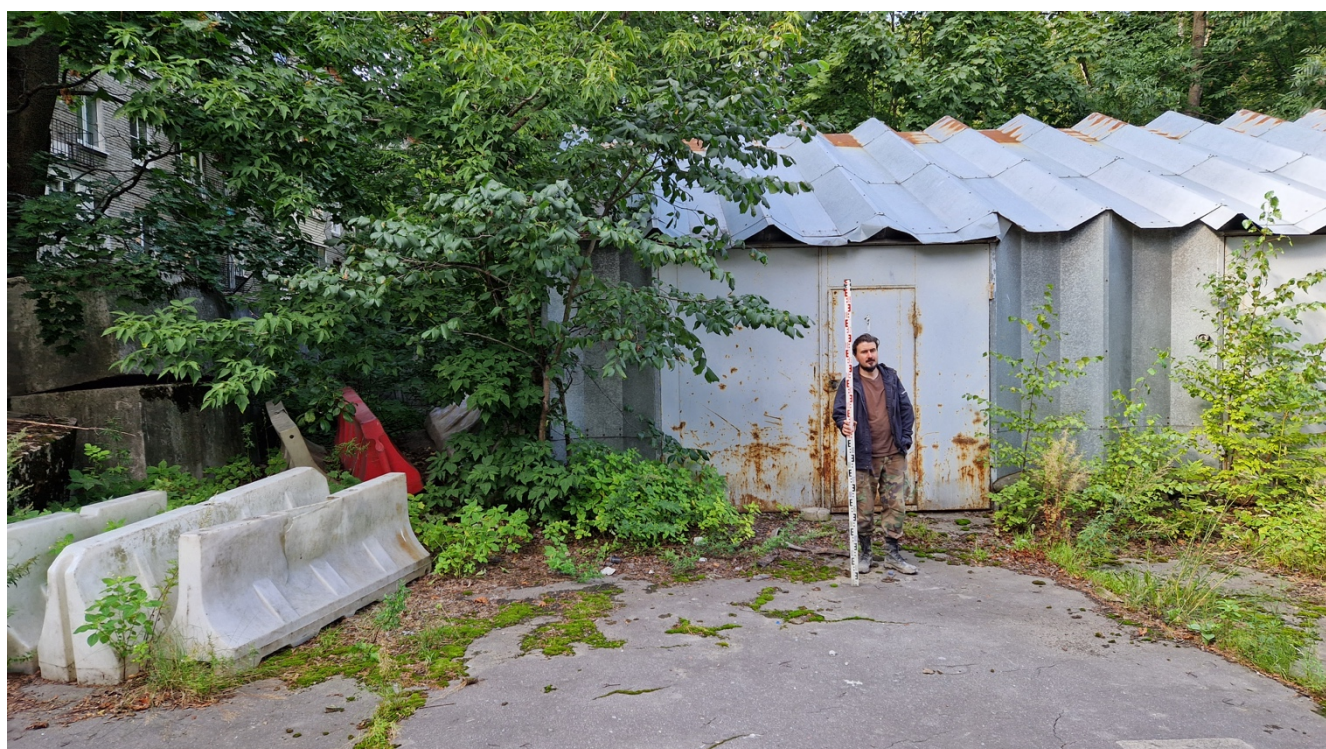
Рис.21. СПб., Василеостровский р-н., ул. Железноводская. Точка съёмки №2. Вид на северо-запад.
