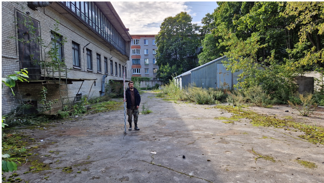
Рис.18. СПб., Василеостровский р-н., ул. Железноводская. Точка съёмки №1. Вид на юго-запад.
