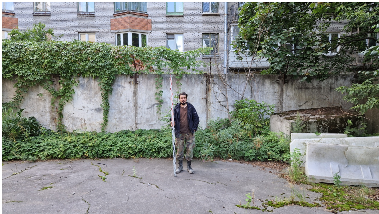
Рис.22. СПб., Василеостровский р-н., ул. Железноводская. Точка съёмки №2. Вид на юго-запад.
