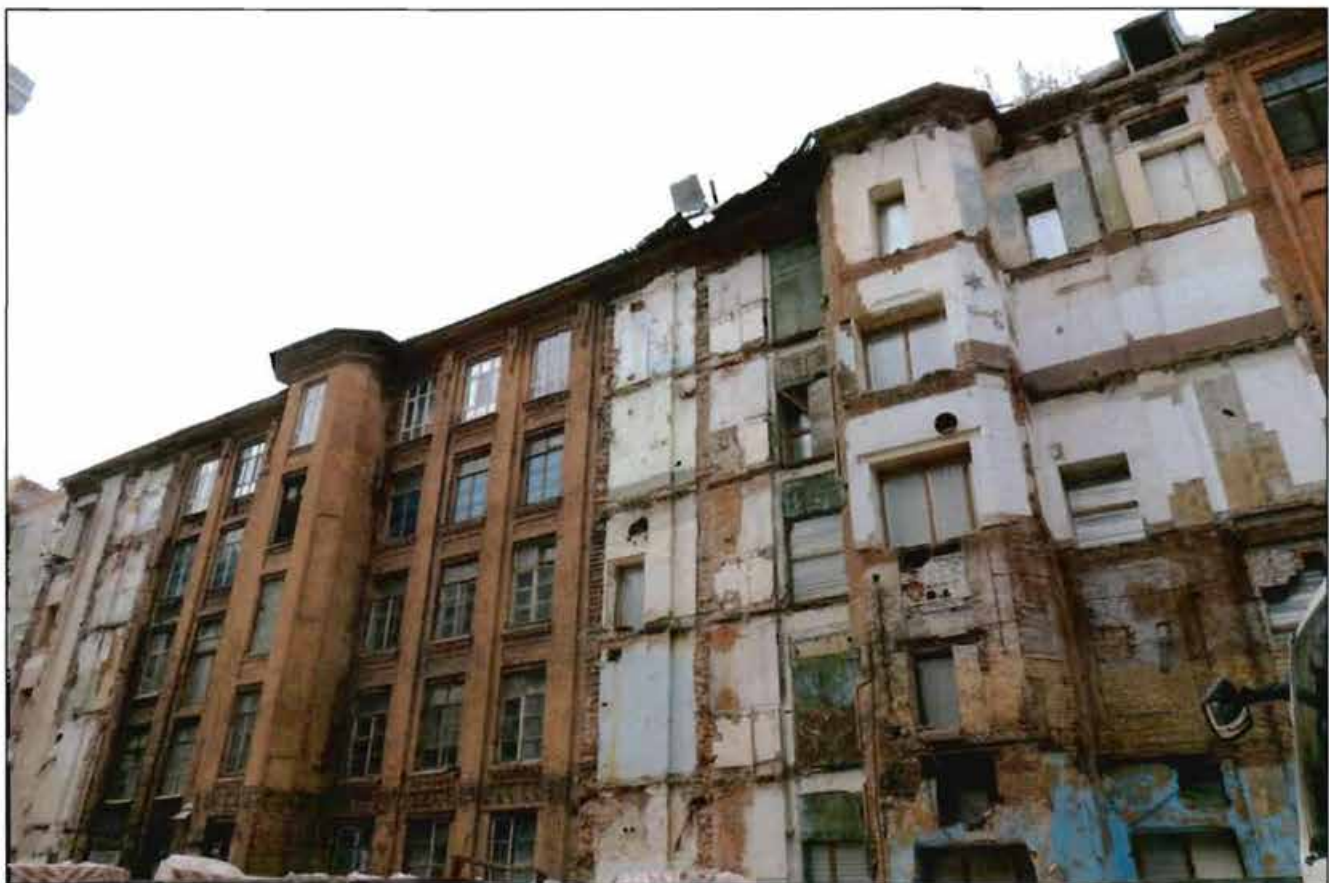
2. Общий вид дворового фасада объекта культурного наследия с севера-востока.
