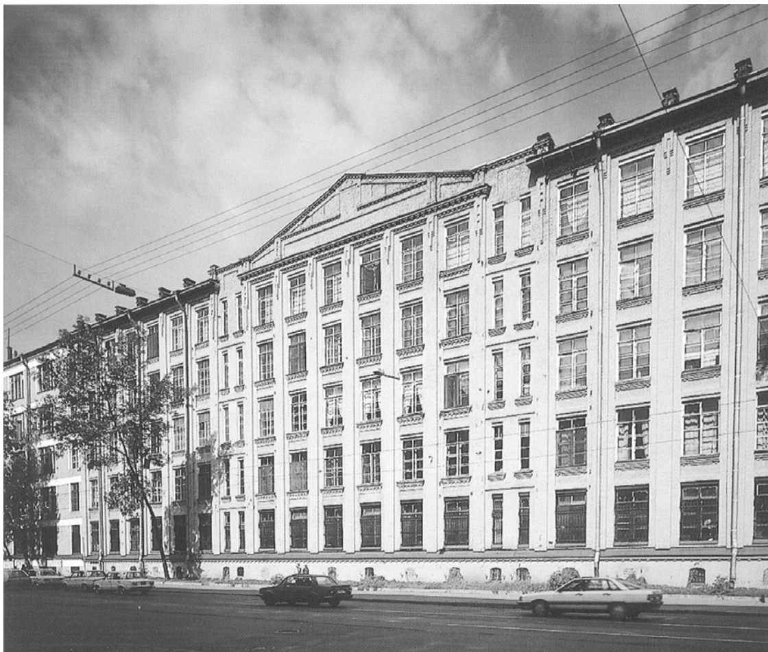
30. Лицевой фасад исторического здания фабрики. 1980-е гг.
