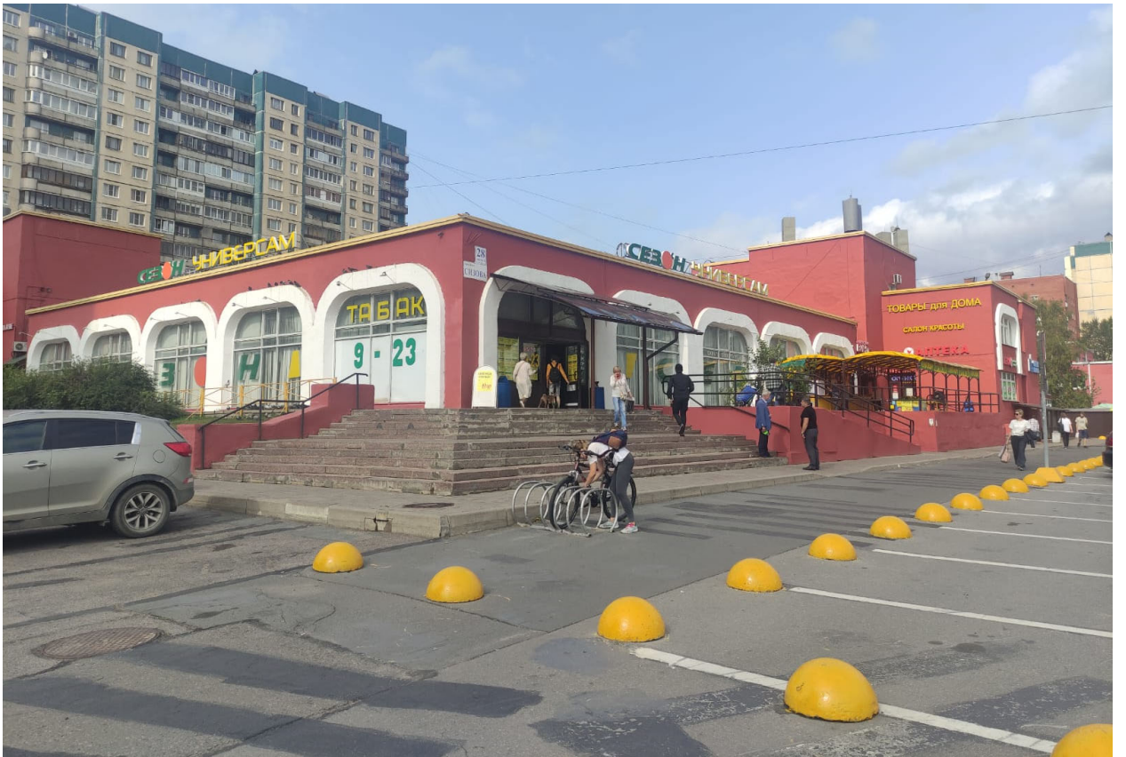
Илл. 4. Санкт-Петербург, участок обследования. Точка фотофиксации Ф1. Общий вид с юго-востока. 01.09.23.
