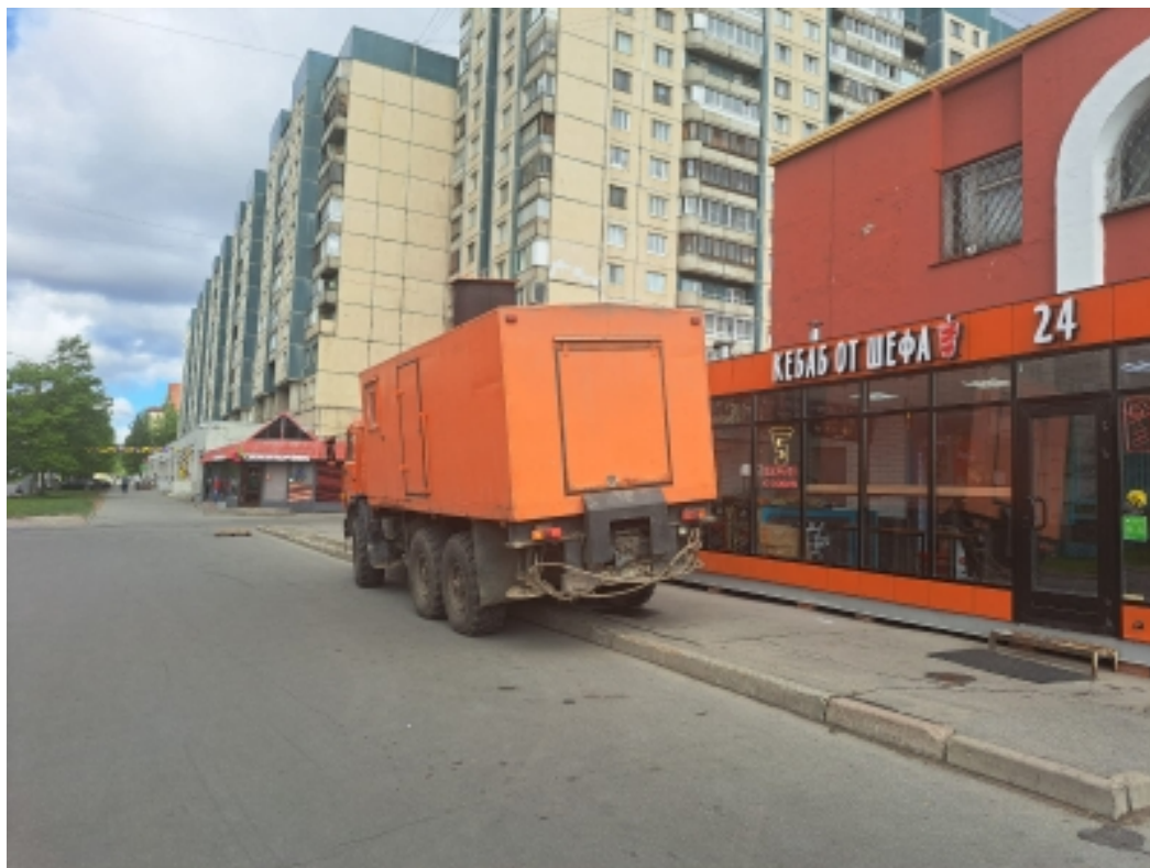
Рисунок 3.2 – Бурение скважин на участке изысканий (фотоматериалы)
