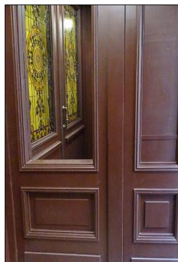
деревянные полусветлые многостворчатые дверные заполнения с полихромными витражами растительно-геометрического рисунка в верхней части и филенчатой глухой нижней частью;
