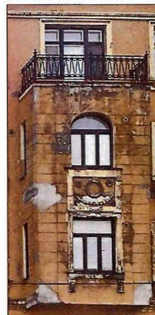
балкон в пять световых осей, на четырех гранитных кронштейнах, с закругленными углами, с гранитным стилизованным балюстрадным ограждением с глухой центральной частью, декорированной воллютообразными завитками (по лицевой стороне), с металлическими секциями из вертикальных стоек, горизонтальных тяг, пальметт, венков и розеток в боковых частях;
