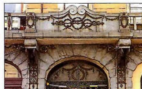
металлодекор балкона – накладные литые тирсы, провисающие гирлянды, ленты и растительные завитки (в части гранитного ограждения и под балконной плитой), четыре кованых с литыми деталями (пальметты, цветочные розетки, растительные элементы) кронштейна черного металла, поддерживающих гранитные кронштейны;
