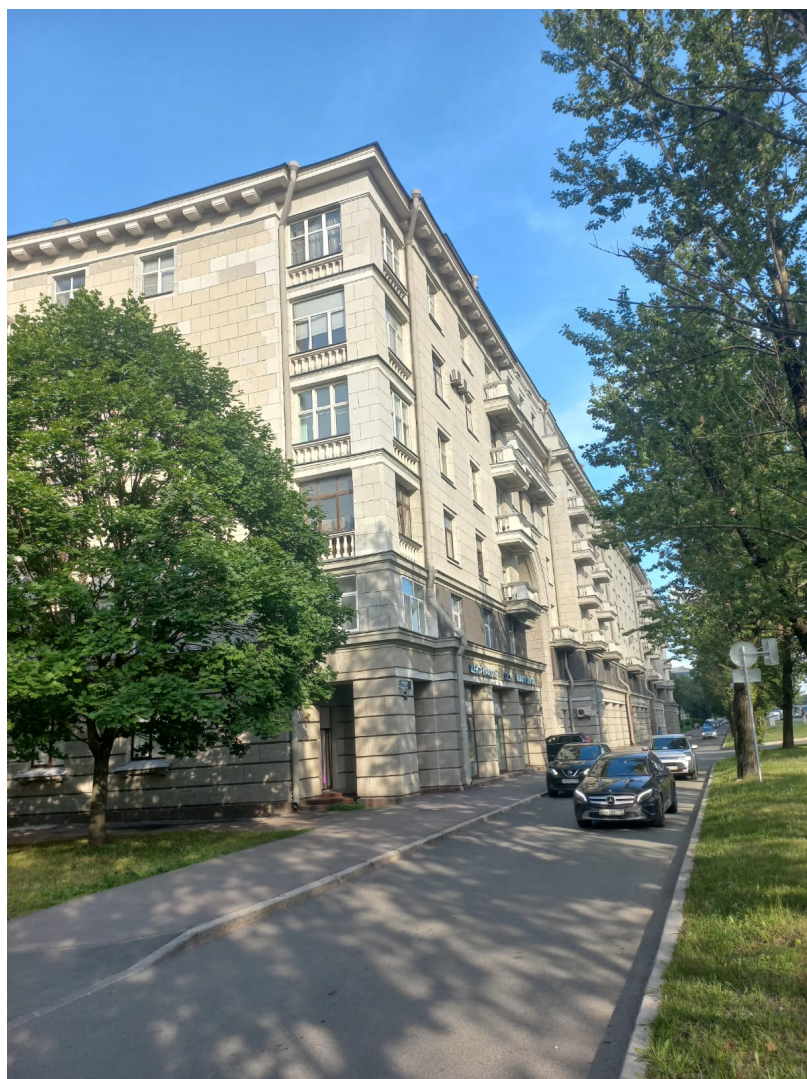
14. Общий вид фасада дома 16, корп. 1, литера А вдоль Московского шоссе
