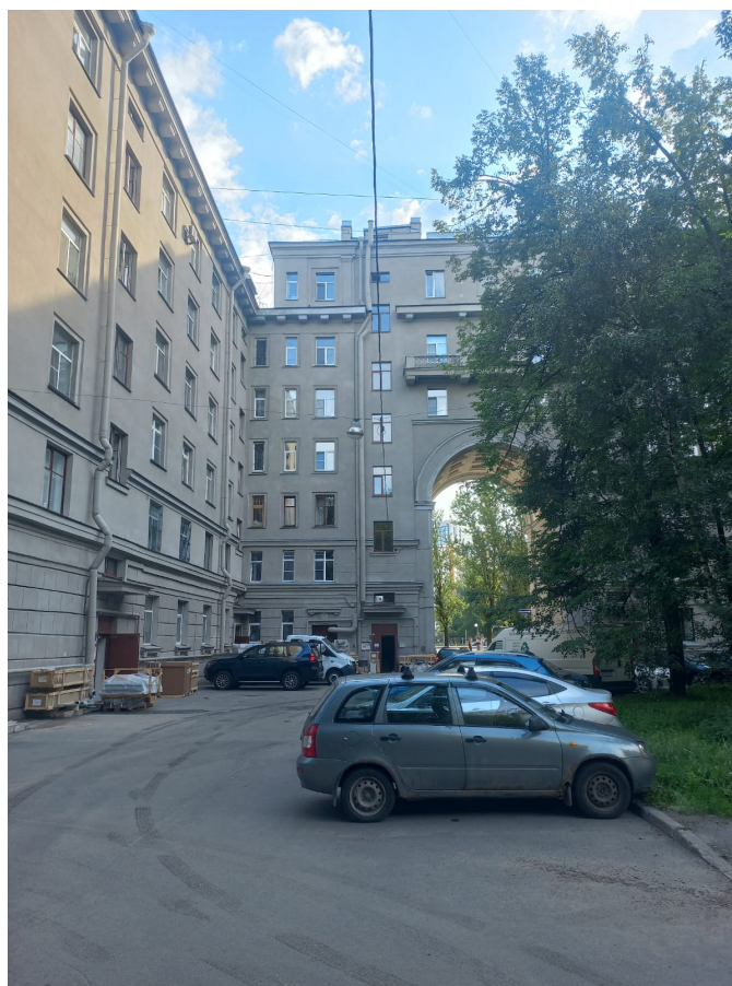
8. Фрагмент дворового фасада и юго-восточная проезжая арка со стороны двора дома 16, корп. 1, литера А
