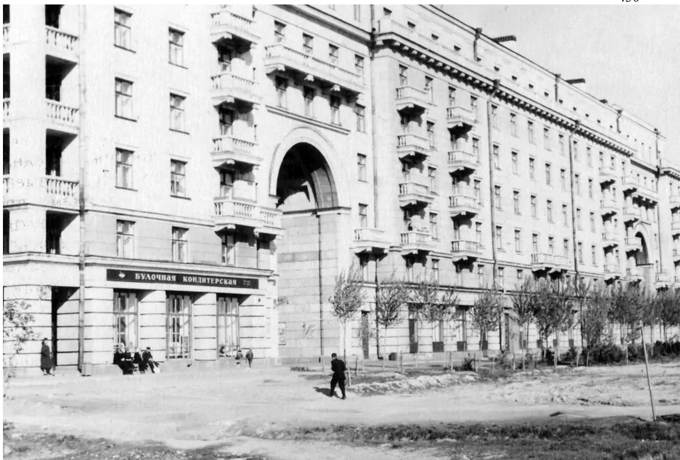
10. Фрагмент лицевого фасада дома №14 корп. 1 по Московскому шоссе. Фотография. Автор неизвестен. 1958–1960 гг.
