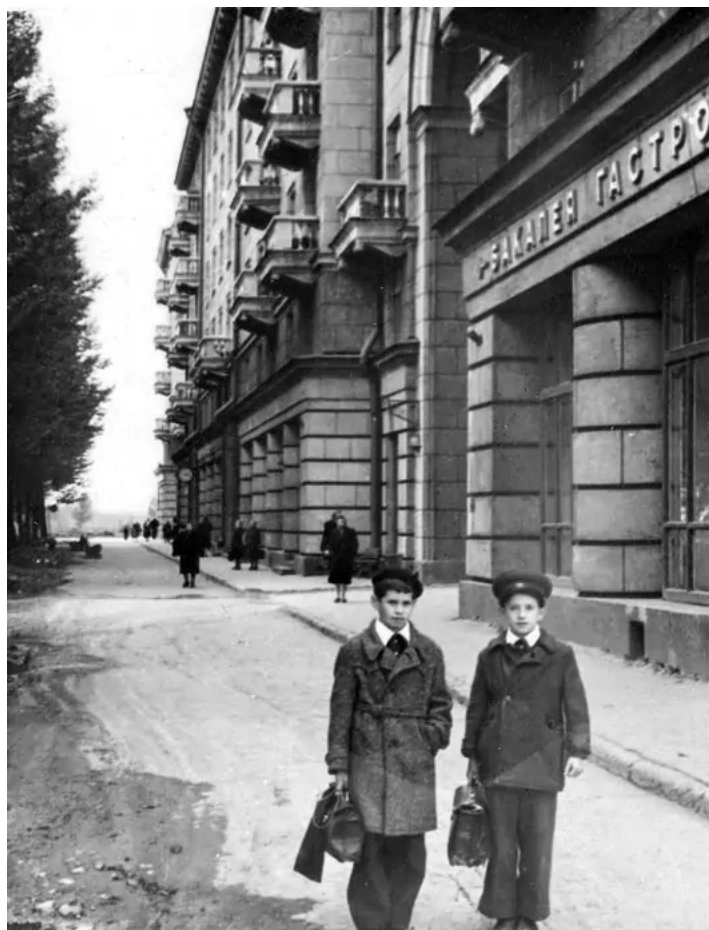
8. Фрагмент лицевого фасада дома №14 корп. 1 по Московскому шоссе. Фотография. Автор неизвестен. 1958–1960 гг.
