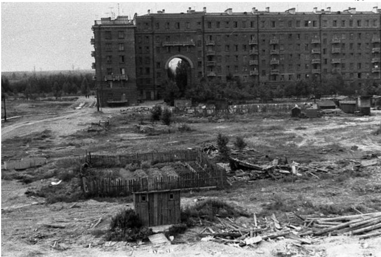
12. Фасад дома №16 корп. 1 по Московскому шоссе со стороны двора. Фотография. Автор неизвестен. 1961 г.
