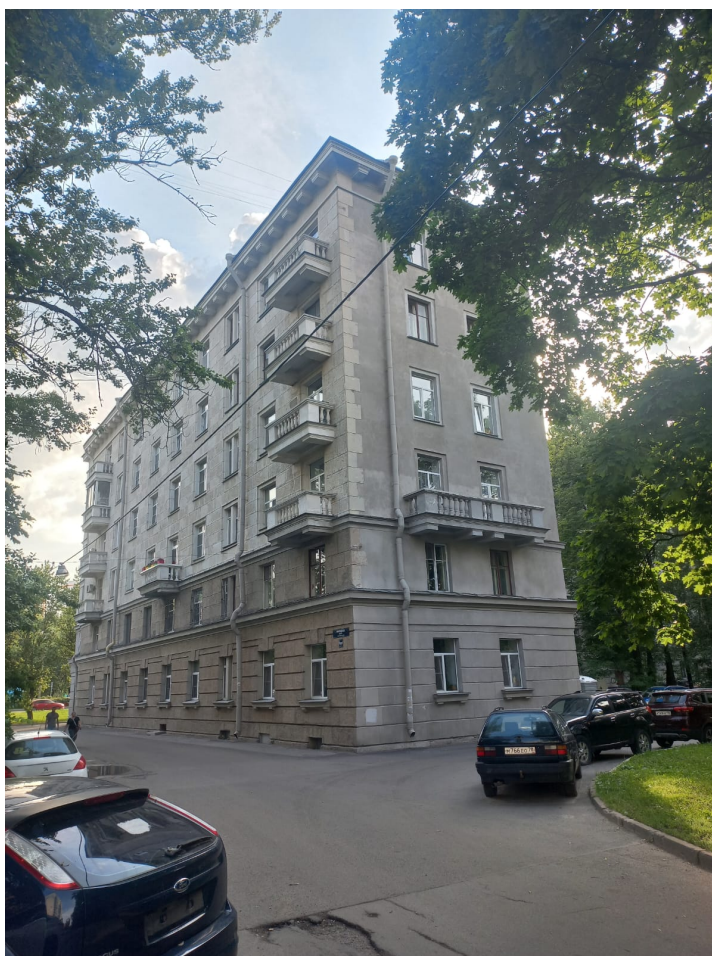
10. Общий вид юго-восточного фасада дома 16, корп. 1, литера А
