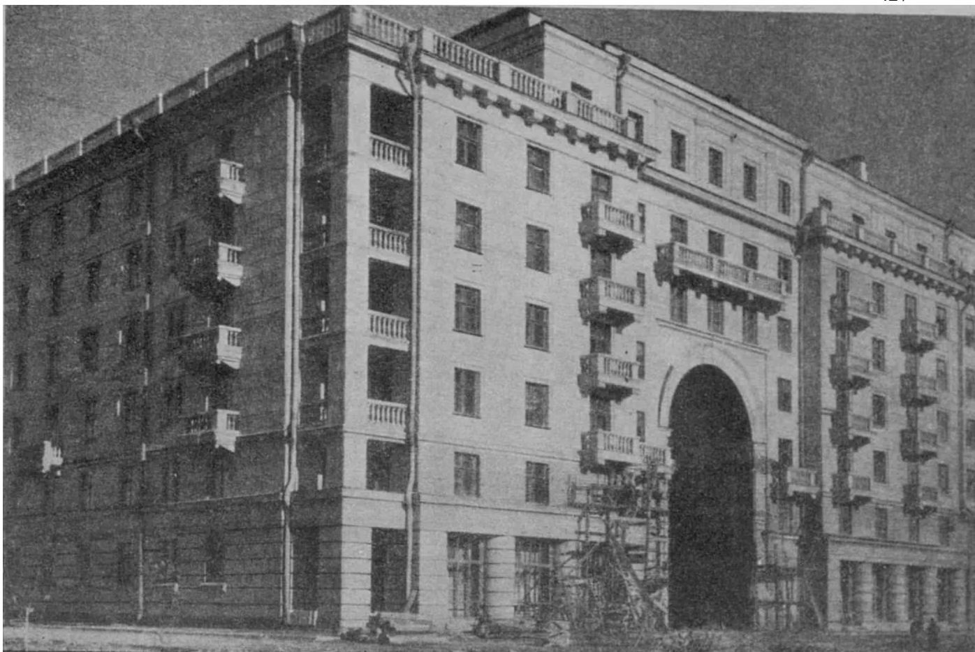
4. Жилой дом ленинградского мясокомбината. Фотография. Автор неизвестен. Журнал Архитектура и строительство Ленинграда №2. 1948–1949 гг.
