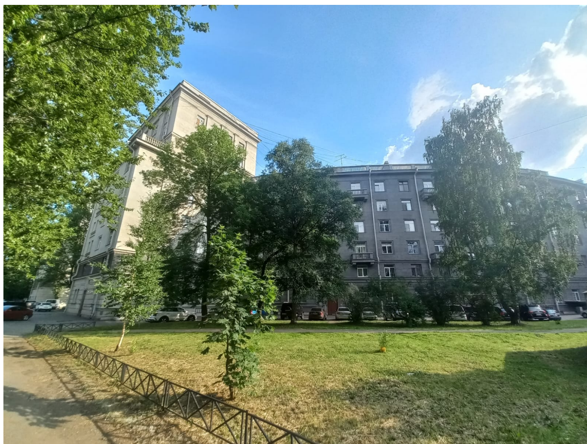
4. Общий вид полукруглой части фасада дома 14, корп. 1, литера А со стороны двора.
