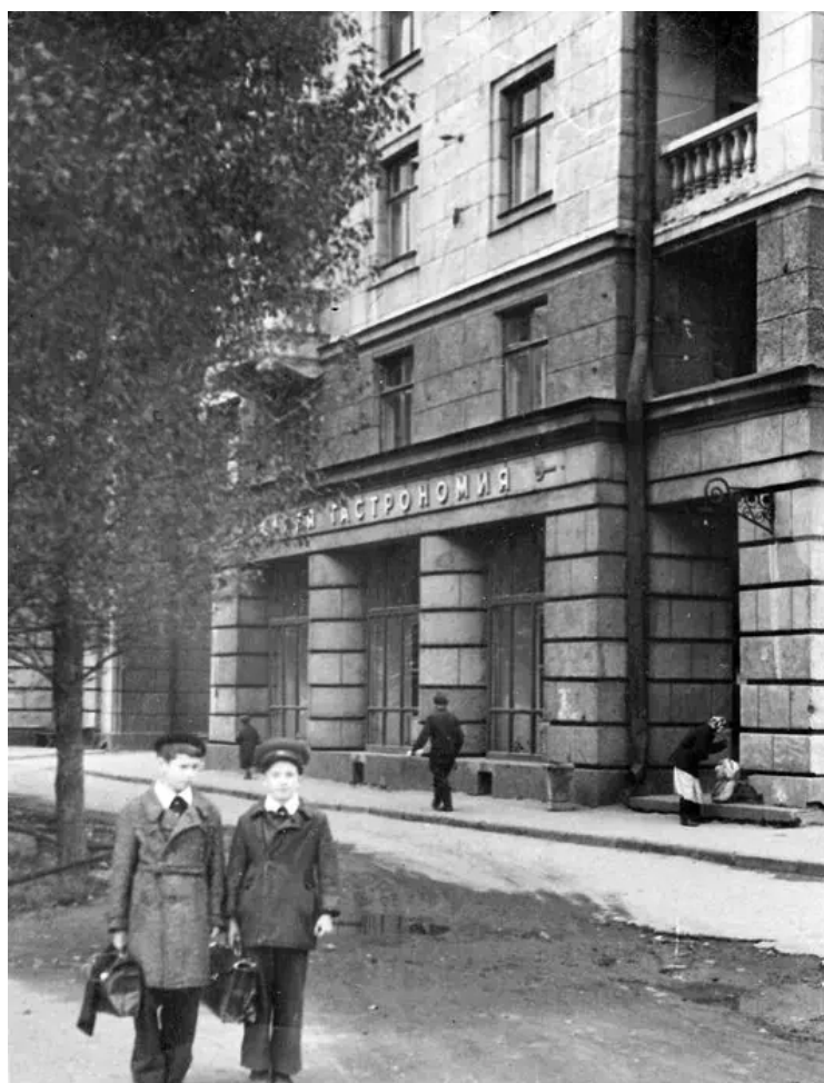
7. Фрагмент лицевого фасада дома №14 корп. 1 по Московскому шоссе. Фотография. Автор неизвестен. 1958–1960 гг.
