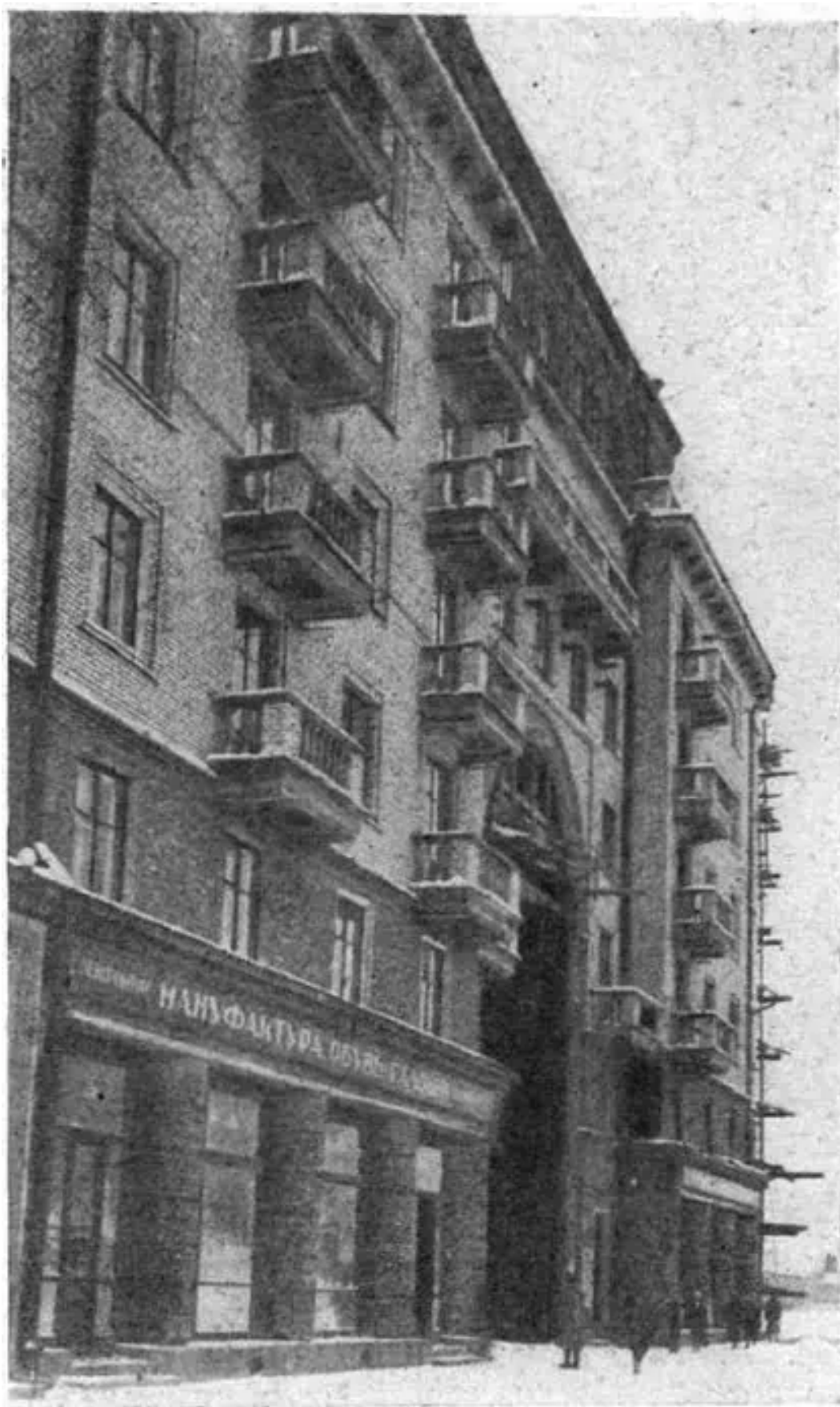
1. Жилой дом Ленмясокомбината. Фотография. Автор неизвестен. Журнал Архитектура Ленинграда №1 1939 г.
