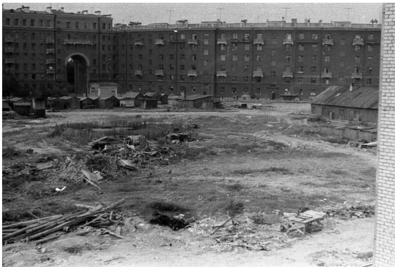
11. Фасад дома №16 корп. 1 по Московскому шоссе со стороны двора. Фотография. Автор неизвестен. 1961 г.
