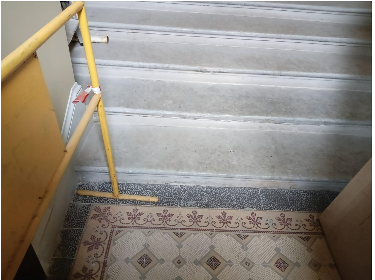
Фото 16. Объект культурного наследия федерального значения «Дом Форостовского П.П.», Санкт-Петербург, 4 линия В.О., дом 9 литера А. Помещение 1-Н (63). Покрытие пола в вестибюле керамической (метлахской?) плиткой с мозаичным эффектом (восьмигранной светло-охристого цвета с терракотовым рисунком) со вставками мелкой квадратной плитки; орнаментальный бордюр по периметру.
