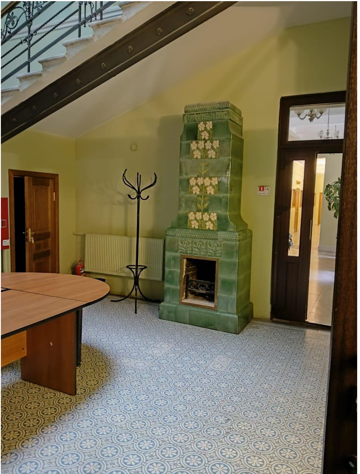
Фото 11. Объект культурного наследия федерального значения «Дом Форостовского П.П.», Санкт-Петербург, 4 линия В.О., дом 9 литера А. Помещение 1-Н (29). Холл у лестницы. Камин – средистенный, двухъярусный, облицованный гладким и рельефным поливным изразцом изумрудно-зеленого цвета; нижний ярус на цоколе; топочный проем прямоугольный, в латунном обрамлении, таган черного металла, топка выложена кирпичом; над топкой – рельефный растительный орнамент в стиле модерн; верхний ярус
