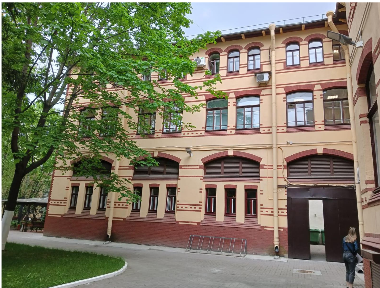
Фото 4. Объект культурного наследия федерального значения «Дом Форостовского П.П.», Санкт-Петербург, 4 линия В.О., дом 9 литера А. Фасад западный (северного двора) флигеля 2 (хозяйственного).
