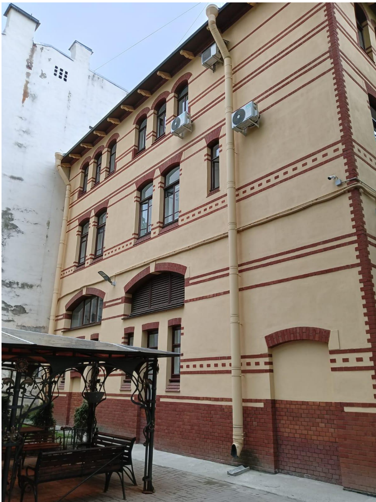
Фото 5. Объект культурного наследия федерального значения «Дом Форостовского П.П.», Санкт-Петербург, 4 линия В.О., дом 9 литера А. Фасад северный (северного двора) флигеля 2 (хозяйственного).
