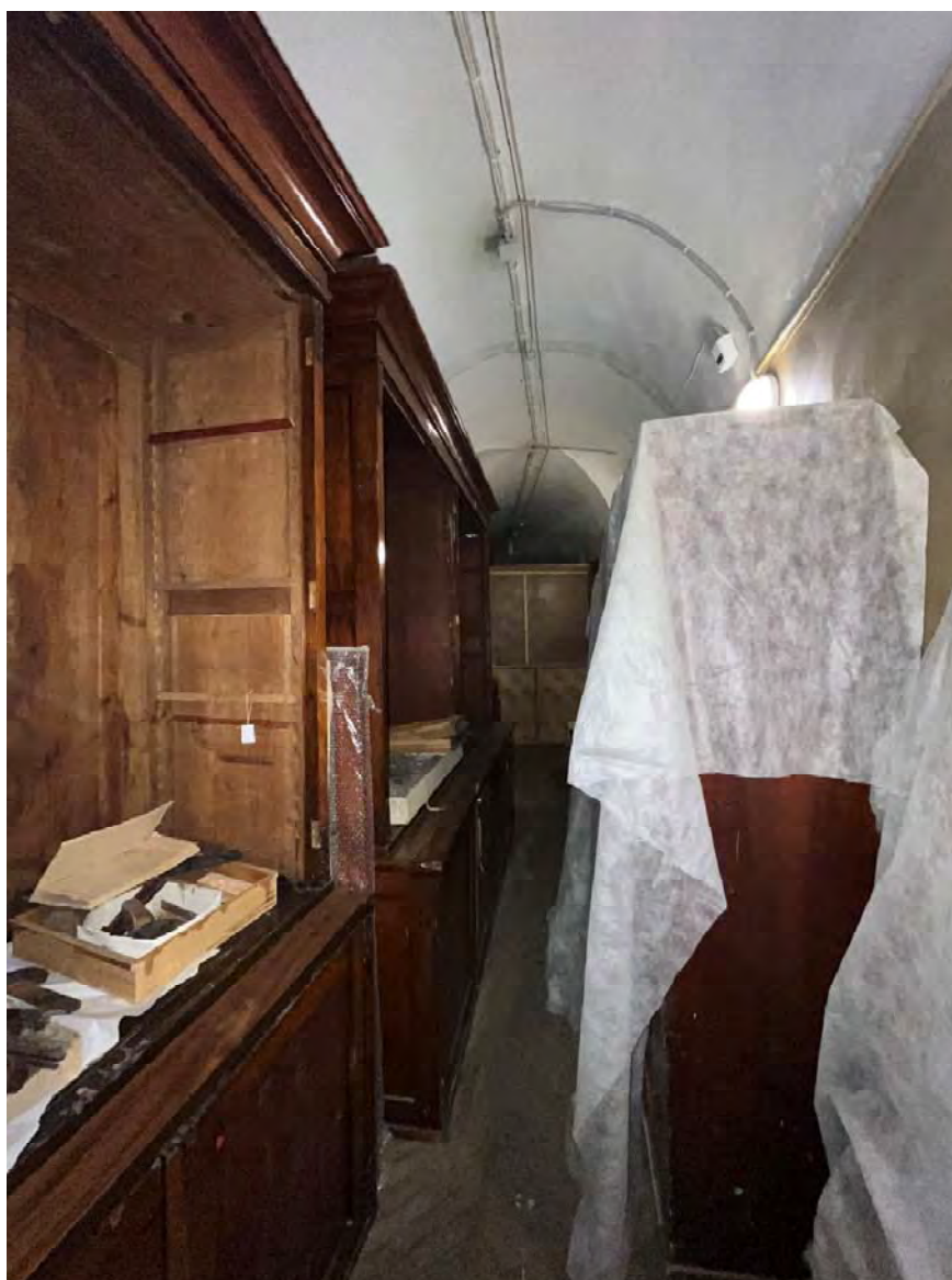
Фото №54. 1-ый этаж, западное крыло, помещение 1-Н(11).
