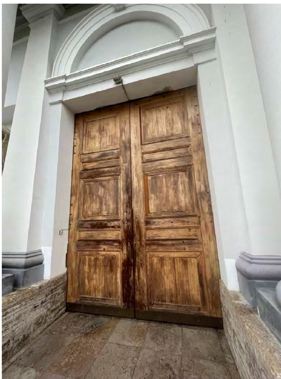
Фото №2. Лицевой полукруглый фасад, дверное заполнение главного входа.
