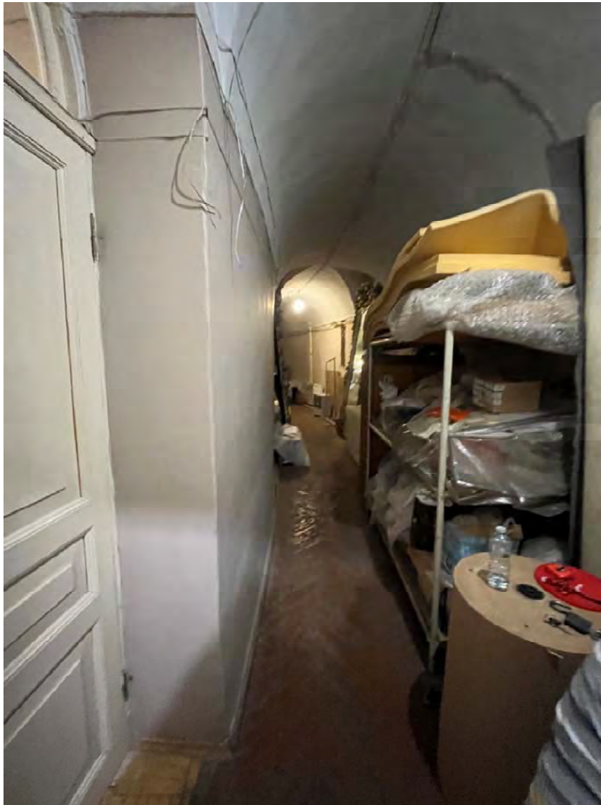
Фото №27. 1-ый этаж, восточное крыло, помещение 1-Н(2).
