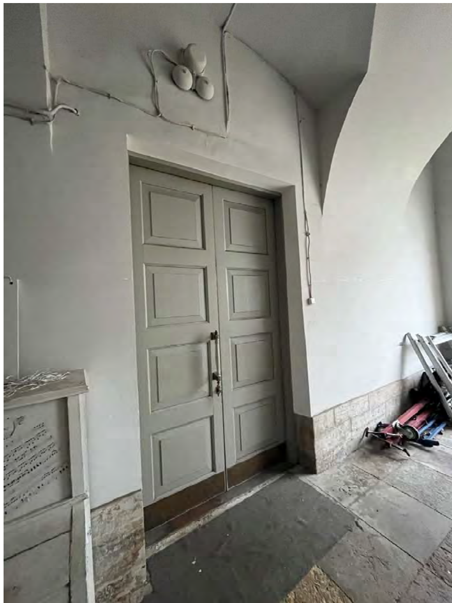
Фото 22. Воротный проезд, вход в западное крыло.
