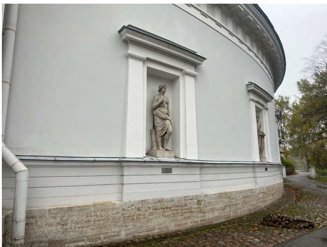
Фото №6. Лицевой полукруглый фасад, фрагмент.
