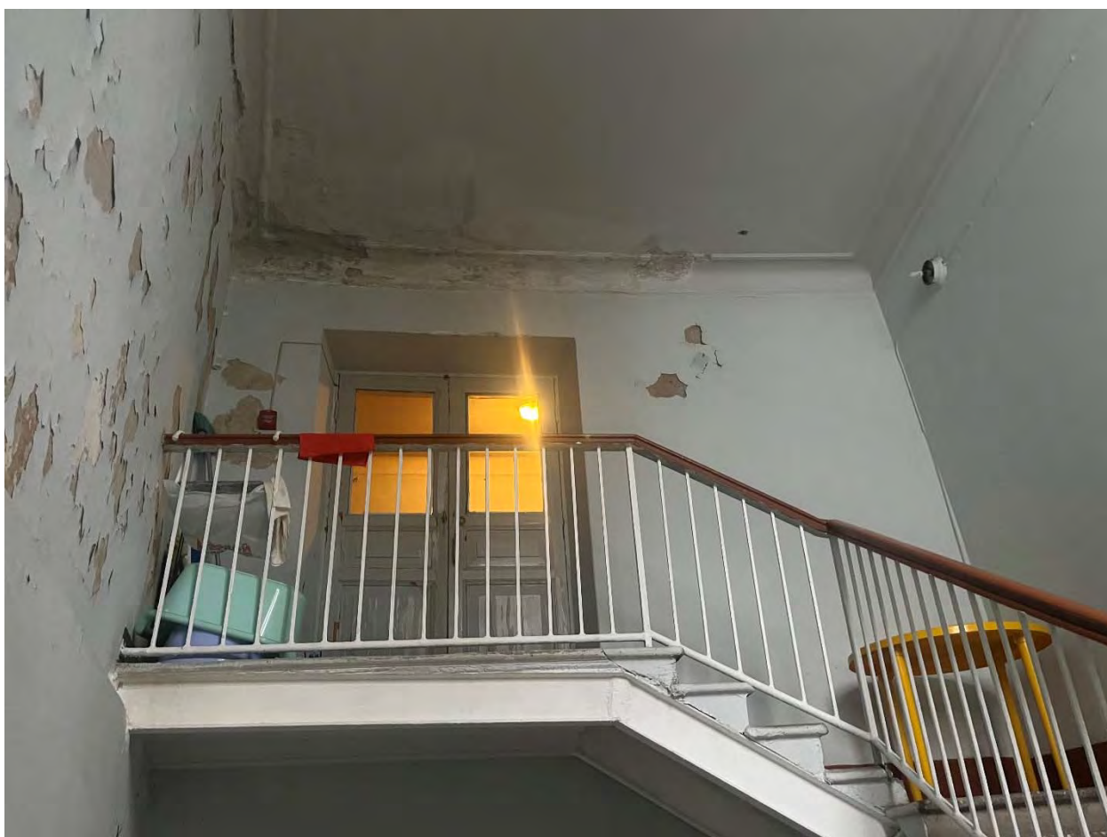
Фото №40. 1-ый этаж, восточное крыло, помещение 1-Н(3), лестничная клетка, вид на площадку 2-го этажа.
