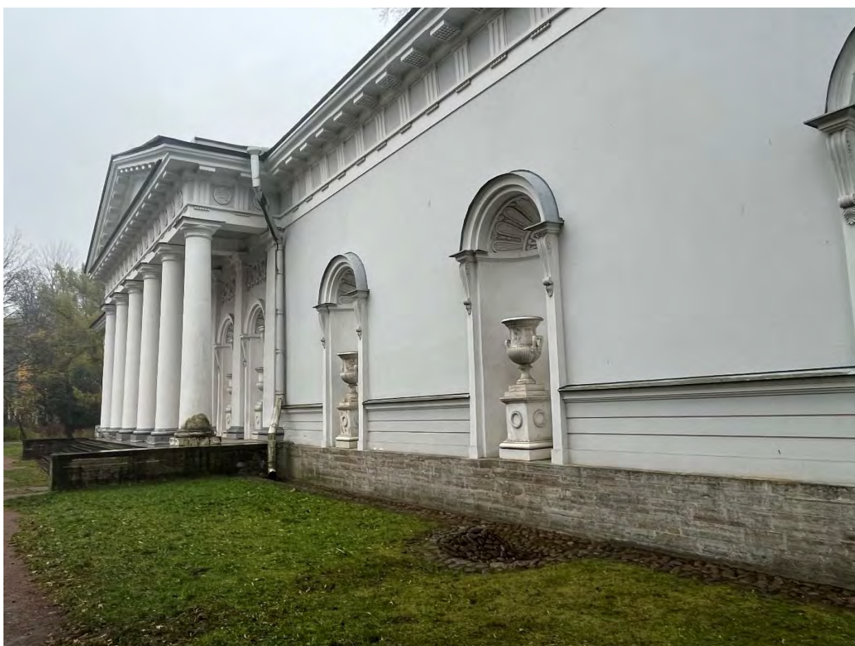
Фото 12. Северный фасад, конструкции лестницы портика.
