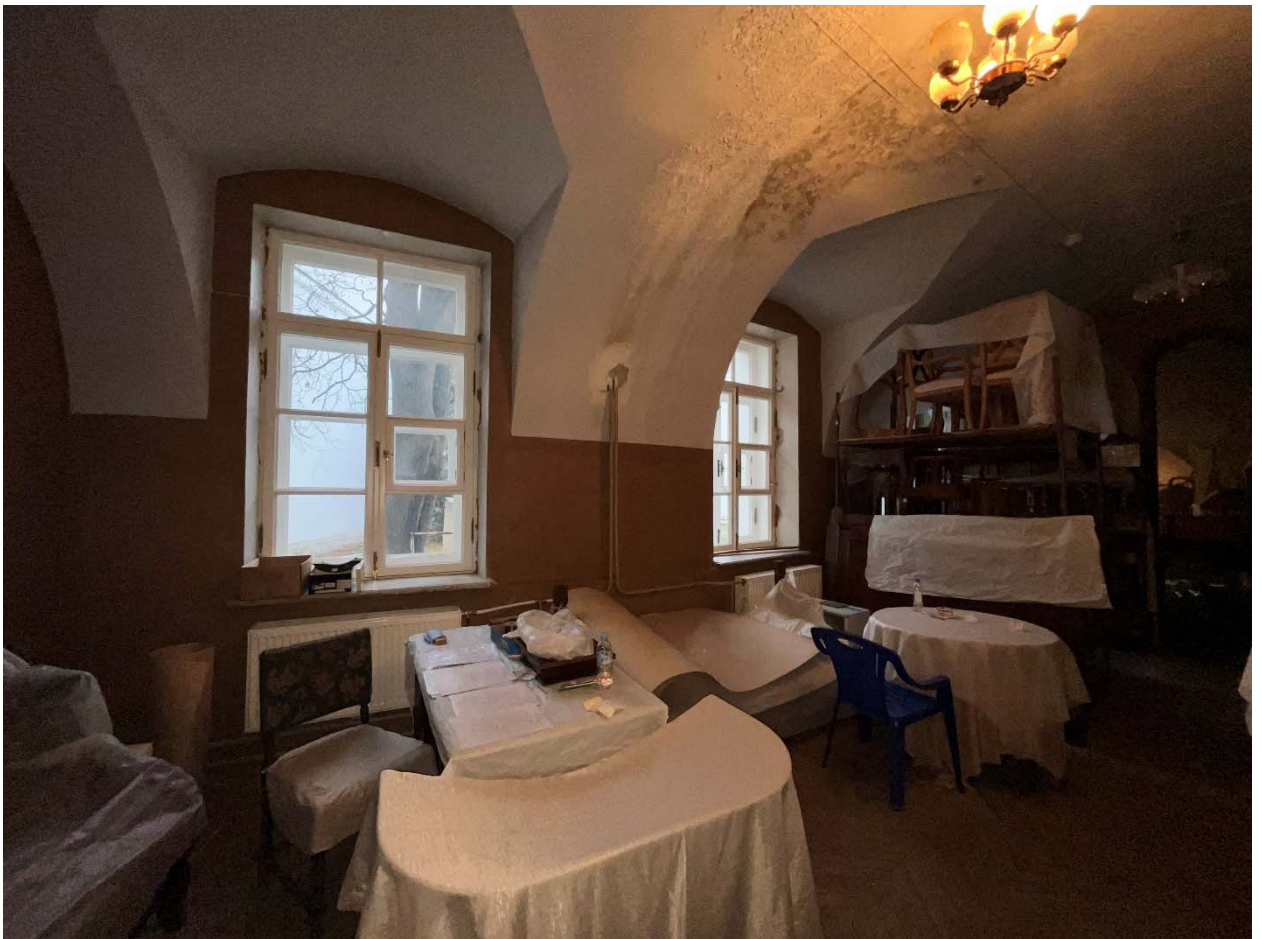
Фото №52. 1-ый этаж, западное крыло, помещение 1-Н(13).
