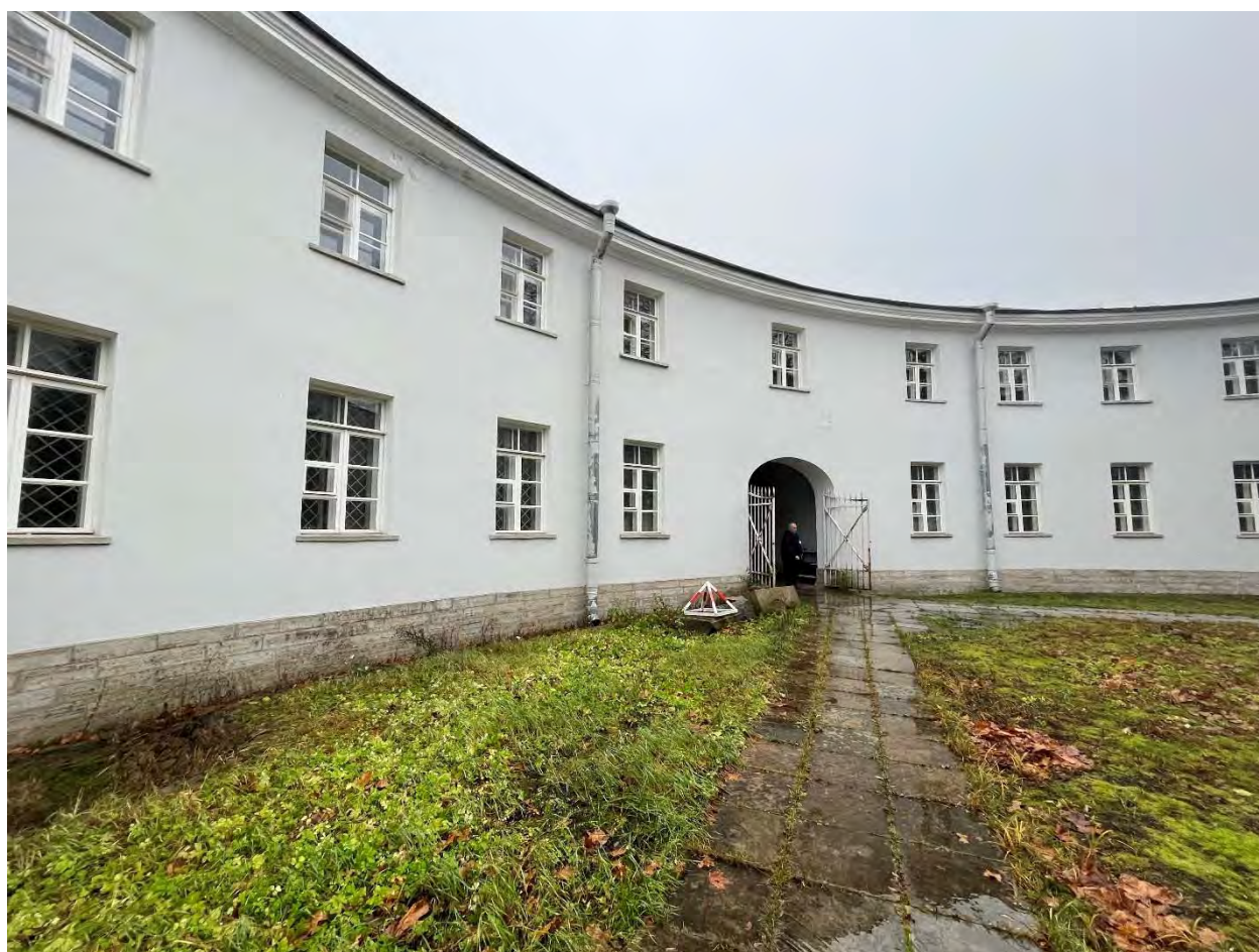
Фото 19. Дворовый полукруглый фасад, общий вид.
