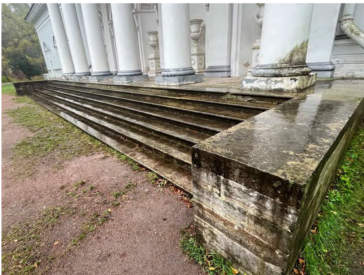
Фото 11. Северный фасад, конструкции лестницы портика.
