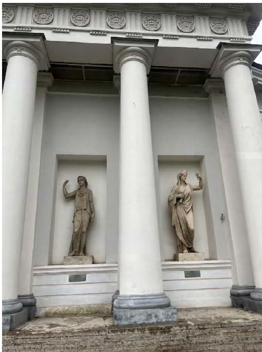
Фото №5. Лицевой полукруглый фасад, фрагмент.
