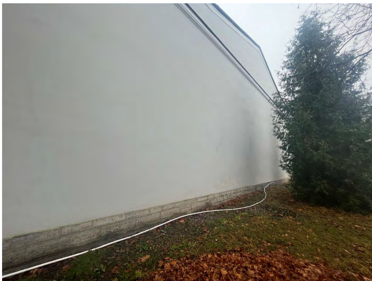
Фото 17. Дворовый южный фасад.
