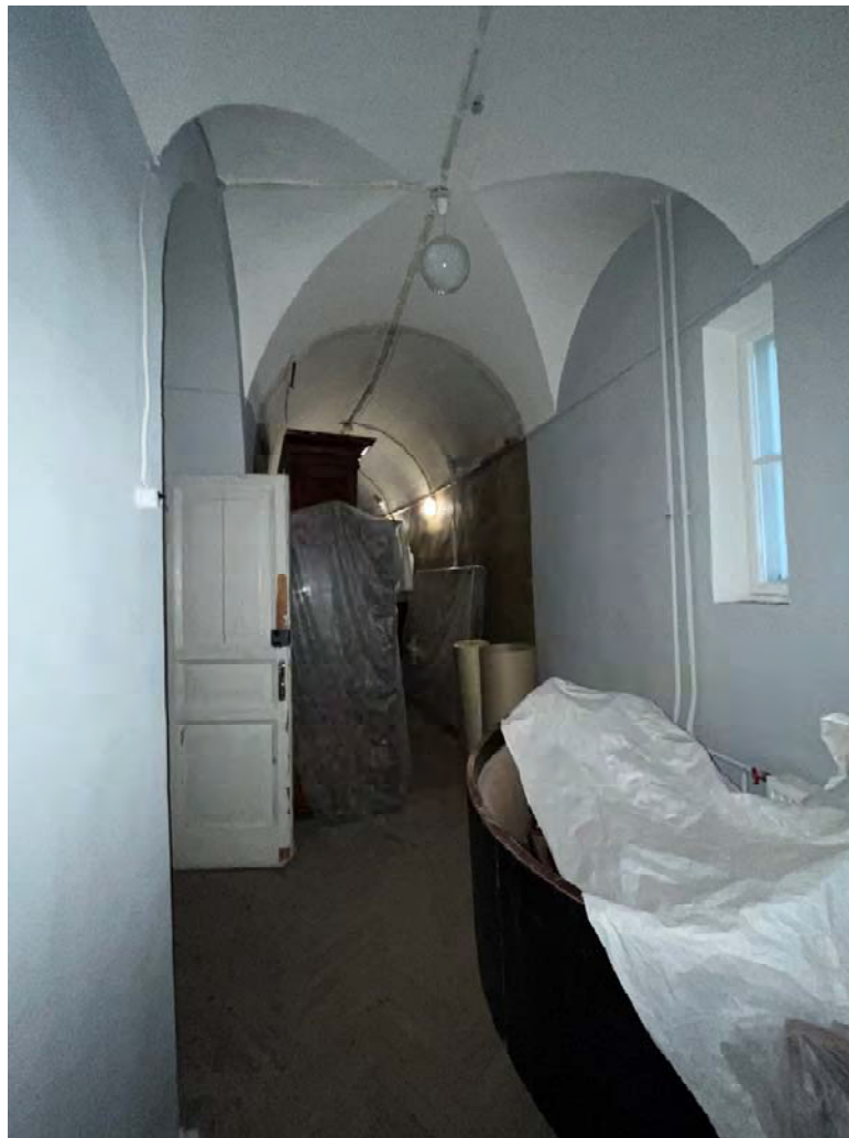
Фото №51. 1-ый этаж, западное крыло, помещение 1-Н(11).
