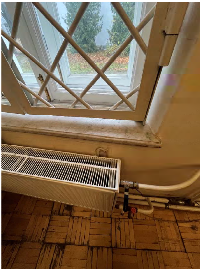
Фото №34. 1-ый этаж, восточное крыло, помещение 1-Н(5), мраморный подоконник.
