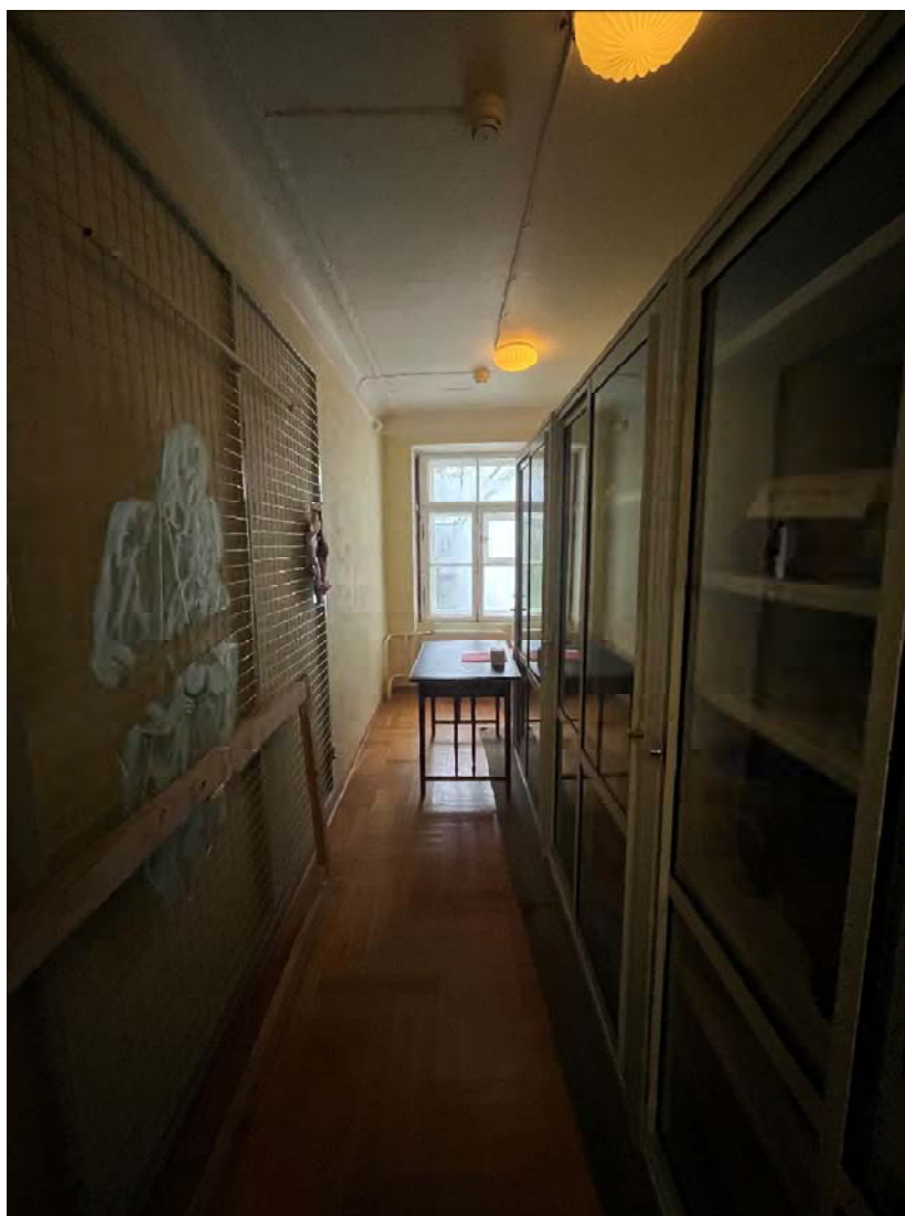
Фото №58. 2-ой этаж, помещение 1-Н(17).
