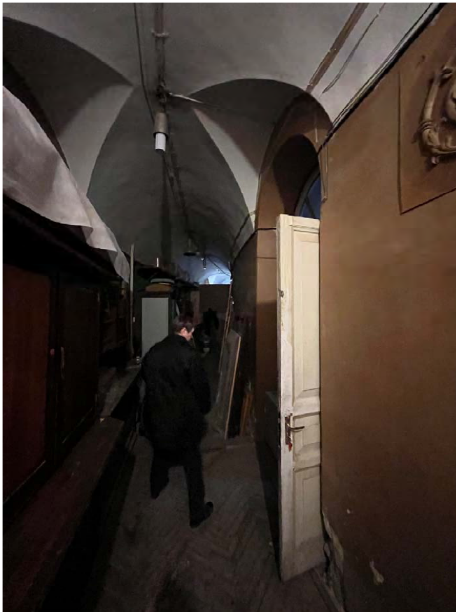
Фото №45. 1-ый этаж, западное крыло, помещение 1-Н(11).
