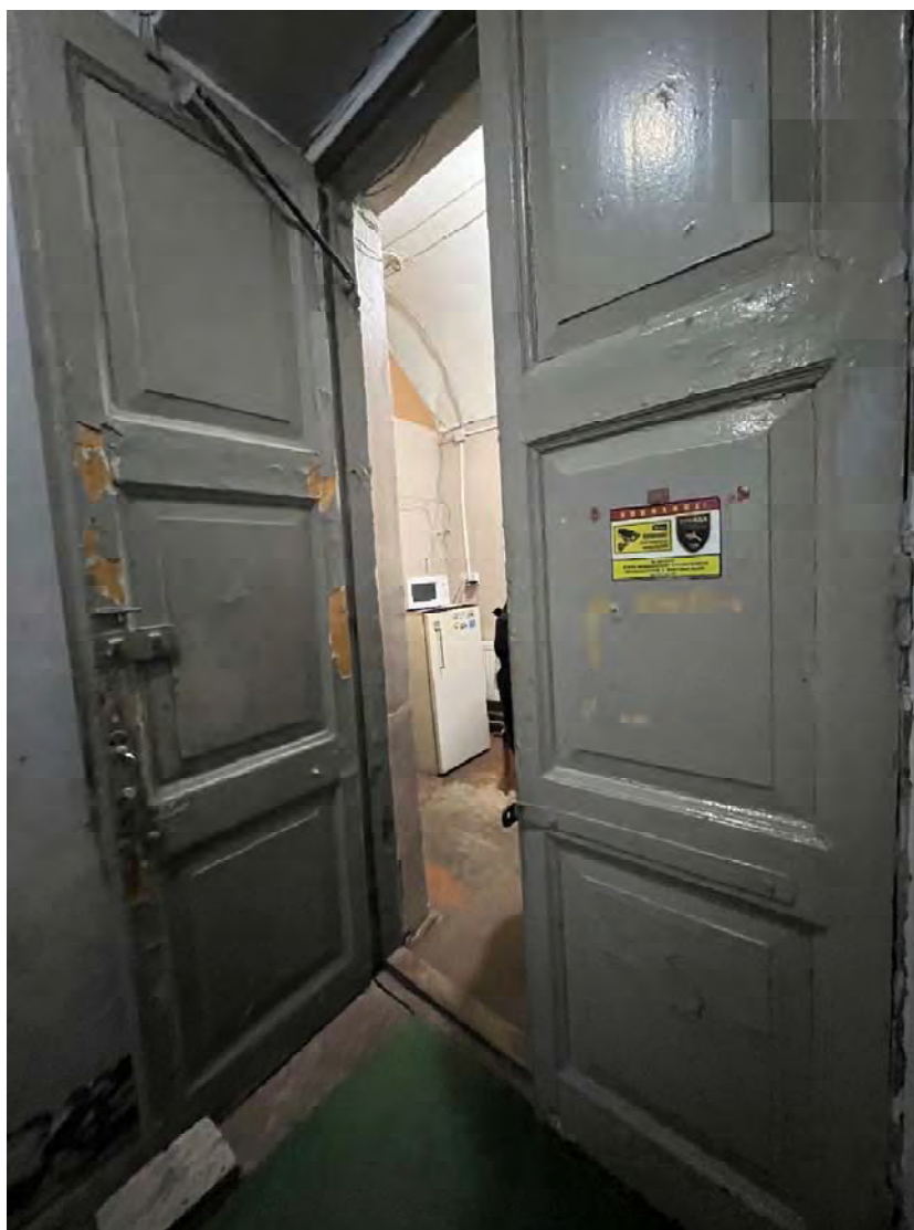
Фото №25. 1-ый этаж, помещение 1-Н, лестничная клетка, дверное заполнение входа в помещения восточного крыла.
