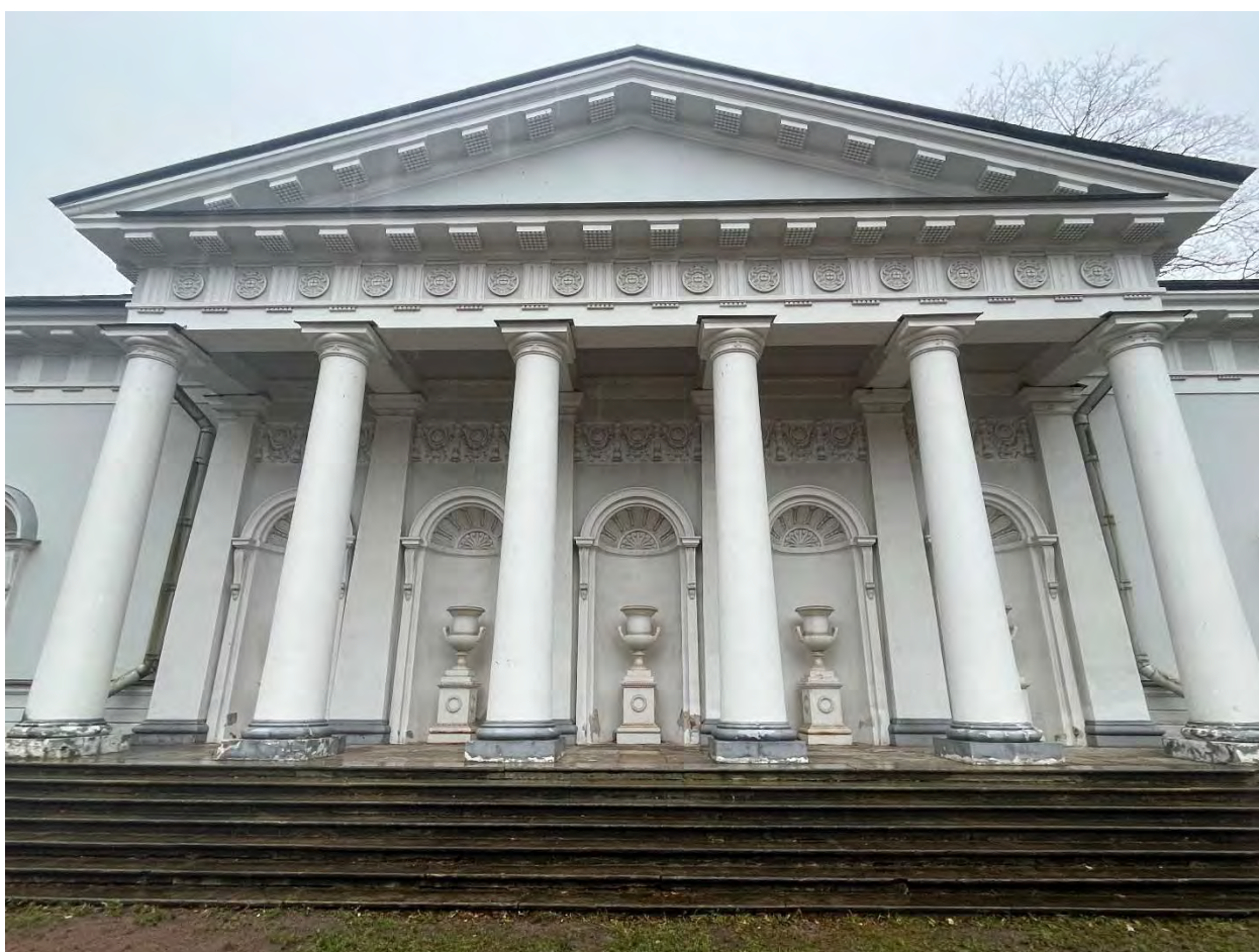
Фото 10. Северный фасад, портик.
