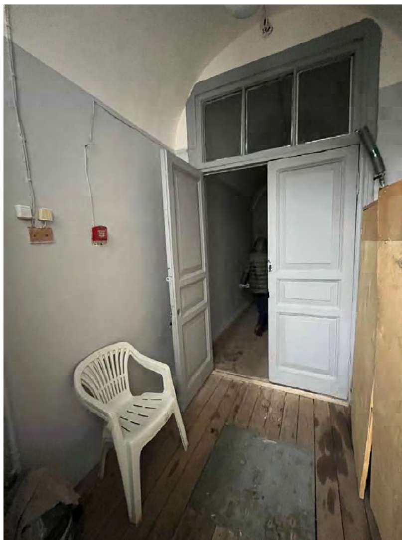
Фото №49. 1-ый этаж, западное крыло, помещение 1-Н(15).
