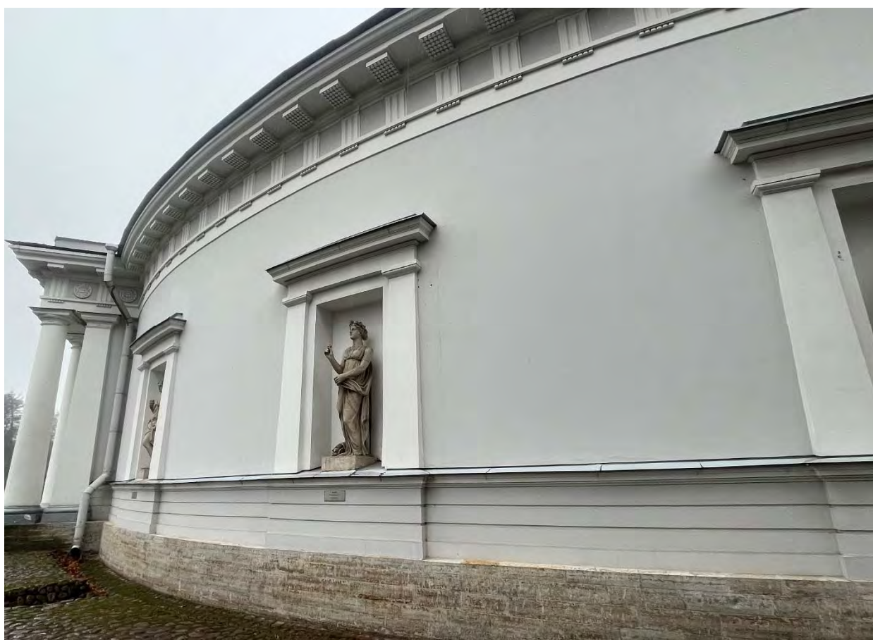
Фото №7. Лицевой полукруглый фасад, фрагмент.
