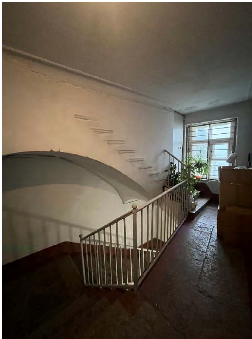
Фото №64. 2-ой этаж, помещение 1-Н(22).
