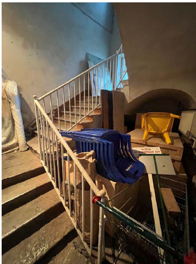
Фото №42. 1-ый этаж, западное крыло, помещение 1-Н(10), лестничная клетка.
