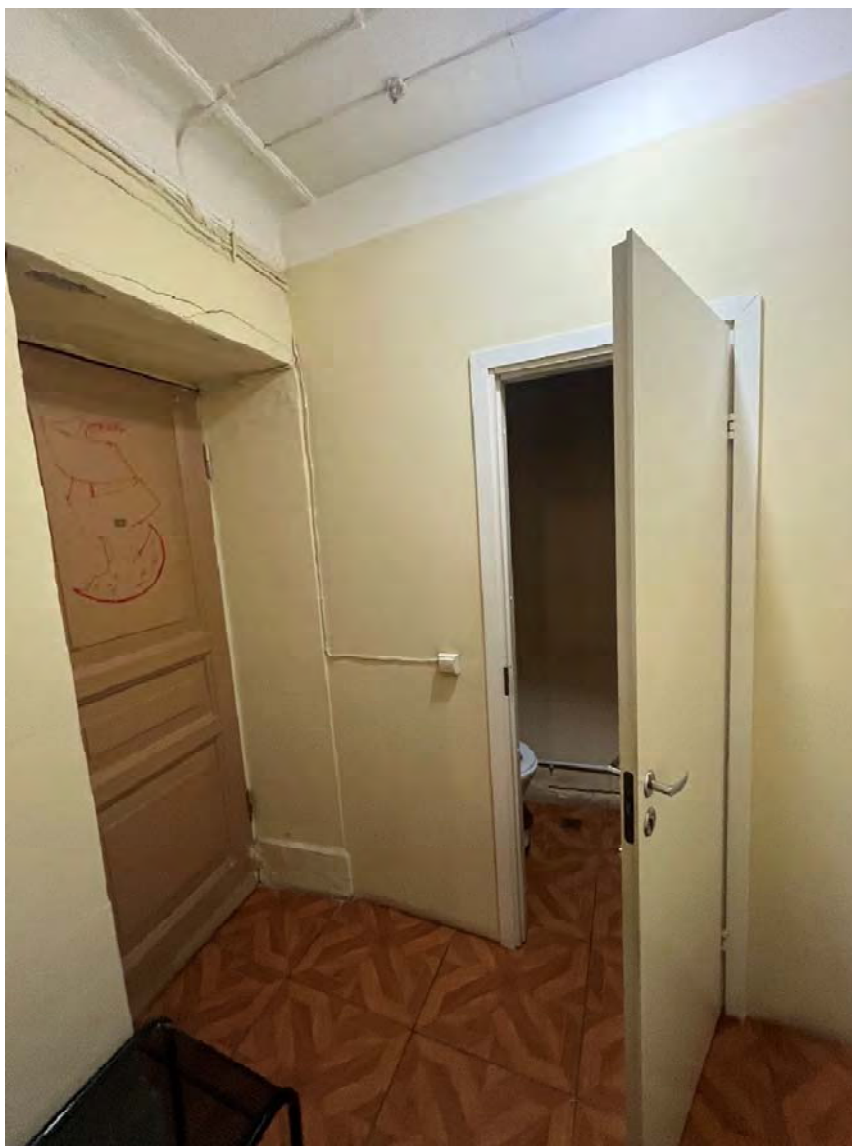
Фото №57. 2-ой этаж, помещение 1-Н(16).
