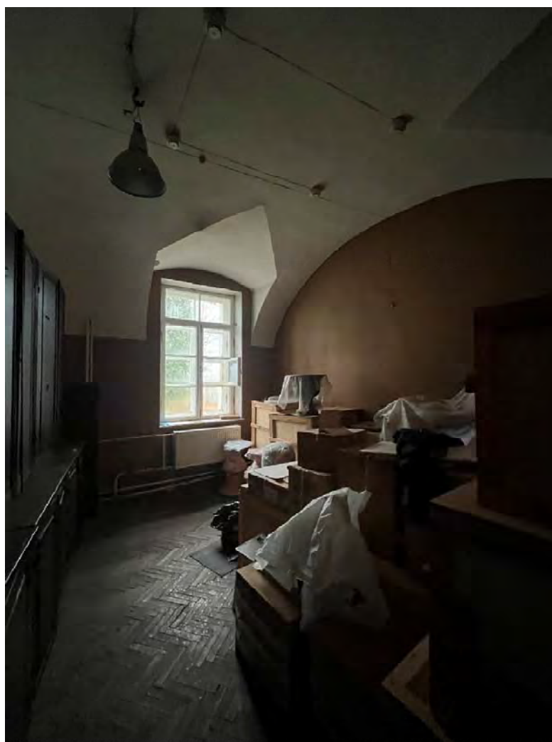
Фото №45. 1-ый этаж, западное крыло, помещение 1-Н(11).
