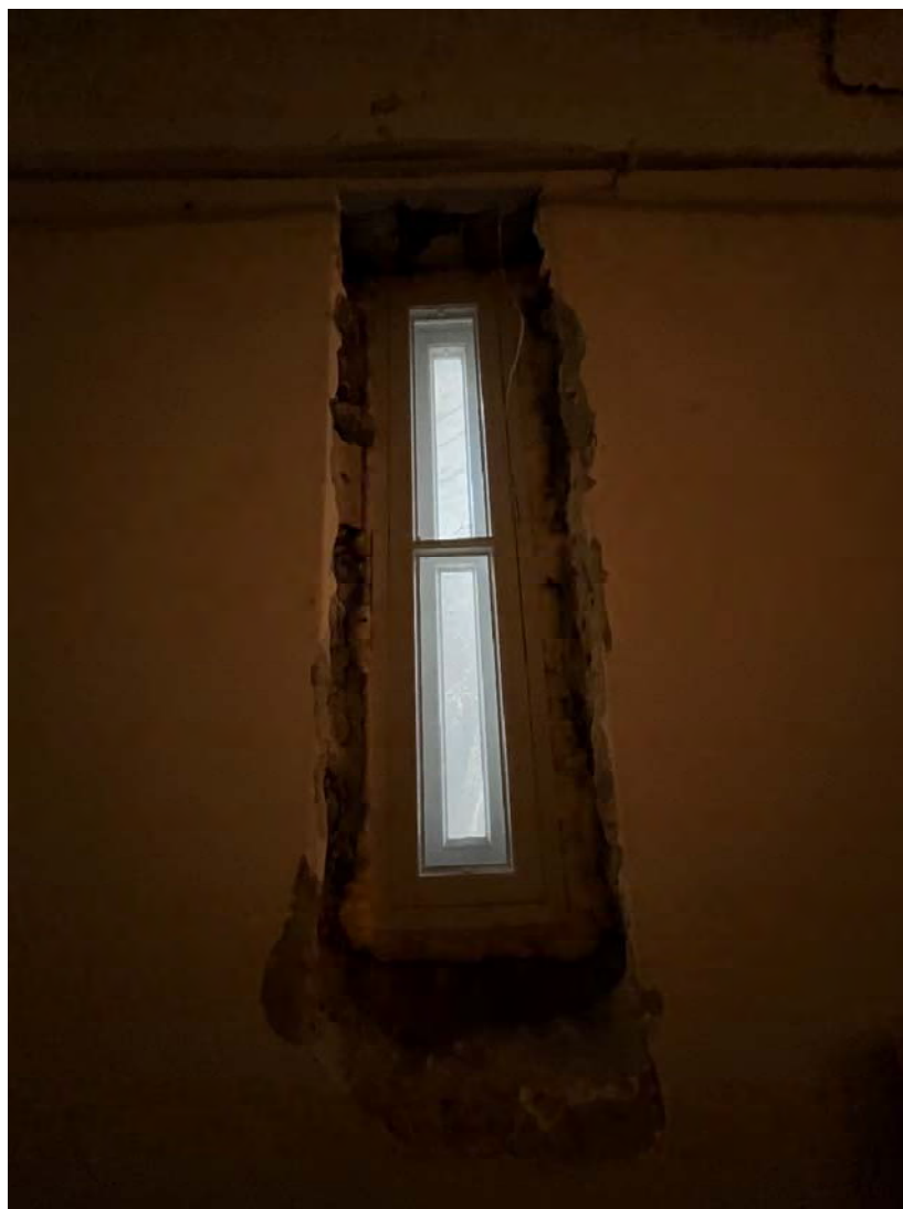
Фото №35. 1-ый этаж, восточное крыло, помещение 1-Н(2), оконный проем.
