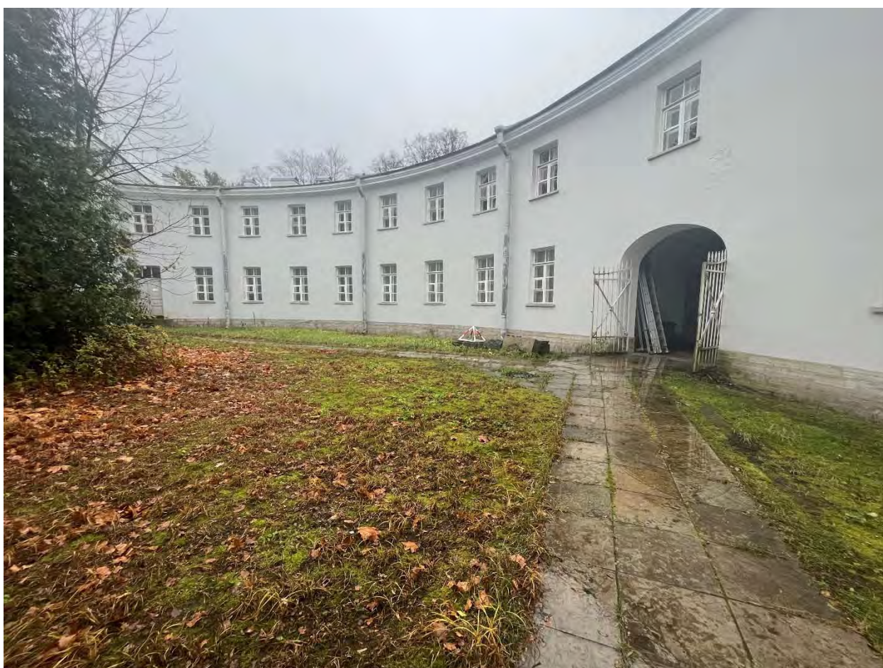
Фото 15. Дворовый полукруглый фасад, общи вид, территория двора.
