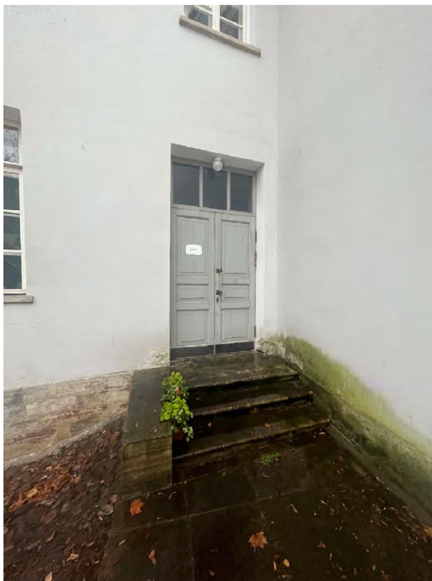
Фото 16. Дворовый полукруглый фасад, вход в западное крыло.
