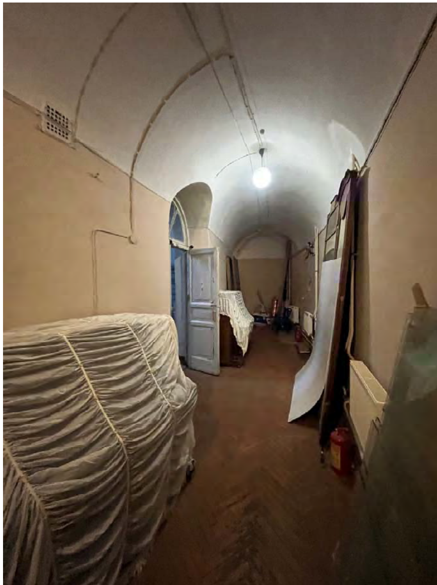
Фото №36. 1-ый этаж, восточное крыло, помещение 1-Н(2).
