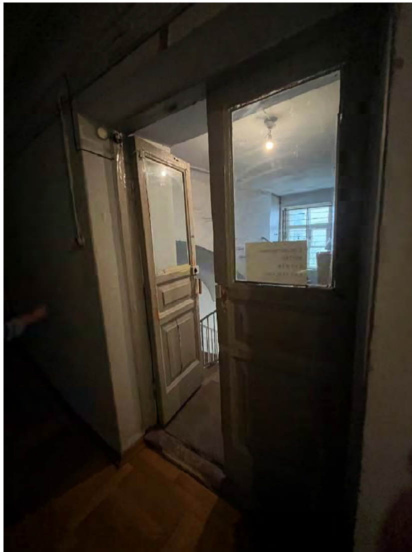
Фото №63. 2-ой этаж, помещение 1-Н(19).
