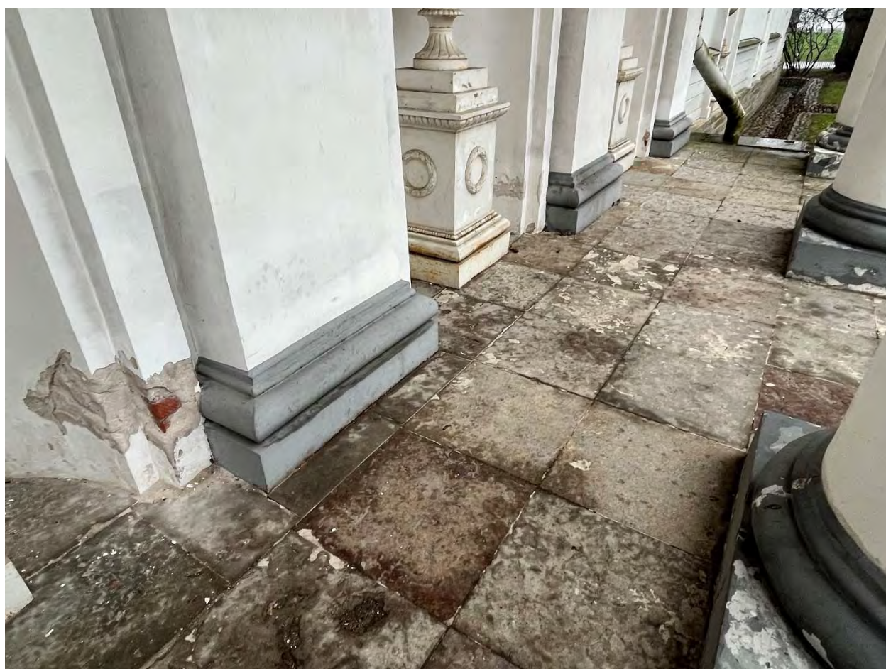
Фото 14. Северный фасад, портик, покрытие стилобата известняковыми плитами.
