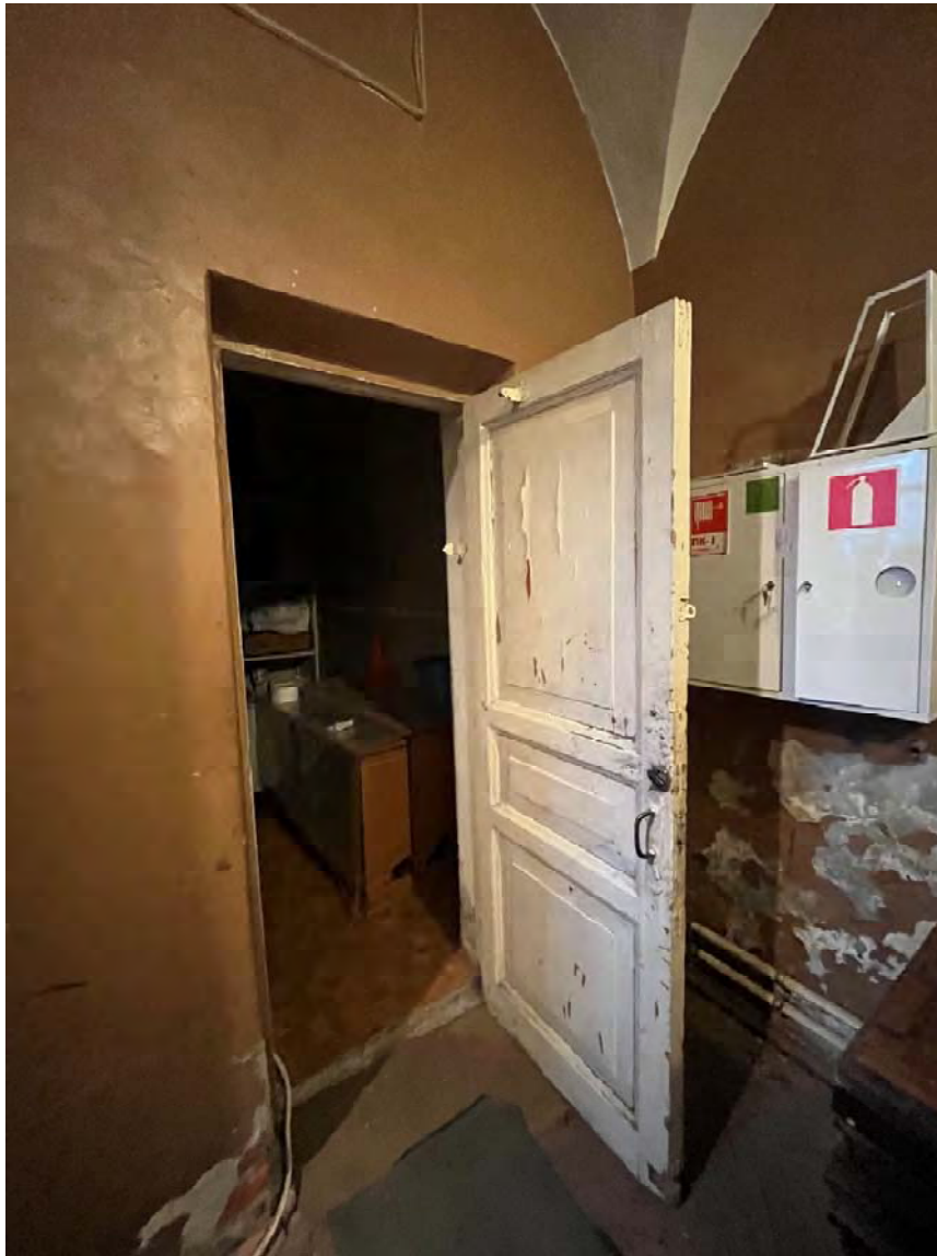
Фото №44. 1-ый этаж, западное крыло, помещение 1-Н(9), дверное заполнение.
