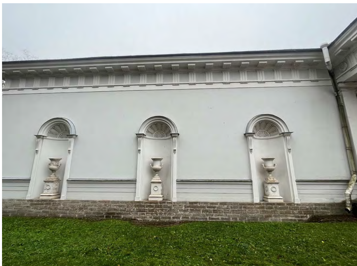
Фото №9. Северный фасад, фрагмент.
