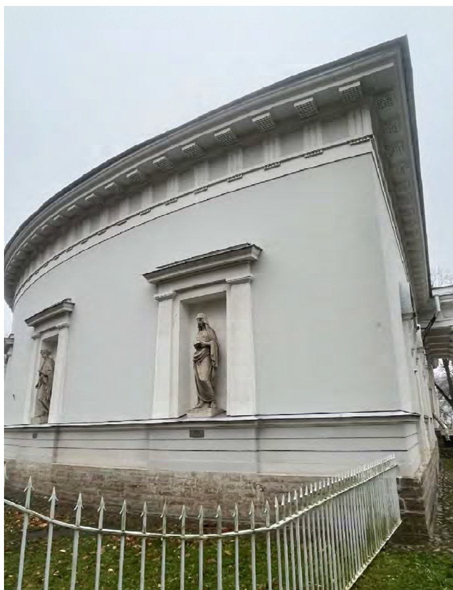
Фото №8. Лицевой полукруглый фасад, фрагмент.
