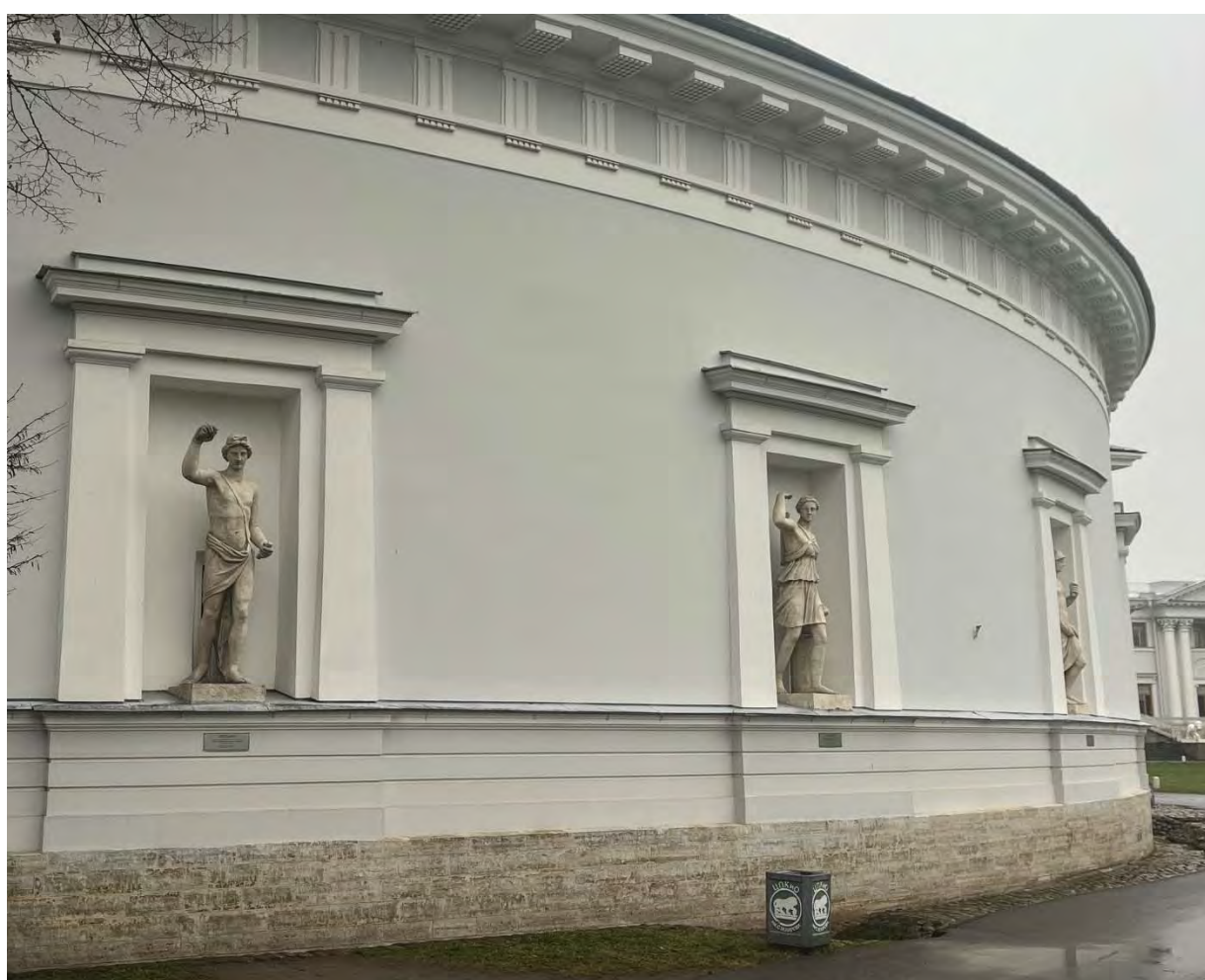
Фото №3. Лицевой полукруглый фасад, фрагмент.
