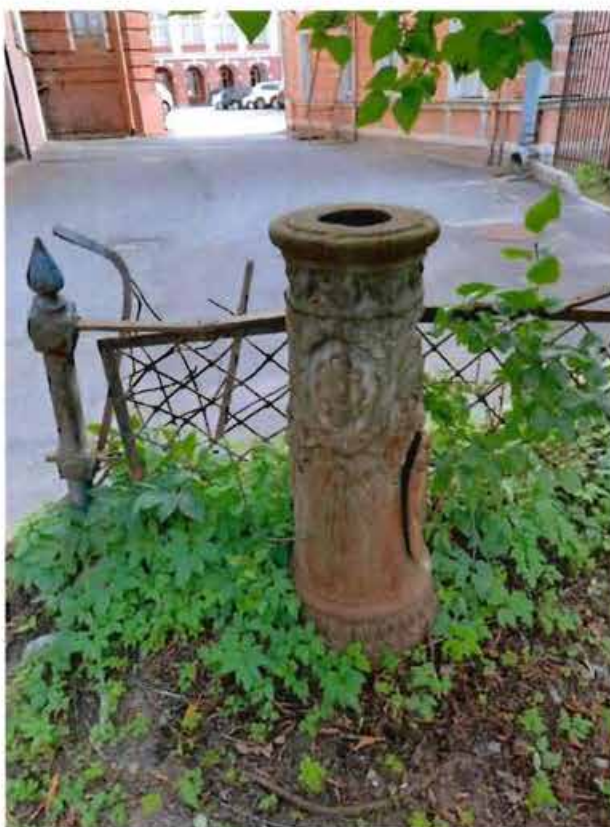
Фото 12: фрагмент объекта культурного наследия: фрагмент исторической чугуной фонарной опоры.
