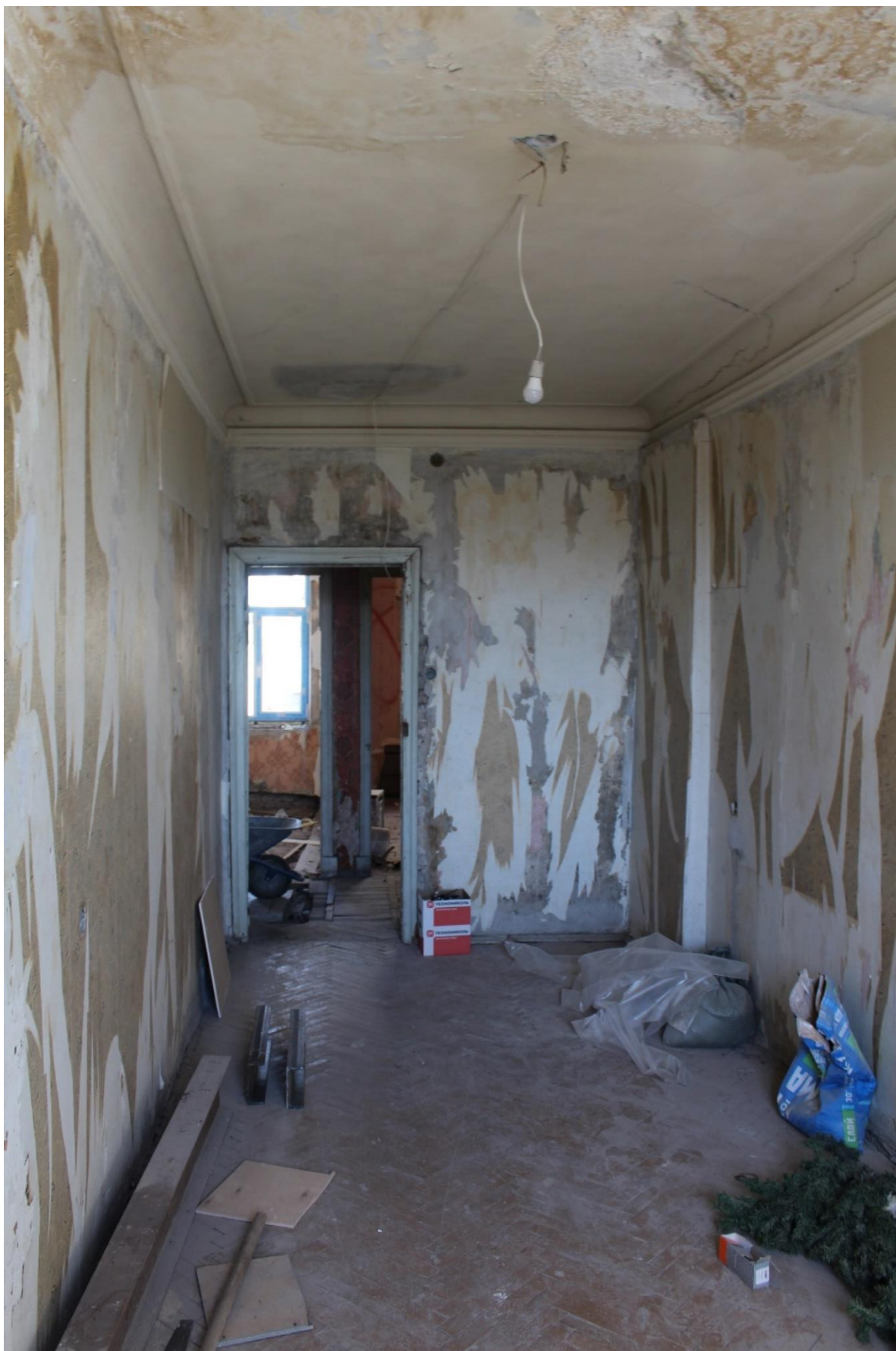
Фото 32. Вид на помещение № 15.
