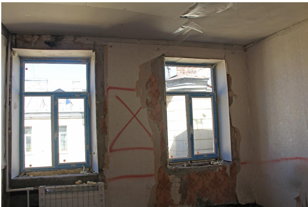
Фото 27. Вид на помещение № 4.
