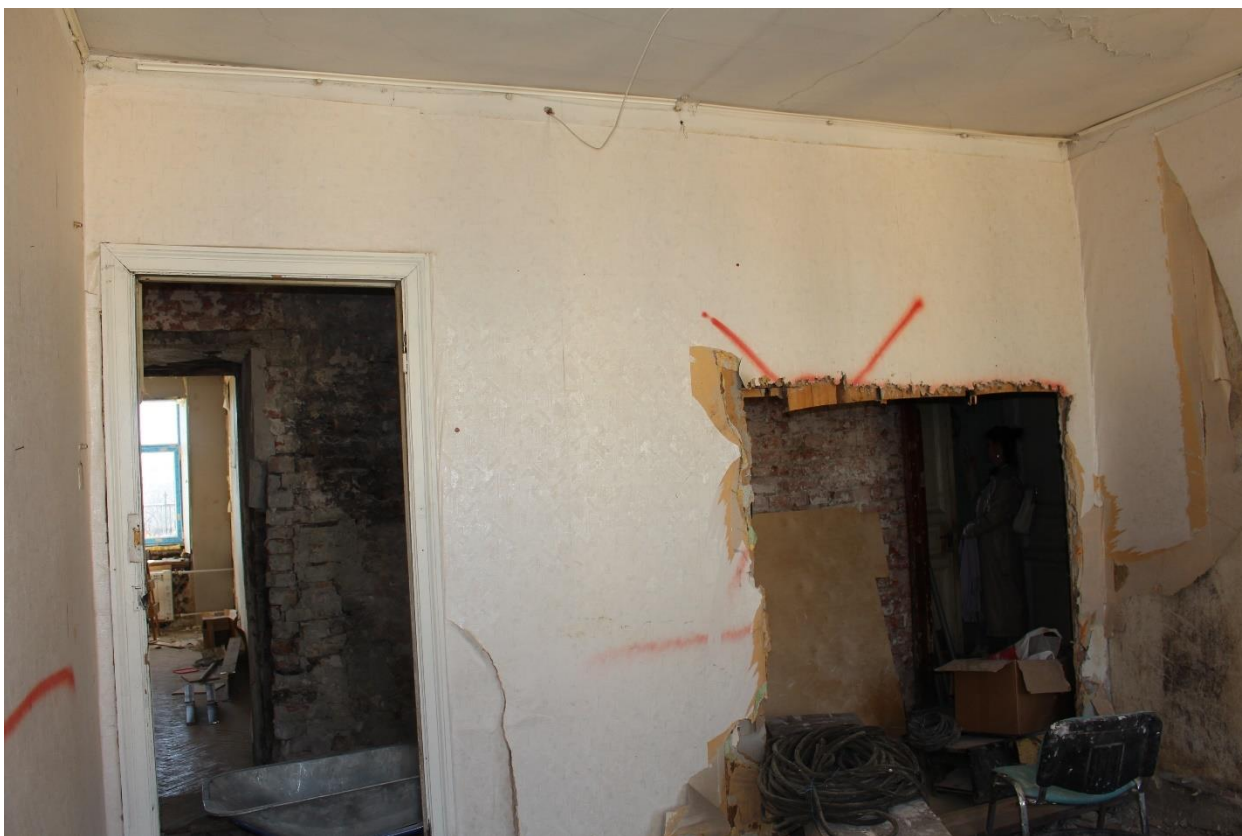
Фото 28. Вид на помещение № 4.
