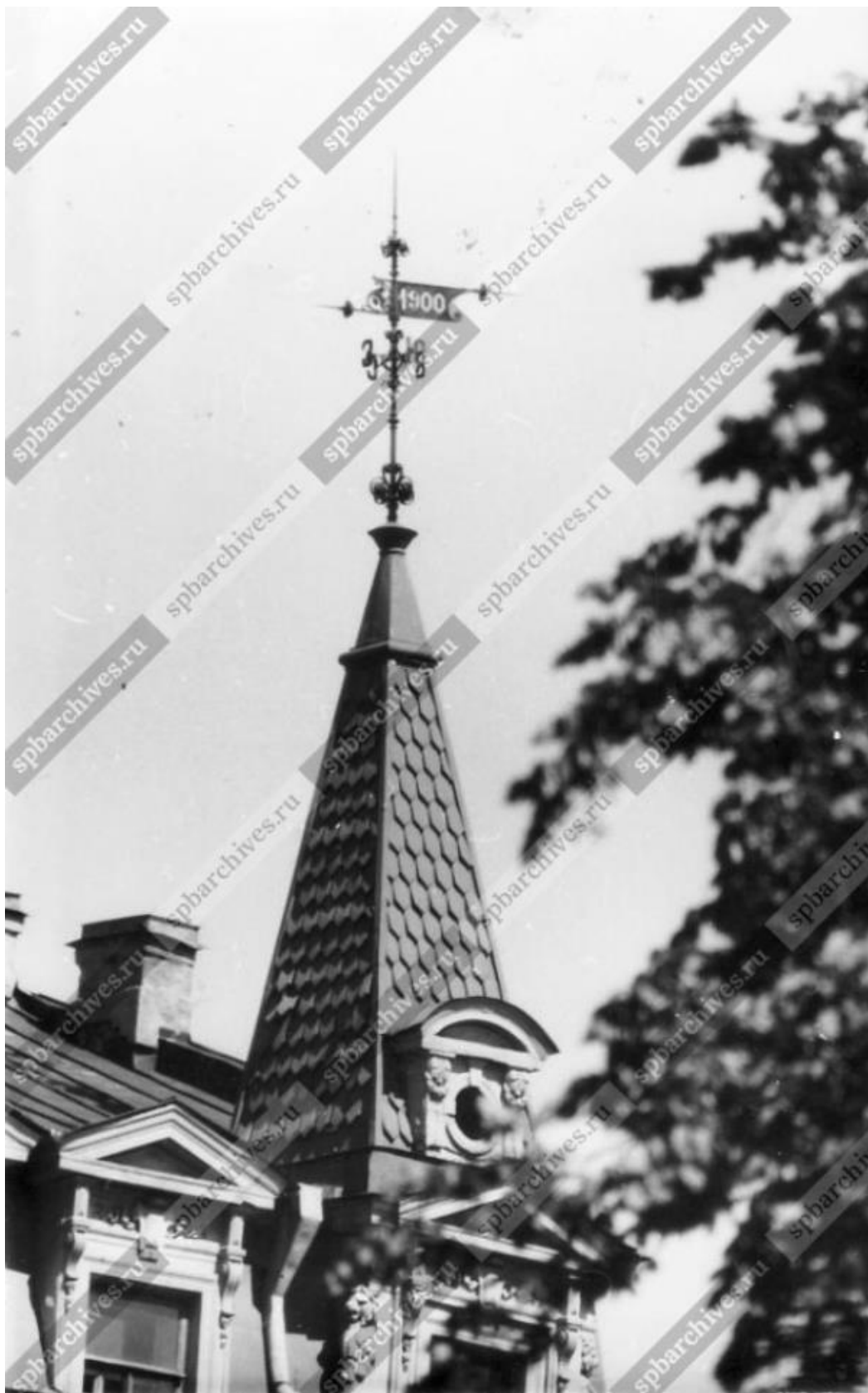
Илл. 33. Вид угловой башни жилого дома № 1 по проспекту Римского-Корсакова с покрытием под «чешую» и завершенной шпилем -флюгером, с просечной датой постройки на металлическом флажке, 1977 г. (источник: ЦГАКФФД СПб. Фотодокумент Ар 222451).
