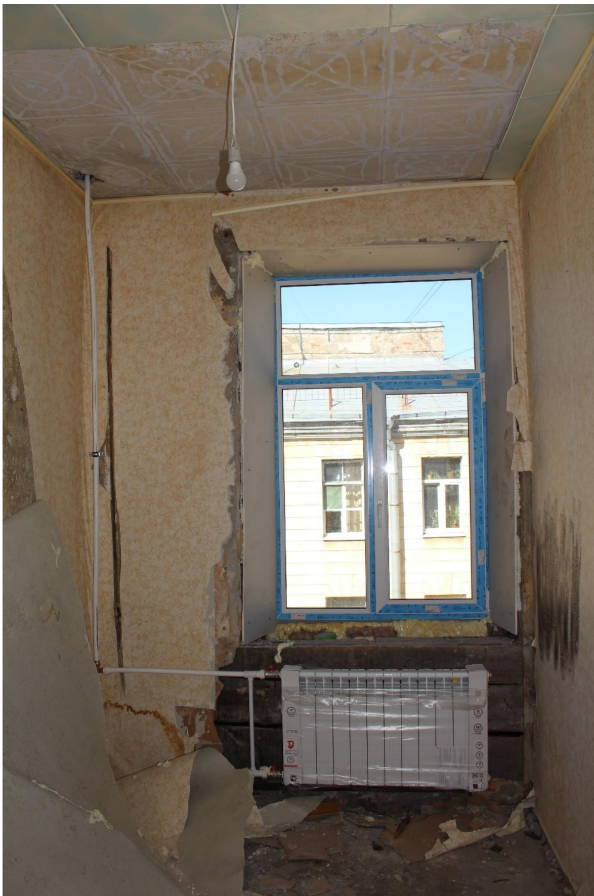
Фото 17. Вид на помещение № 2.
