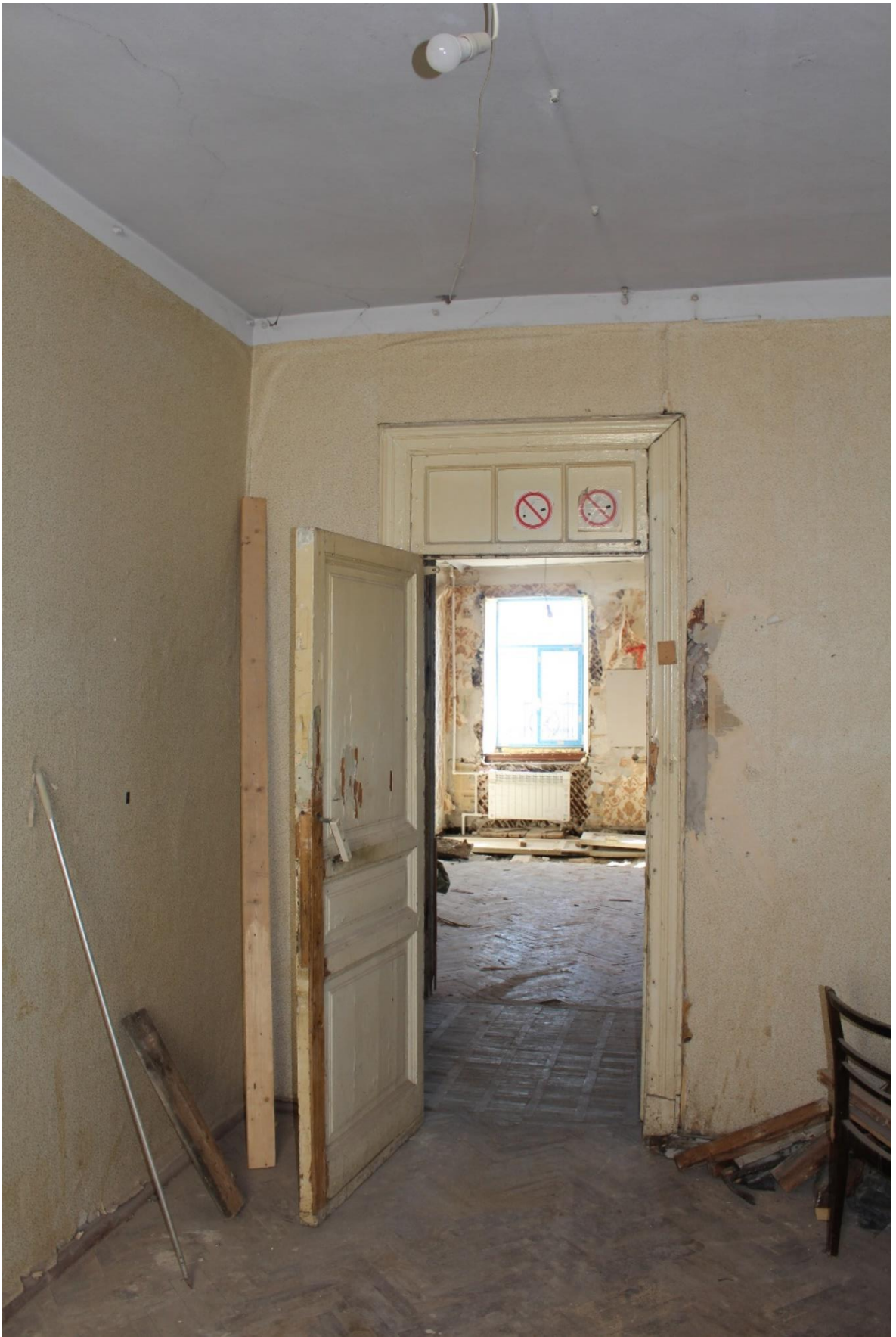
Фото 39. Вид на помещение № 6.
