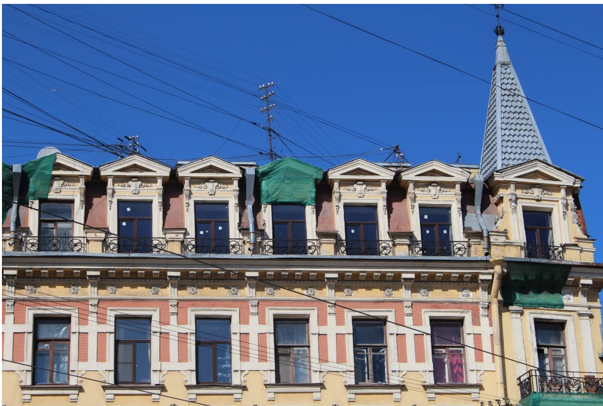
Фото 3. Вид на оконные проемы квартиры № 11 с юга.
