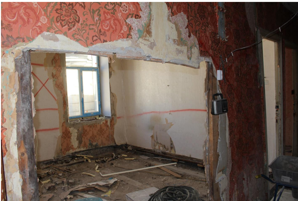
Фото 26. Вид на помещение 4.
