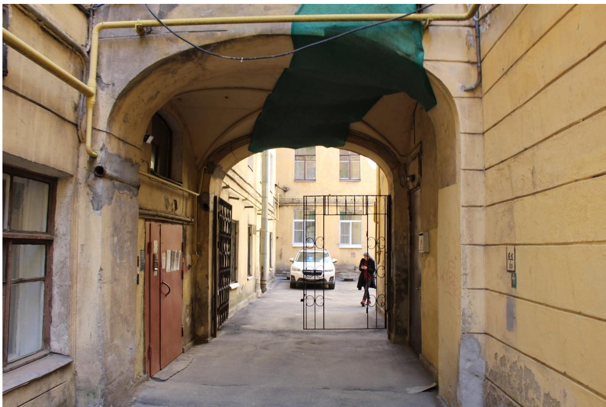
Фото 7. Арка воротного проезда, ведущая в северный двор.
