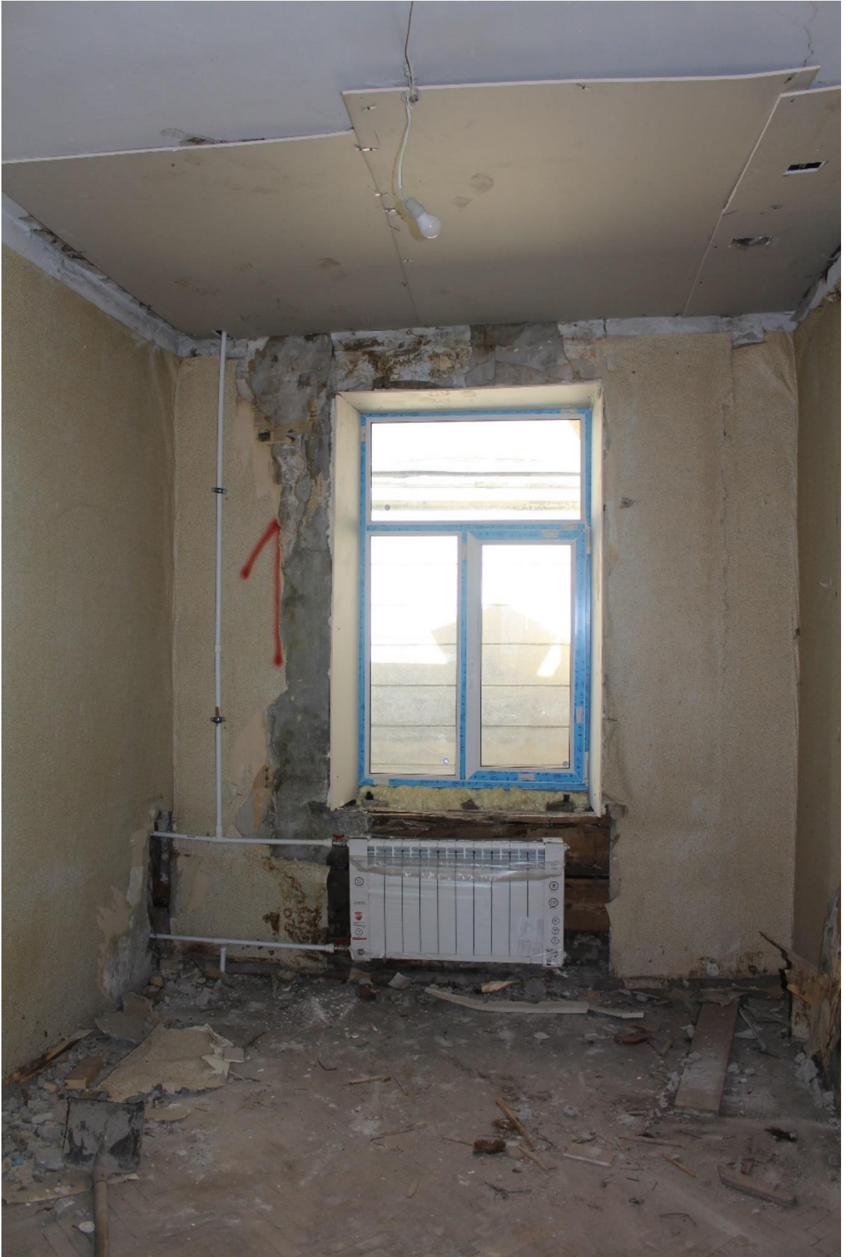
Фото 38. Вид на помещение № 6.
