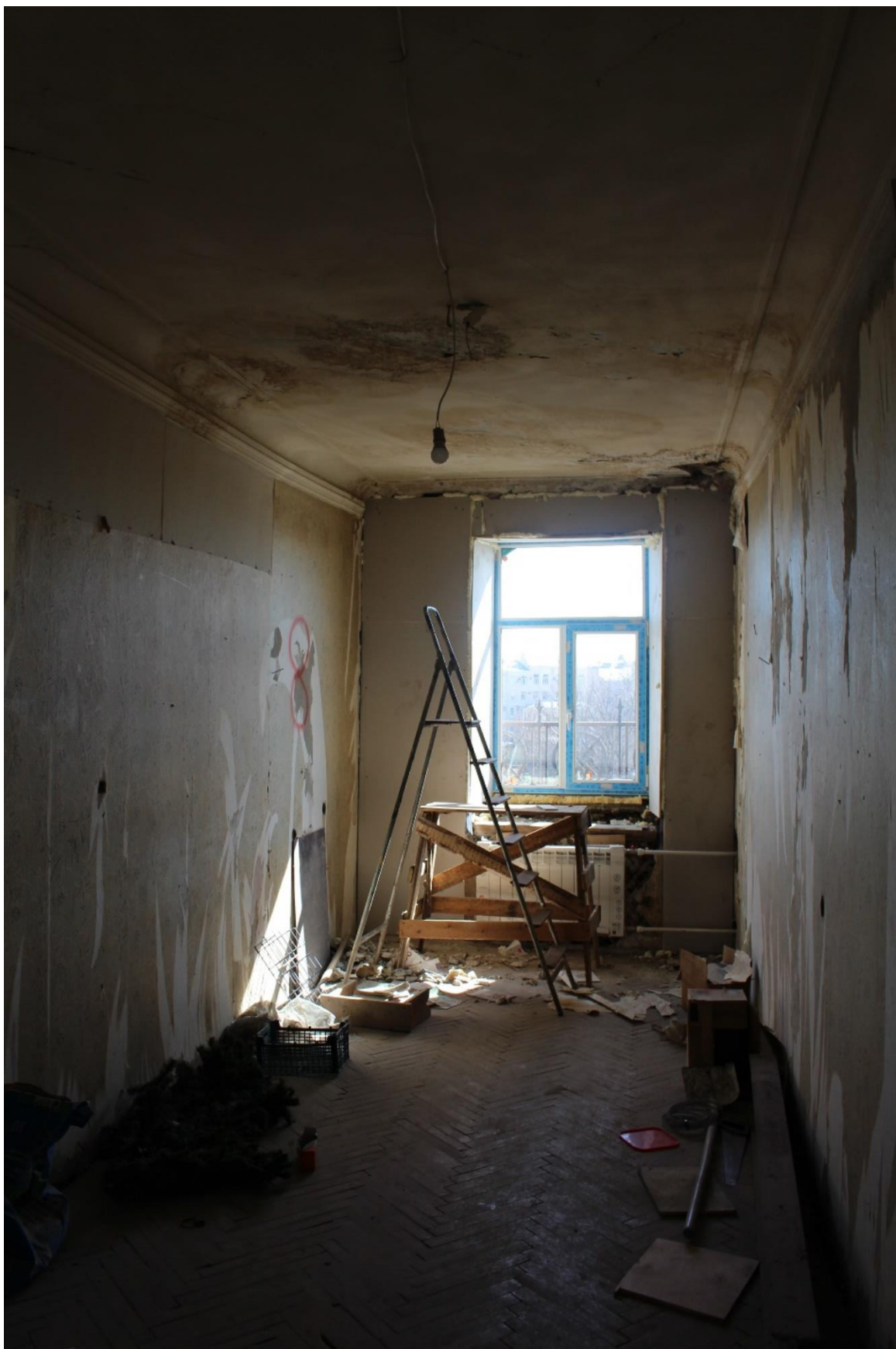
Фото 31. Вид на помещение № 15.
