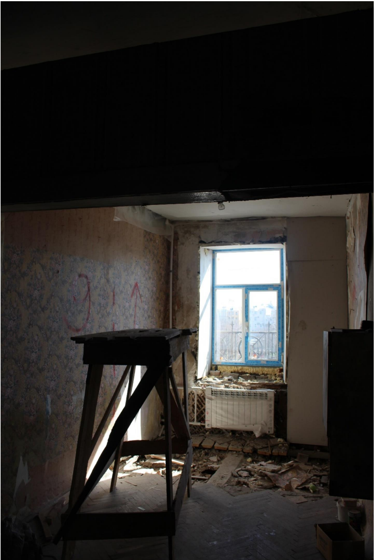
Фото 23. Вид на помещение № 16.
