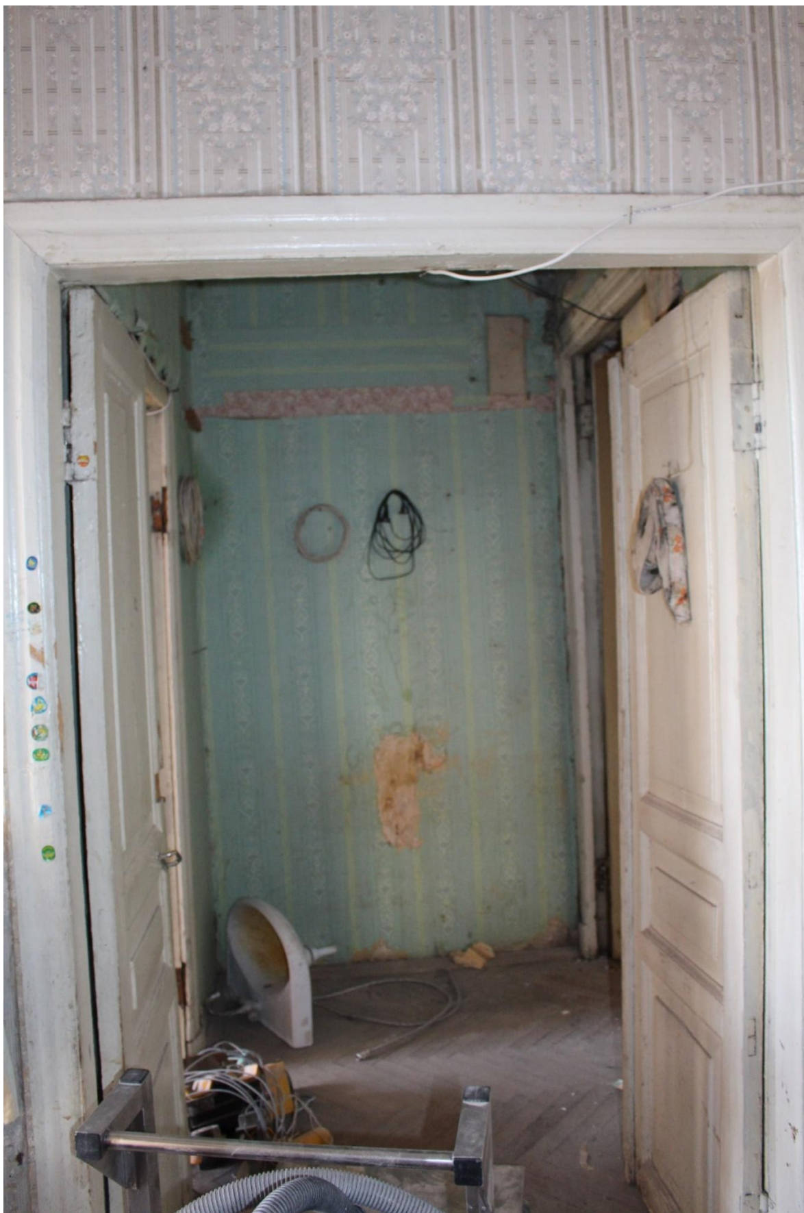
Фото 25. Вид на помещение № 18.
