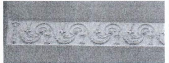
междуэтажные профилированные штукатурные карнизы, крытые железом – местоположение (между 1-2-м этажами, между 2-3-м этажами);
