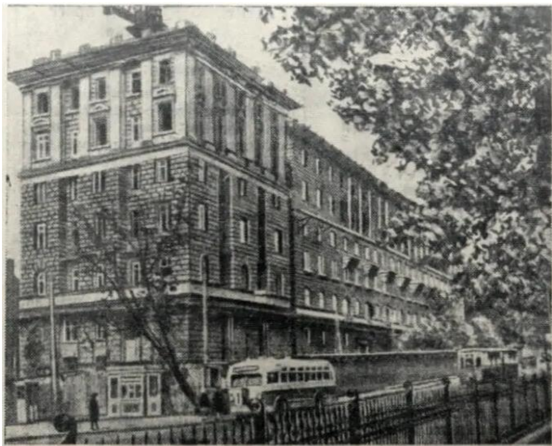
25. Строительство дома у Ланской. (газета «Вечерний Ленинград». 1953 г.).
