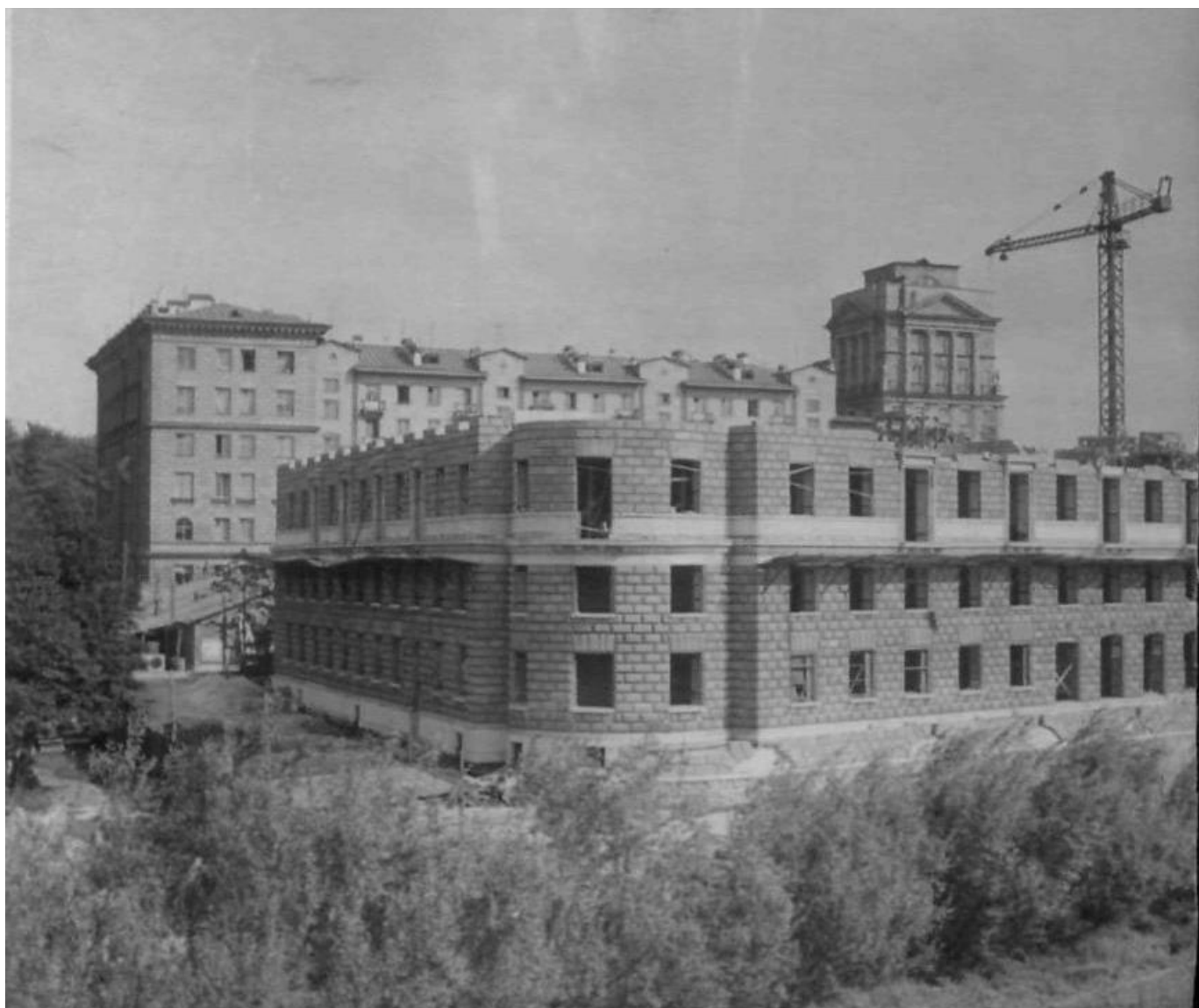
29. ЦГАКФФД СПб. Бр 27594. Строительство новых домов на проспекте Энгельса у железнодорожной станции Ланская. Ок. 1955 г (в аннотации ЦГАКФФД СПб неверно указана датировка – 1970-е гг.).
