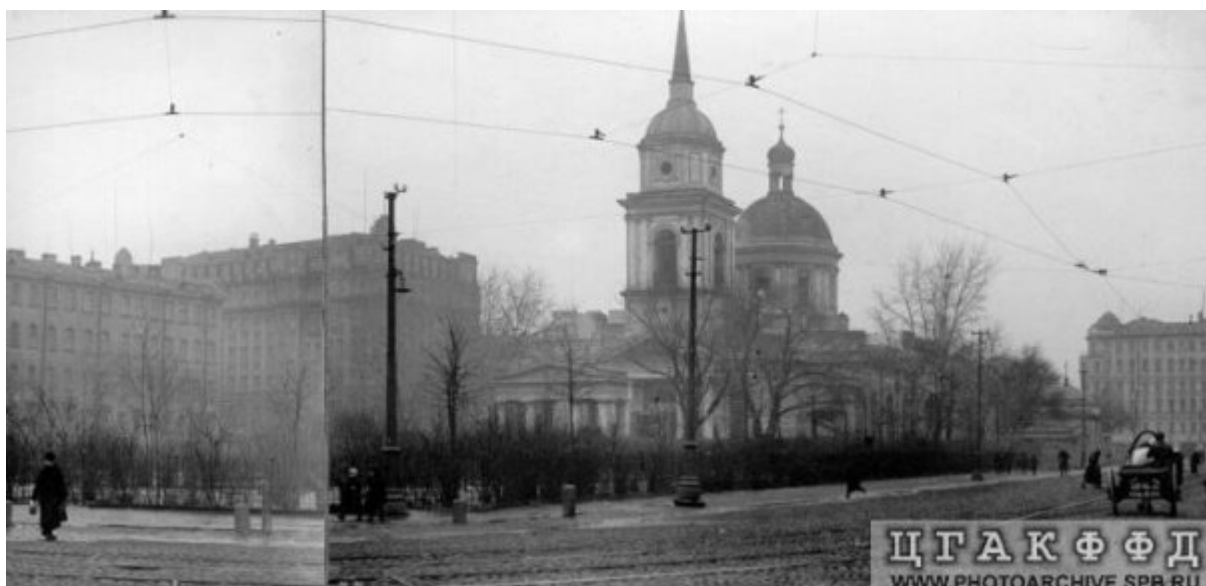
Илл. 84. Покровская церковь. 1934 // ЦГАКФФД СПб. Бр 9052
