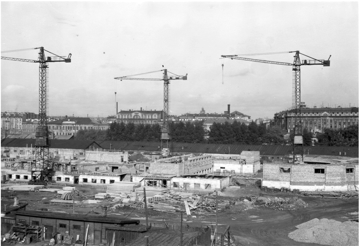
30. ЦГАКФФД СПб. Бр 71406. Вид на строительство здания театра юных зрителей. 1957 г.
