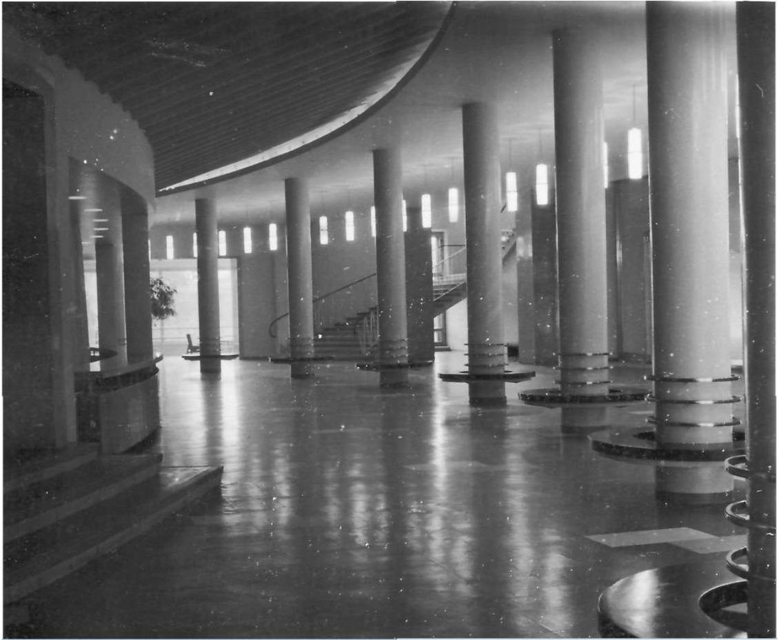
60. ЦГАКФФД СПб. Бр 71337. Общий вид фойе первого этажа театра юных зрителей. Архитектор А.В. Жук, 1962 г.
