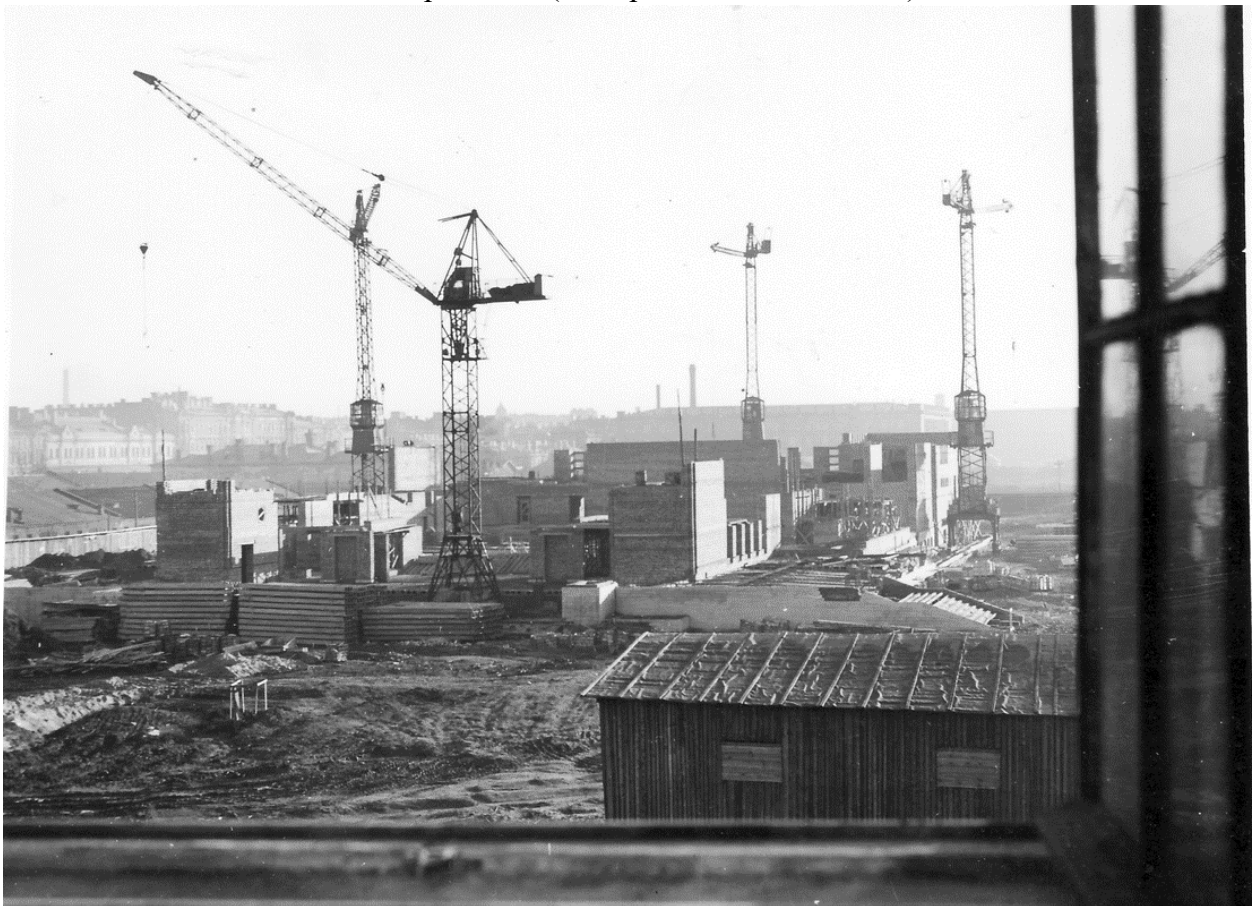
33. ЦГАКФФД СПб. Бр 71408. Вид на строительство здания театра юных зрителей. 1958 г.
