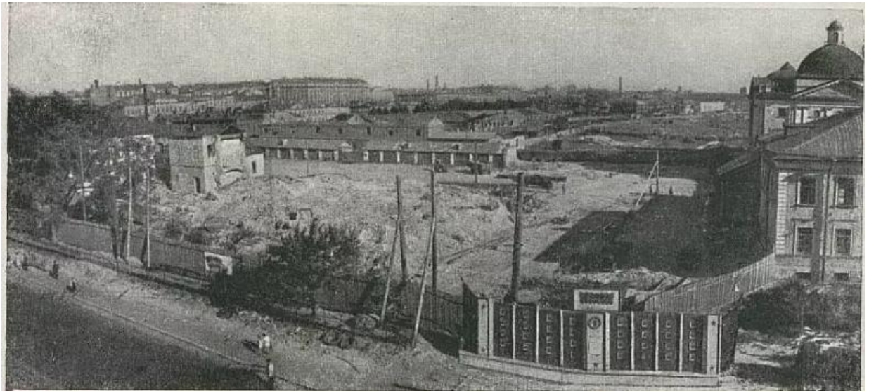
19. На бывшем ипподроме. (по изд.: журнал «Архитектура и строительство Ленинграда» № 1. 1948 год).
