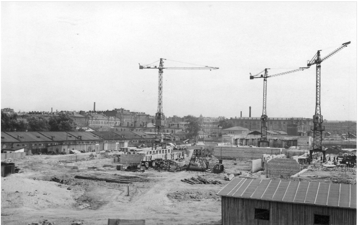
31. ЦГАКФФД СПб. Бр 71407. Вид строительной площадки здания театра юных зрителей. 1957 г.
