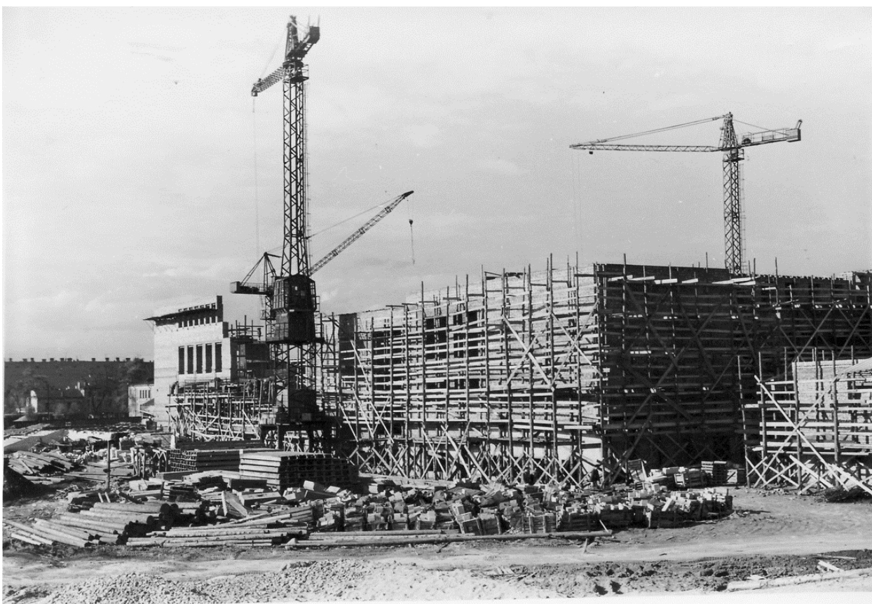
41. ЦГАКФФД СПб. Бр 71422. Установка лесов на фасады здания театра юных зрителей для облицовки стен декоративной плиткой. 1959 г.
