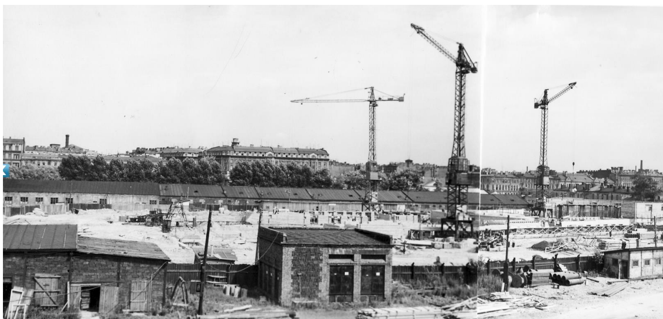
37. ЦГАКФФД СПб. Бр 71412. Общий вид строительной площадки здания театра юных зрителей. (Панорама из 2-х снимков). 1957 г.
