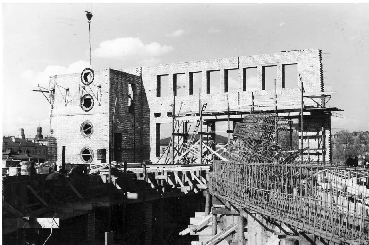
47. ЦГАКФФД СПб. Бр 71427. Монтаж конструкций зрительного зала театра юных зрителей. 1959 г.
