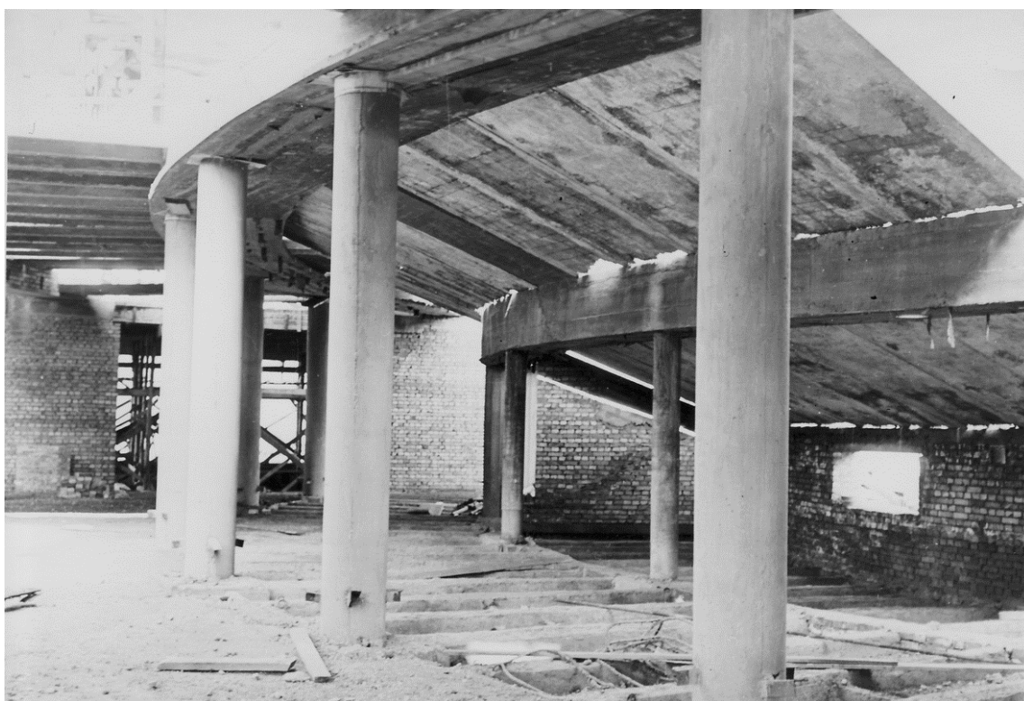
49. ЦГАКФФД СПб. Бр 71449. Вид на конструкции зрительного зала театра юных зрителей. 1958 г.
