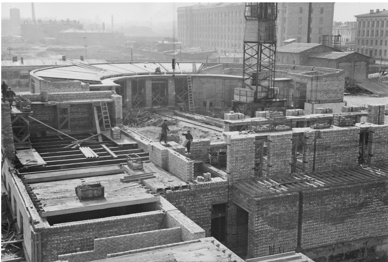
34. ЦГАКФФД СПб. Бр 71430. Общий вид строительной площадки здания театра юных зрителей. 1957 г.
