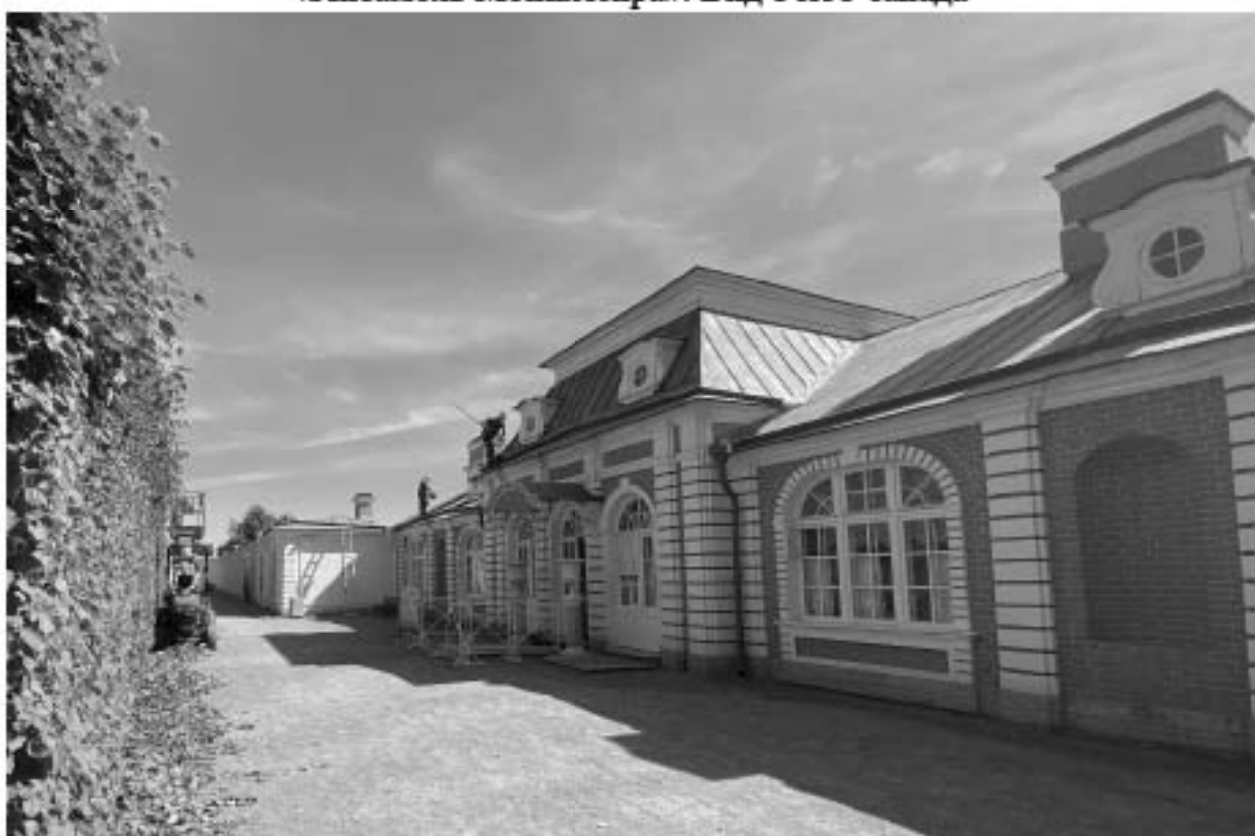
Фото 2. Западный фасад Банного корпуса. Вид с юго-запада
