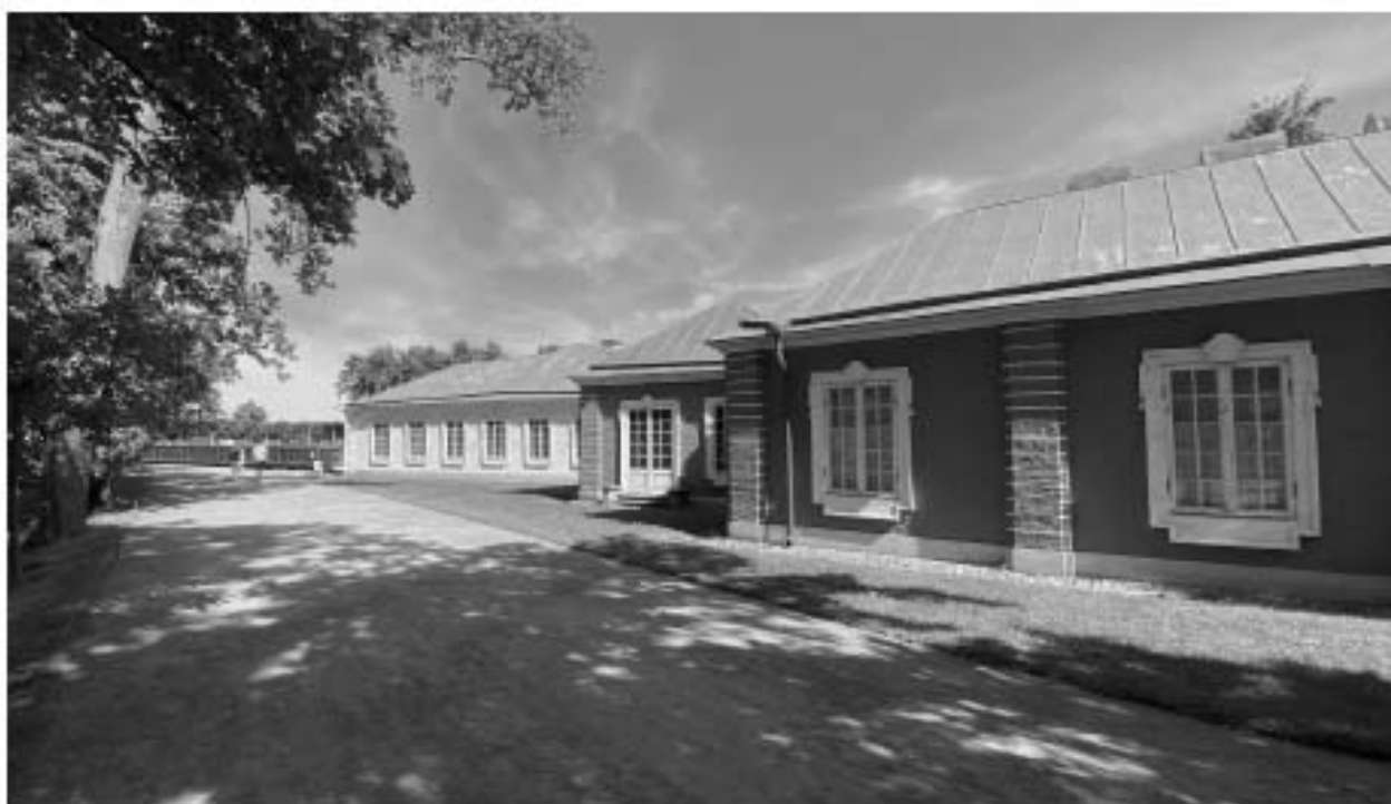
Фото 5. Южные фасады Ассамблейного зала и Кухонного корпуса. Вид с юга
