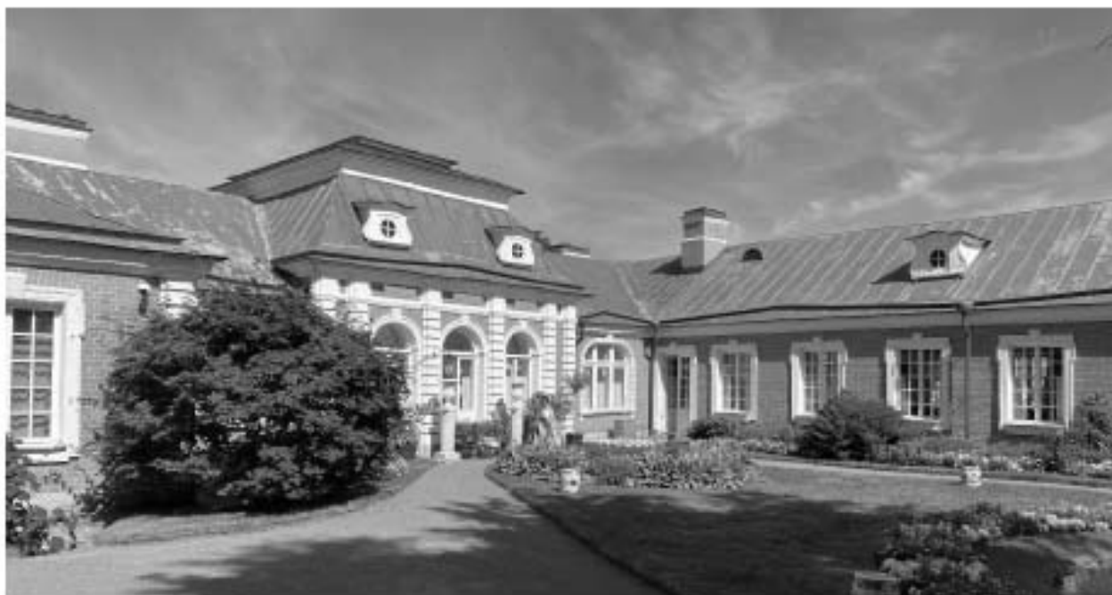
Фото 7. Восточный фасад Банного корпуса, южный фасад Мыльни. Вид с юго-востока
