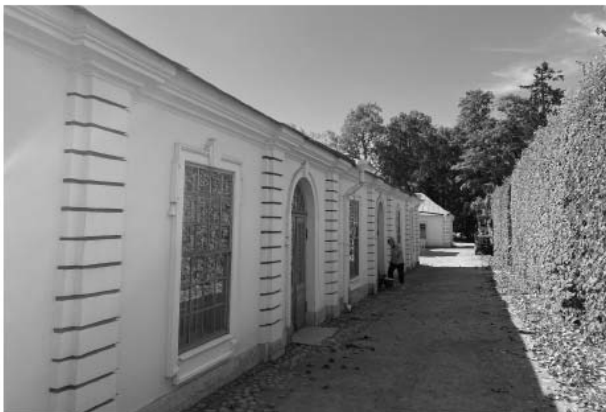
Фото 3. Западный фасад Восточного Служительского флигеля. Вид с северо-запада
