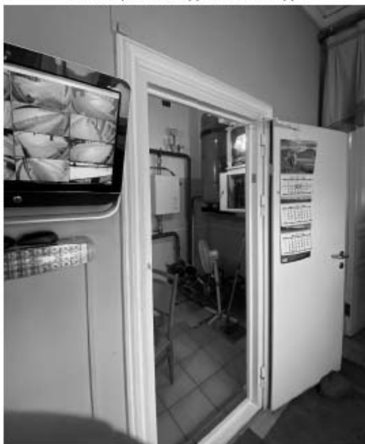
Фото 56. Банный корпус. Помещение № 29 согласно плану ПИБ. Котельная. Вид с северо-запада
