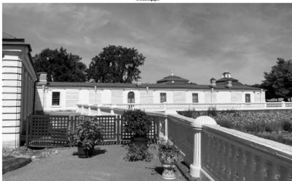
Фото 4. Восточный фасад Восточного Служительского флигеля, северный фасад Мыльни. Вид с юго-востока
