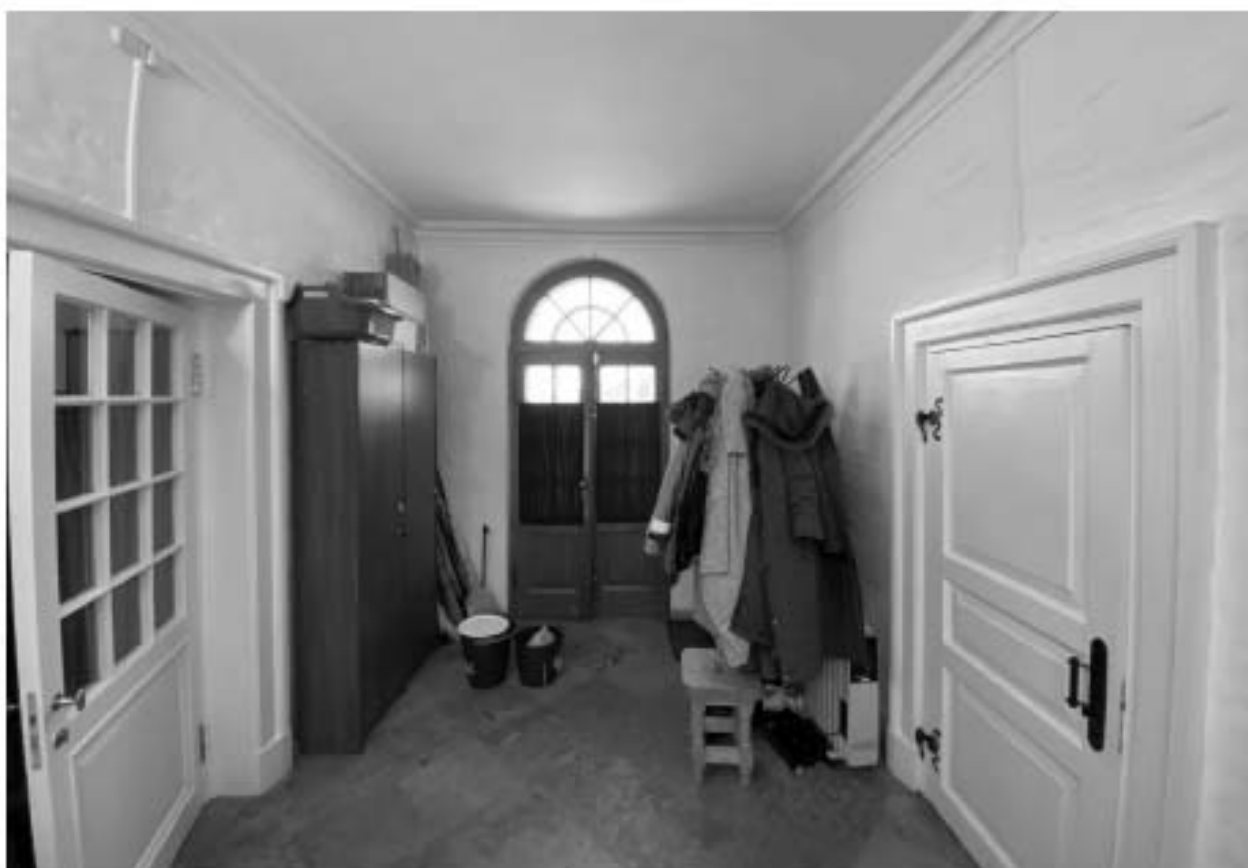
Фото 17. Восточный Служительский флигель. Помещение № 8 согласно плану ПИБ. Вид с северо-запада
