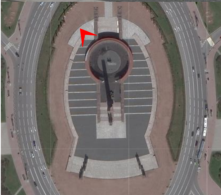
37. Вид с северо-запада
