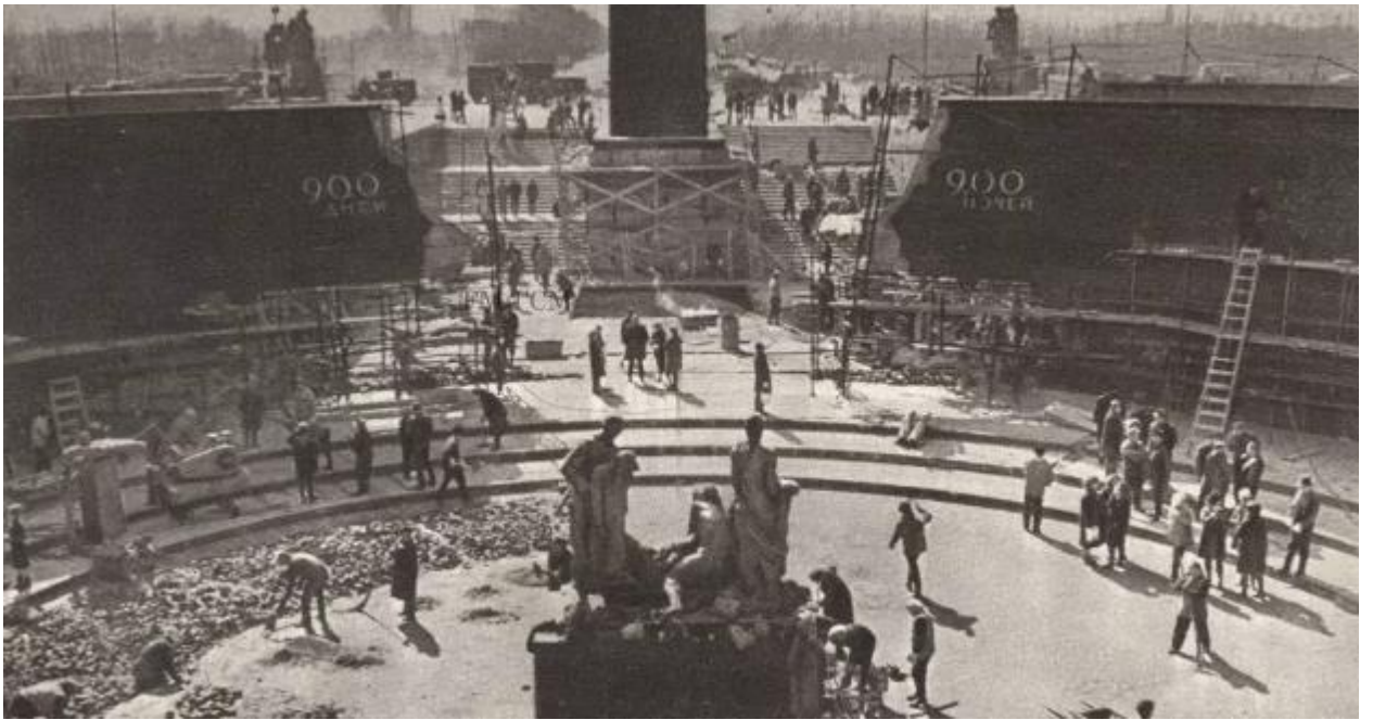
51. Строительство Монумента Героическим защитникам Ленинграда. Фото 1975 г.
