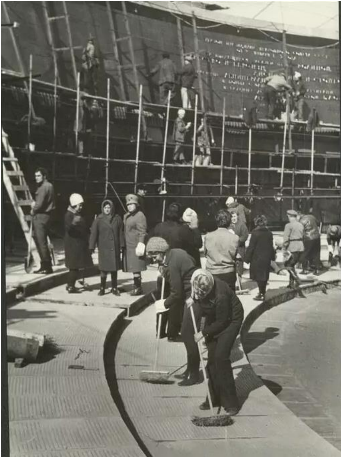
50. Строительство Монумента Героическим защитникам Ленинграда. Фото 1975 г.
