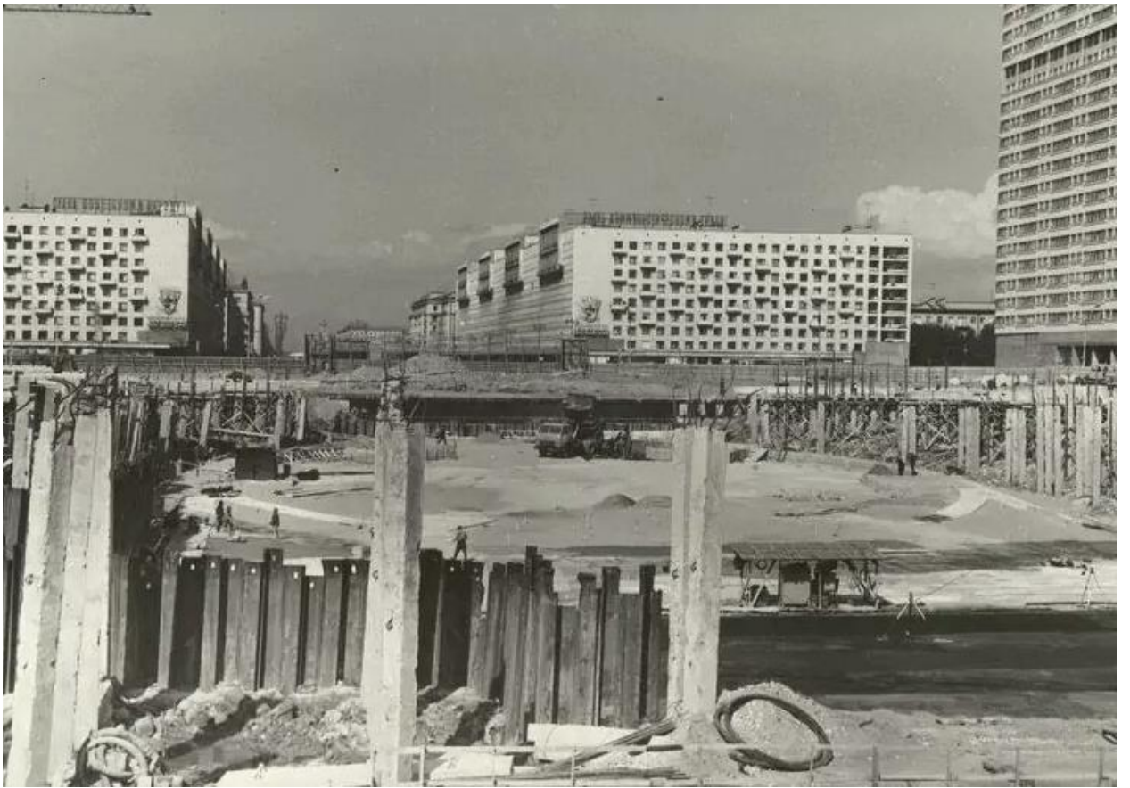
48. Строительство Монумента Героическим защитникам Ленинграда. Закладка фундамента. Фото 1974 г.
