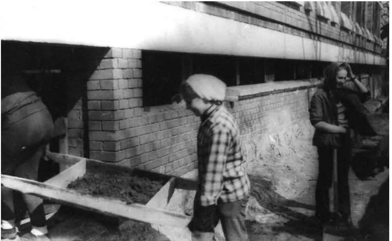
63. Фото 1970-е гг. Строительство пятого корпуса
