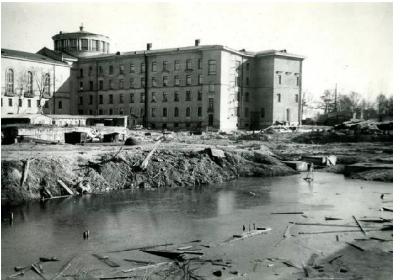
53. Фото около 1970 г. Начало строительства пятого корпуса
