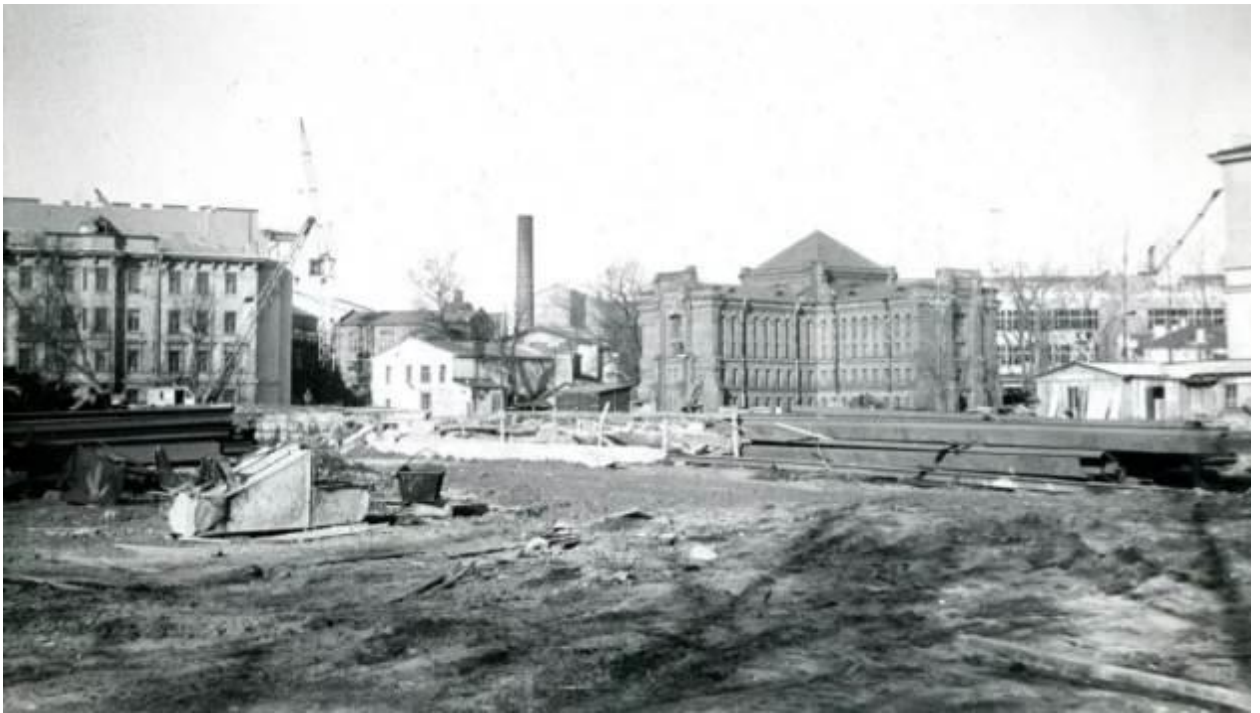
56. Фото около 1970 г. Начало строительства пятого корпуса
