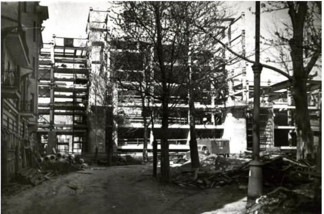
61. Фото 1970-е гг. Строительство пятого корпуса
