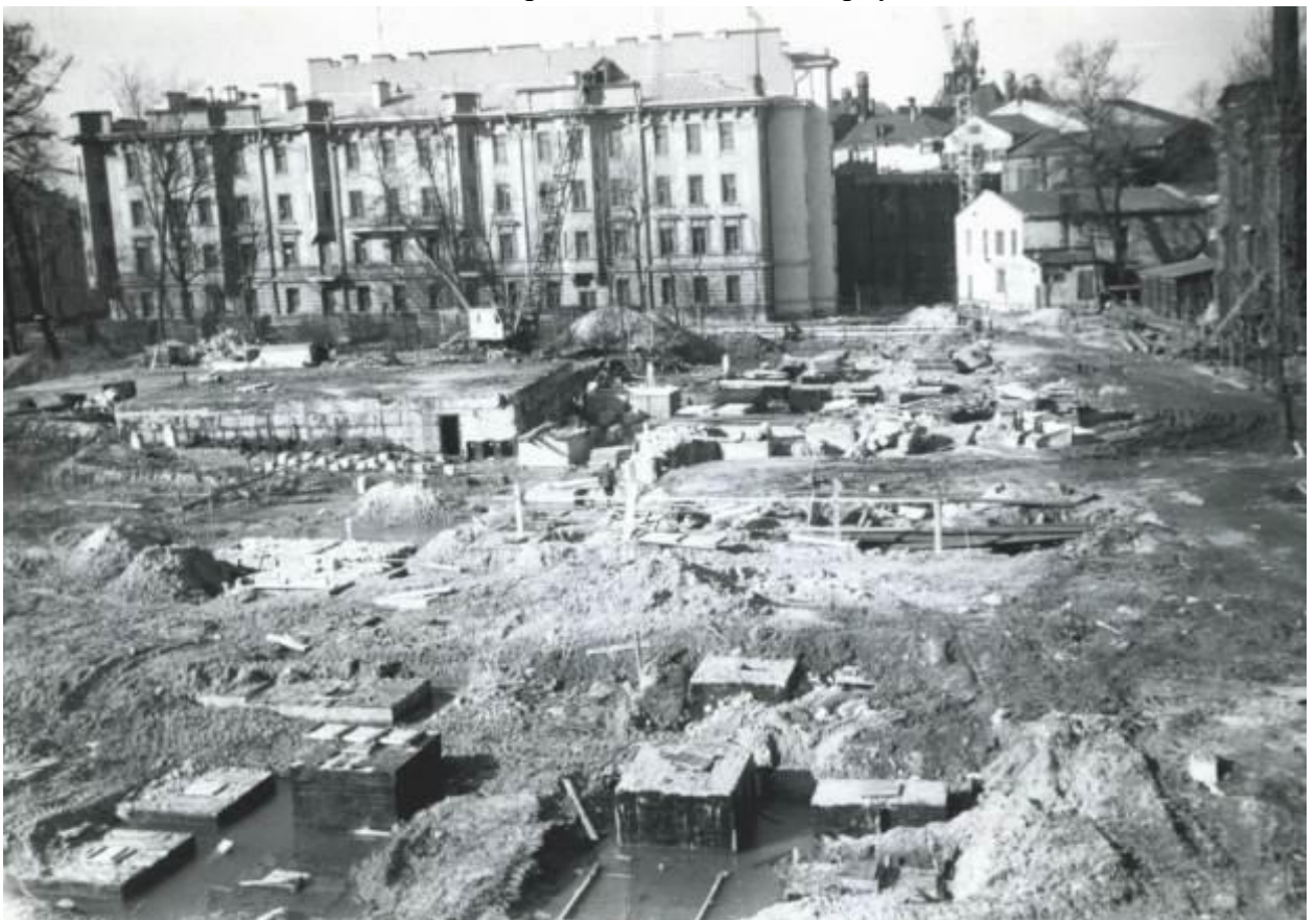
57. Фото около 1970 г. Начало строительства пятого корпуса
