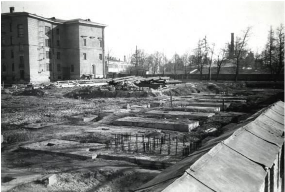
54. Фото около 1970 г. Начало строительства пятого корпуса
