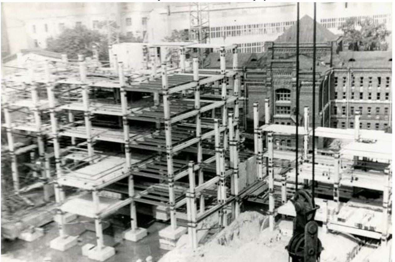
59. Фото 1970-е гг. Строительство пятого корпуса
