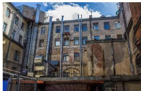
профилированный межэтажный карниз; профилированный карниз над оконными проемами 3-го этажа.
