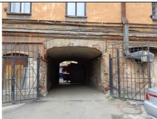
исторические оконные, дверные и воротные проемы: на уровне 1-го этажа – местоположение, конфигурация (прямоугольные с лучковыми перемычками);
