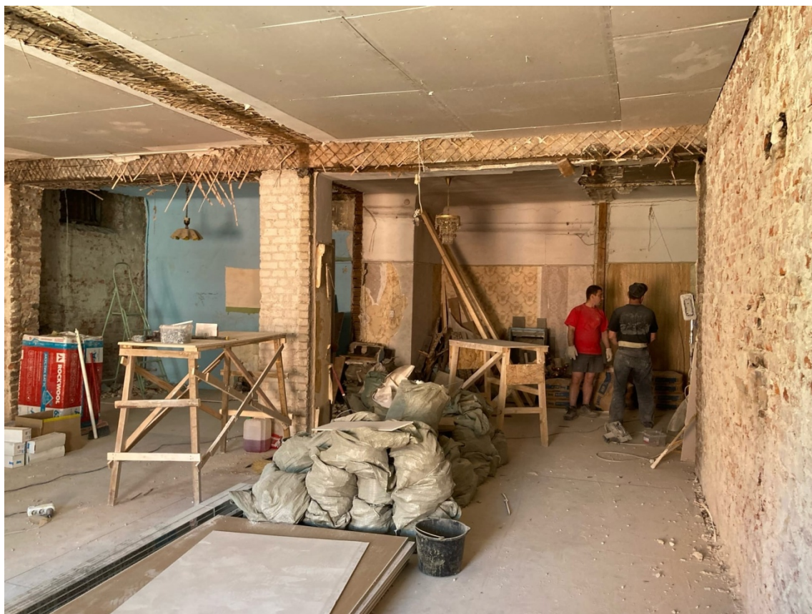
Фото 20. Интерьер квартиры №132 выявленного объекта культурного наследия «Жилые корпуса» (в составе «Комплекс построек Придворно-конюшенного ведомства»)
