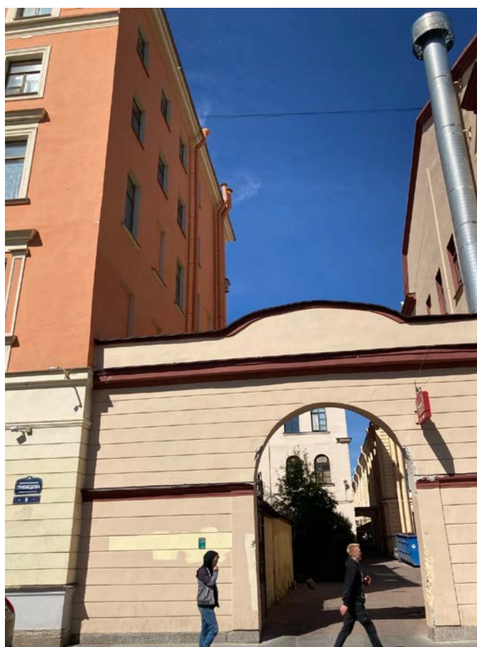
Фото 6. Фрагмент лицевого фасада выявленного объекта культурного наследия «Жилые корпуса» (в составе «Комплекс построек Придворно-конюшенного ведомства»)
