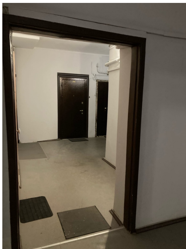
Фото 24. Интерьер 5 этажа выявленного объекта культурного наследия «Жилые корпуса» (в составе «Комплекс построек Придворно-конюшенного ведомства»)
