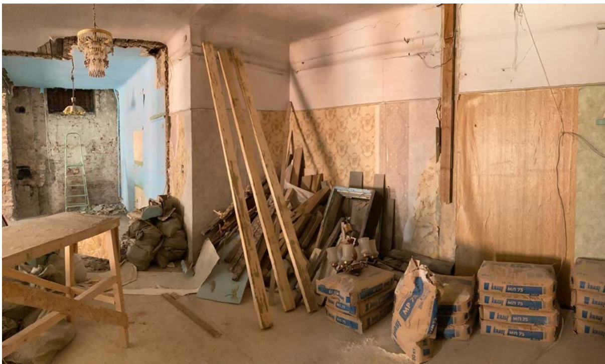
Фото 15. Интерьер квартиры №132 выявленного объекта культурного наследия «Жилые корпуса» (в составе «Комплекс построек Придворно-конюшенного ведомства»)
