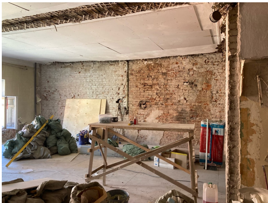
Фото 18. Интерьер квартиры №132 выявленного объекта культурного наследия «Жилые корпуса» (в составе «Комплекс построек Придворно-конюшенного ведомства»)
