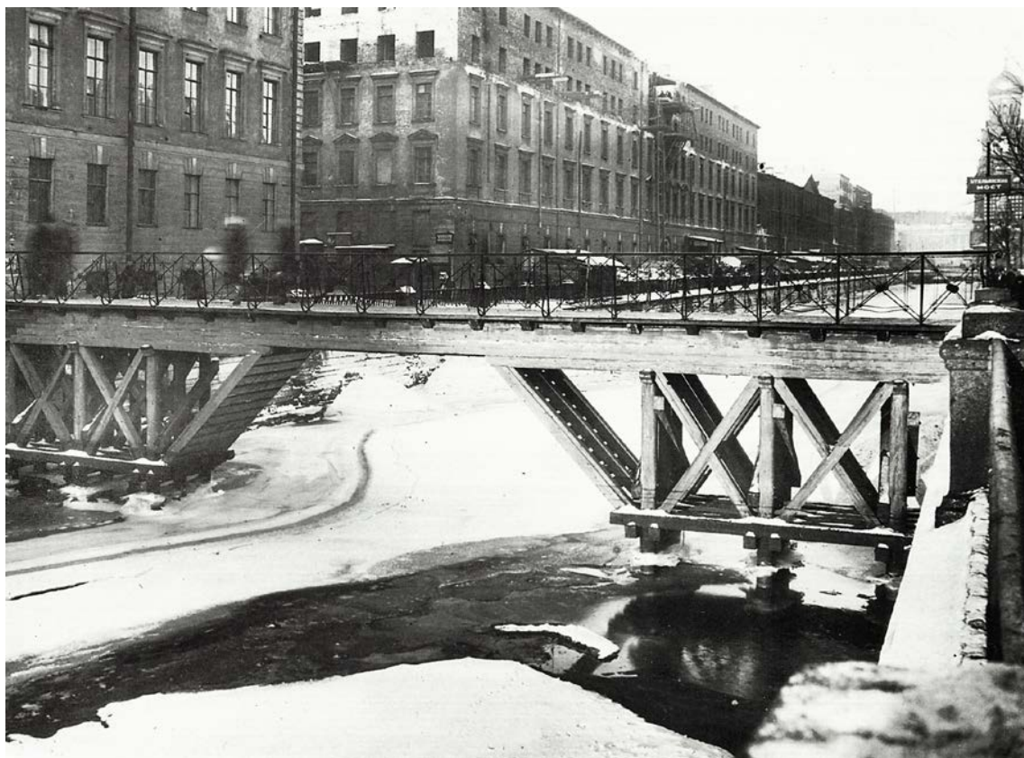
15. Итальянский мост до реконструкции. 1932-1933 г.г. // Фотоальбом "Петербургские мосты", Г.И.Богданов. Санкт-Петербург. 2006 год.
