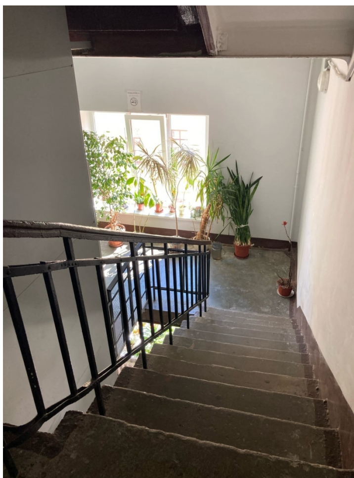
Фото 26. Лестничная клетка (5ЛК) 5 этажа выявленного объекта культурного наследия «Жилые корпуса» (в составе «Комплекс построек Придворно-конюшенного ведомства»)
