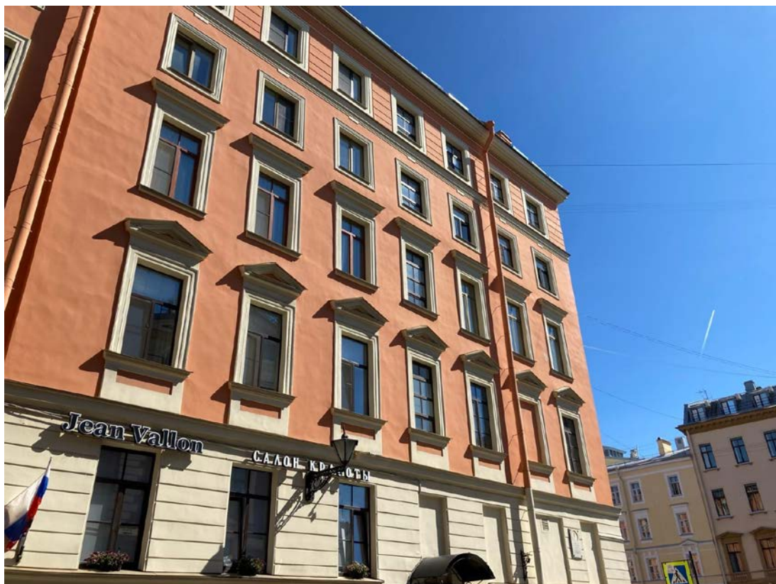
Фото 3. Лицевой фасад выявленного объекта культурного наследия «Жилые корпуса» (в составе «Комплекс построек Придворно-конюшенного ведомства»)
