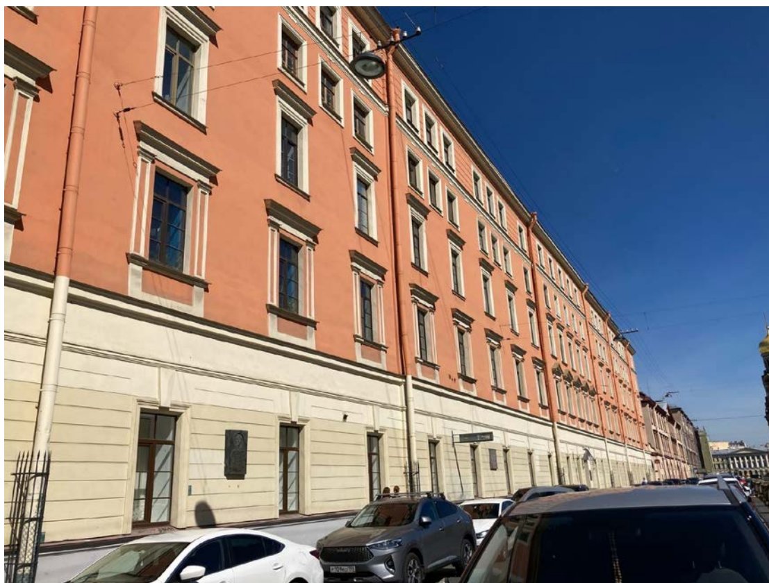
Фото 4. Фрагмент лицевого фасада выявленного объекта культурного наследия «Жилые корпуса» (в составе «Комплекс построек Придворно-конюшенного ведомства»)
