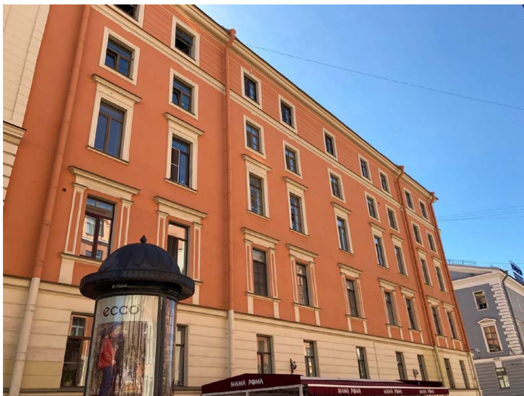
Фото 8. Лицевой фасад выявленного объекта культурного наследия «Жилые корпуса» (в составе «Комплекс построек Придворно-конюшенного ведомства»)
