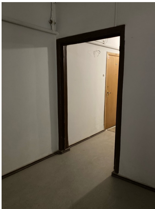
Фото 23. Интерьер 5 этажа выявленного объекта культурного наследия «Жилые корпуса» (в составе «Комплекс построек Придворно-конюшенного ведомства»)
