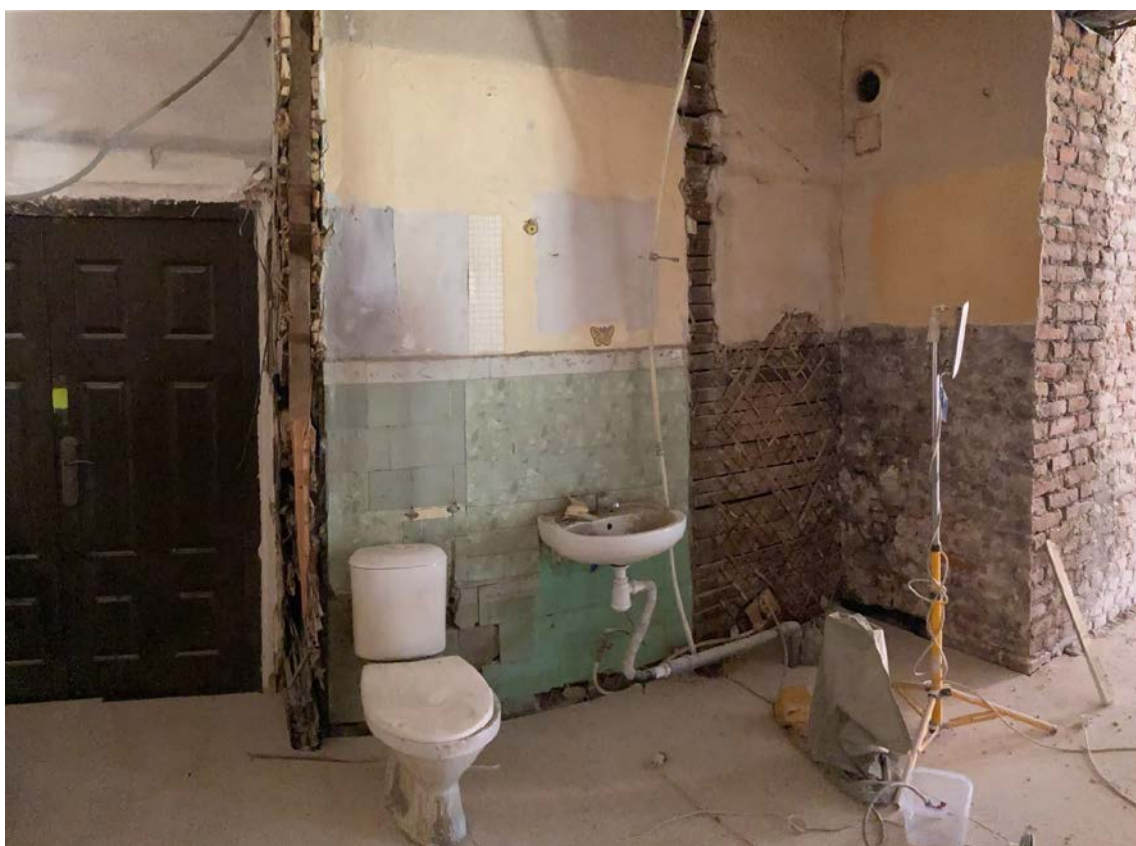
Фото 14. Интерьер квартиры №132 выявленного объекта культурного наследия «Жилые корпуса» (в составе «Комплекс построек Придворно-конюшенного ведомства»)
