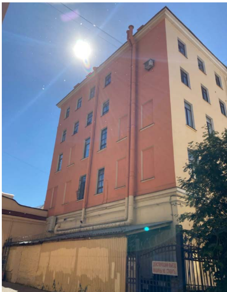
Фото 7. Лицевой фасад выявленного объекта культурного наследия «Жилые корпуса» (в составе «Комплекс построек Придворно-конюшенного ведомства»)
