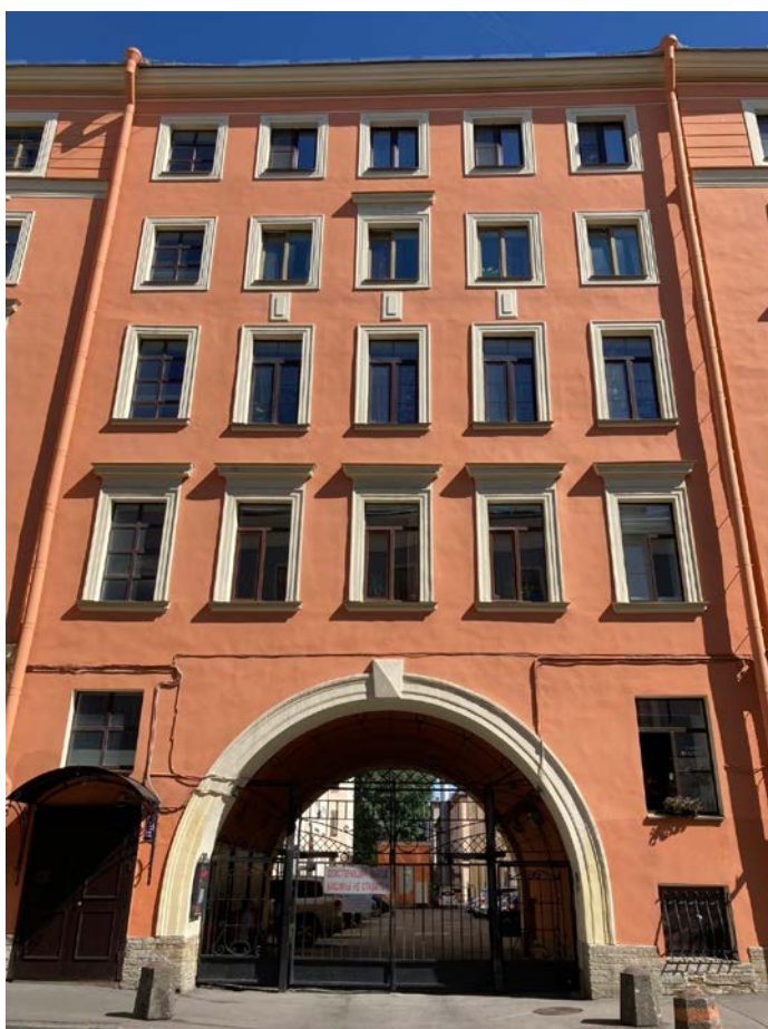
Фото 2. Фрагмент лицевого фасада выявленного объекта культурного наследия «Жилые корпуса» (в составе «Комплекс построек Придворно-конюшенного ведомства»), воротный проезд
