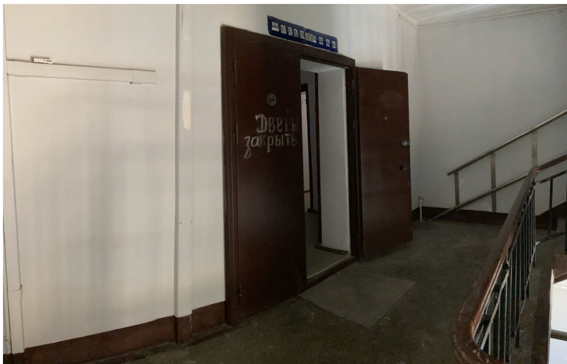
Фото 25. Интерьер 5 этажа выявленного объекта культурного наследия «Жилые корпуса» (в составе «Комплекс построек Придворно-конюшенного ведомства»)
