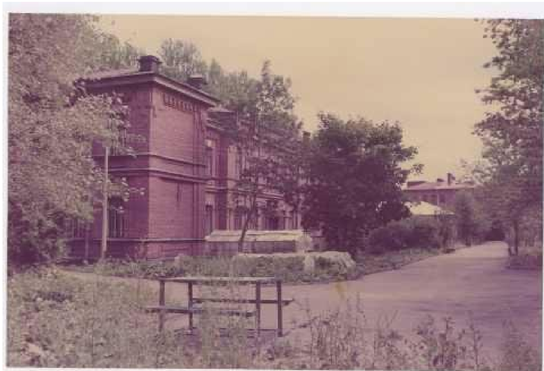
18. Дворовый фасад больницы при Александровском заводе Николаевской ж/д (ныне госпиталь) по адресу: ул. Цимбалина, 13. Фотография. Автор неизвестен. Июль 1999 г. // Источник: Госкаталог.рф. № 41274866. URL: https://goskatalog.ru/portal/#/collections?id=41498258 (дата обращения: 04.09.2023).
