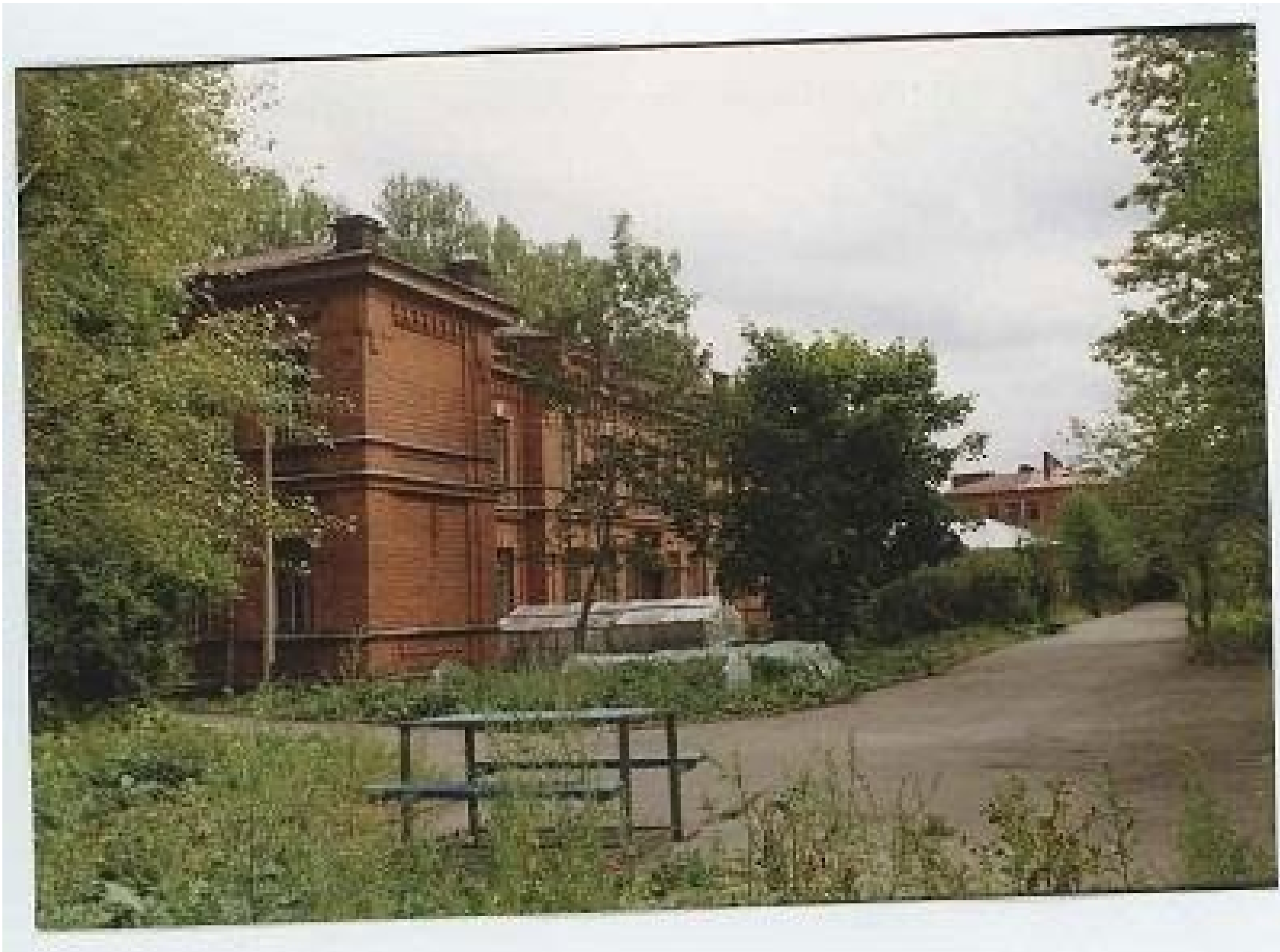
19. Дворовый фасад больницы при Александровском заводе Николаевской ж /д (ныне госпиталь) по адресу: ул. Цимбалина, 13. Фотография. Автор фото – Попов А.А. Август 1999 г. // Источник: Госкаталог.рф. № 41325154. URL: https://goskatalog.ru/portal/#/collections?id=41549494 (дата обращения: 04.09.2023).
