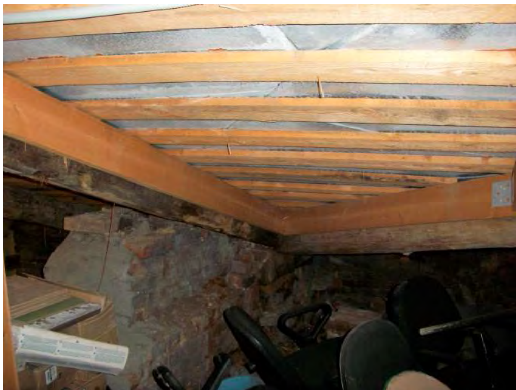
15. Объект культурного наследия регионального значения «Городской дом начальных училищ им. М.Г. Петрова», по адресу: Санкт-Петербург, Малоохтинский проспект, дом 51, литера А. Чердачное помещение. Дата съемки: 19.09.2022г.
