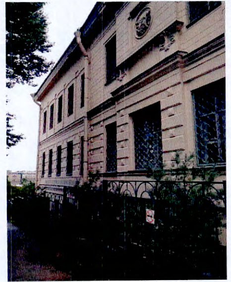
3. Фрагмент южного фасада объекта культурного наследия.
