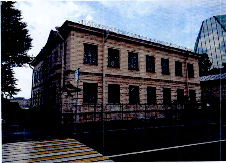
2. Вид на восточный фасад объекта культурного наследия.
