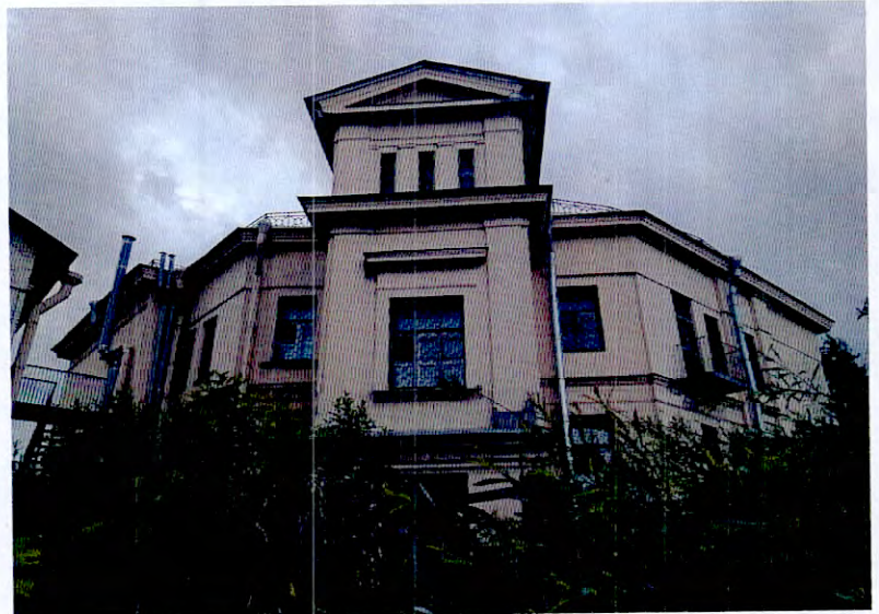
5. Вид с северо-западной стороны на объект культурного наследия. Фрагмент фасада.
