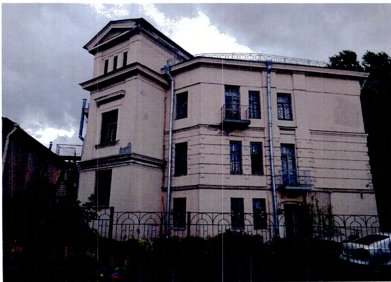
1. Вид на объект культурного наследия с западной стороны.
