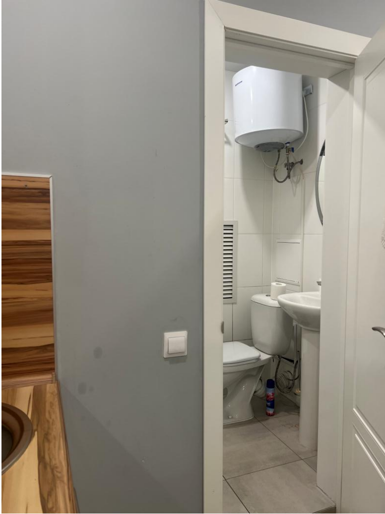
9. Помещение 3-Н. Фрагмент.
