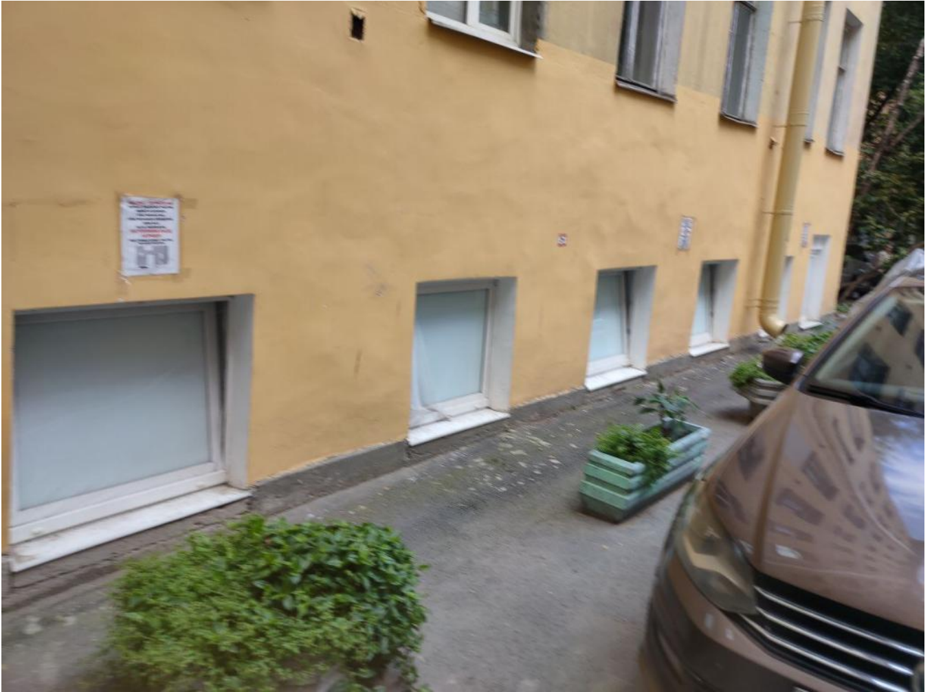
3. Фрагмент дворового фасада. Окна помещений 3-Н и 4-Н, выходящие во двор.
