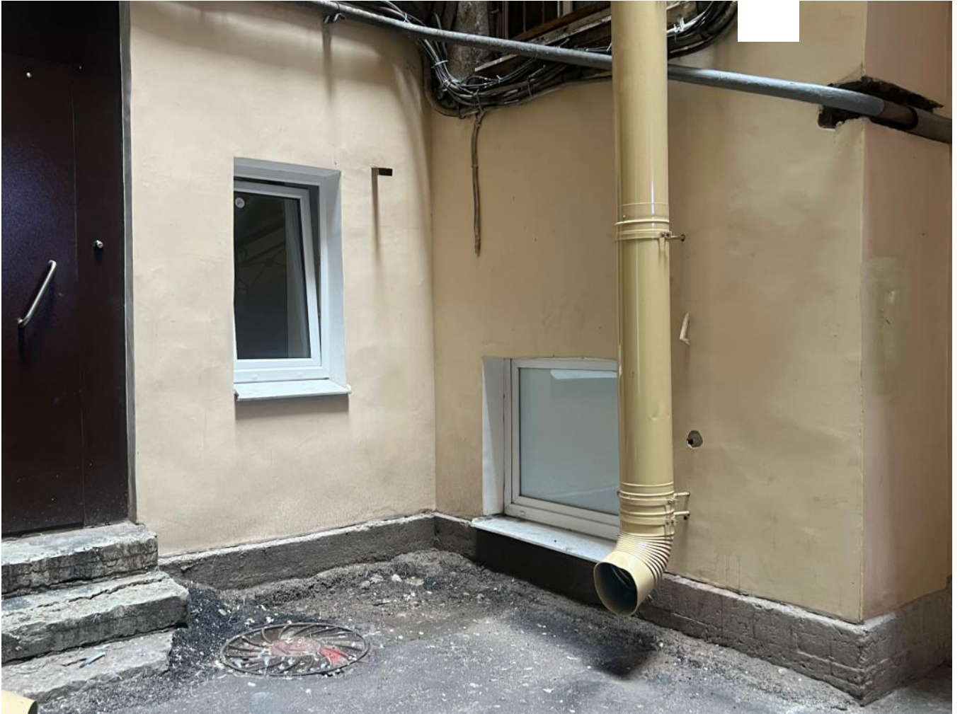
5. Фрагмент внутреннего двора. Справа — оконный проем помещения 4-Н.
