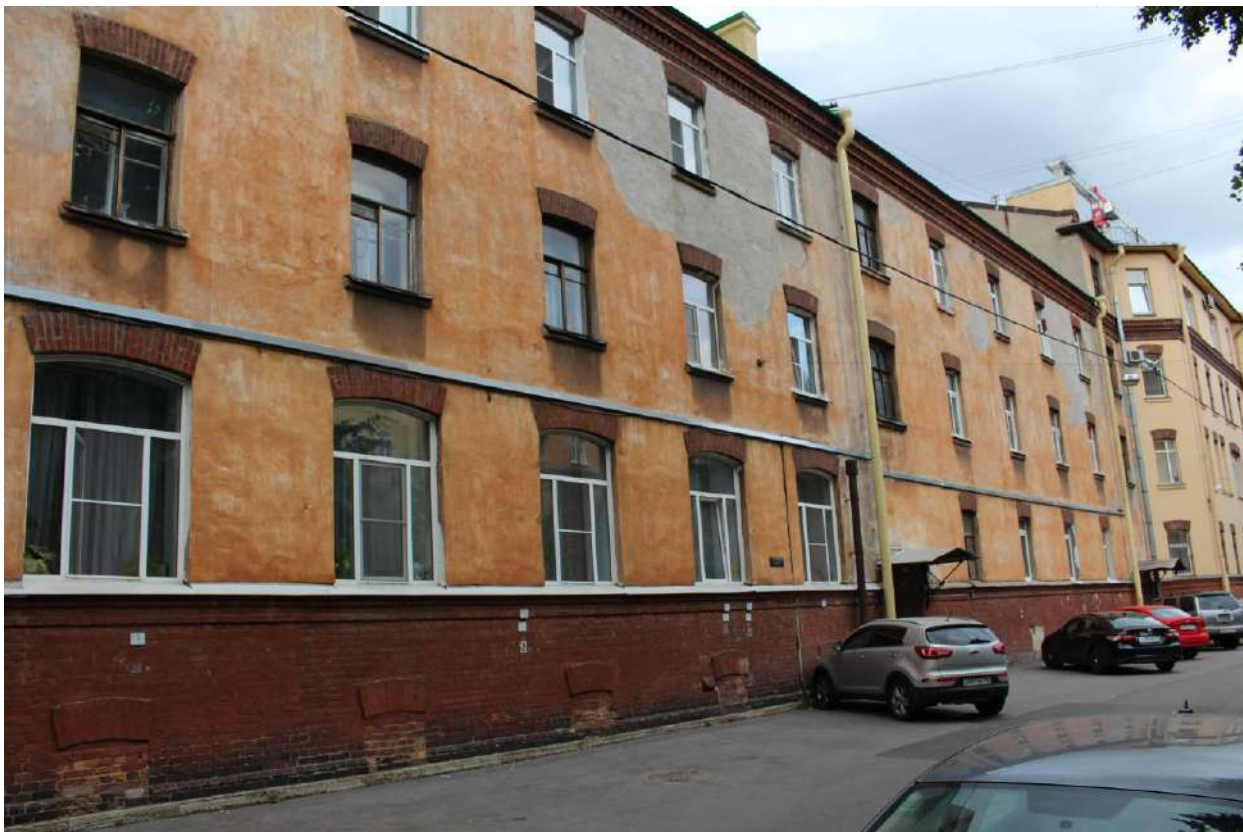
Фото 3. Вид на лицевой фасад жилого дома по адресу: Санкт-Петербург, Лесной пр., 20, корп. 10, лит. Е с юго-запада.
