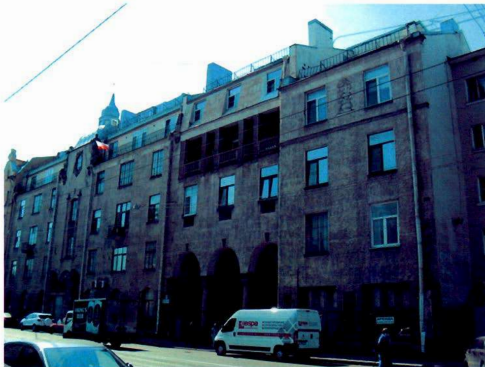
Фото 1. Вид на восточный фасад.
