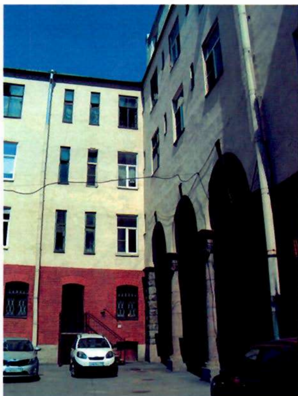
Фото 4. Вид на западный и южный фасады.
