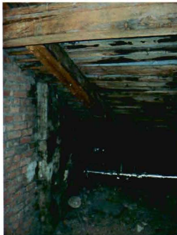
Фото 4. Чердачные помещения. Фрагмент.
