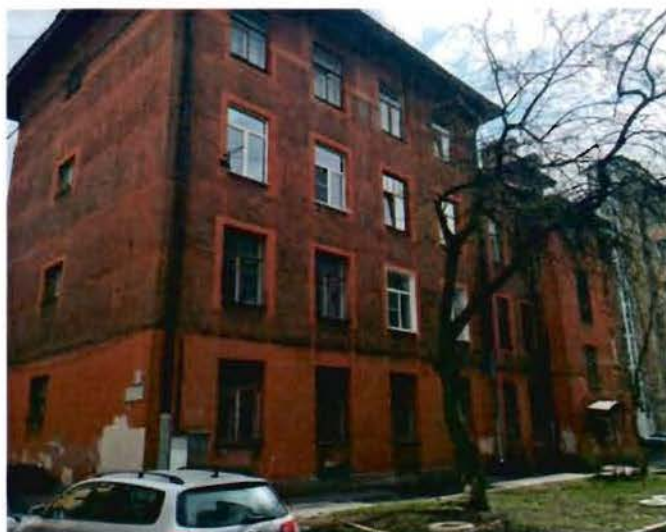
Фото 6. Вид на западный и северный фасады.
