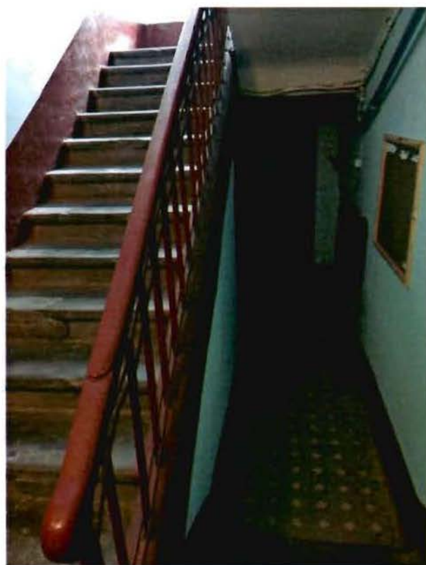
Фото 8. Лестница в южной части здания. Фрагмент. Метлахская плитка.
