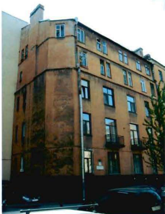
Фото 26. Вид на северный фасад. Фрагмент.
