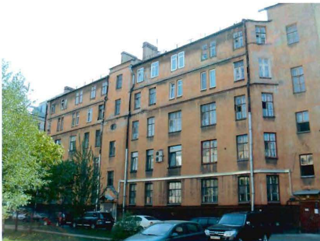
Фото 25. Вид на северный фасад. Фрагмент.
