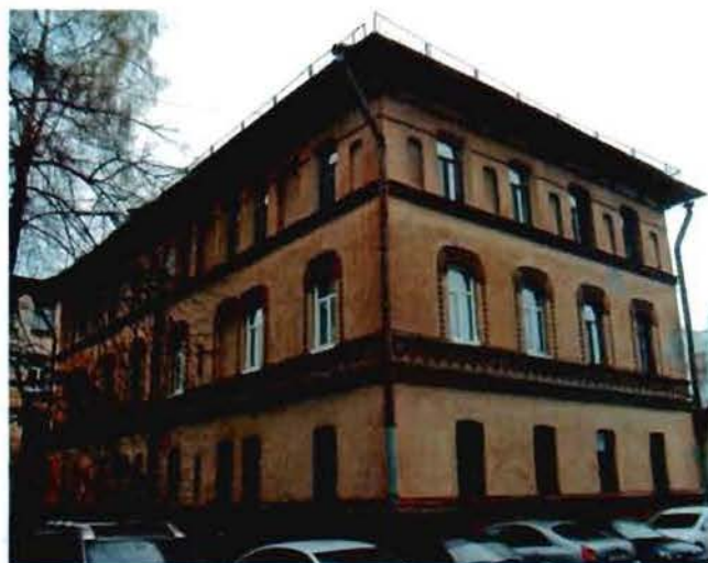
Фото 10. Вид на западный и южный фасады.
