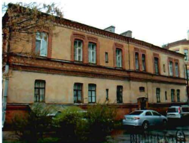
Фото 14. Вид на восточный фасад.
