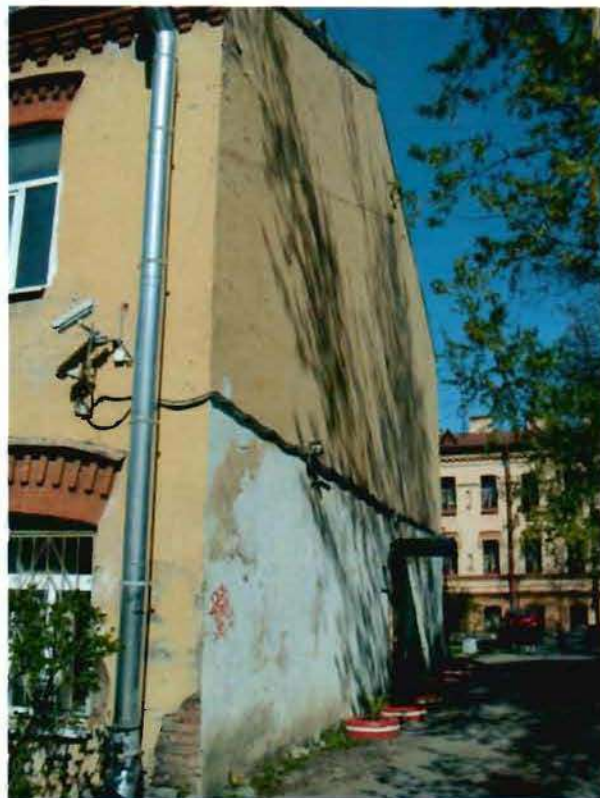
Фото 23. Вид на восточный фасад.
