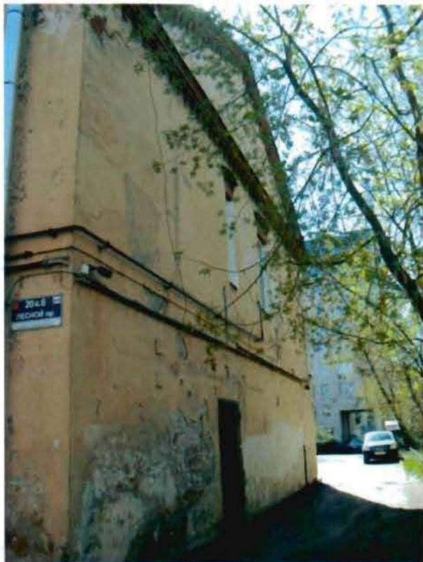
Фото 22. Вид на западный фасад.
