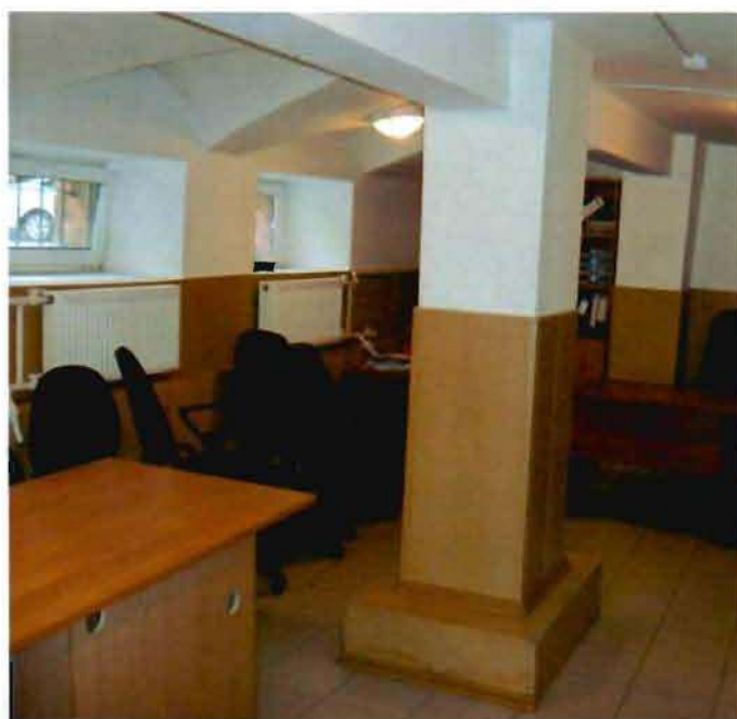
Фото 30. Пилоны в уровне подвального этажа. Фрагмент.
