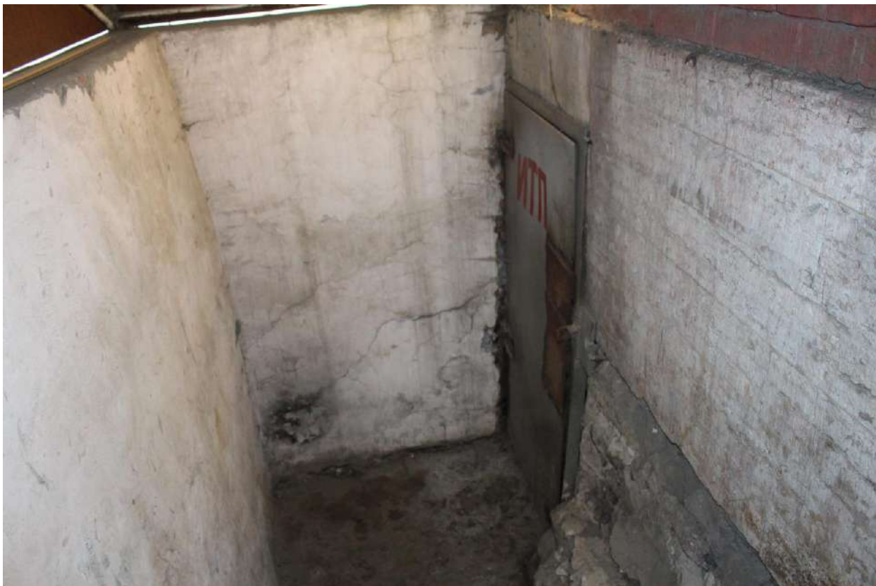
Фото 11. Вход в тепловой пункт (помещение 3-Н).
