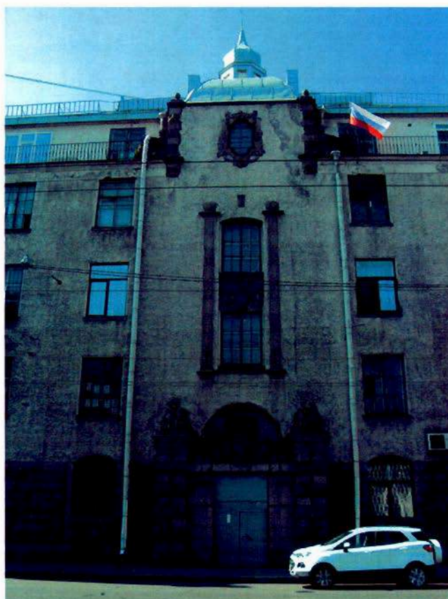
Фото 2. Вид на восточный фасад. Фрагмент.
