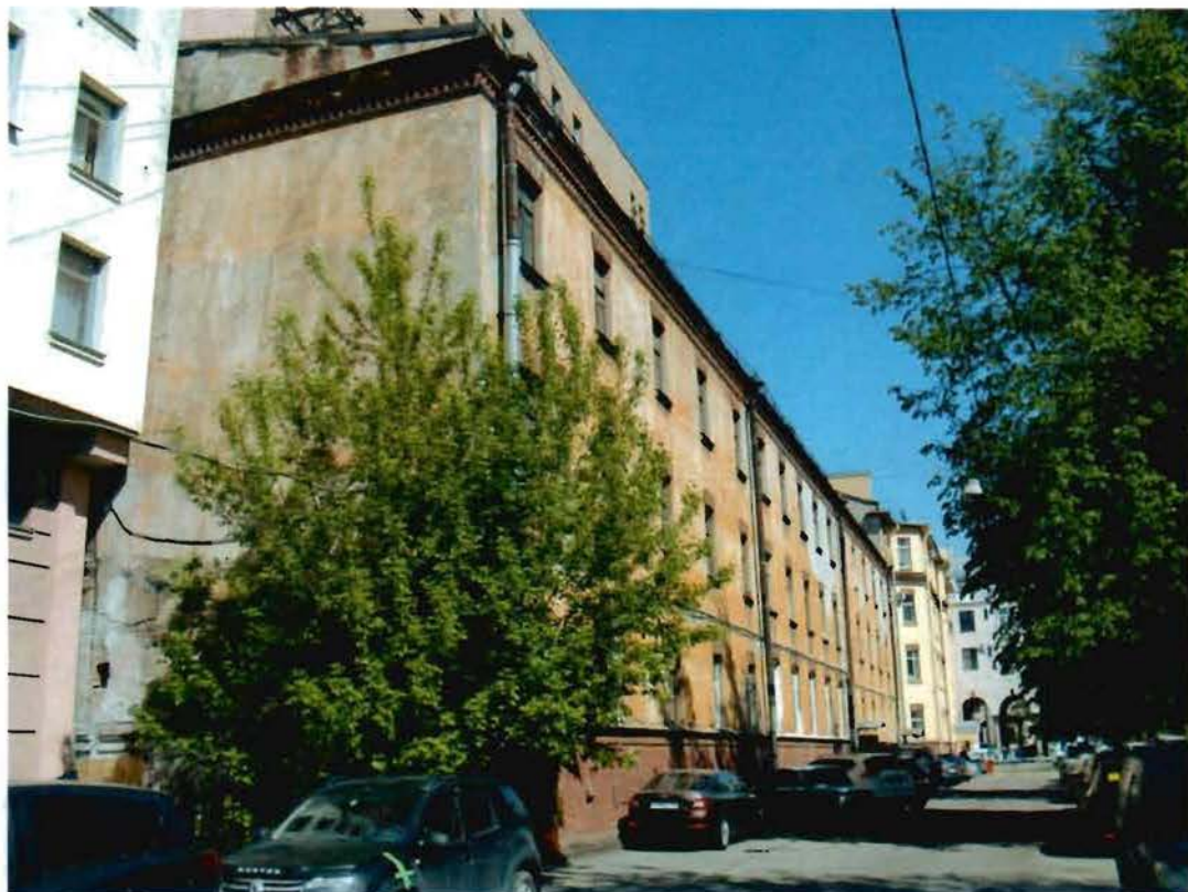
Фото 31. Вид на южный и западный фасады.
