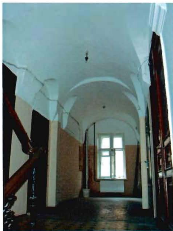
Фото 12. Вестибюль 2-го этажа. Цилиндрические своды с распалубками.
