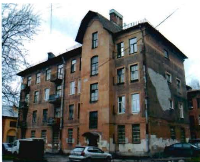
Фото 1. Вид на западный и южный фасады.
