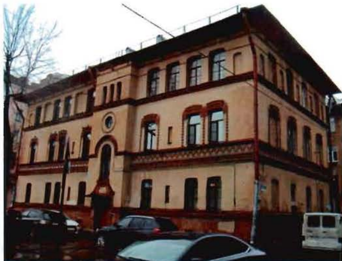
Фото 9. Вид на восточный и северный фасады.
