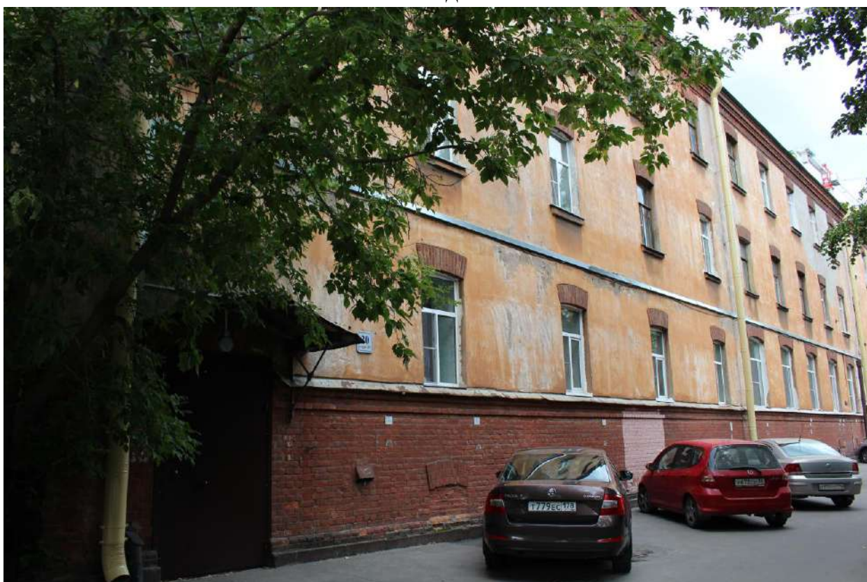
Фото 2. Вид на лицевой фасад жилого дома по адресу: Санкт-Петербург, Лесной пр., 20, корп. 10, лит. Е с юго-запада.
