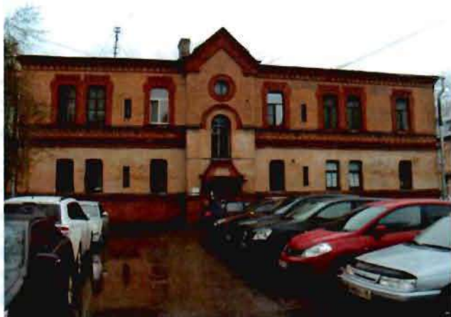
Фото 13. Вид на западный фасад.
