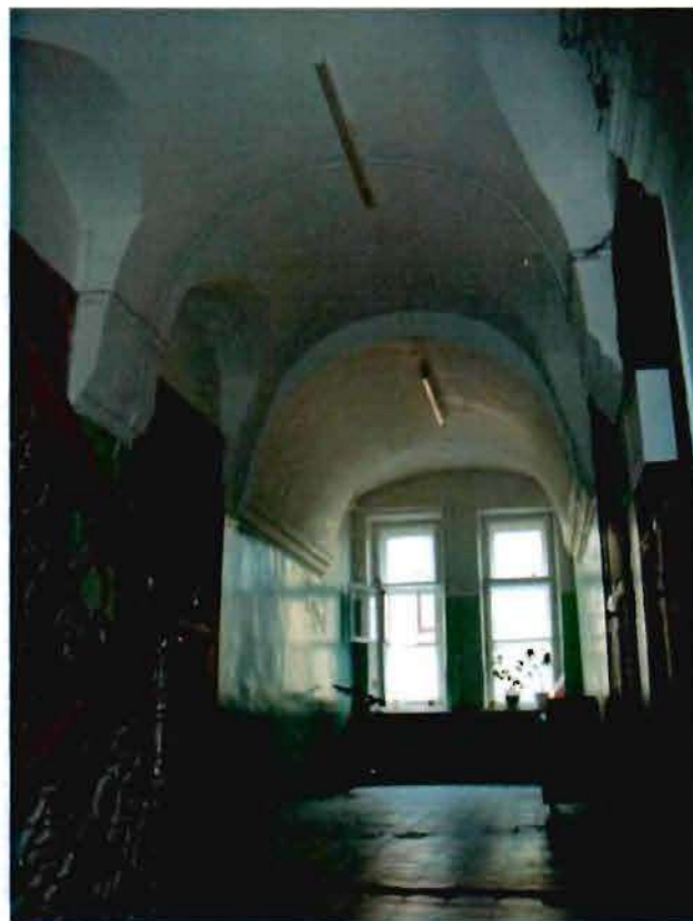
Фото 16. Вестибюль 2-го этажа. Цилиндрические своды с распалубками.
