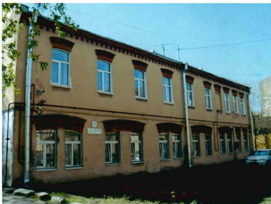
Фото 21. Вид на северный фасад.
