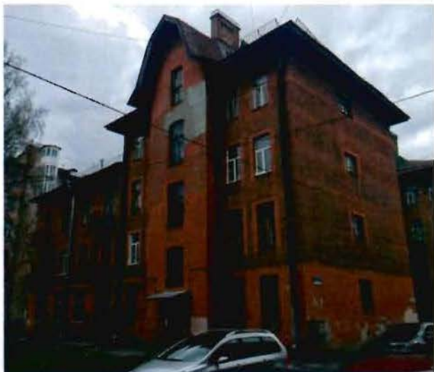
Фото 5. Вид на восточный и северный фасады.
