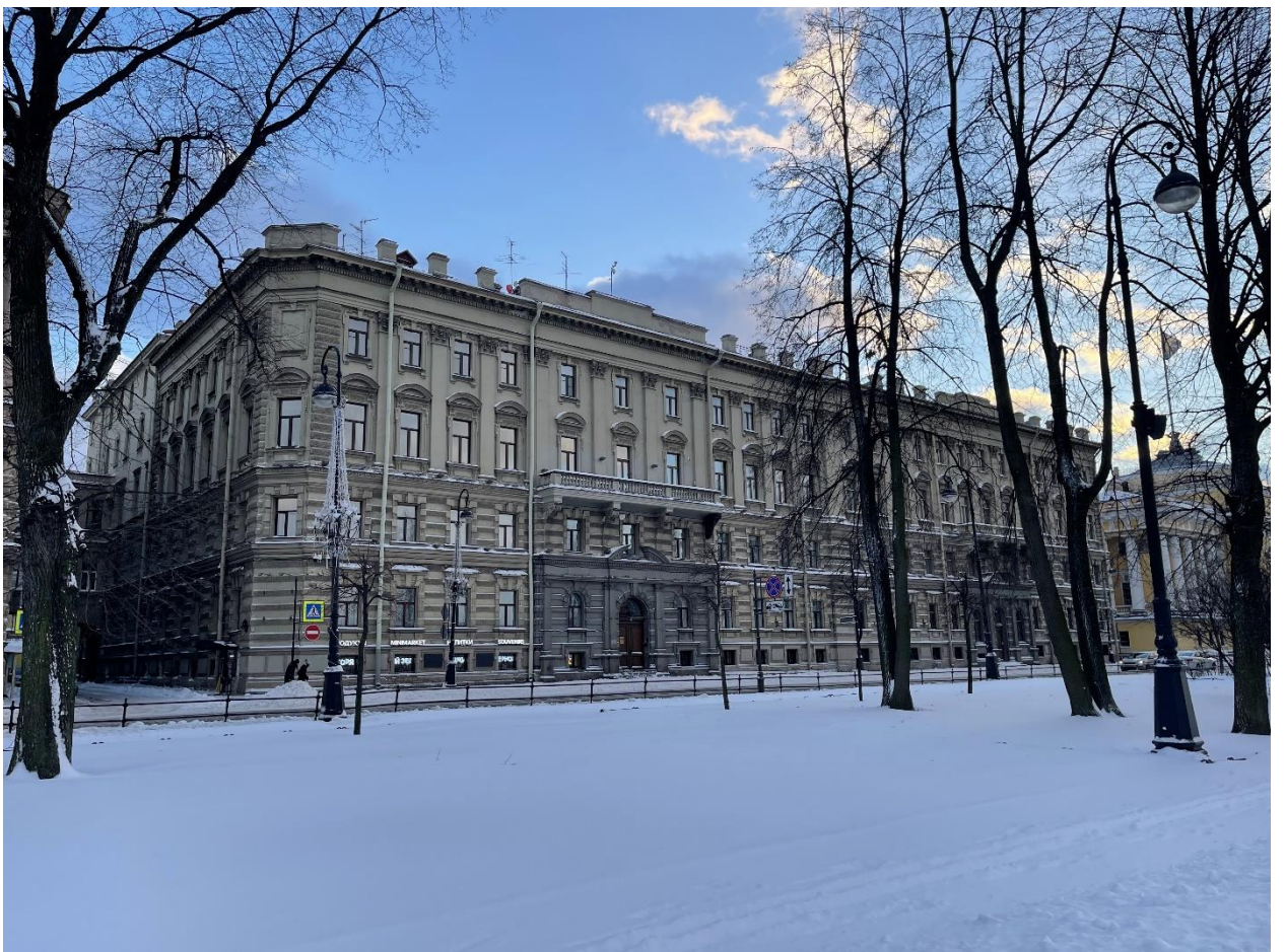
Фото №1. Лицевой (северо-западный) фасад по Адмиралтейской набережной
