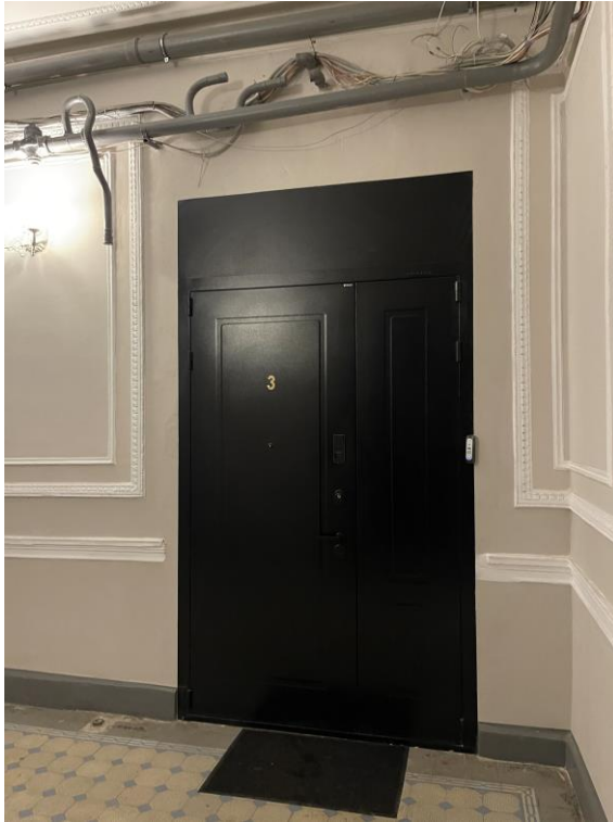
Фото №4. Входная дверь в квартиру №3
