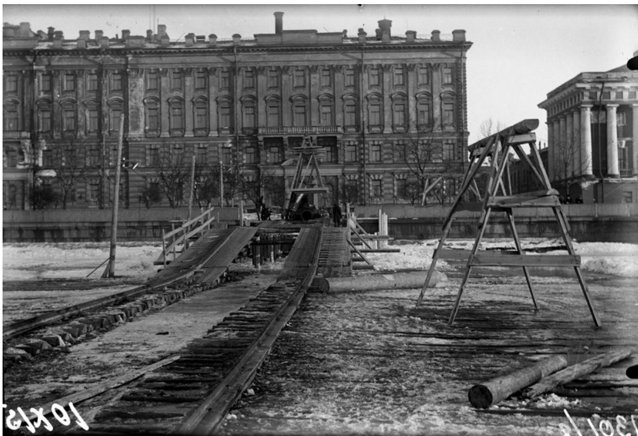
Илл. 37. Водопроводные работы. Устройство перехода через Неву в районе Адмиралтейской набережной. 1920-е гг. ГМИ СПб Инв.№-II-A-864 н
