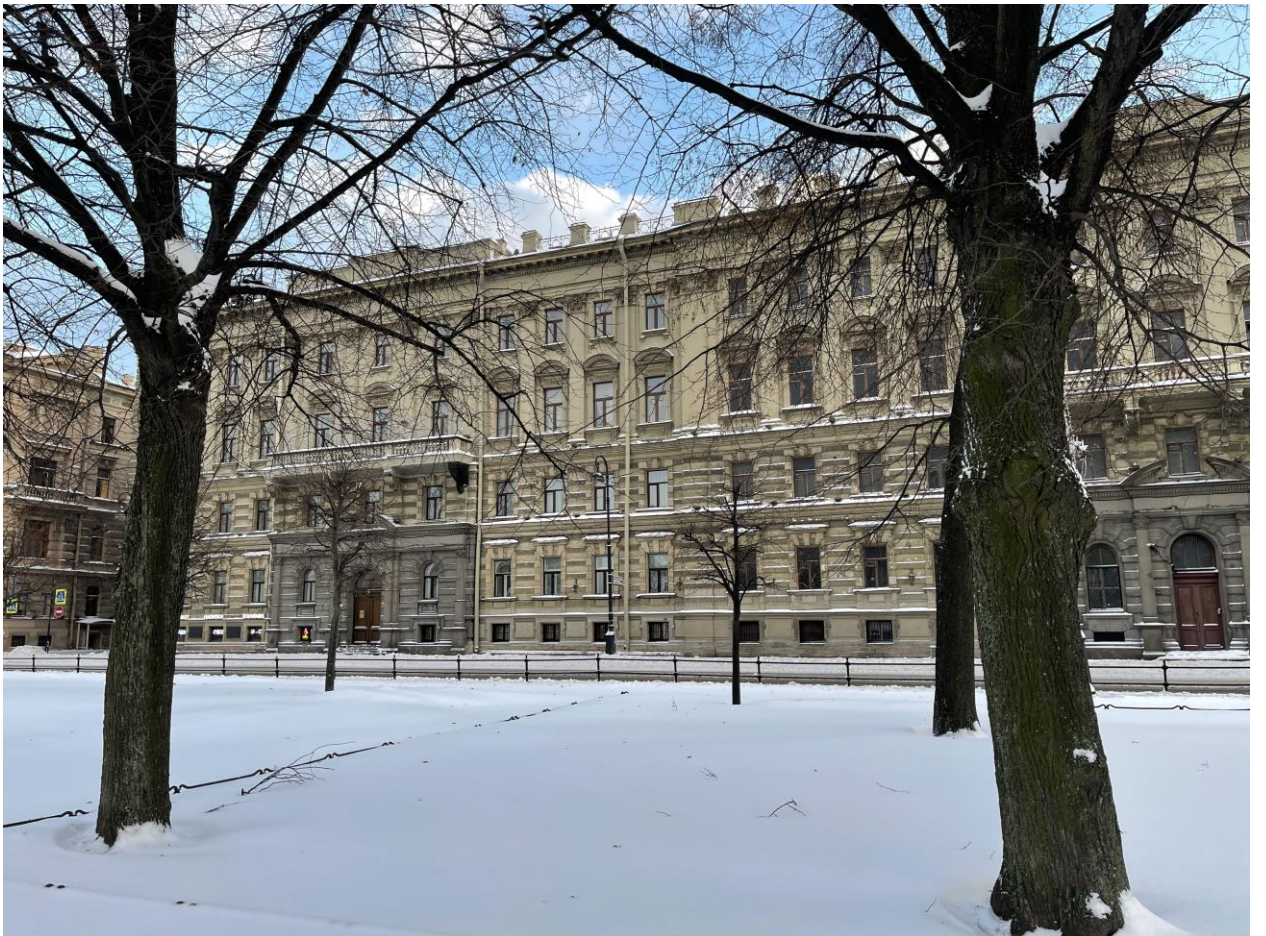
Фото №2. Лицевой (северо-западный) фасад по Адмиралтейской набережной
