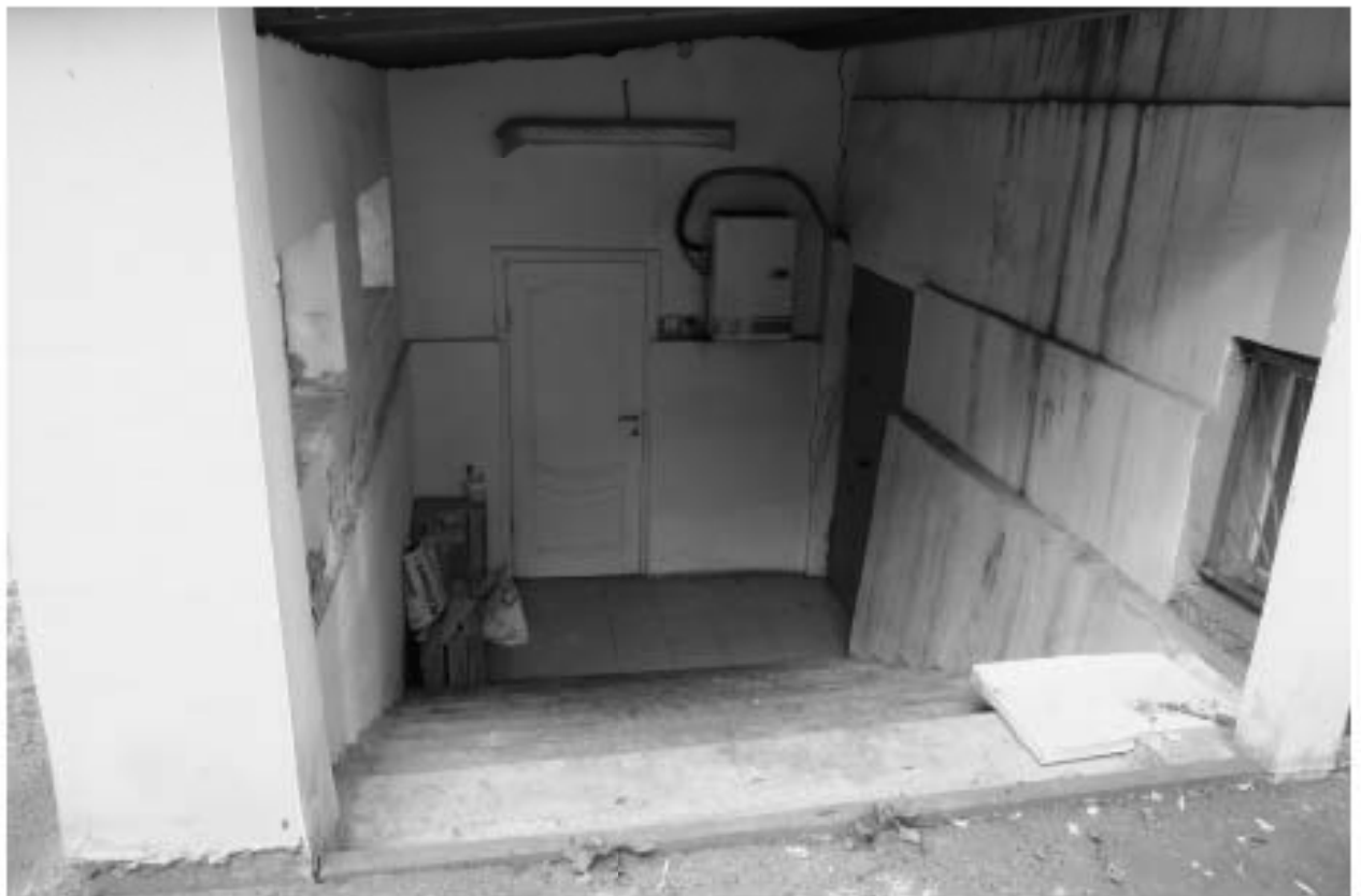
20. Приемок северо-западного фасада объекта культурного наследия регионального значения «Противоалкогольный институт» (Главное здание)», расположенного по адресу: г. Санкт-Петербург, ул. Бехтерева д. 3, Лит. А. 26.07.2018
