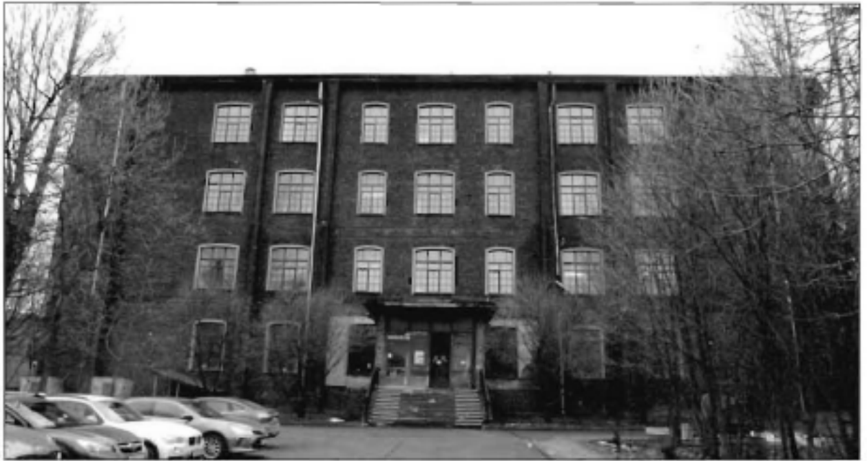
1. Санкт-Петербург, ул. Бехтерева 1, лит. А. «Главное здание». Общий вид с северо-запада.
