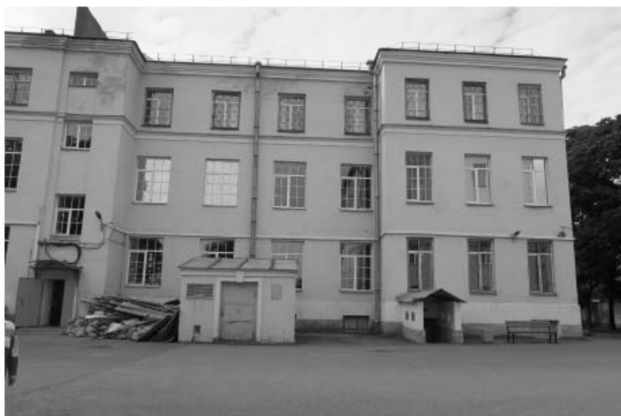
15. Юго-восточный дворовый фасад объекта культурного наследия регионального значения «Противоалкогольный институт» (Главное здание), расположенного по адресу: г. Санкт-Петербург, ул. Бехтерева д. 3, Лит. А. Фрагмент. 26.07.2018
