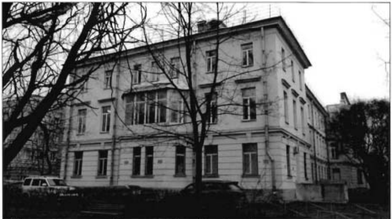
28. Корпус, расположенный по адресу: Санкт-Петербург, Бехтерева улица, дом 3, литера 3. Общий вид с запада.
