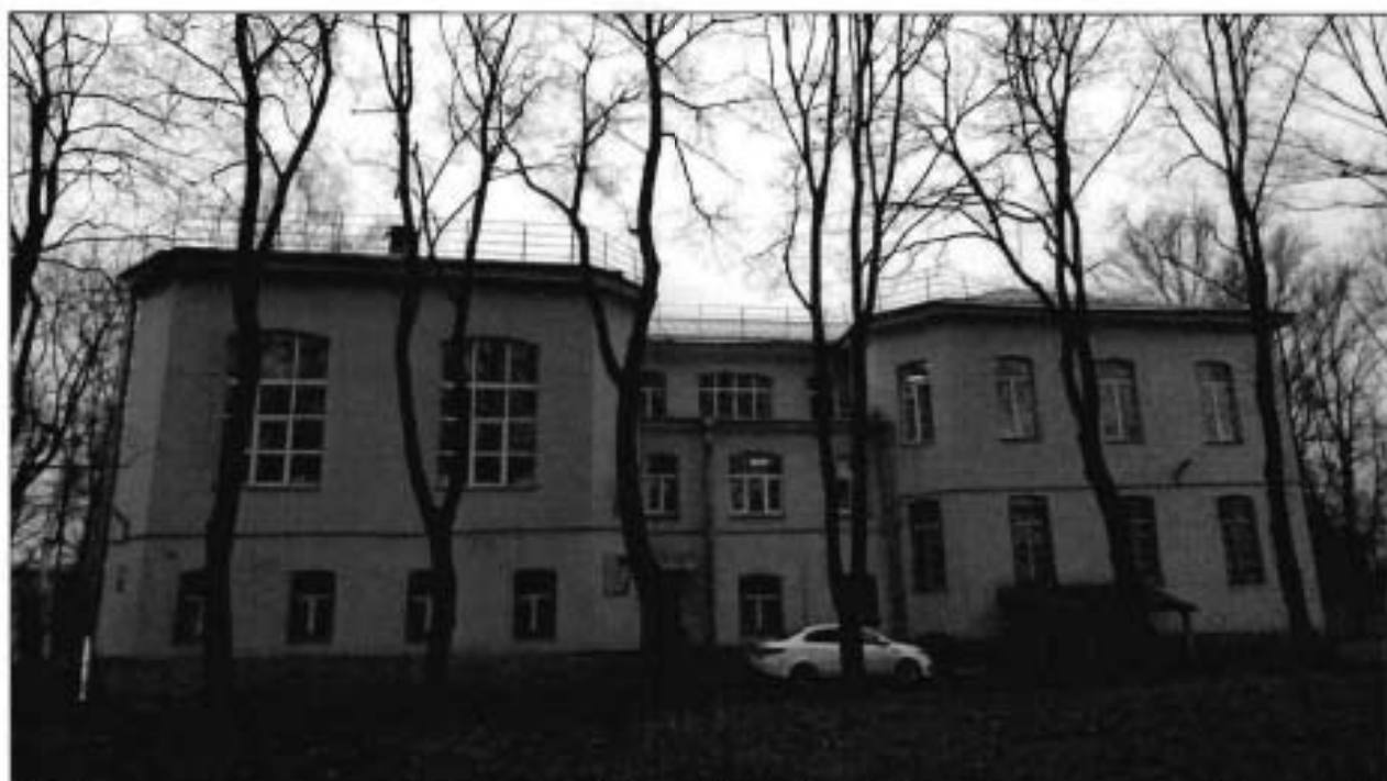
18. Корпус, расположенный по адресу: Санкт-Петербург, Бехтерева улица, дом 3, литера Д. Общий вид с севера.
