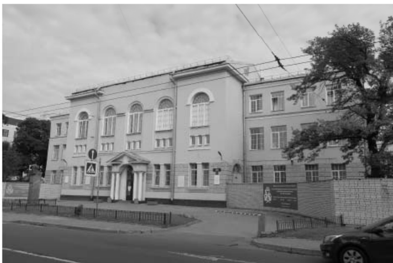
1. Северо-западный лицевой фасад объекта культурного наследия регионального значения «Противоалкогольный институт» (Главное здание), расположенного по адресу: г. Санкт-Петербург, ул. Бехтерева д. 3, Лит. А. 26.07.2018
