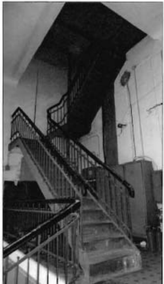
4. Лестница на чердак (восточная лестничная клетка).
