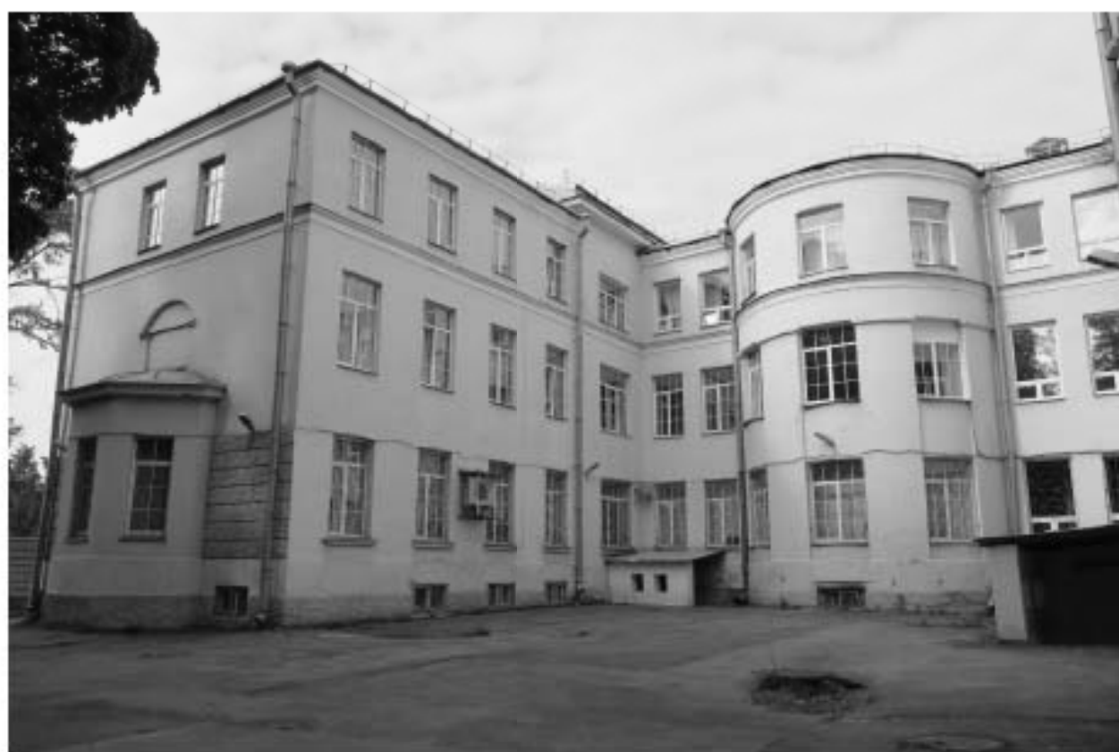
18. Юго-западные и северо-западные фасады объекта культурного наследия регионального значения «Противоалкогольный институт» (Главное здание), расположенного по адресу: г. Санкт-Петербург, ул. Бехтерева д. 3, Лит. А. 26.07.2018
