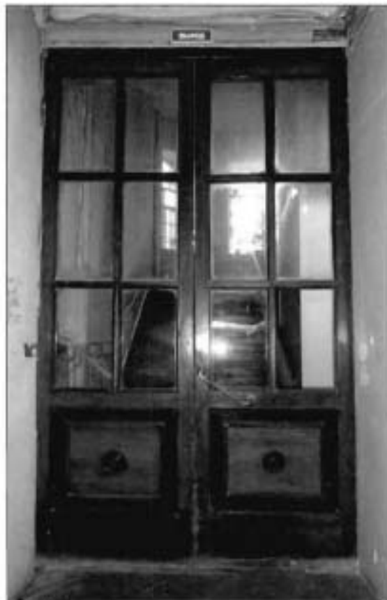
5. Исторические дверные заполнения.
