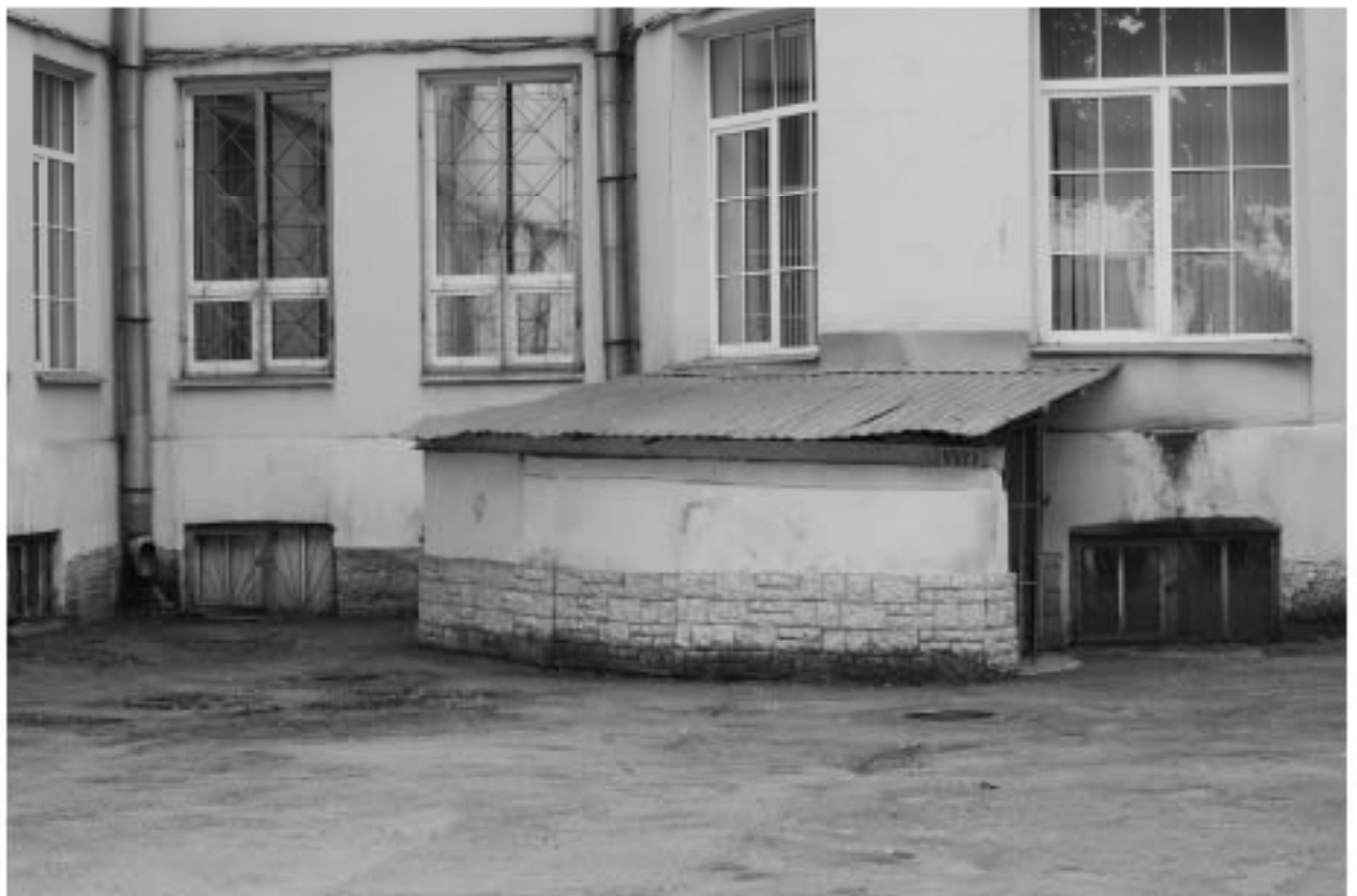
13. Крыльцо северо-восточного фасада объекта культурного наследия регионального значения «Противоалкогольный институт» (Главное здание)», расположенного по адресу: г. Санкт-Петербург, ул. Бехтерева д. 3, Лит. А. 26.07.2018
