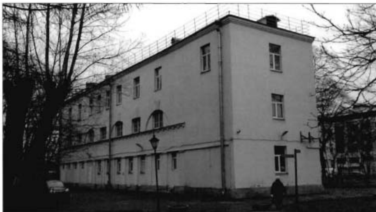
16. Корпус, расположенный по адресу: Санкт-Петербург, Бехтерева улица, дом 3, литера В. Общий вид с юга.
