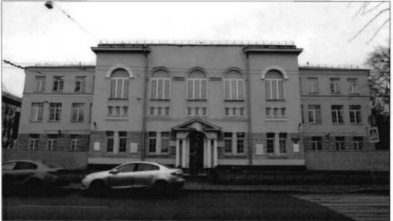
6. Корпус по адресу: Санкт-Петербург, Бехтерева улица, дом 3, литера А. Вид с северо-запада.
