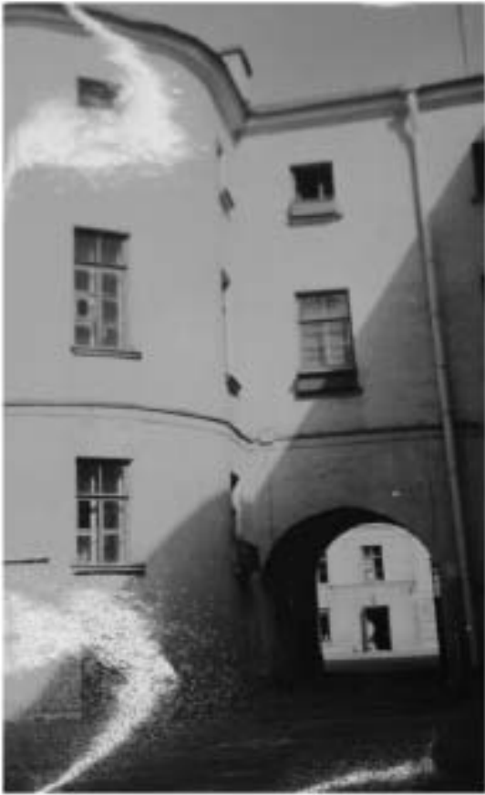
19. Жилой дом Академии наук. Фрагмент дворового фасада с аркой, ведущей на 7-ю линию. 1968г.
