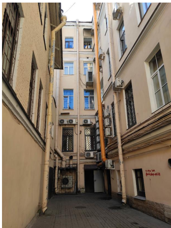
Фото №5. Фрагмент дворовых фасадов. Вход на лестничную клетку, где расположены квартиры 18, 50, 51
