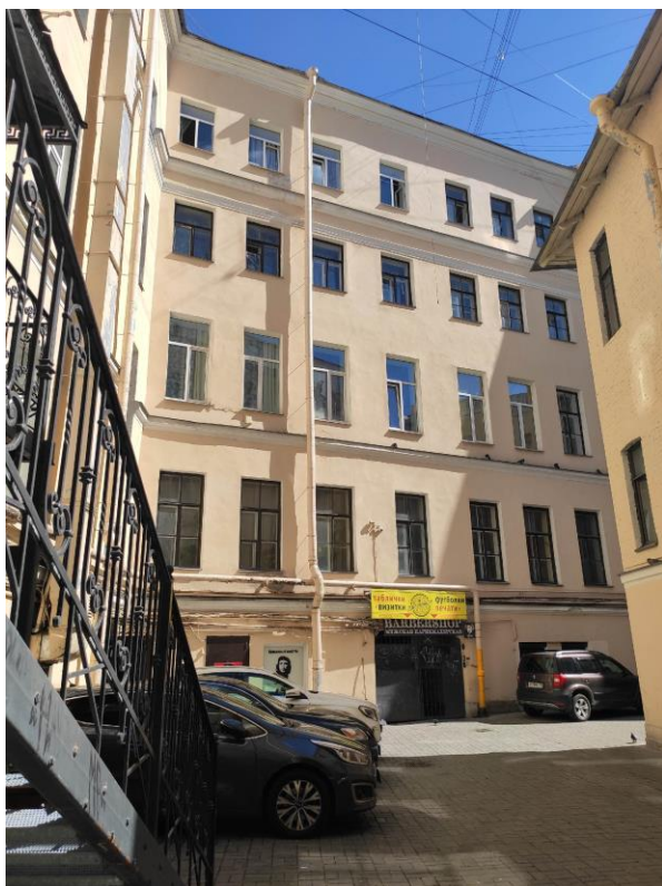
Фото №3. Фрагмент дворовых фасадов
