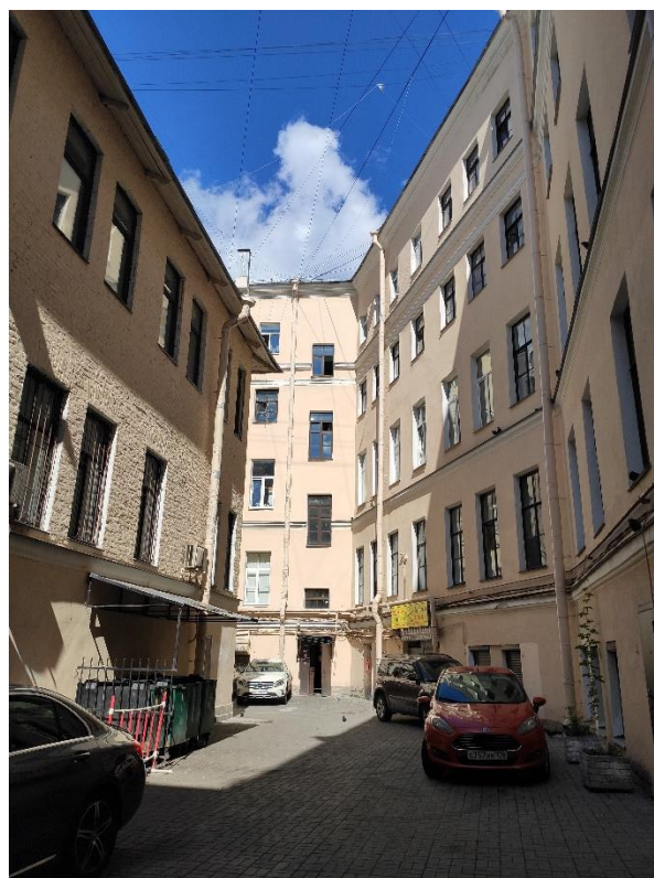
Фото №4. Фрагмент дворовых фасадов
