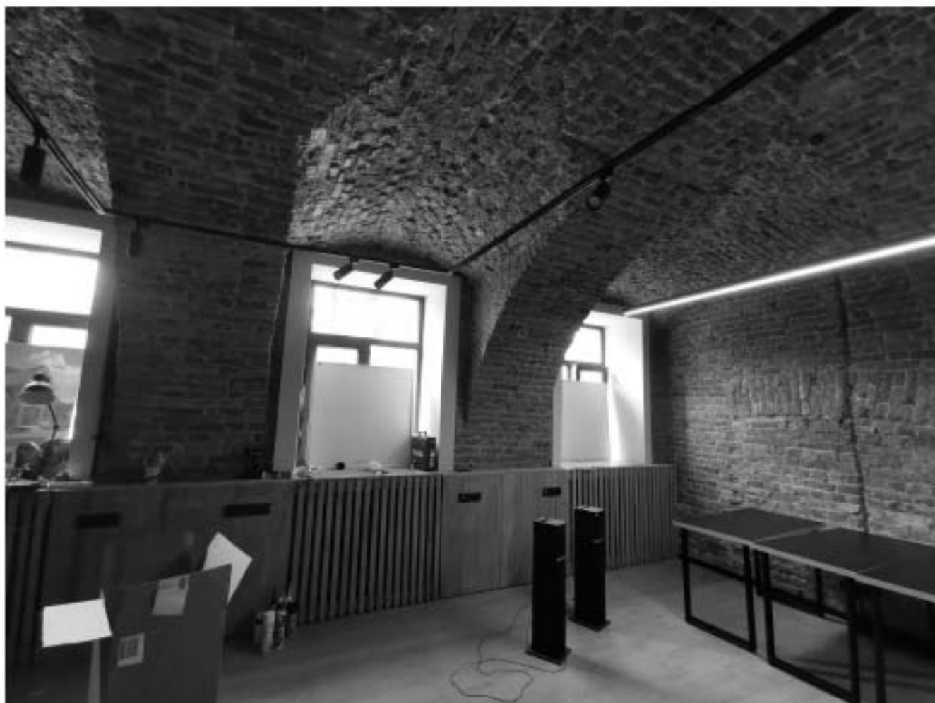
Фото №7. Вид на оконные проемы и перекрытия в виде сводов. Вид на исторический заложенный проем с клинчатой перемычкой.
