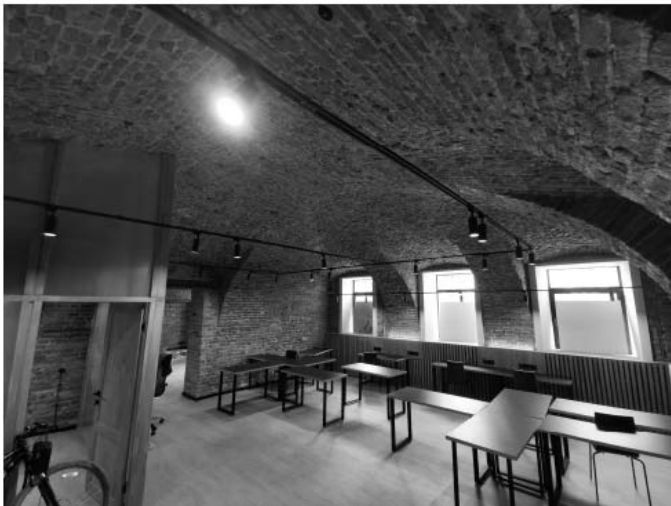
Фото №3. Общий вид помещения. Вид на оконные проемы и перекрытия в виде сводов.
