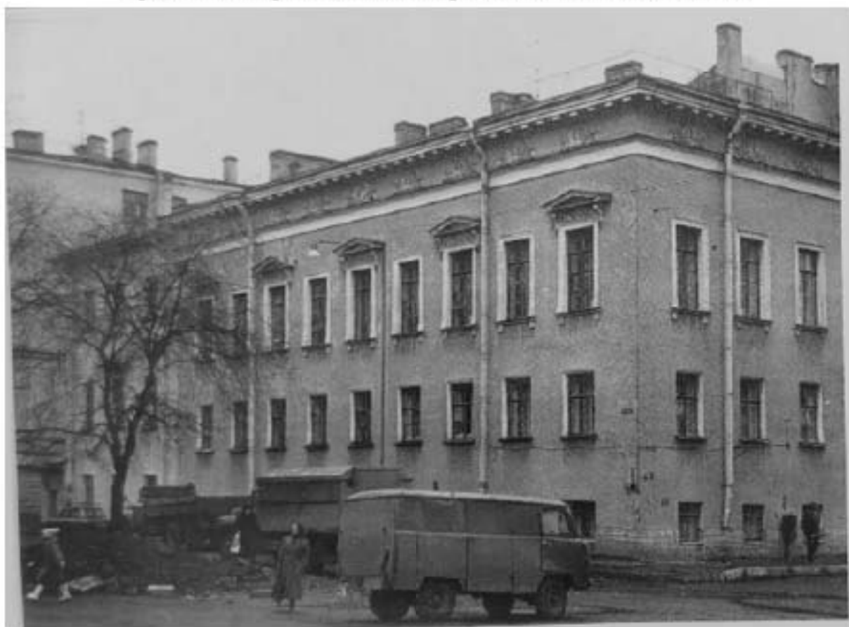
Илл. 24. Фасад дома № 14 по Захарьевской ул. Вид с угла Захарьевской и пр. Чернышевского. Фото 1992 г. //Архив КТИОП. П. 1139. Н-5618
