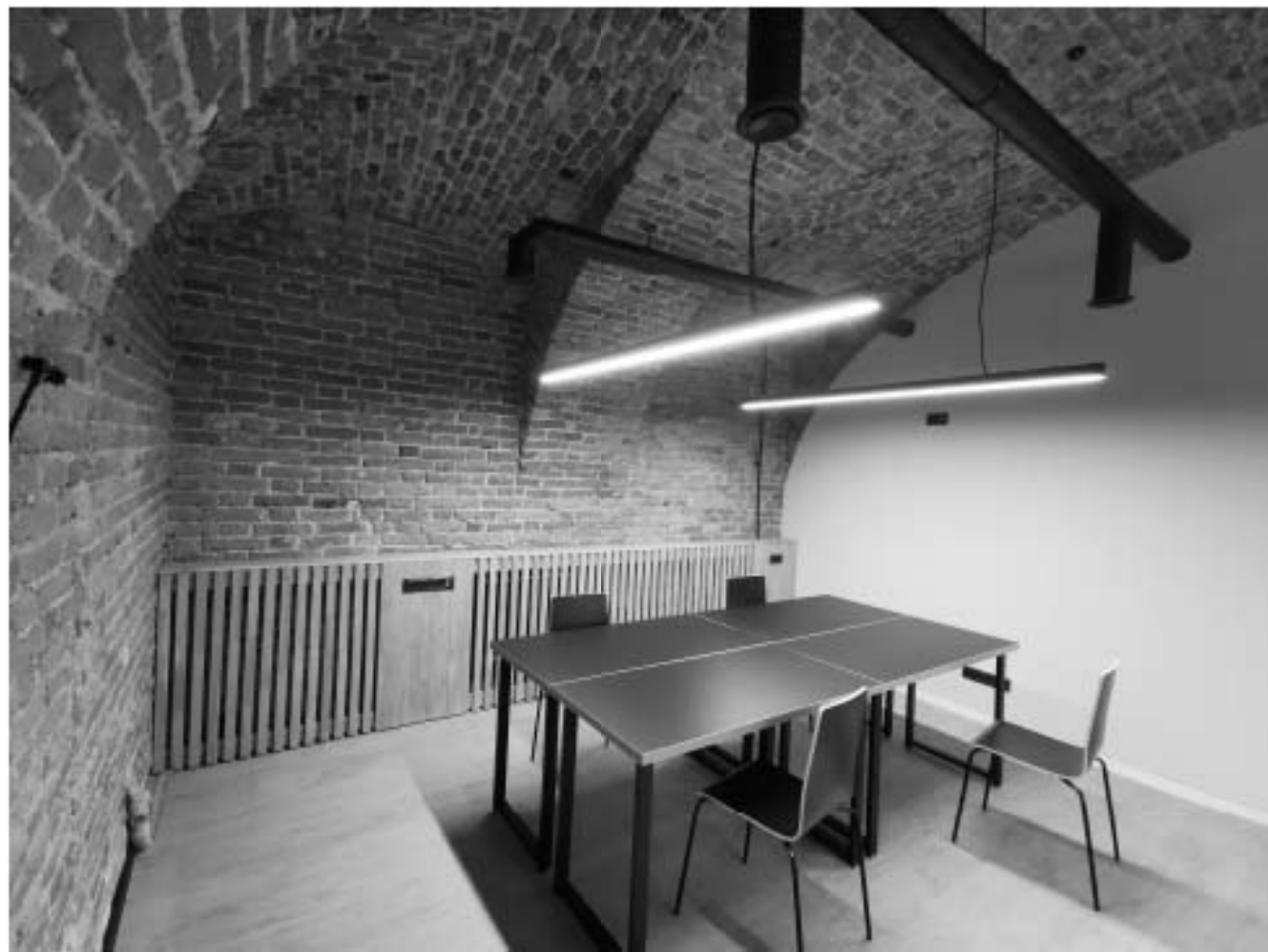
Фото №9. Общий вид помещения.
