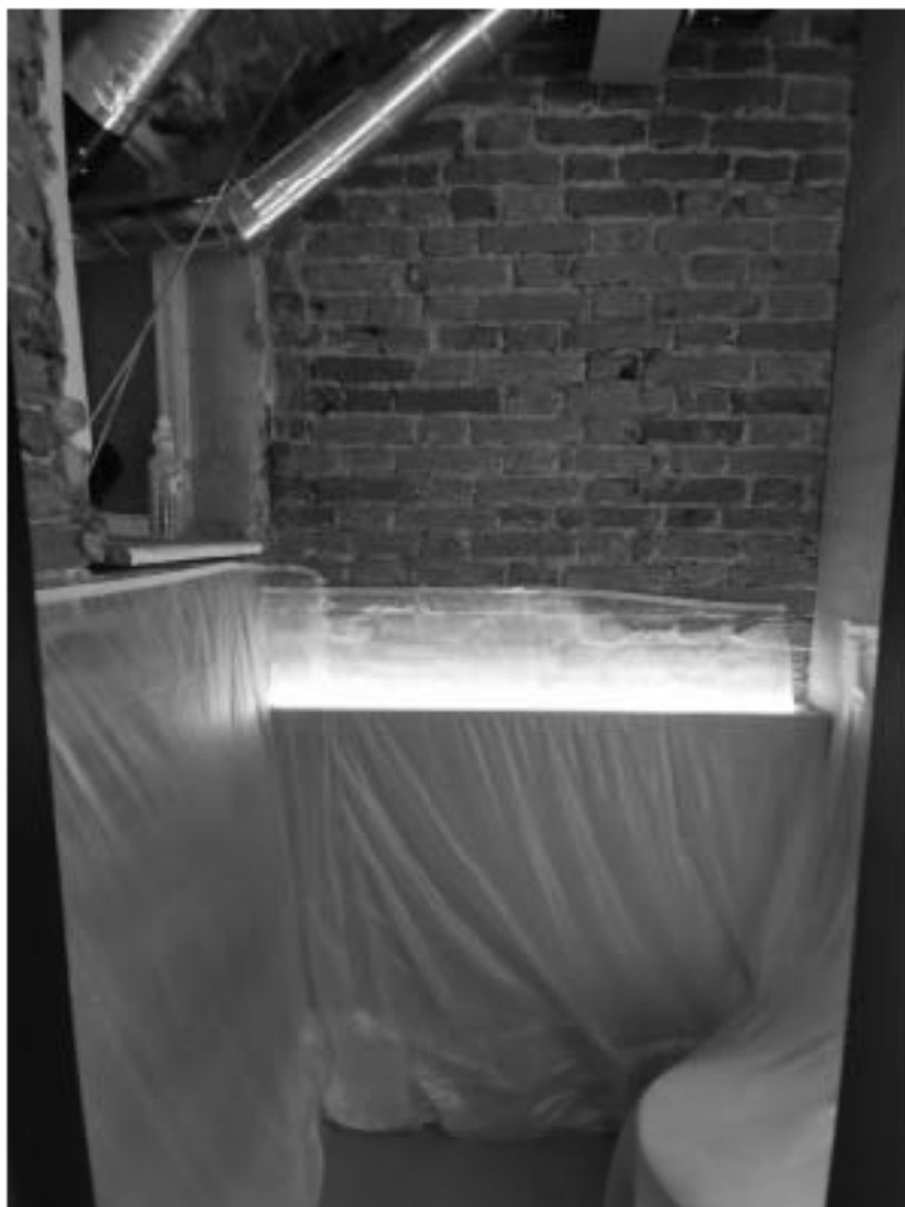
Фото №10. Общий вид помещения..
