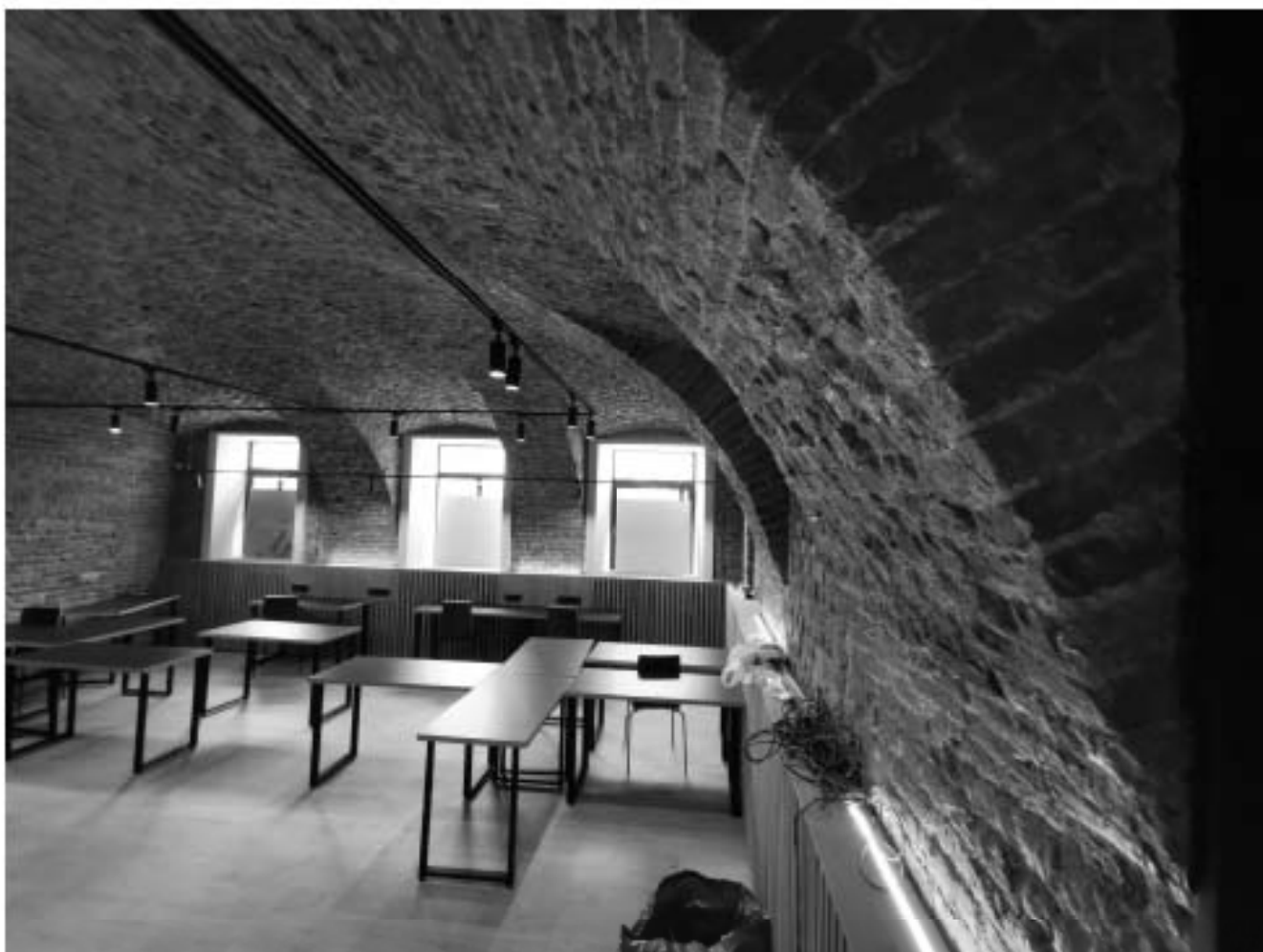
Фото №2. Общий вид помещения. Вид на оконные проемы и перекрытия в виде сводов.
