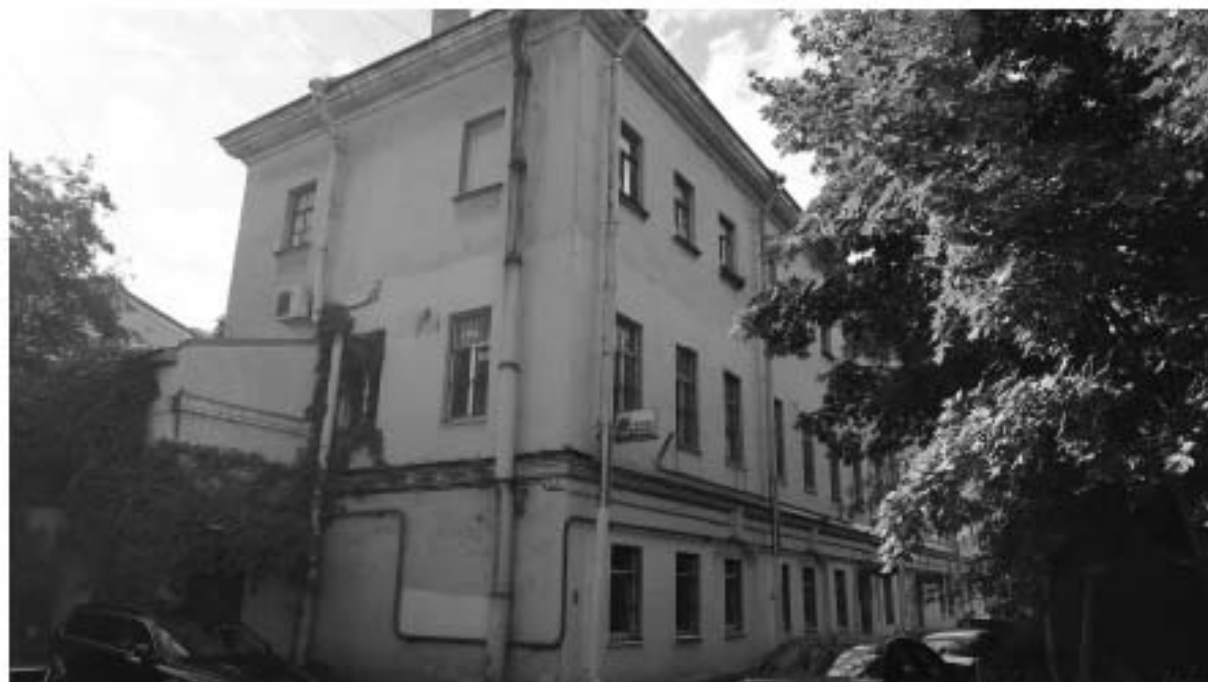
Фото №12. Общий вид фасада.
