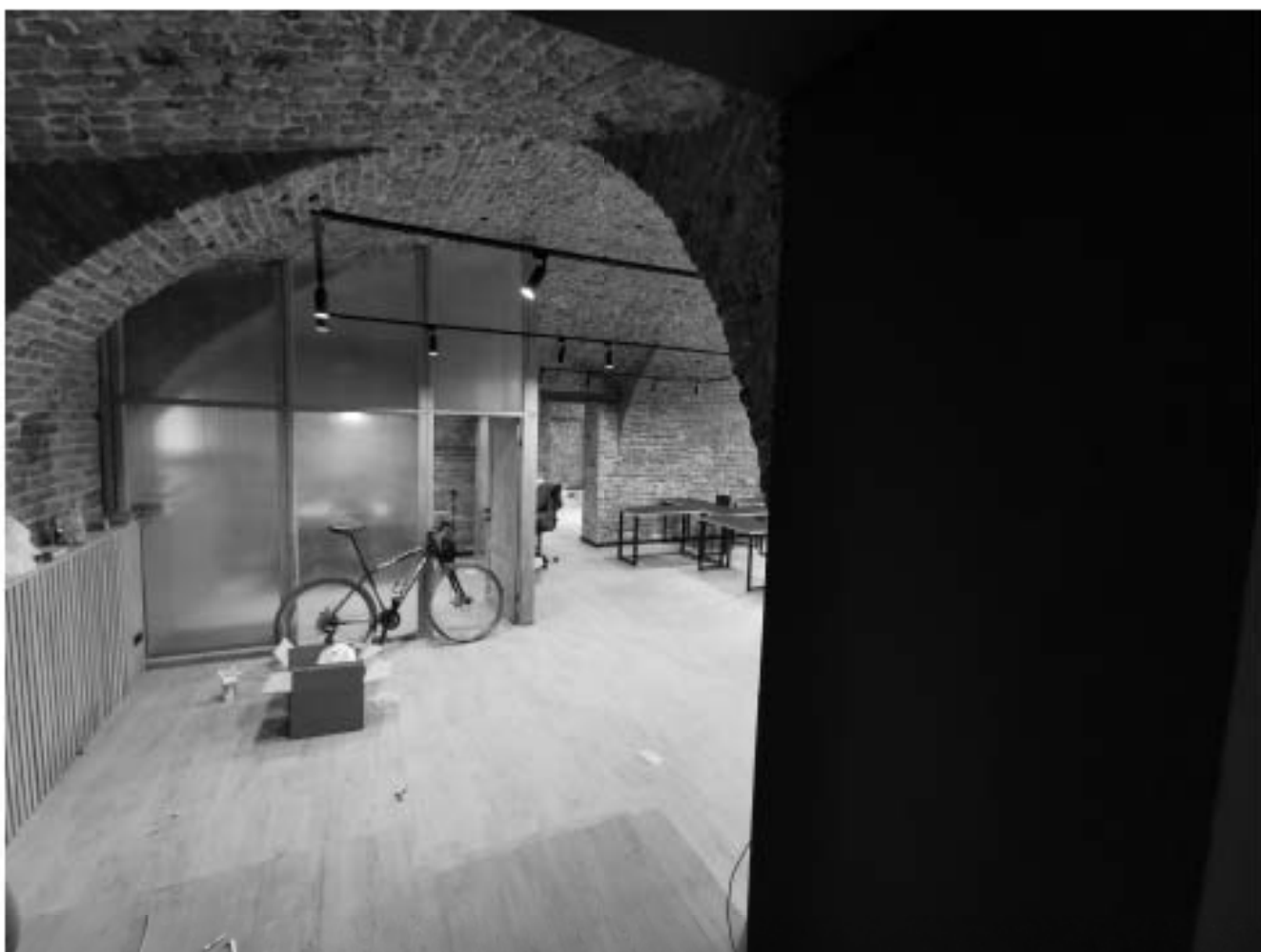
Фото №1. Общий вид помещения. Общий вид перекрытий в виде сводов.
