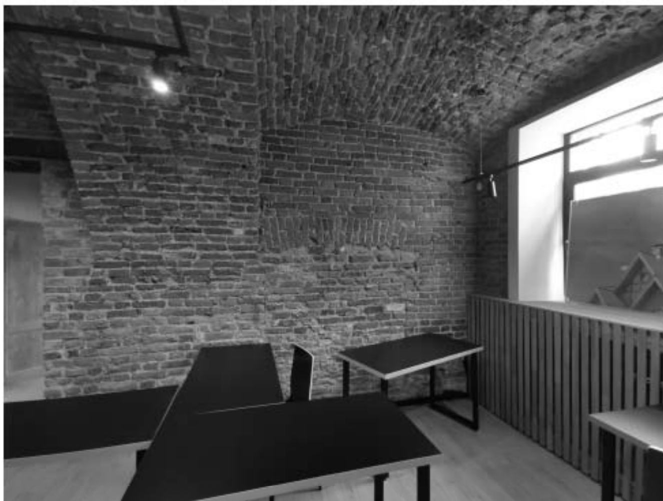
Фото №5. Вид на оконный проем и перекрытия в виде сводов. Вид на исторический заложенный проем с клинчатой перемычкой.
