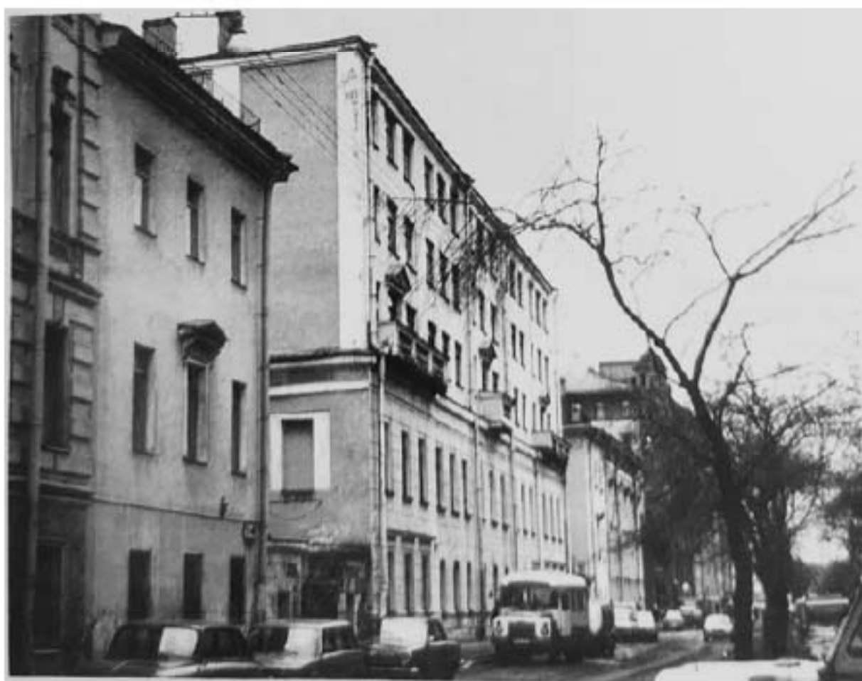
Илл. 22. Фасад дома № 14 по Захарьевской ул. Общий вид. Фото 1992 г. // Архив КГИОП. П. 1139. Н-5618
