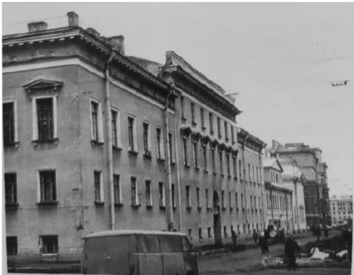
Илл. 25. Фасад дома с проспекта Чернышевского. Общий вид. Фото 1992 г. //Архив КТИОП. П. 1139. Н-5618
