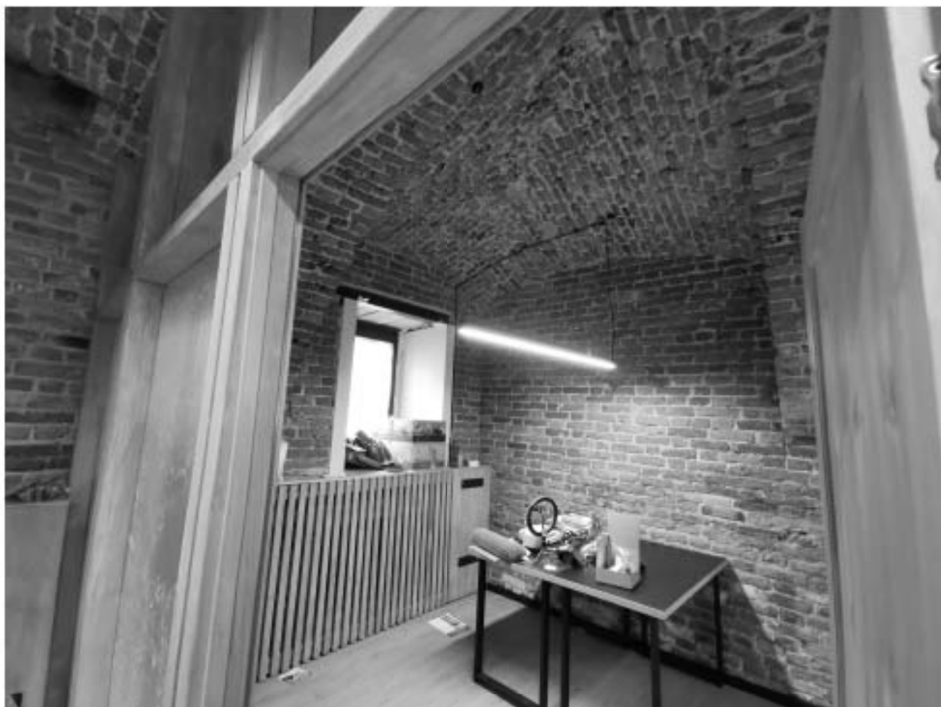
Фото №4. Общий вид помещения.
