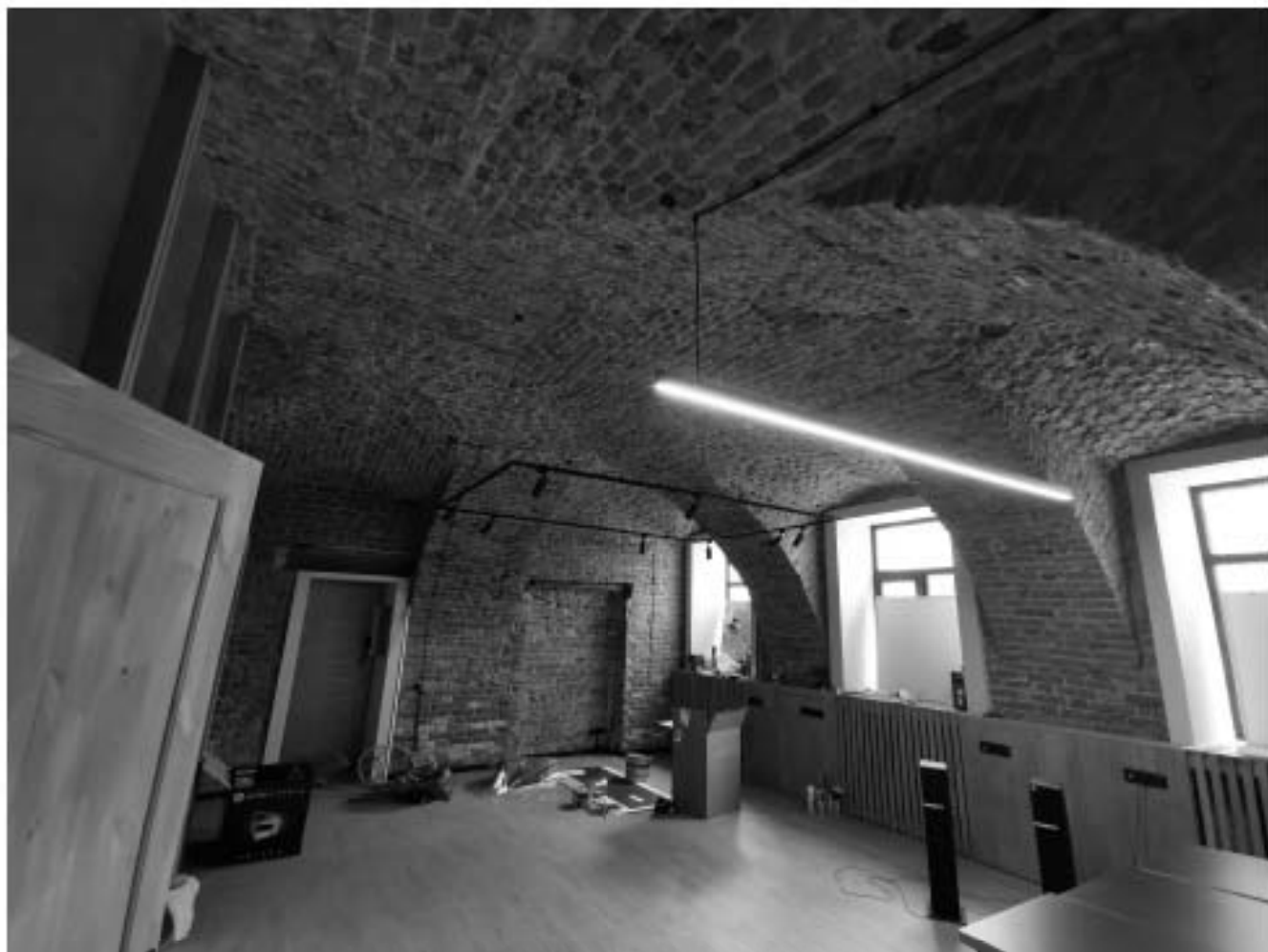
Фото №6. Общий вид помещения. Вид на оконные проемы и перекрытия в виде сводов, на существующую нишу и входную дверь.
